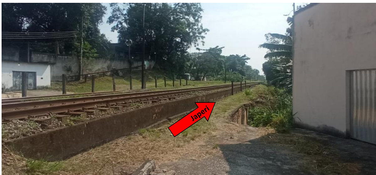
Figura 17. Cruzamento em nível sobre a Rua K (Seropédica): presença de residência no mesmo lado da nova linha proposta, distando aproximadamente 7 metros da linha férrea existente, operada pela MRS Logística.
