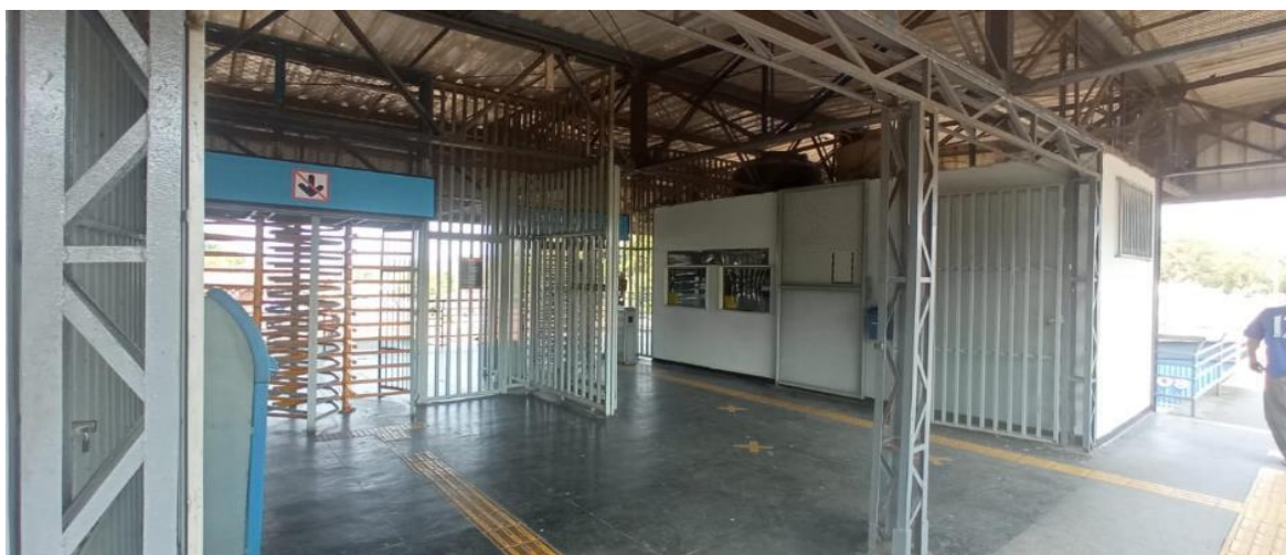
Figuras 60, 61 e 62. Estação Ferroviária de Japeri, de grande porte e perfeitamente adequada para inclusão de um novo modal de conexão, utilizando as estruturas de linhas antigas.
