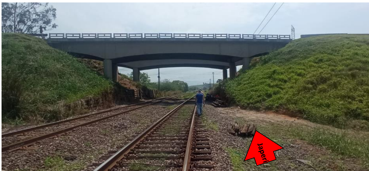
Figura 26. Vista, a partir da linha férrea, do viaduto da BR-116 - Rodovia Presidente Dutra.
