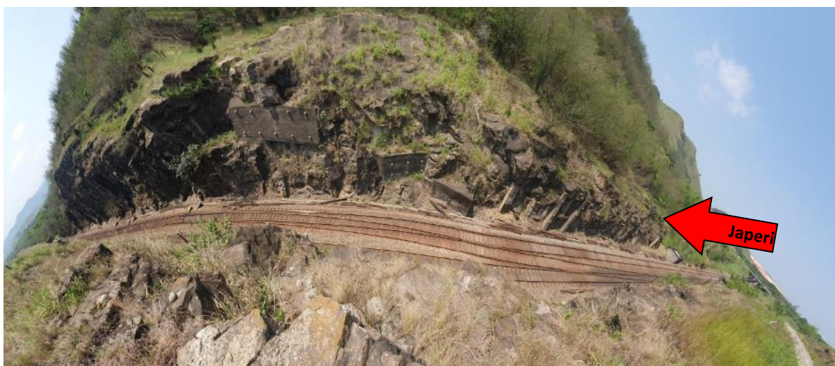
Figuras 43, 44, 45, 46 e 47. Trechos do estreitamento entre morros, na altura de Japeri. Talvez aqui esteja o trecho mais complexo, que irá requerer obras de engenharia para alargamento do leito ferroviário ou uma pequena alteração no trajeto da linha proposta.
