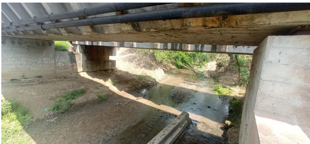
Figuras 30, 31 e 32. Vistas em detalhe da ponte sobre o córrego, próximo à BR116 – Rodovia Presidente Dutra.
