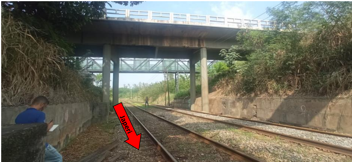
Figura 10. Vista sob viadutos da Rodovia BR-465 e ciclovia em Seropédica (RJ).
