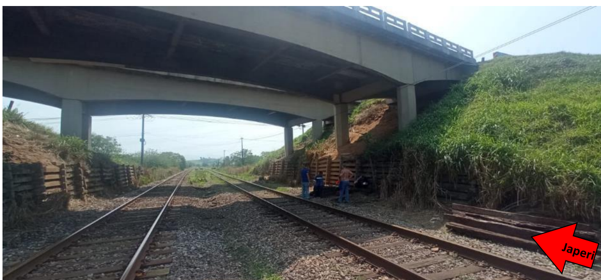
Figura 27. Vista em detalhe das estruturas de sustentação e contenção sob o viaduto da BR116 – Rodovia Presidente Dutra.
