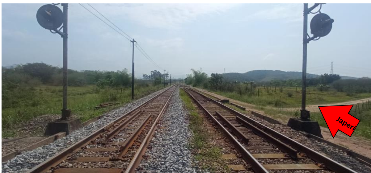
Figura 25. Vista dos trilhos da linha férrea a partir do acesso pela Rua Sete de Setembro. Ampla margem de espaço para a construção de uma nova linha férrea.
