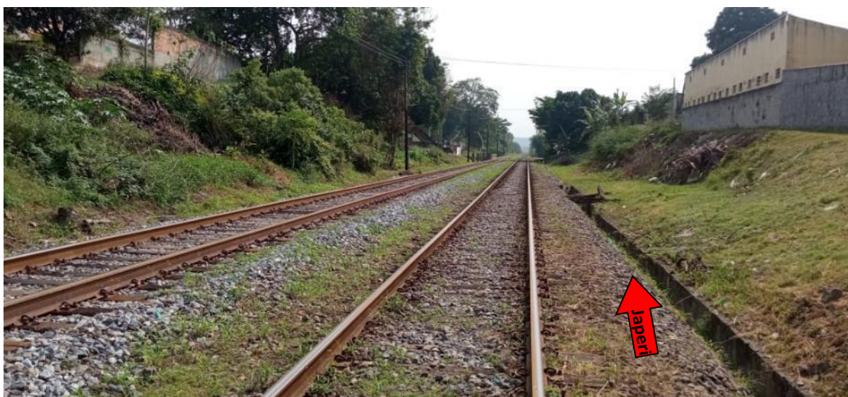
Figura 15. Vista da linha férrea (para norte) a partir do cruzamento em nível na Rua Marquês Valença (Seropédica). Deste ângulo, a área destinada à nova ferrovia ficaria à direita das existentes.
