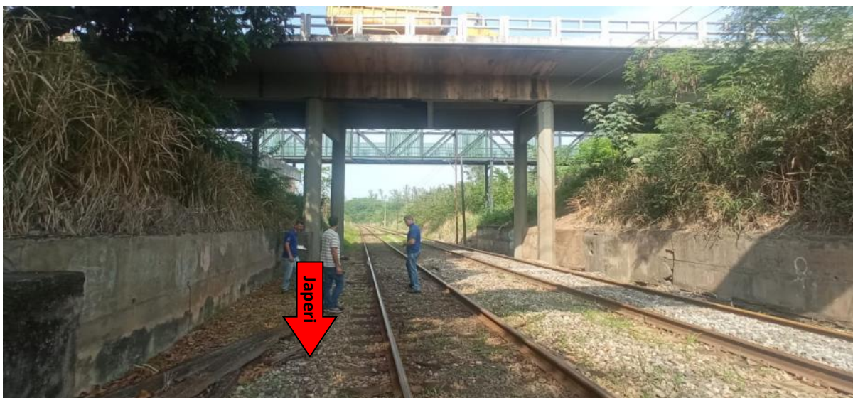
Figura 9. Vista sob viadutos da Rodovia BR-465 e ciclovia em Seropédica (RJ). Deste ângulo, a área destinada à nova ferrovia ficaria à esquerda das existentes.
