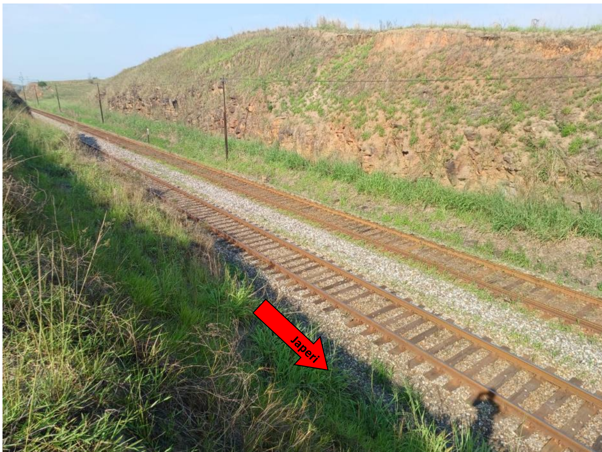
Figura 35. Vista do trecho de recorte de morros para passagem dos trilhos no “Ponto 53/MRS”.
