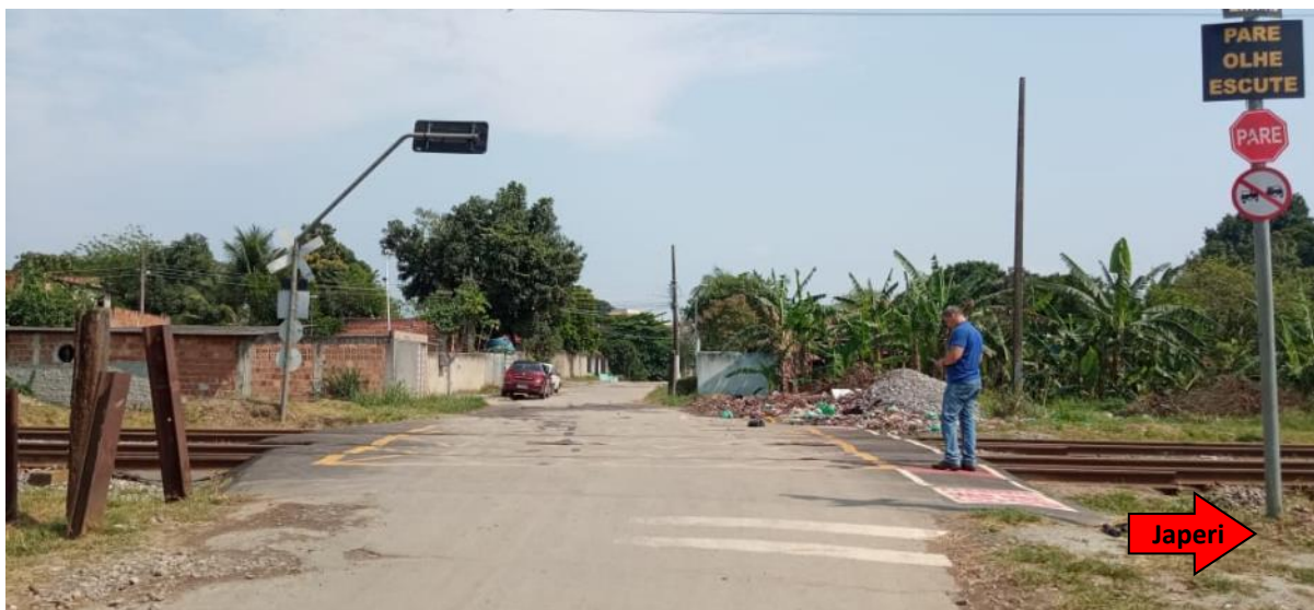
Figura 19. Cruzamento em nível sobre a Rua 31, localizada em área periurbana de Seropédica.
