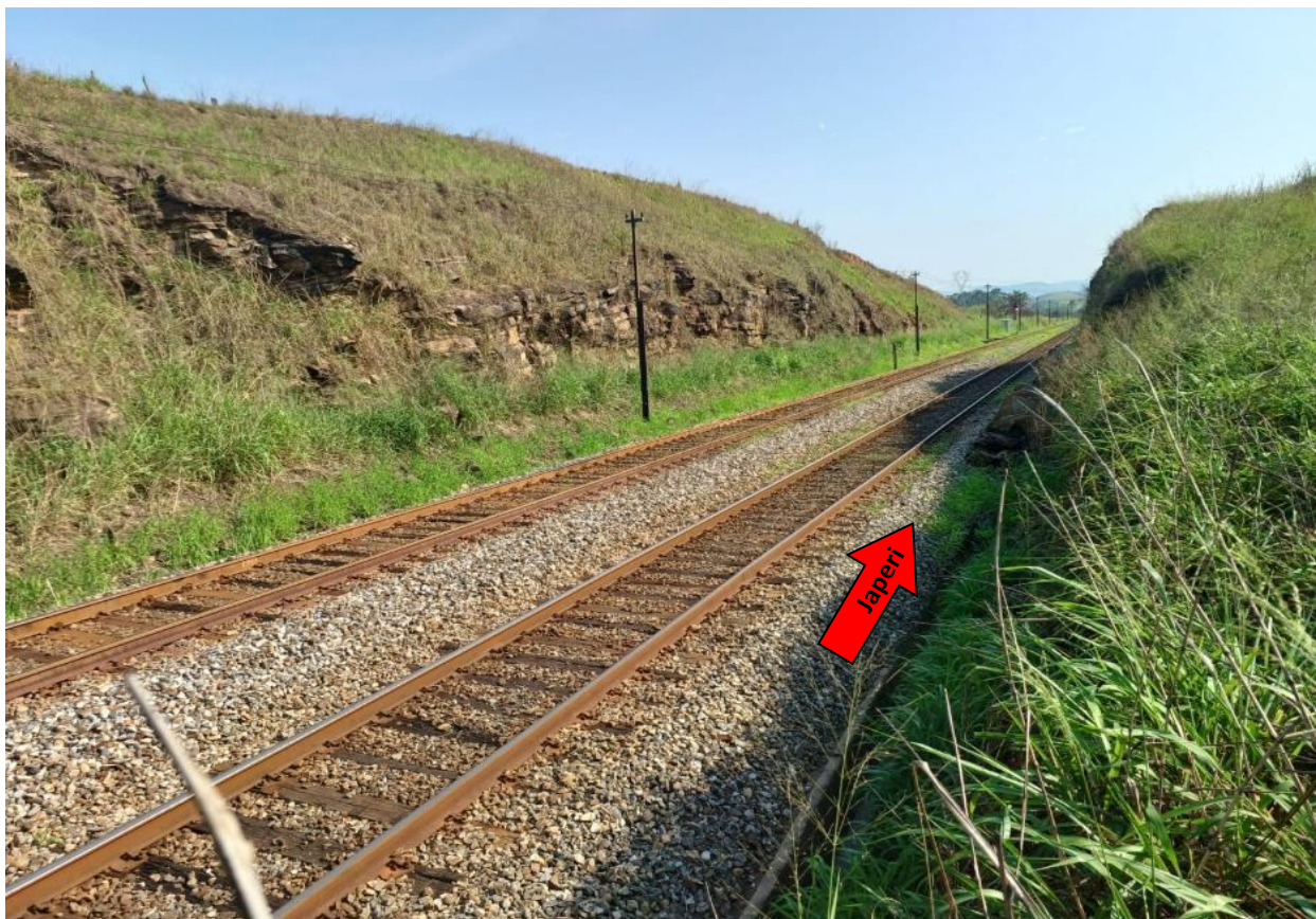
Figura 36. Vista do trecho de recorte de morros para passagem dos trilhos no “Ponto 53/MRS”.
