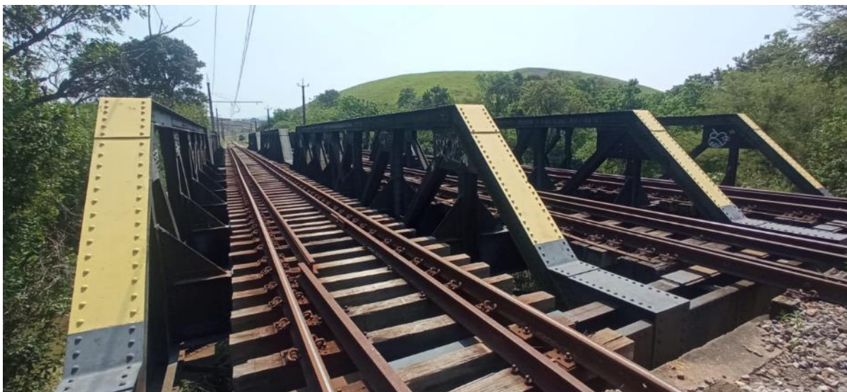
Figuras 54, 55, 56 e 57. Viaduto sobre o Rio Santana. Neste trecho já há linha implementada que poderá ser compartilhada com a proposta.
