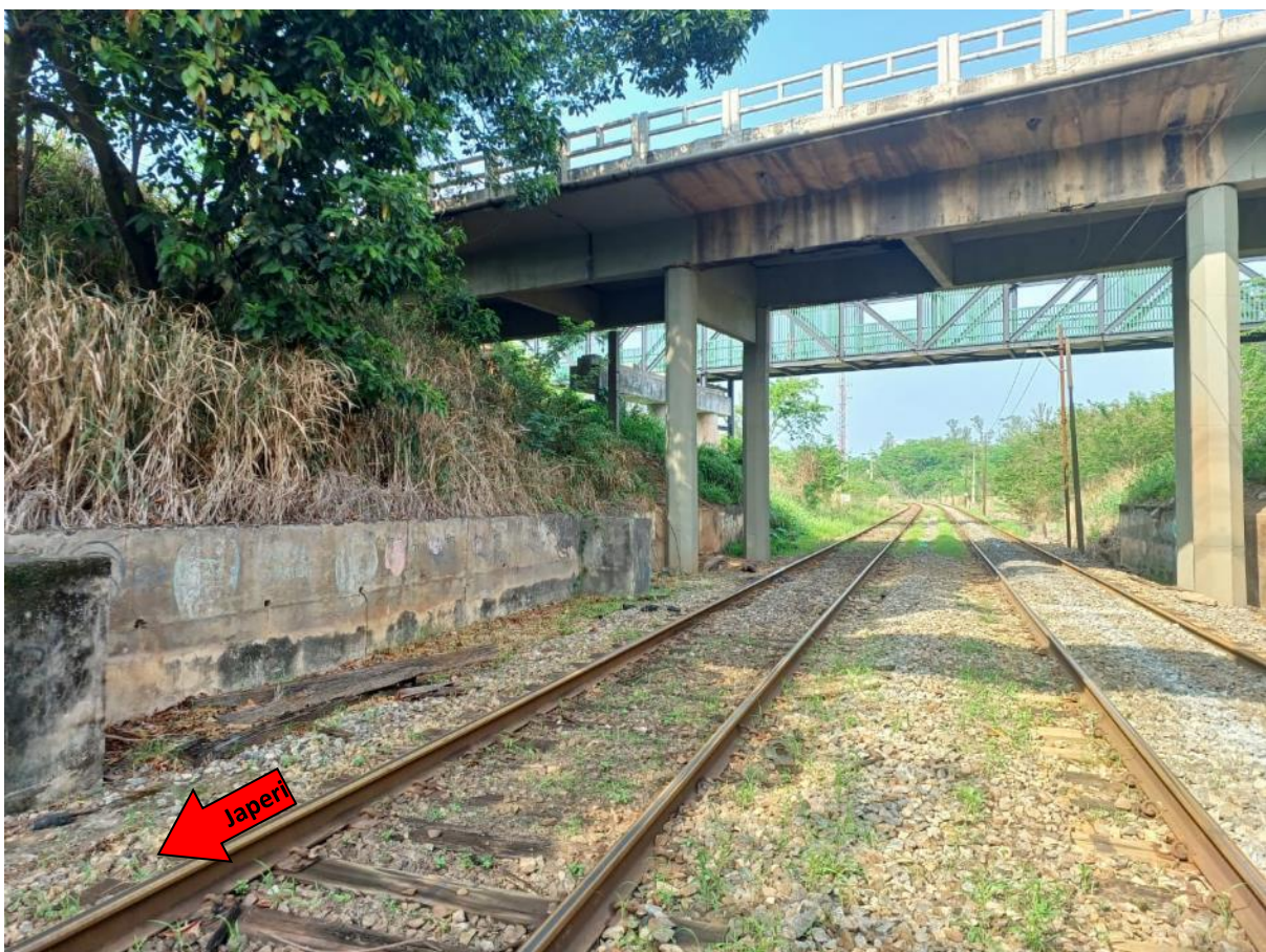
Figura 11. Vista sob viadutos da Rodovia BR-465 e ciclovia em Seropédica (RJ).
