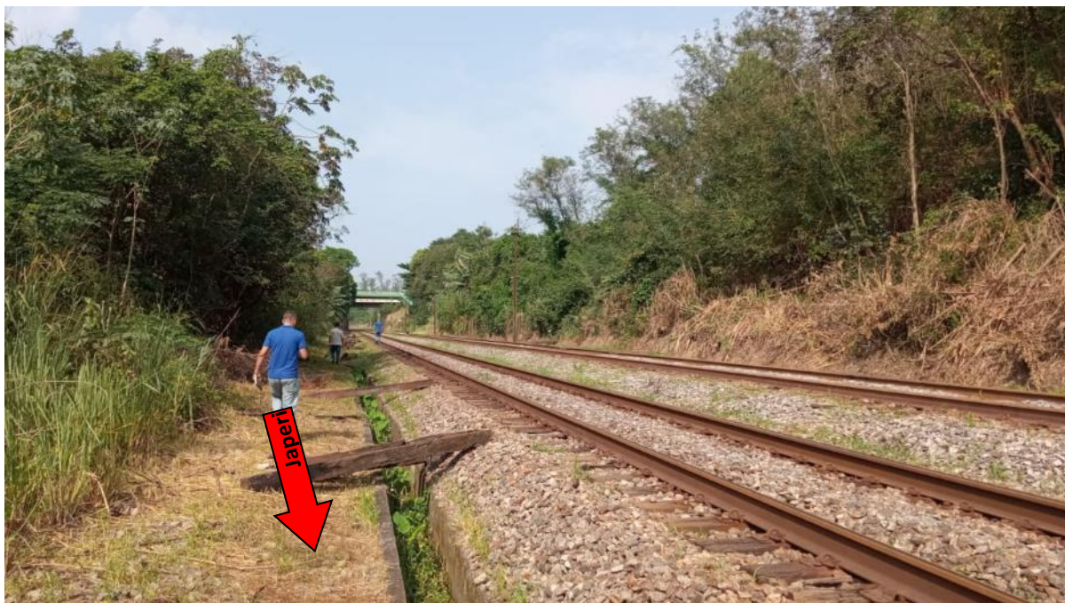
Figura 14. Trecho da linha férrea entre o cruzamento em nível na Rua Marquês Valença e os viadutos da Rodovia BR-465.
