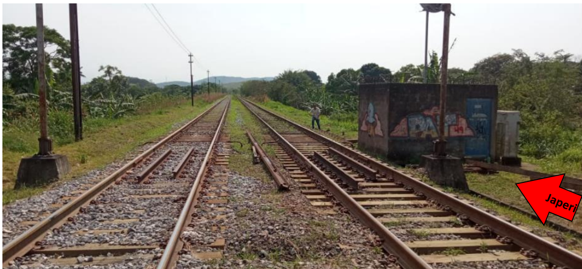
Figura 22. Vista para norte (sentido Japeri) a partir do cruzamento em nível sobre a Rua 31 (Seropédica). Na margem onde se propõe o estabelecimento da nova linha há uma estrutura de operacional de alvenaria que precisará ser deslocada.
