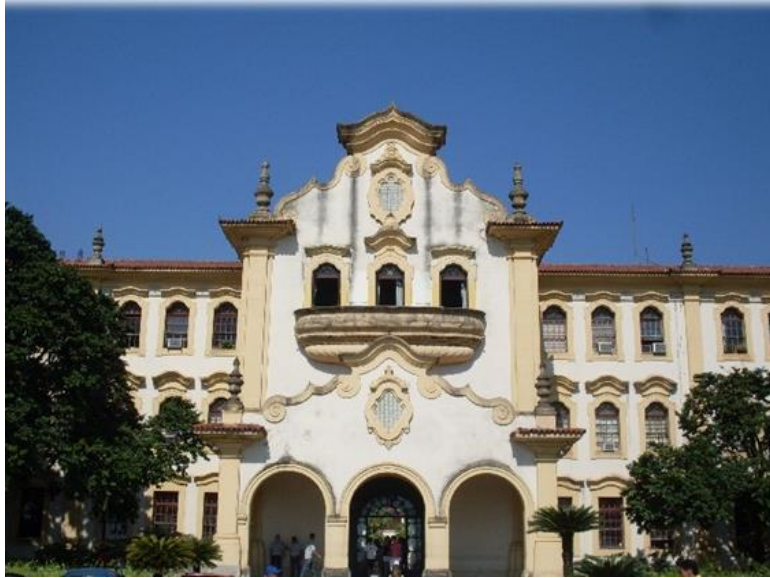
Figura 8 - Fachada do prédio principal (P1) da UFRRJ.
