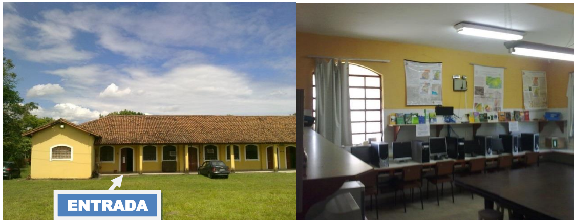
Figura 15 - (Esquerda) Localização do LGA - Prédio anexo ao DEGEO. (Direita) Vista do interior do LGA com seus computadores utilizados por alunos e pesquisadores para aulas práticas, pesquisa e extensão universitária.
