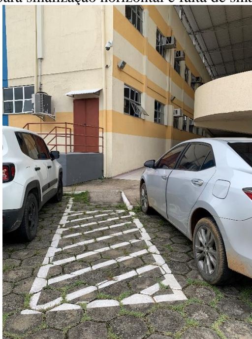
Figura 25: Estacionamento do ITR com sinalização horizontal parcial, demarcando o espaço adicional de circulação entre vagas reservadas, e ausência de pintura demarcando a vaga e sinalização vertical
