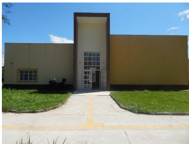
Figuras 55, 56, 57 e 58: Sinalização tátil no piso em circulação externa e interna do Prédio da Biodiversidade
