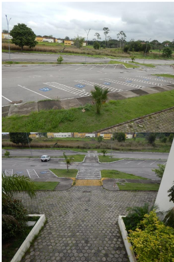
Figuras 26 e 27: Estacionamento com vagas reservadas às pessoas com deficiência no PAT. Destaque para sinalização horizontal e falta de sinalização vertical
