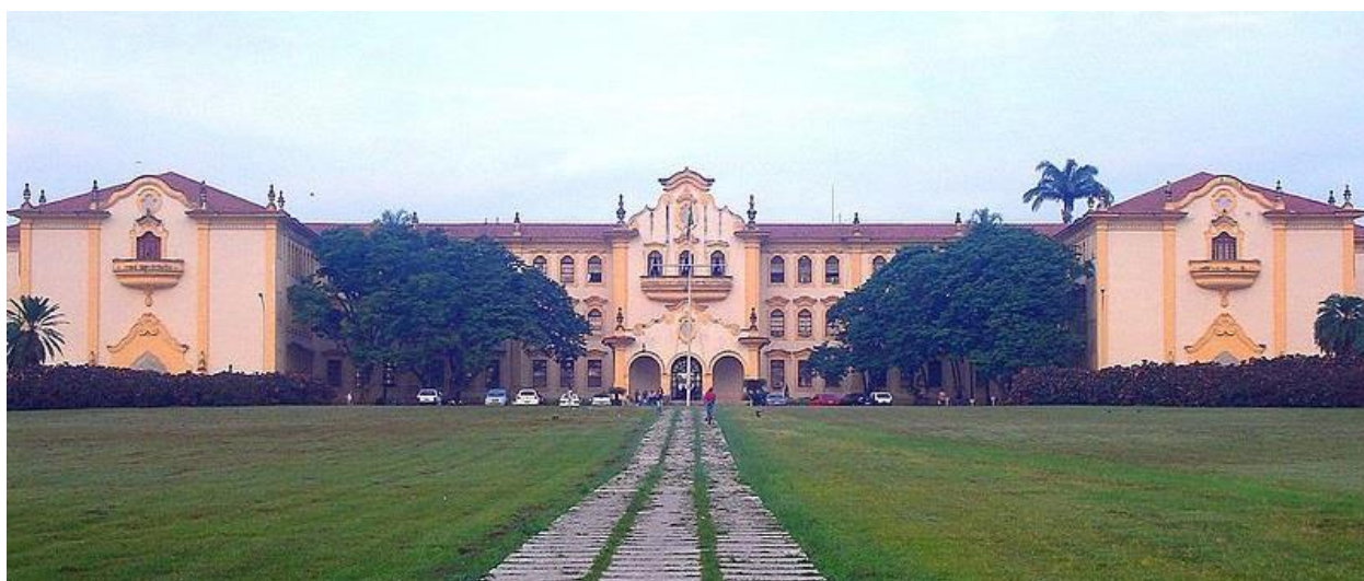
Foto do Prédio Central (P1) – câmpus Seropédica
