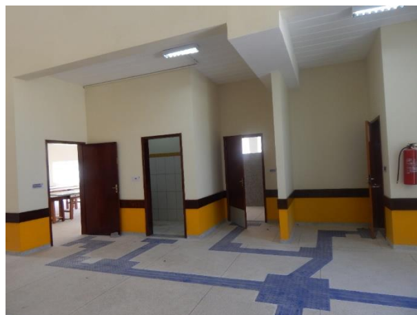
Figuras 59, 60, 61 e 62: Sinalização tátil no piso em circulação externa e interna do PAP - Física 1 e 2
