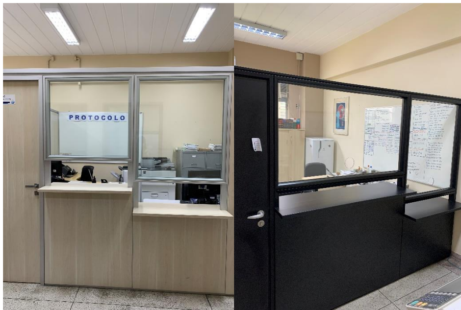
Figuras 52 e 53: Balcão de atendimento com altura acessível para pessoas em cadeira de roda, dos setores de Protocolo e do Núcleo de Prática Jurídica do ITR
