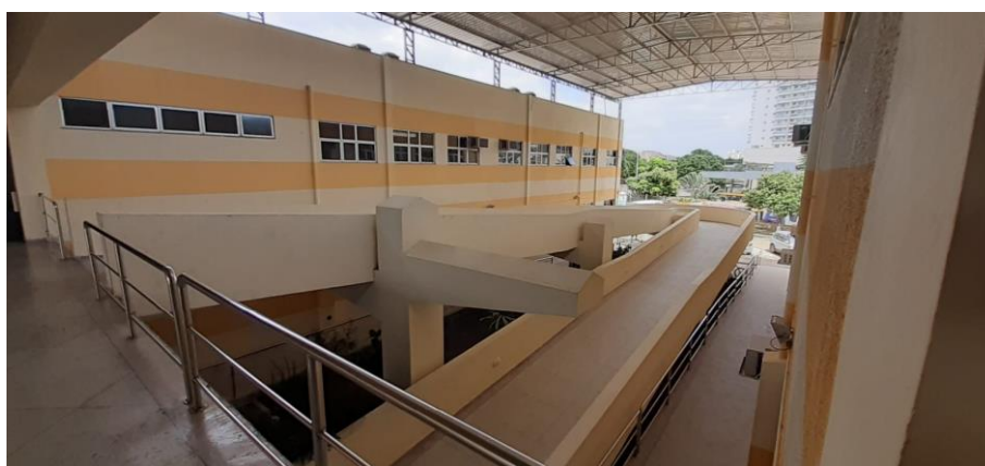
Figuras 14 e 15: Rampas de acesso ao segundo pavimento - Prédio Principal do ITR
