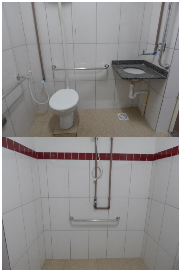
Figuras 44, 45 e 46: Banheiro Acessível – Alojamento
