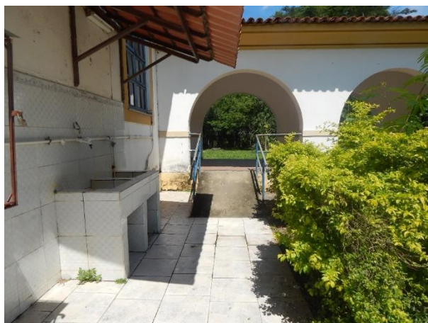
Figuras 17 e 18: Rampas de acesso ao prédio dos Alojamentos
