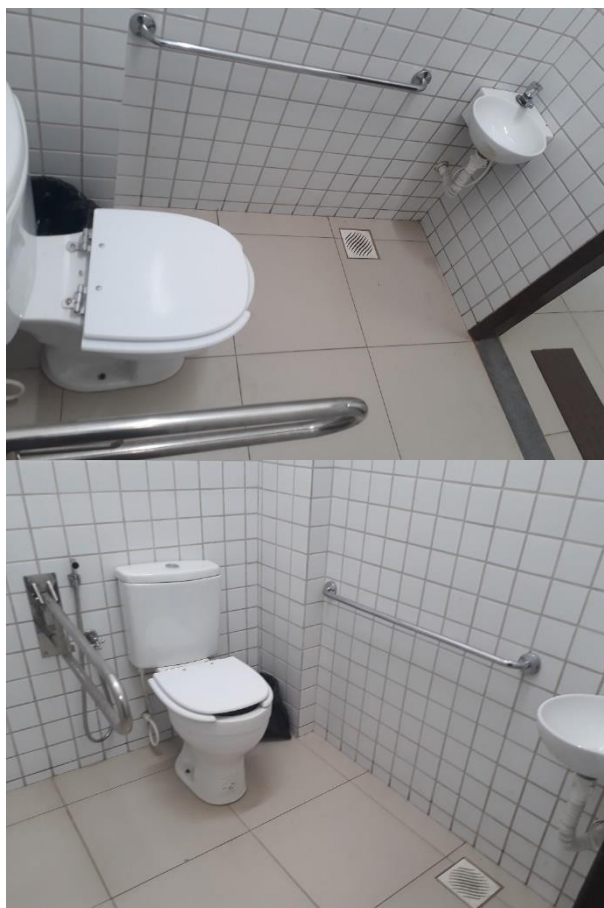
Figuras 32 e 33: Banheiro Acessível - IM
