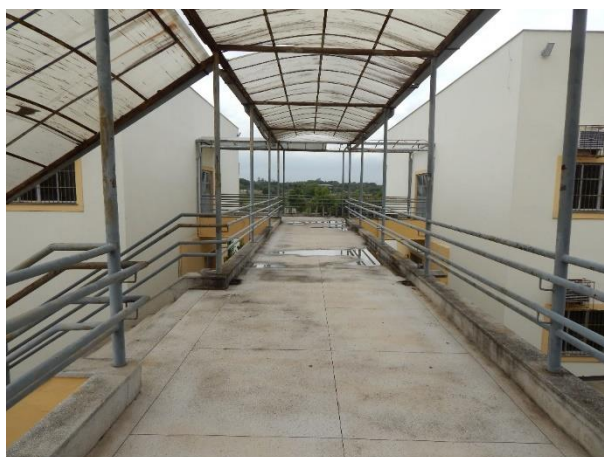
Figuras 18, 19 e 20: Rampas e Circulação - Prédio do PAT
