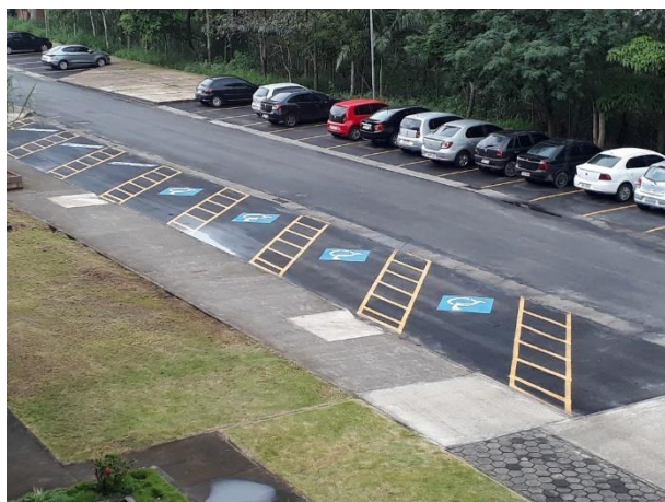
Figura 24: Estacionamento com vagas reservadas à pessoas com deficiência no pátio do IM. Destaque para sinalização horizontal e falta de sinalização vertical
