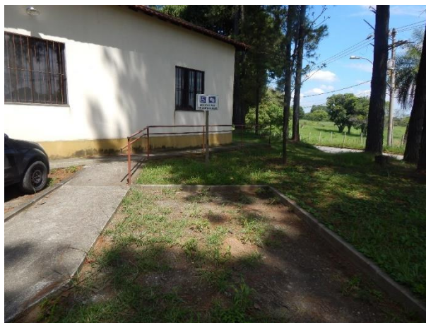
Figura 28: Vaga reservada no prédio da Biodiversidade. Sinalização vertical presente e sinalização horizontal deficitária.
