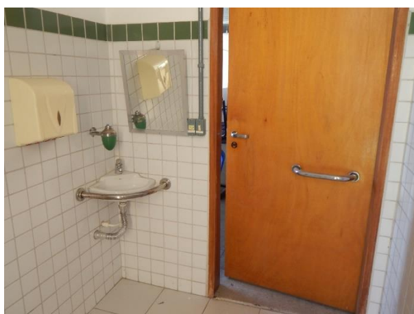
Figuras 35 e 36: Banheiro Acessível - Biblioteca Central
