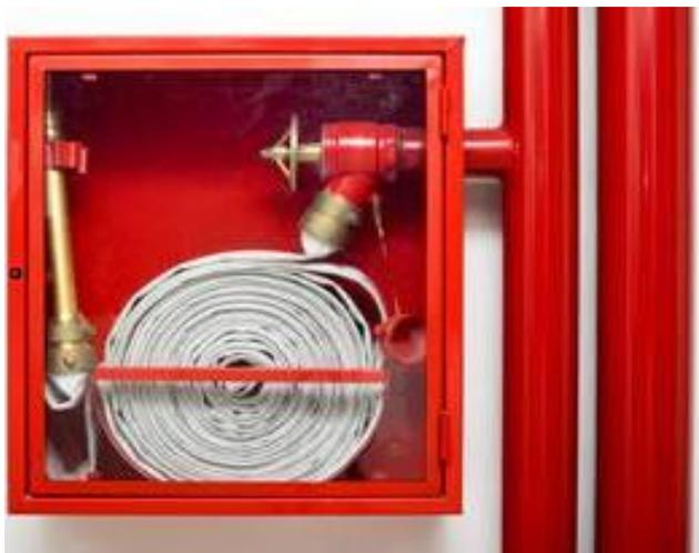
Figura 25 - Hidrante na parede.
