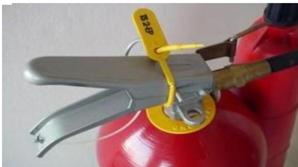
Figura – 16 Anel indica que extintor passou pela recarga (em 2019).
