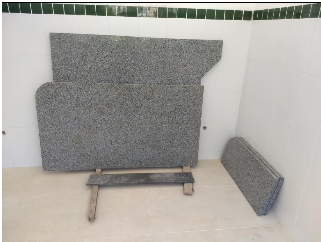
Foto 05 - Entrega do material para o início da instalação das divisórias de granito dos banheiros dos refeitórios nº01 e 02
