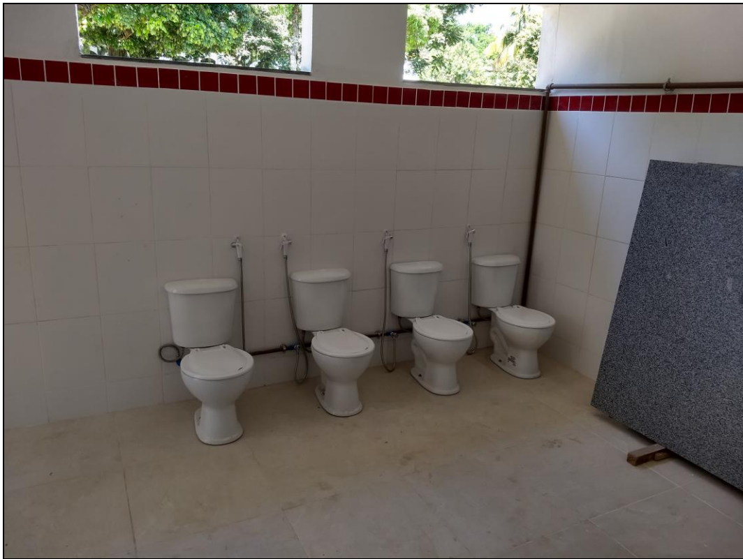
Foto 03 - Instalação dos vasos sanitários dos banheiros dos refeitórios nº01 e 02
