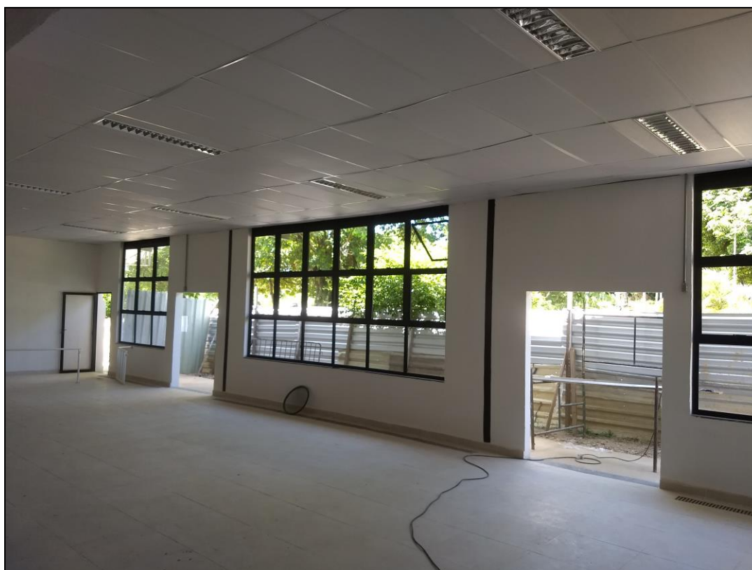
Foto 14 – Vista interna da lateral do refeitório nº 02 com as esquadrias instaladas
