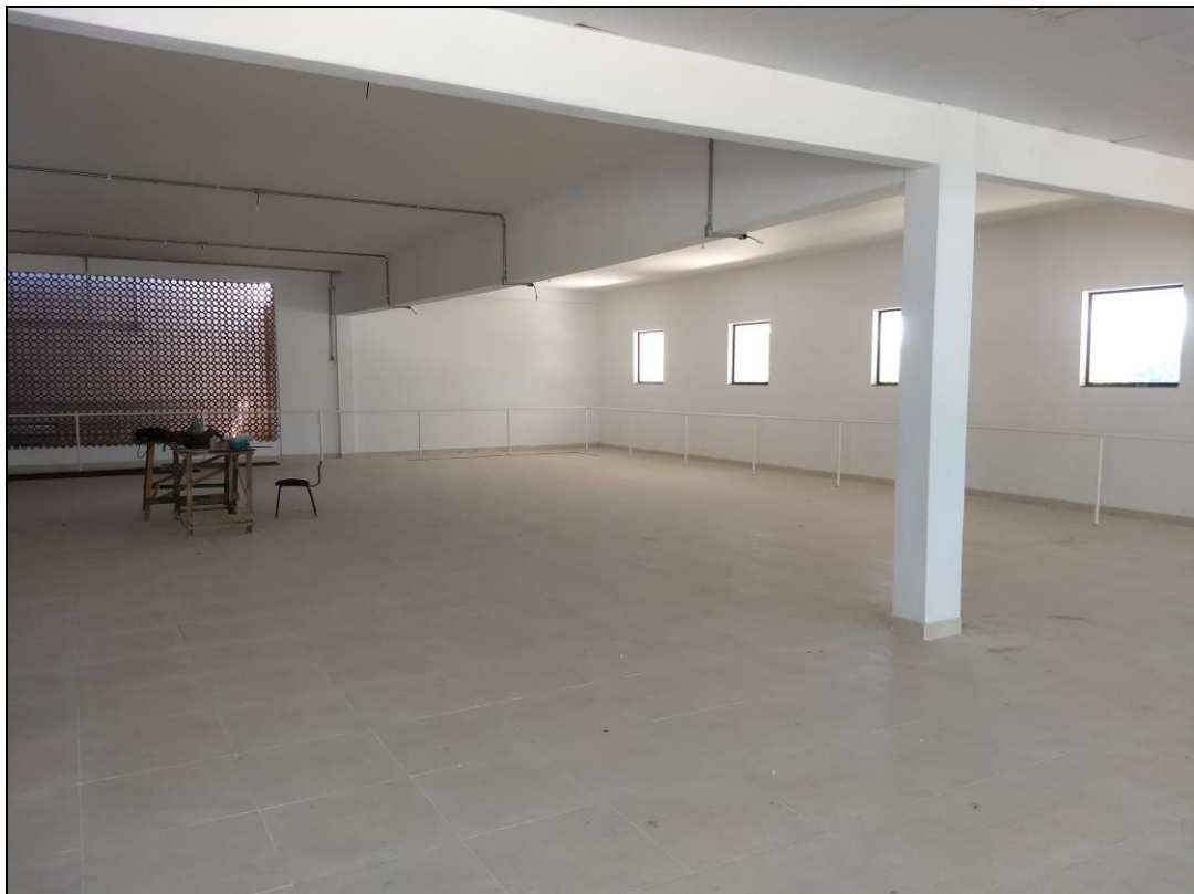
Foto 15 – Vista interna do refeitório nº 02
