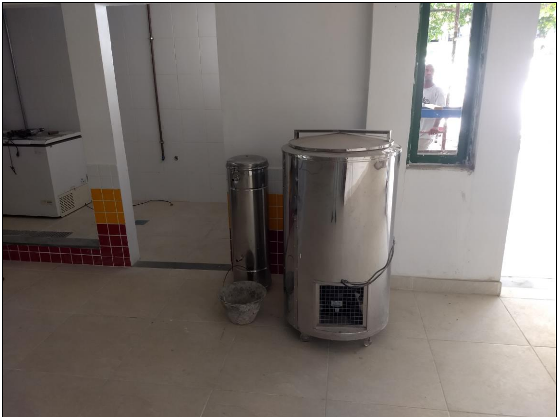
Foto 09 – Equipamento em fase de instalação na área de distribuição de sucos
