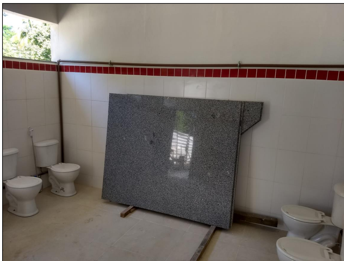
Foto 06 - Entrega do material para o início da instalação das divisórias de granito dos banheiros dos refeitórios nº01 e 02
