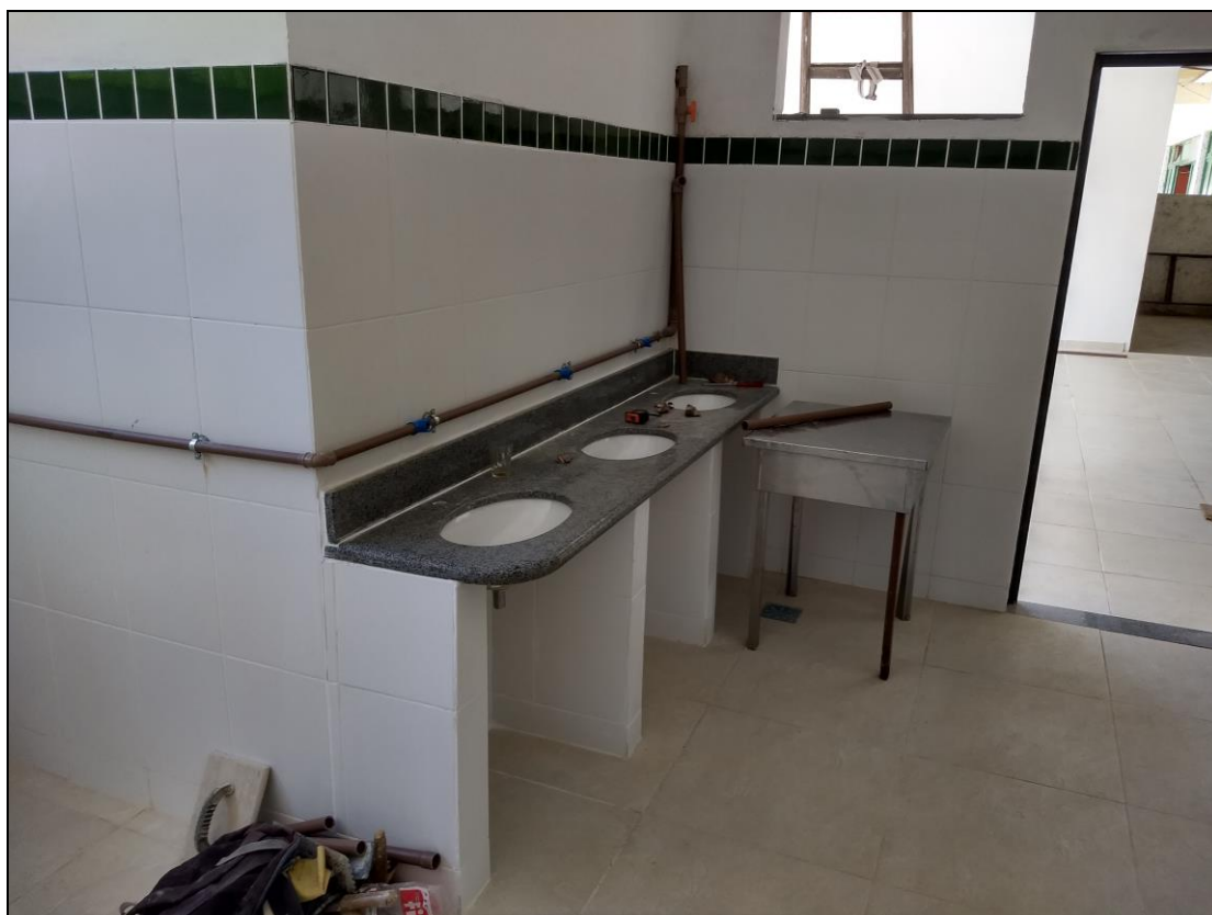
Foto 2 - Finalização da instalação das pias de lavar as mãos dos banheiros dos refeitórios nº01 e 02
