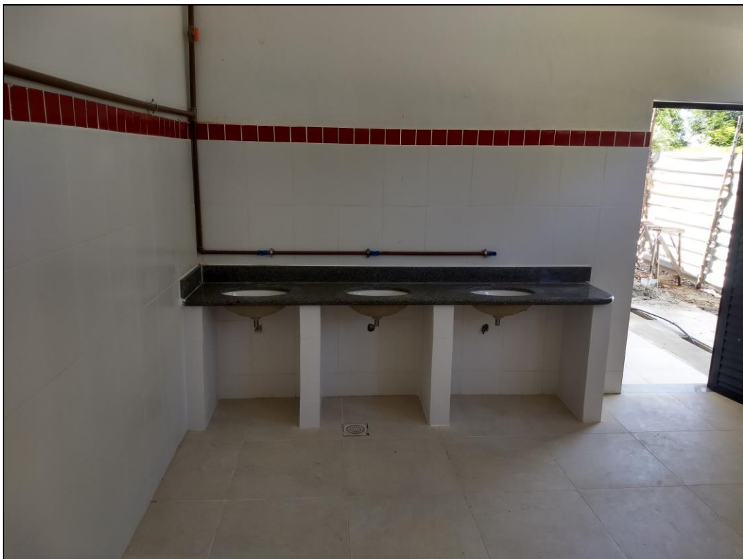
Foto 4 - Finalização da instalação das pias de lavar as mãos dos banheiros dos refeitórios nº01 e 02
