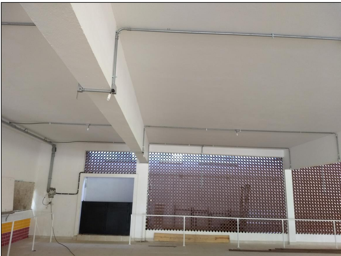
Foto 10 – Continuidade da instalação elétrica do refeitório n° 02
