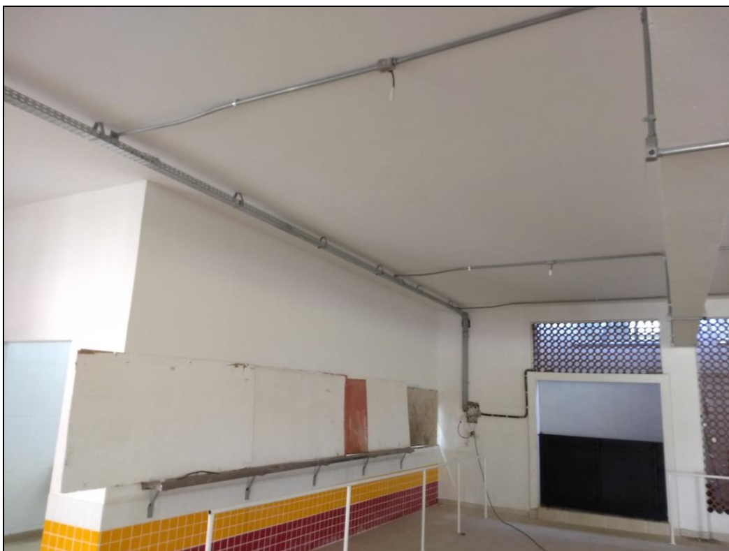
Foto 11 – Continuidade da instalação elétrica do refeitório n° 02
