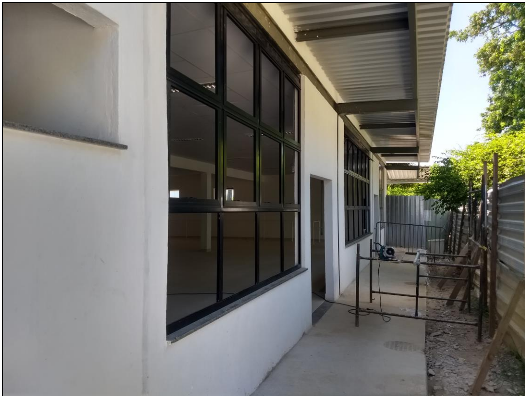
Foto 15 – Vista externa da lateral do refeitório nº 02 com as esquadrias instaladas
