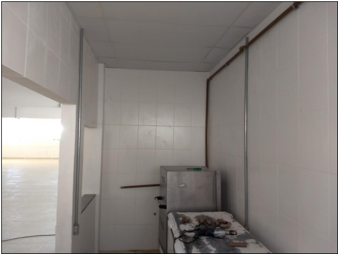
Foto 07 - Instalação da rede hidráulica da área de distribuição de sucos
