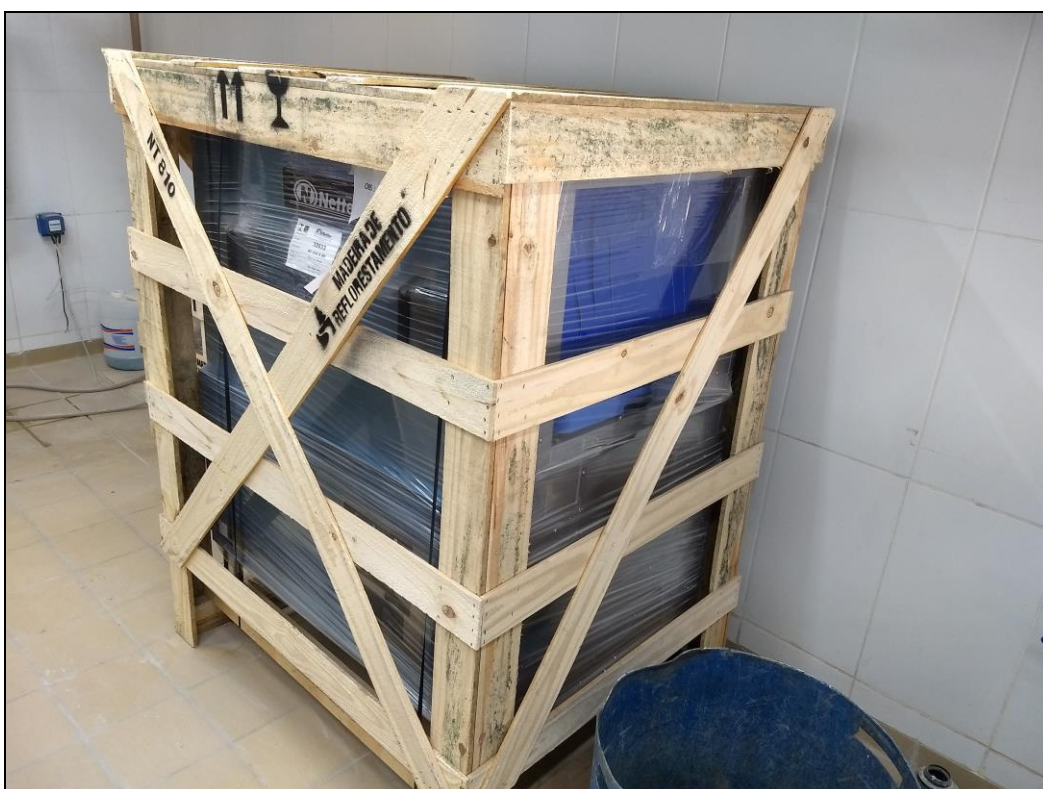
Foto 12 – Máquina de lavar bandejas industrial nova n° 1 posicionada para instalação
