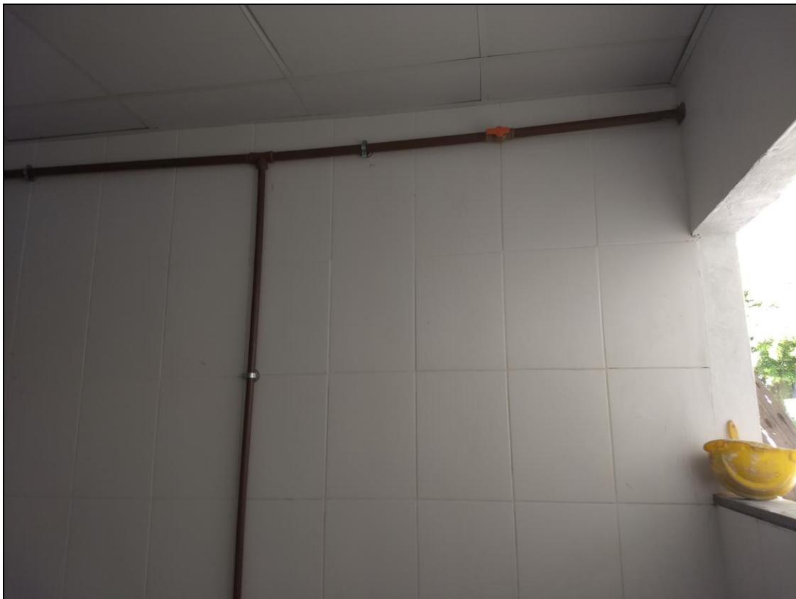
Foto 08 - Instalação da rede hidráulica da área de distribuição de sucos
