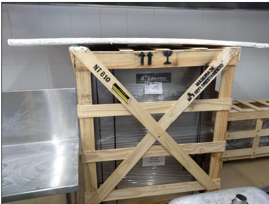
Foto 13 – Máquina de lavar bandejas industrial nova nº 2 posicionada para instalação
