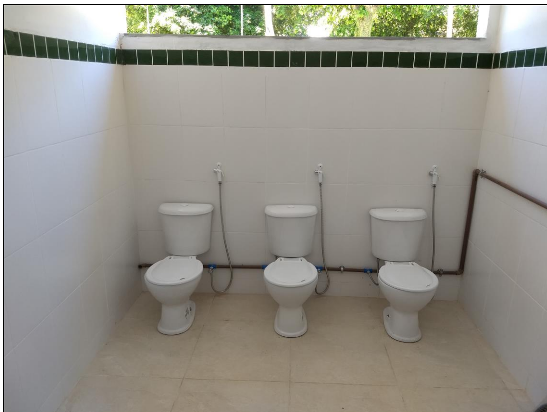
Foto 01 - Instalação dos vasos sanitários dos banheiros dos refeitórios nº01 e 02
