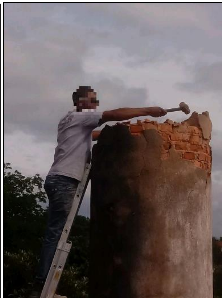
ANEXO 21 – Fotos da retirada da antiga chaminé que estava desabando, e reparo no telhado sobre o salão de capoeira Angolinha:
