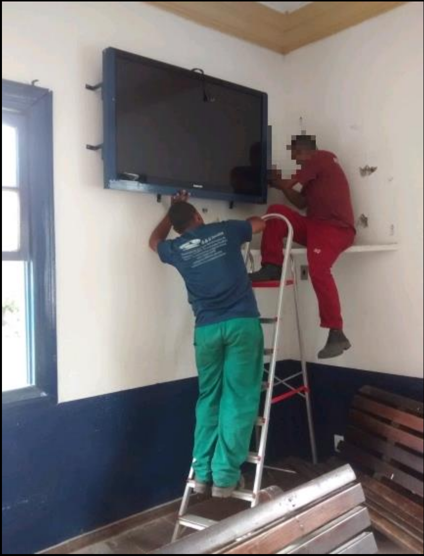
ANEXO 17 – Foto da confecção de suporte de proteção e instalação de TV na Sala de TV pelos profissionais da empresa SM21:
