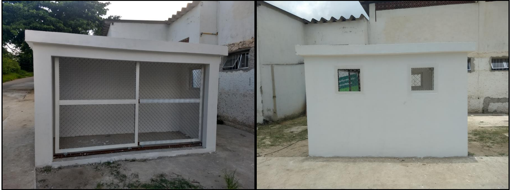
Fotos 34 e 35 – Casa de gás externa
