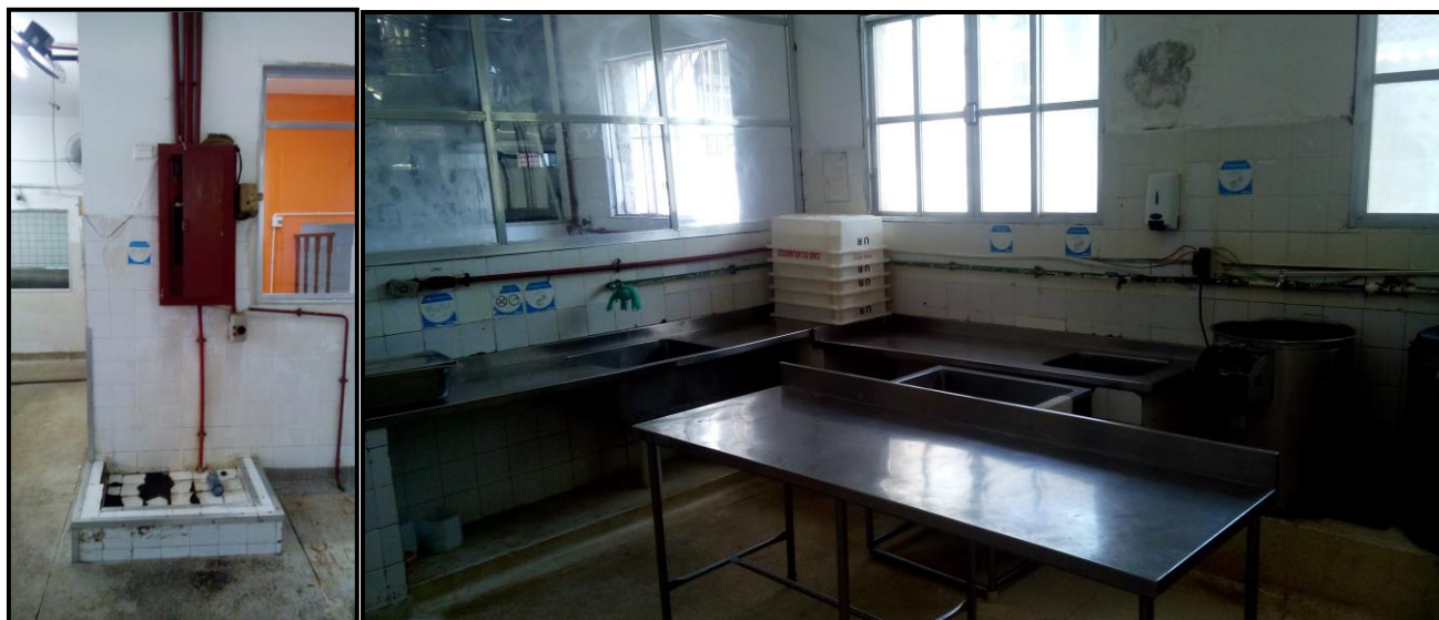
Fotos 19, 20, 21 e 22 – Cozinha do RU antes da reforma
