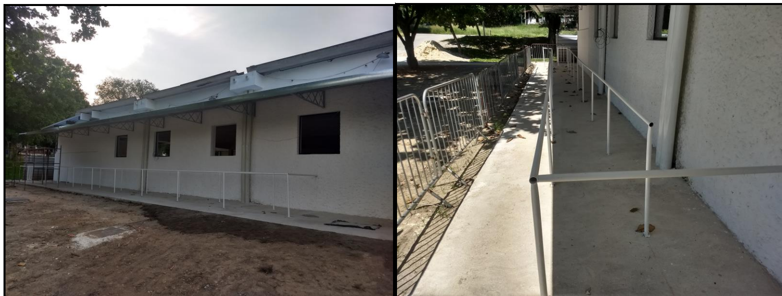
Fotos 30, 31, 32, 33 – RU após a conclusão da 1ª etapa da reforma
