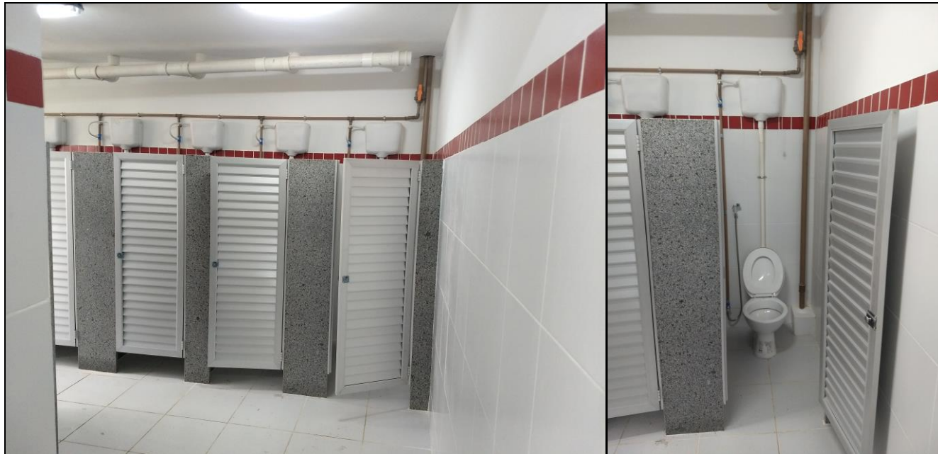
Foto 1 e 2 – Sanitários com divisórias e portas de alumínio
