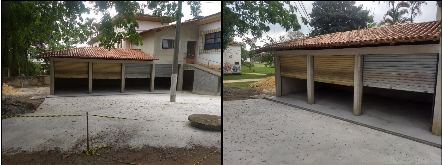
Fotos 3 e 4 – Serviços em fase de finalização
