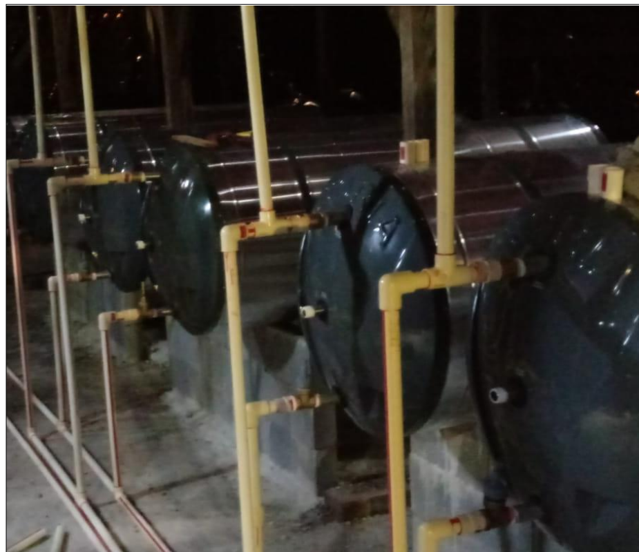
Fotos 3 e 4 – Finalização dos serviços de instalação dos Boilers
