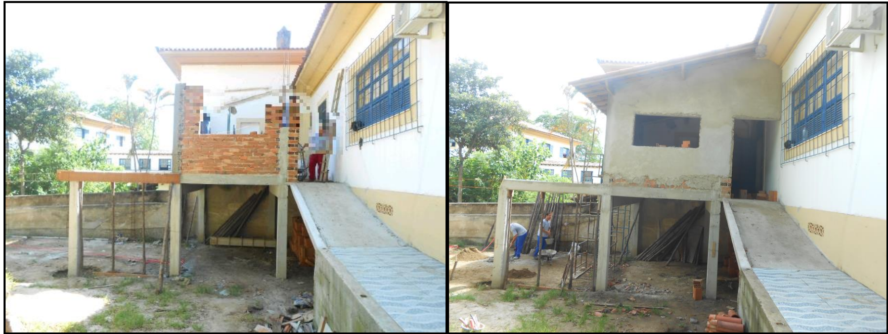
Foto 1 e 2 – Início dos serviços
