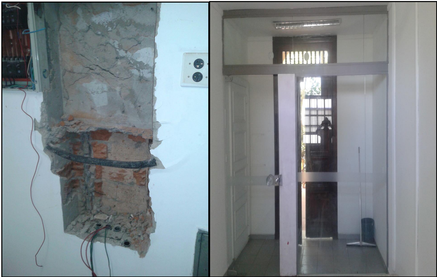
Fotos 1 e 2 – Antes dos serviços de reparo e adaptação
