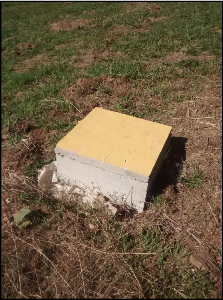
ANEXO 12 – Foto de uma das 06 caixas para a passagem da fibra ótica para internet dos alojamentos construída pelos profissionais da empresa SM21:
