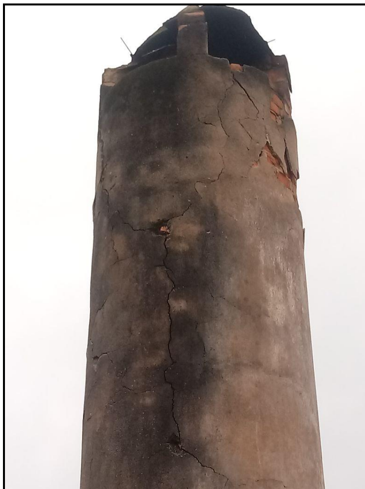
ANEXO 21 – Fotos da retirada da antiga chaminé que estava desabando, e reparo no telhado sobre o salão de capoeira Angolinha:
