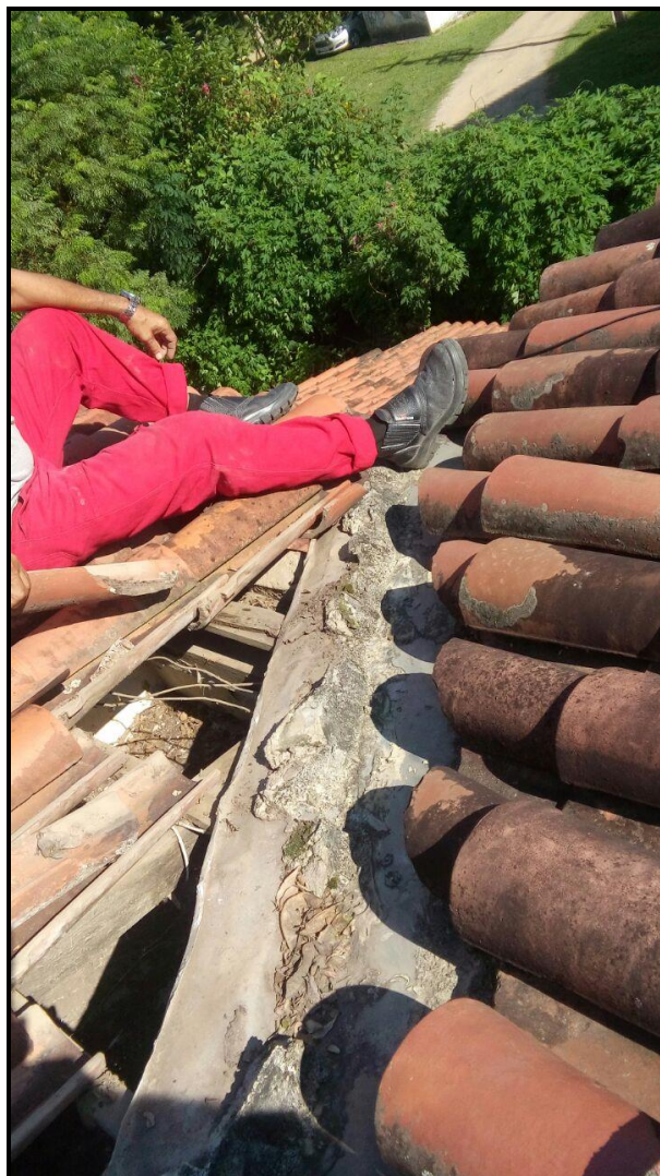
ANEXO 19 – Foto da execução de reparo do telhado da Atlética Central pelos profissionais da empresa SM21:
