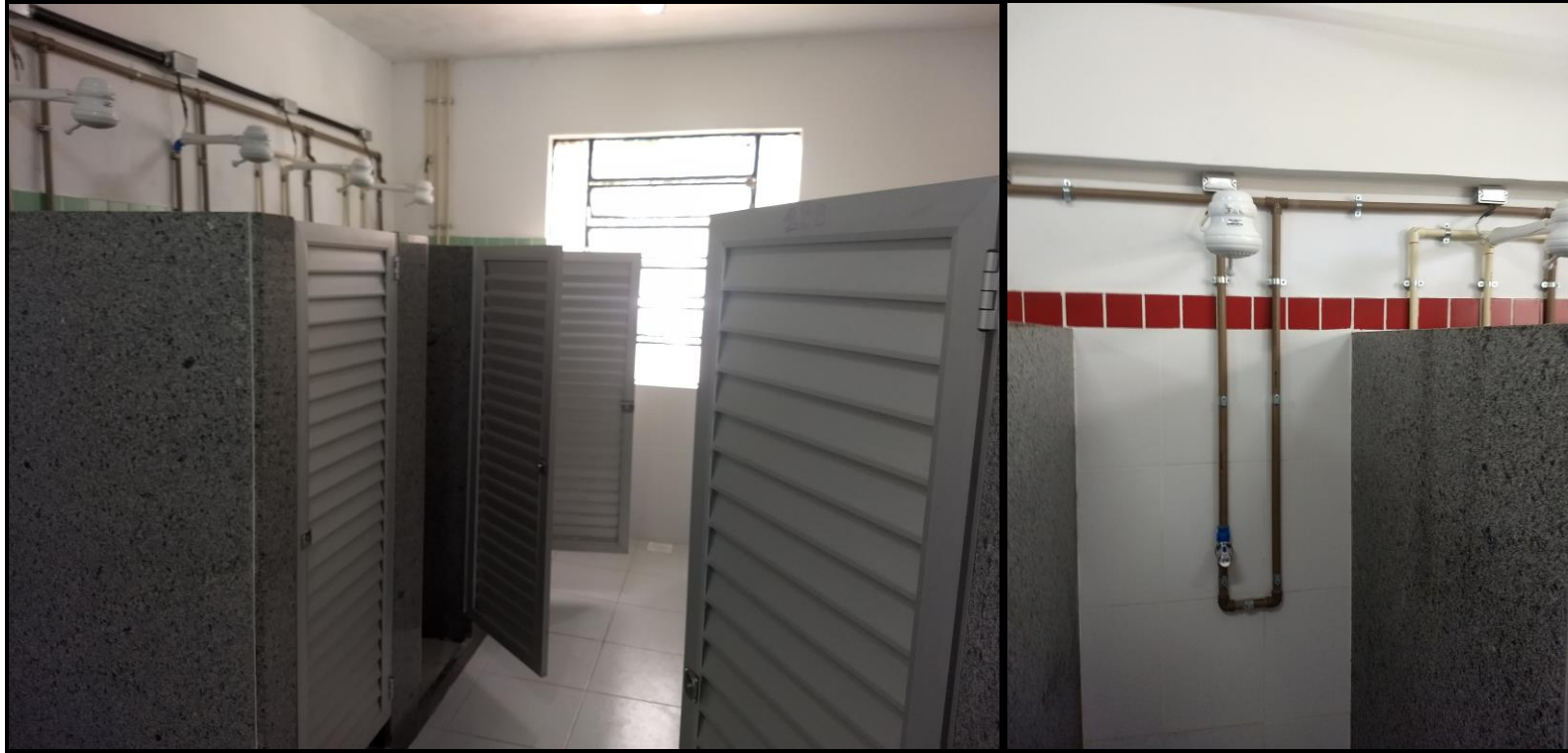
Fotos 3 e 4 – Área dos chuveiros com divisórias de granito e portas de alumínio
