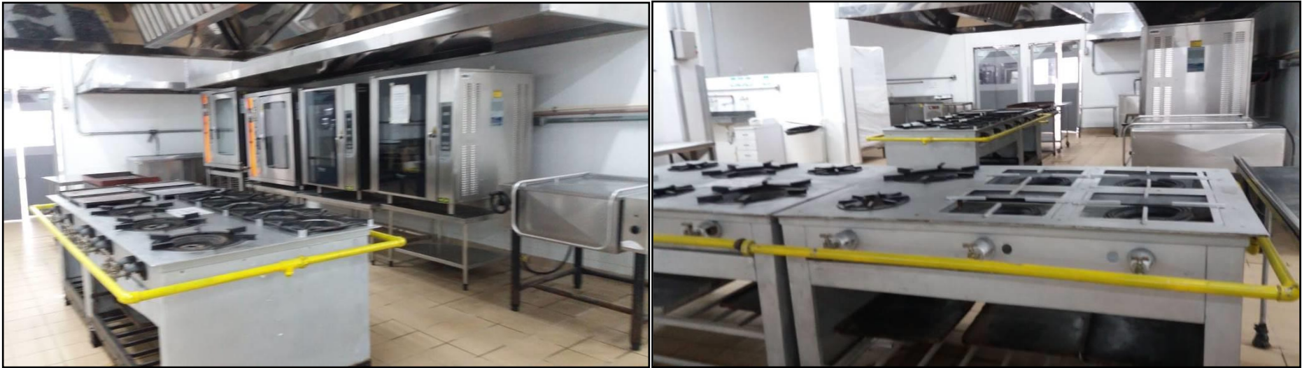
Fotos 1 e 2 – Fogão reformado e instalado na cozinha do RU
