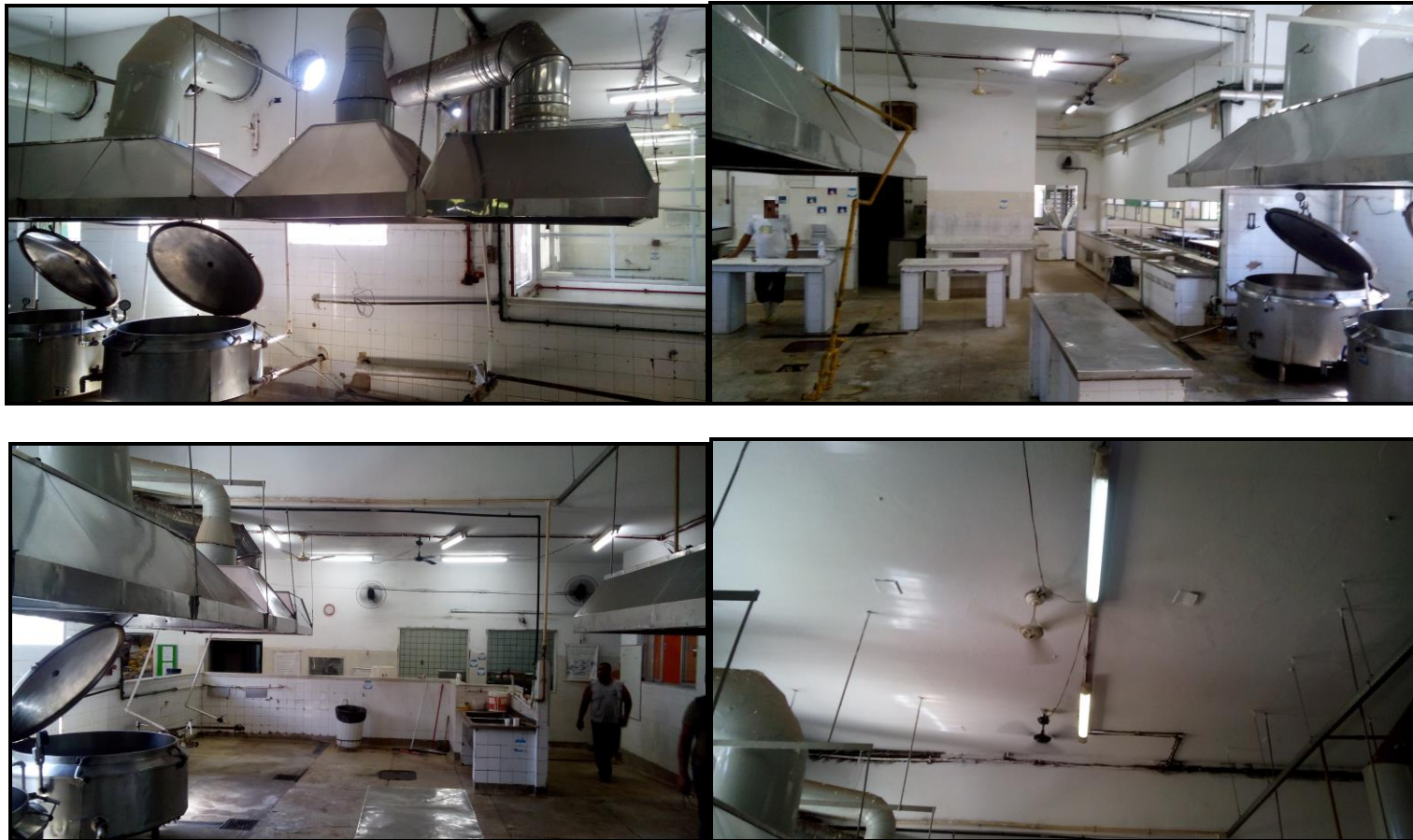
Fotos 1, 2, 3 e 4 – Cozinha do RU antes da reforma
