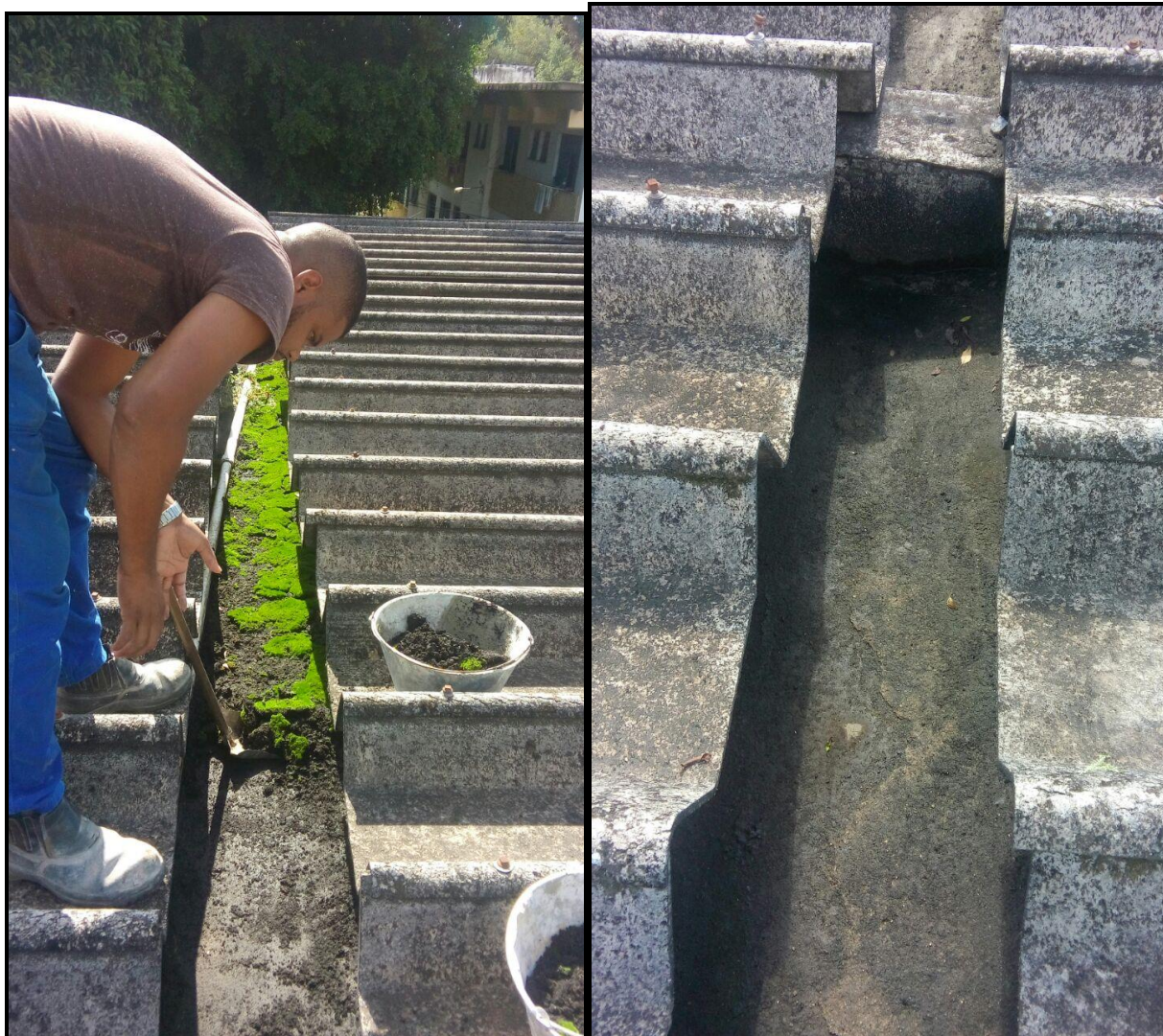
ANEXO 13 – Fotos da execução da limpeza das calhas dos alojamentos femininos pelos profissionais da empresa SM21:
