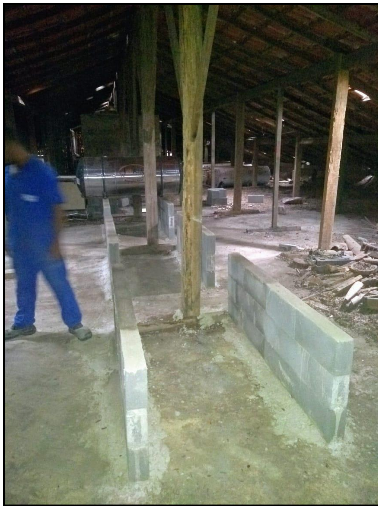
Fotos 1 e 2 – Início dos serviços de instalação dos Boilers
