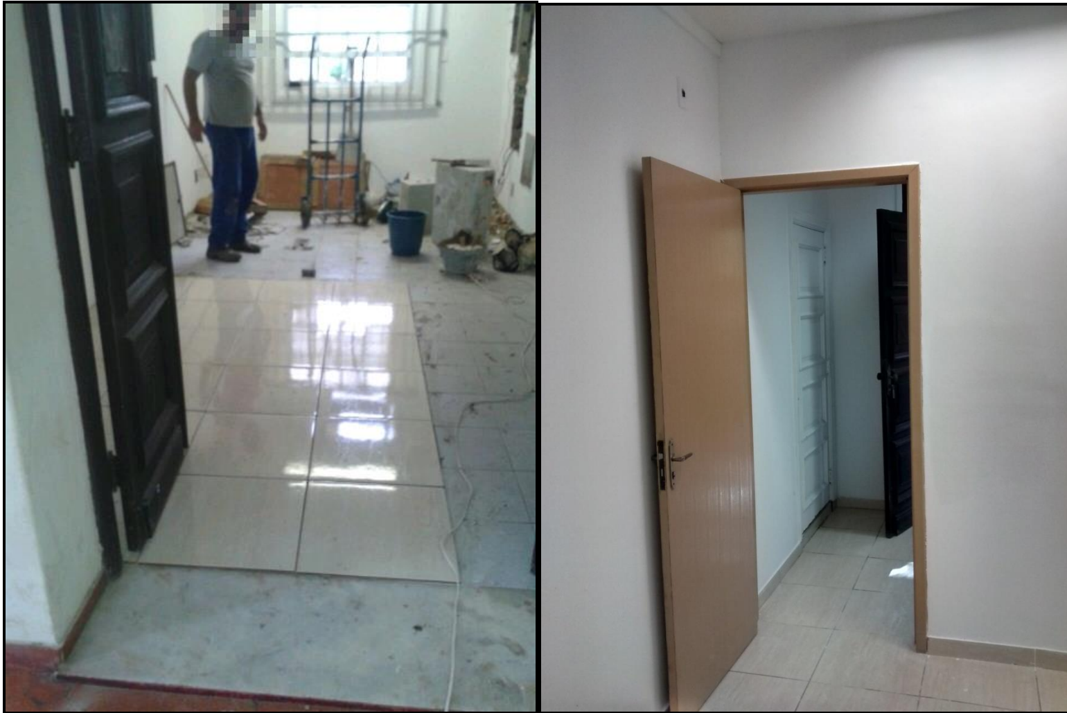
Foto 3 e 4 – Durante e depois dos serviços de reparo e adaptação
