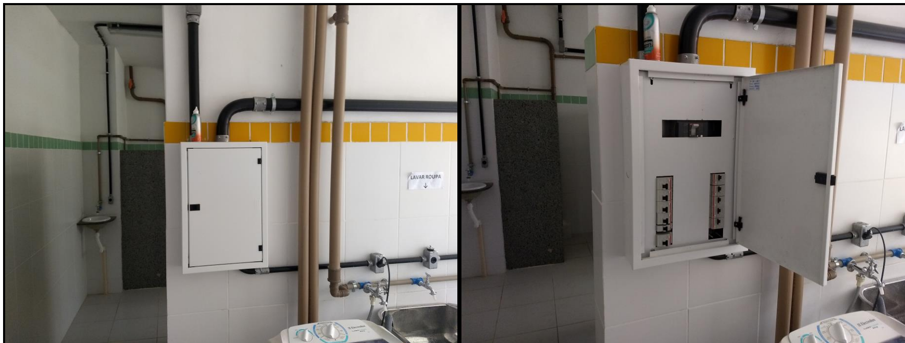
Fotos 7 e 8 – Caixas de centrais de distribuição elétrica instaladas na entrada dos banheiros
