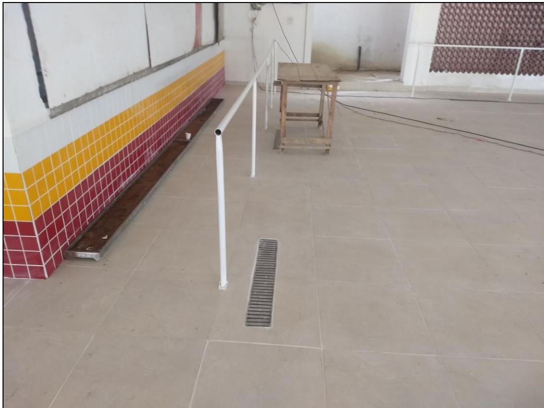
Foto 09 - Execução da estrutura metálica para a organização das filas externas e internas ao refeitório nº02.
