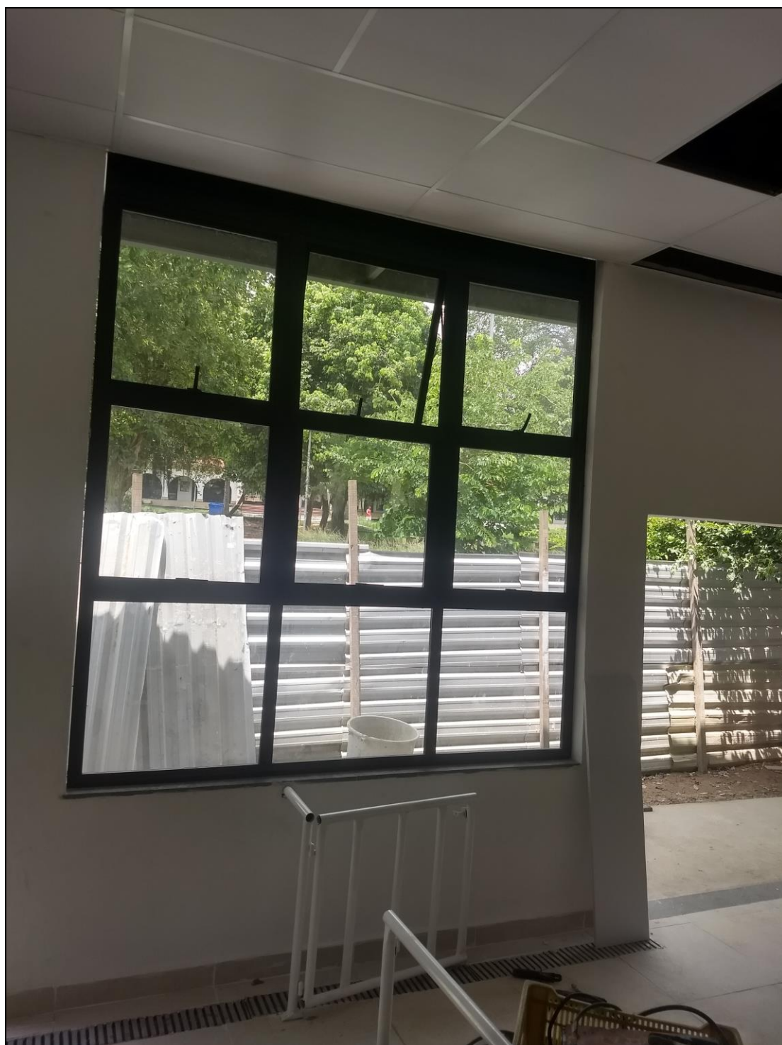
Foto 04 - Início da instalação das janelas e esquadrias do refeitório n° 02.
