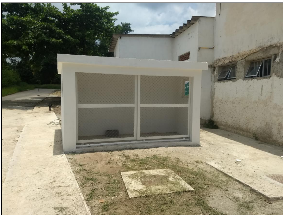
Foto 14 - Finalização da construção da casa externa para armazenamento dos botijões de gás.
