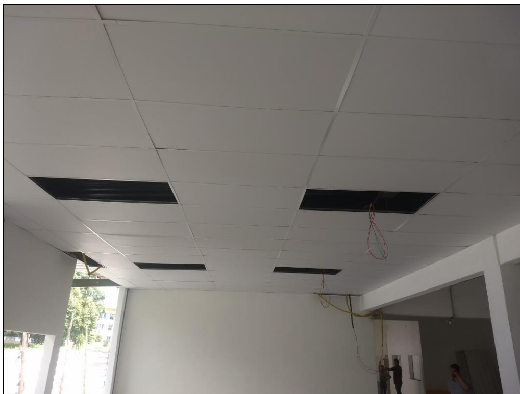
Foto 01 - Instalação do forro da área de ampliação do refeitório nº02.
