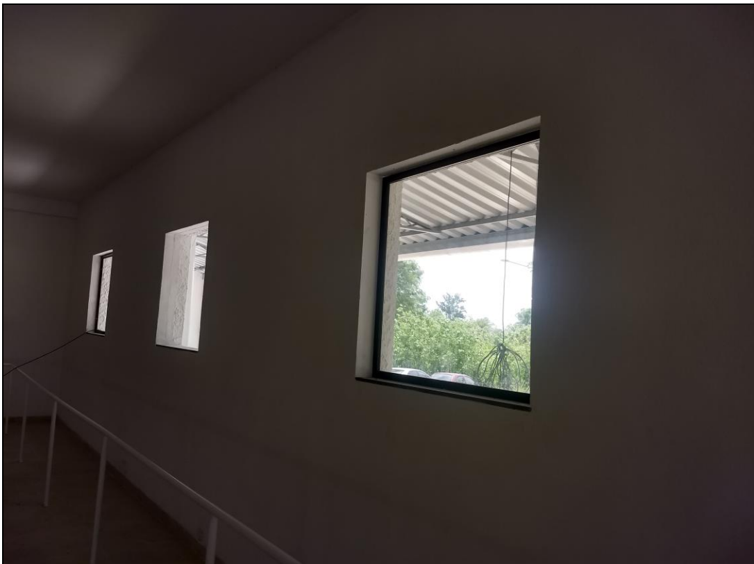
Foto 06 - Início da instalação das janelas e esquadrias do refeitório n° 02.
