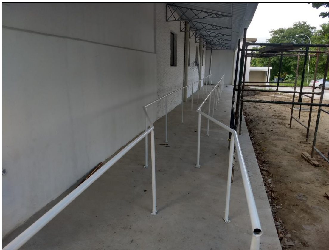
Foto 07 - Execução da estrutura metálica para a organização das filas externas e internas ao refeitório nº02.
