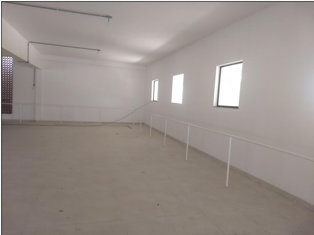
Foto 05 - Início da instalação das janelas e esquadrias do refeitório n° 02.
