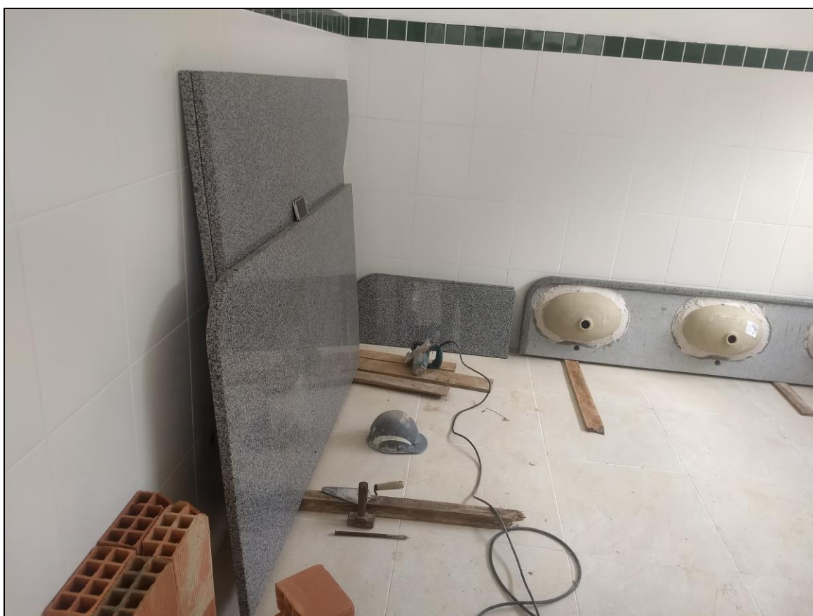
Foto 12 - Início da colocação das divisórias de granito e bancadas dos banheiros externos aos salões nº 01 e 02.
