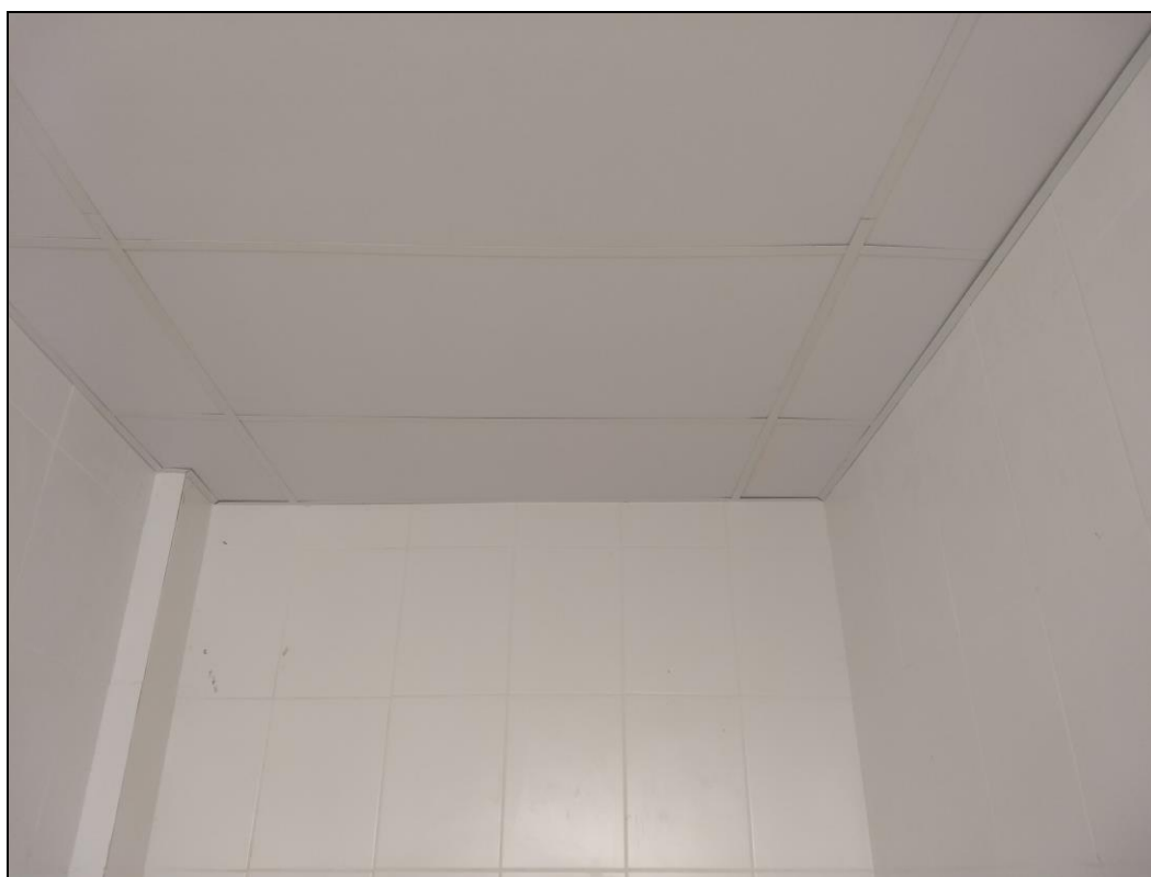
Foto 02 - Instalação do forro da área de ampliação do refeitório nº02.
