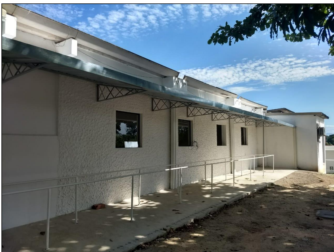
Foto 18 – Vista da lateral do refeitório nº 02, com calçada, organizador de filas e cobertura instalados.
