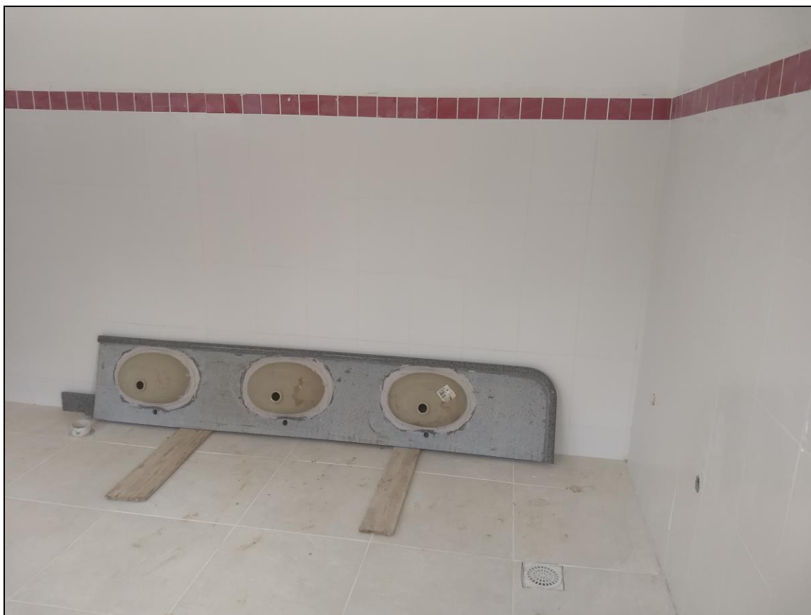
Foto 13 - Início da colocação das divisórias de granito e bancadas dos banheiros externos aos salões nº 01 e 02.
