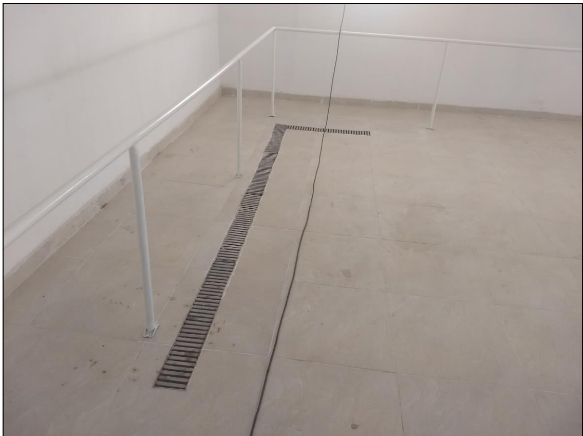
Foto 10 - Instalação das grades metálicas de proteção aos ralos de escoamento do refeitório nº02.
