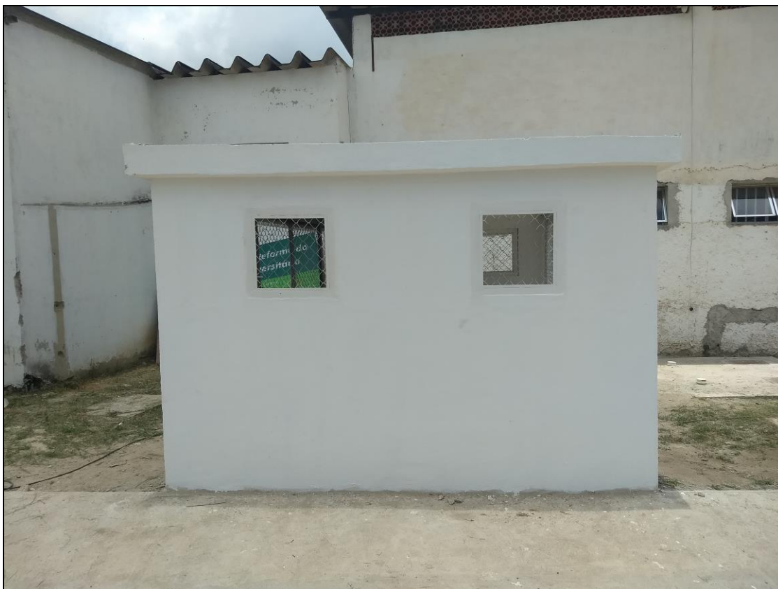
Foto 15 - Finalização da construção da casa externa para armazenamento dos botijões de gás.
