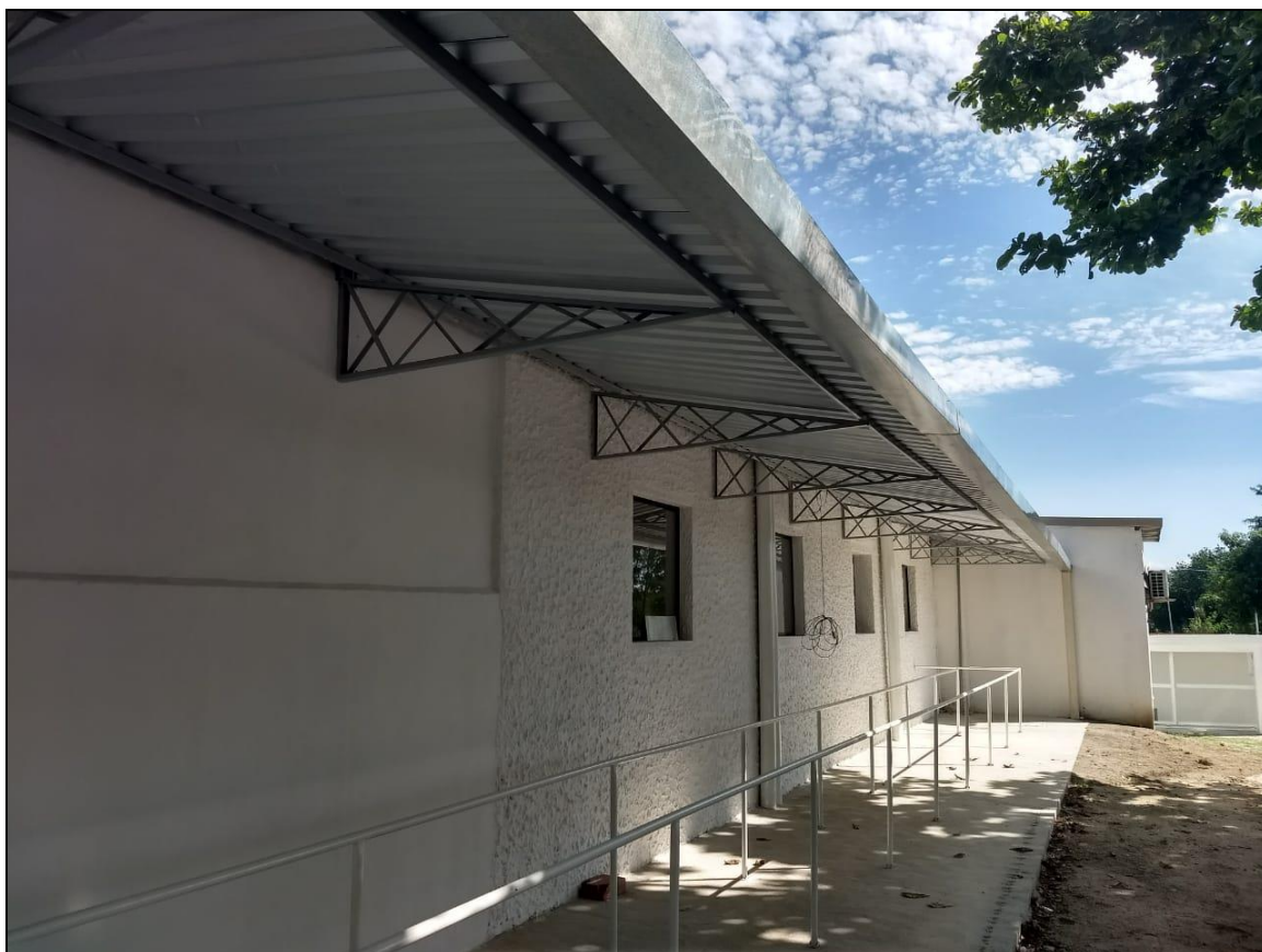
Foto 17 – Vista da lateral do refeitório nº 02, com calçada, organizador de filas e cobertura instalados.
