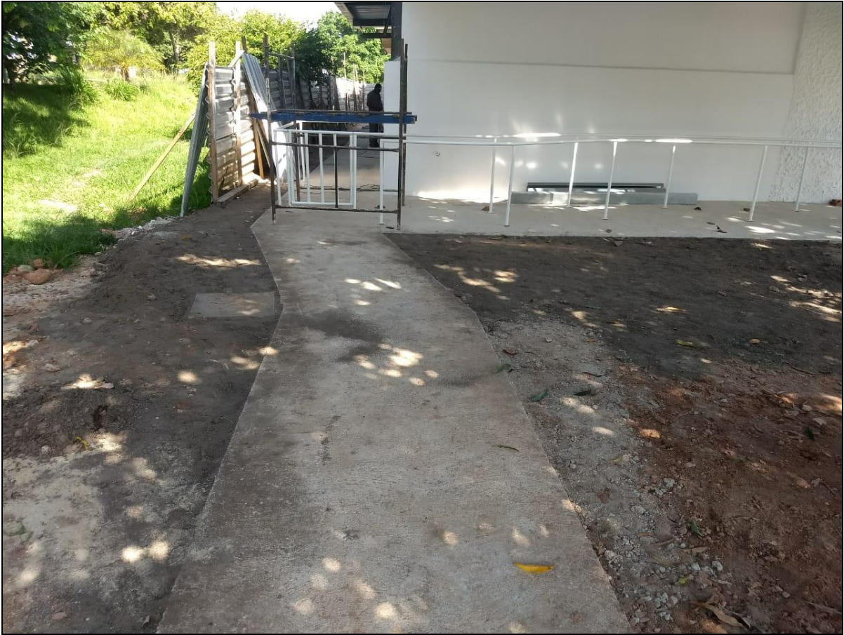
Foto 23 – Vista da calçada de acesso à entrada do refeitório nº 02.
