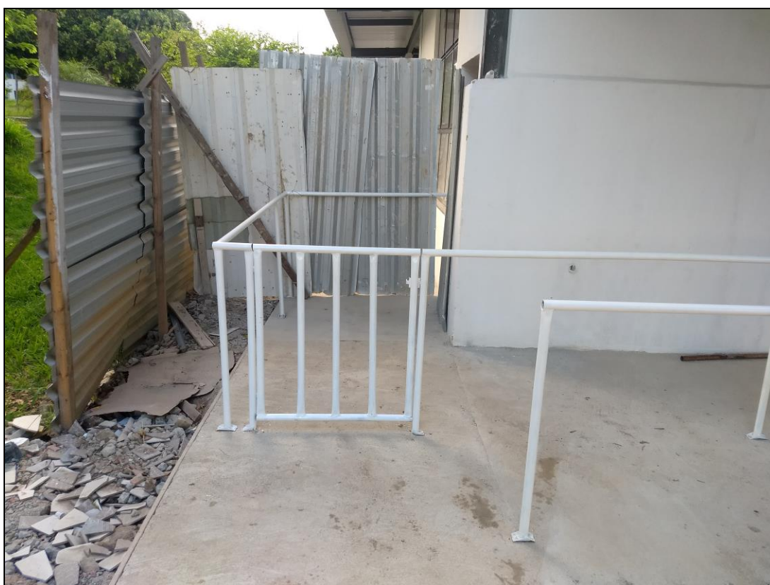
Foto 08 - Execução da estrutura metálica para a organização das filas externas e internas ao refeitório nº02.
