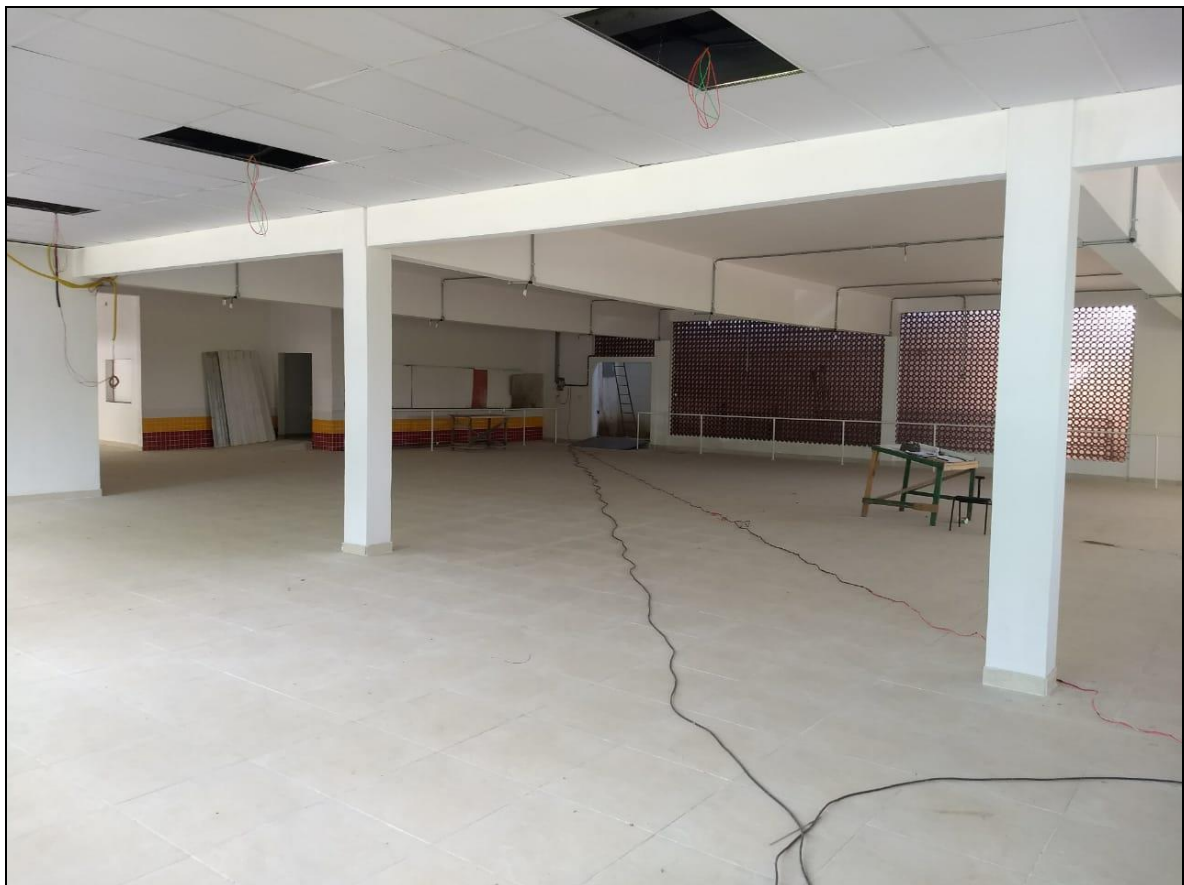
Foto 20 – Vista interna do refeitório nº 02
