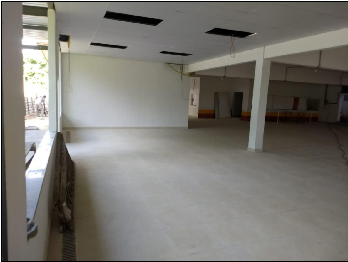
Foto 19 – Vista interna do refeitório nº 02
