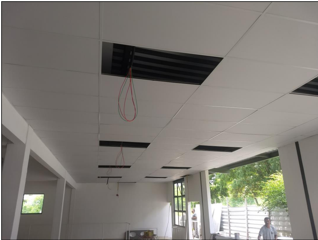
Foto 03 - Instalação do forro da área de ampliação do refeitório nº02.
