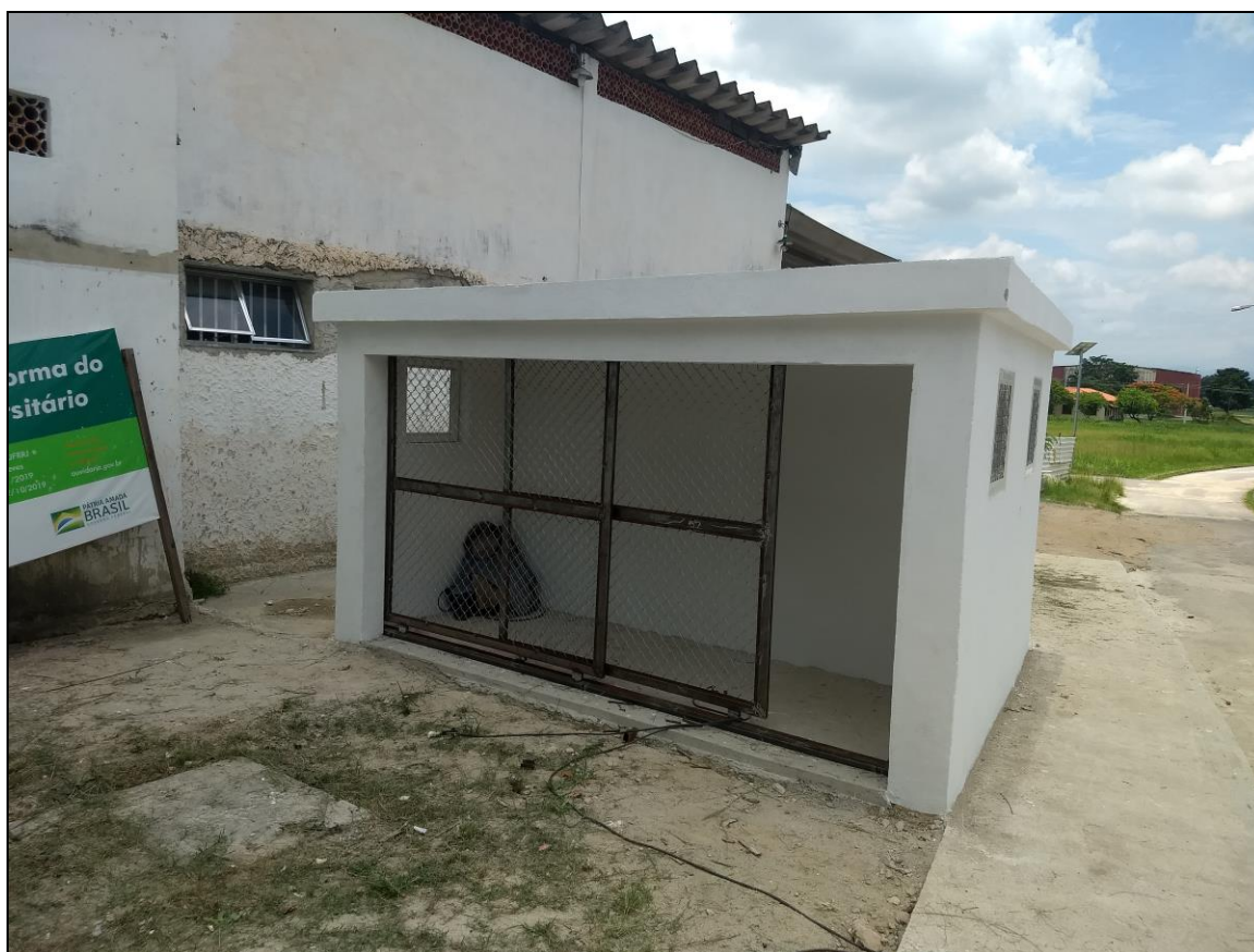
Foto 16 - Finalização da construção da casa externa para armazenamento dos botijões de gás.
