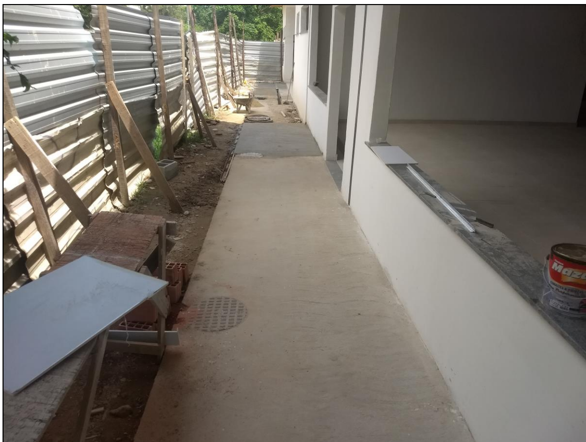
Foto 11 - Execução da rede externa de esgoto dos refeitórios nº 01 e 02.
