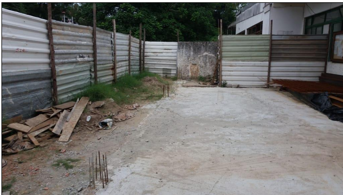
Foto 25 - Execução do contra piso do refeitório nº 01.
