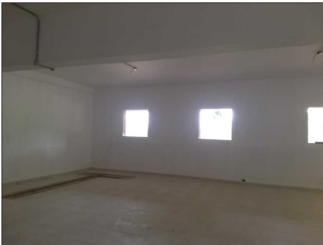
Foto 05 - Início da pintura das paredes do refeitório nº 02
