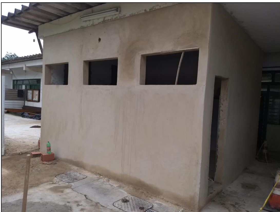
Foto 10 - Execução do emboço nas paredes das fachadas
