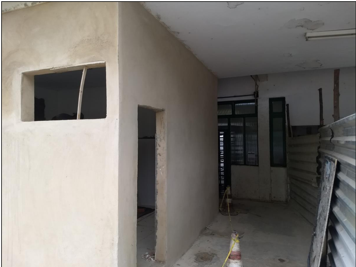
Foto 11 - Execução do emboço nas paredes das fachadas
