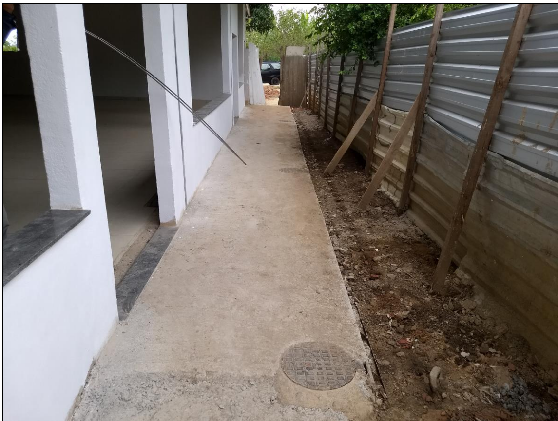
Foto 16 - Execução da calçada frontal do refeitório n° 02
