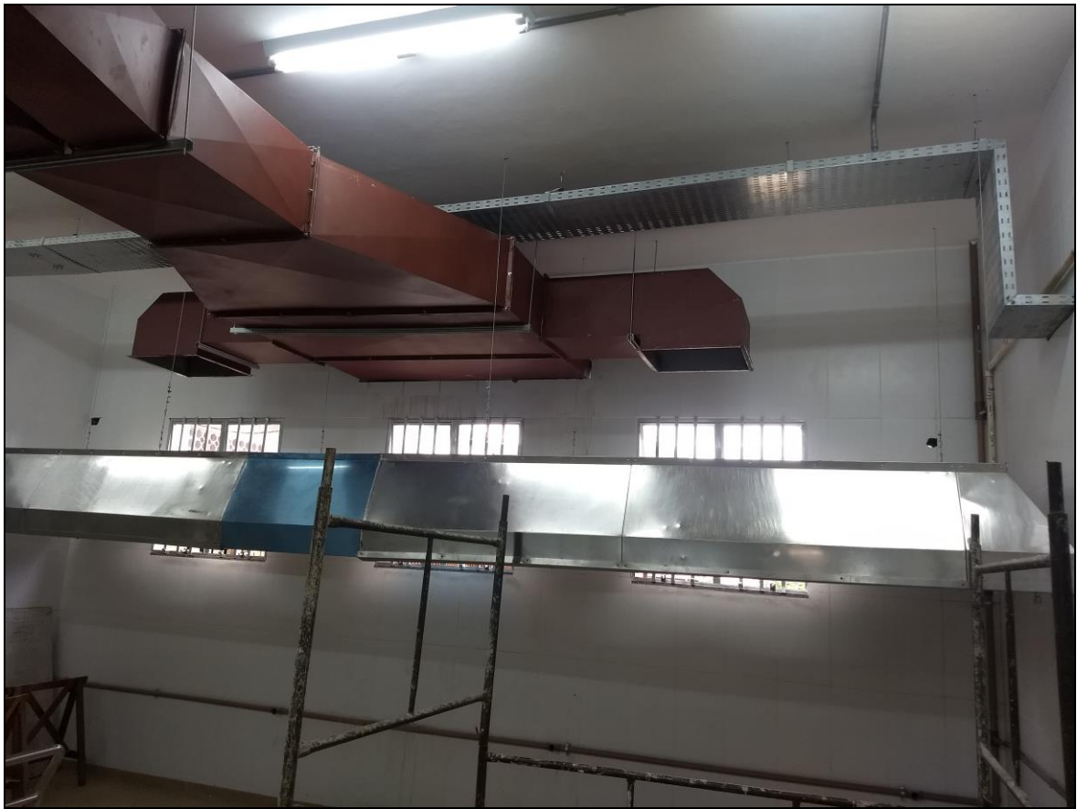
Foto 05 – Início da instalação dos dutos horizontais de exaustão
