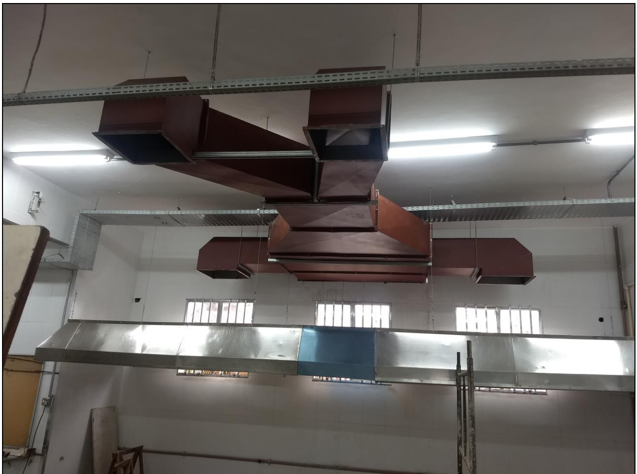
Foto 04 – Início da instalação dos dutos horizontais de exaustão
