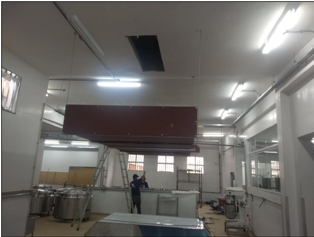
Foto 03 – Início da instalação dos dutos horizontais de exaustão
