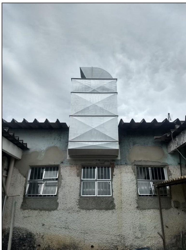
Foto 18 – Saída da exaustão: parte externa.
