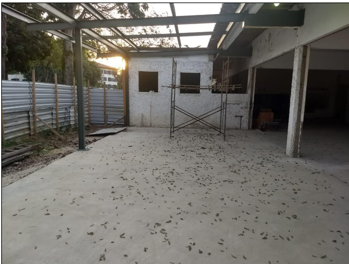
Foto 01 - Execução do contrapiso do refeitório nº 02
