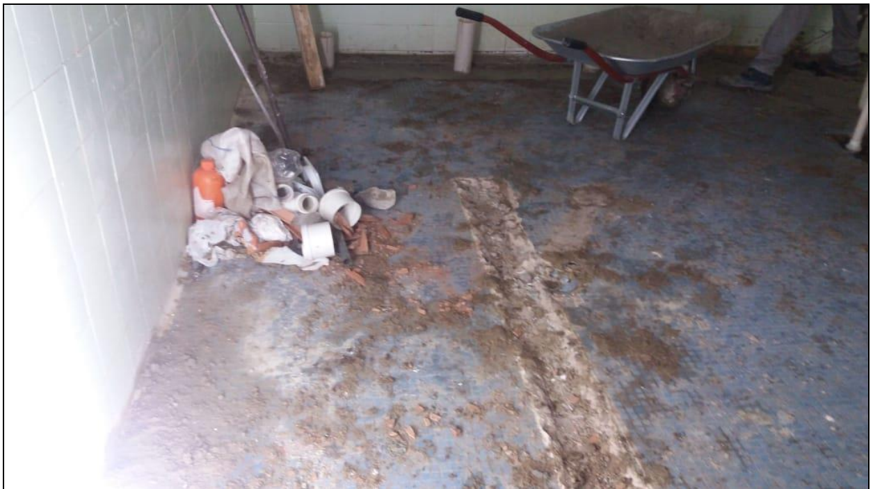
Foto 06 - Demolição da estrutura de alvenaria antiga do banheiro do refeitório n° 02
