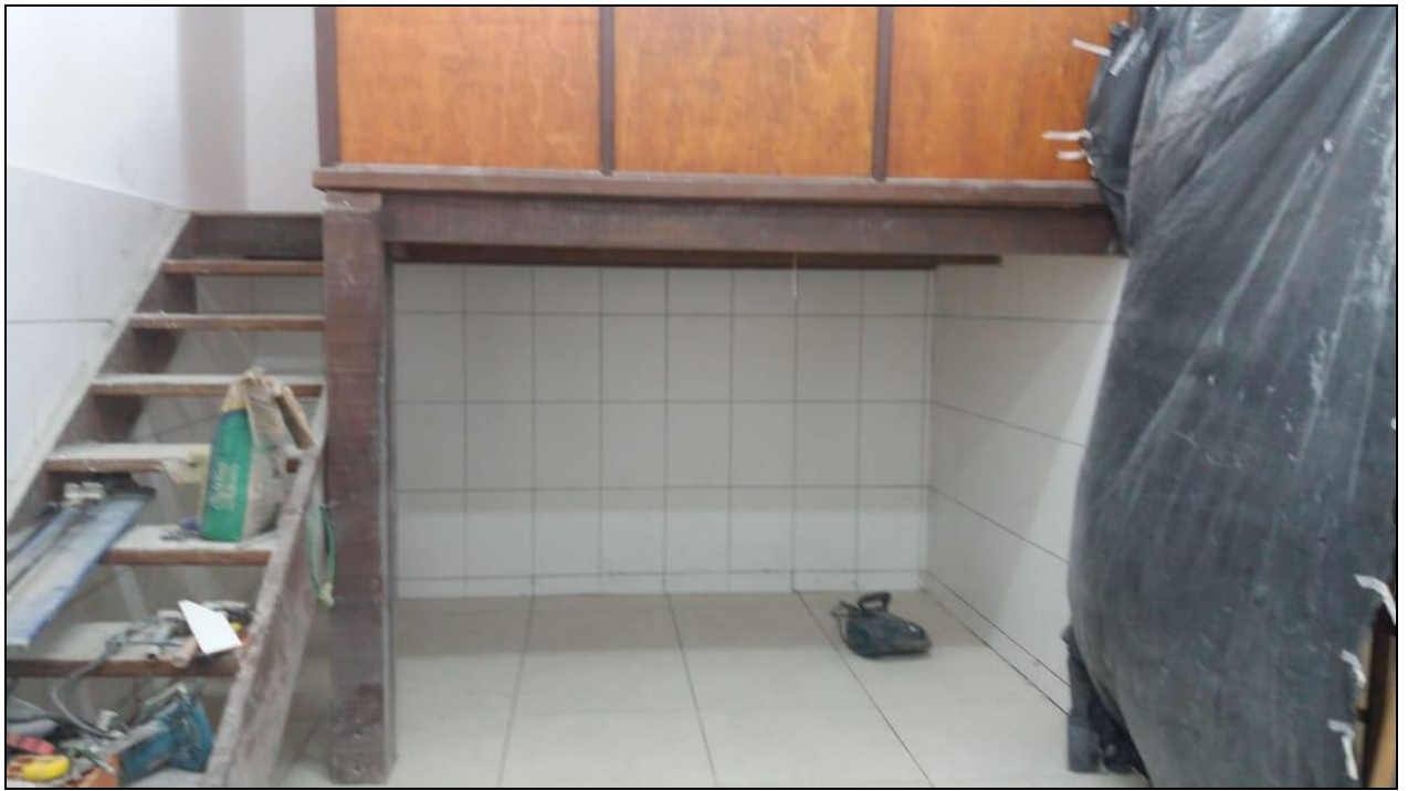
Foto 19 - Execução do revestimento cerâmico do piso da despensa diária
