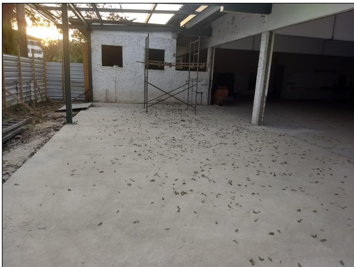
Foto 02 - Execução do contrapiso do refeitório nº 02
