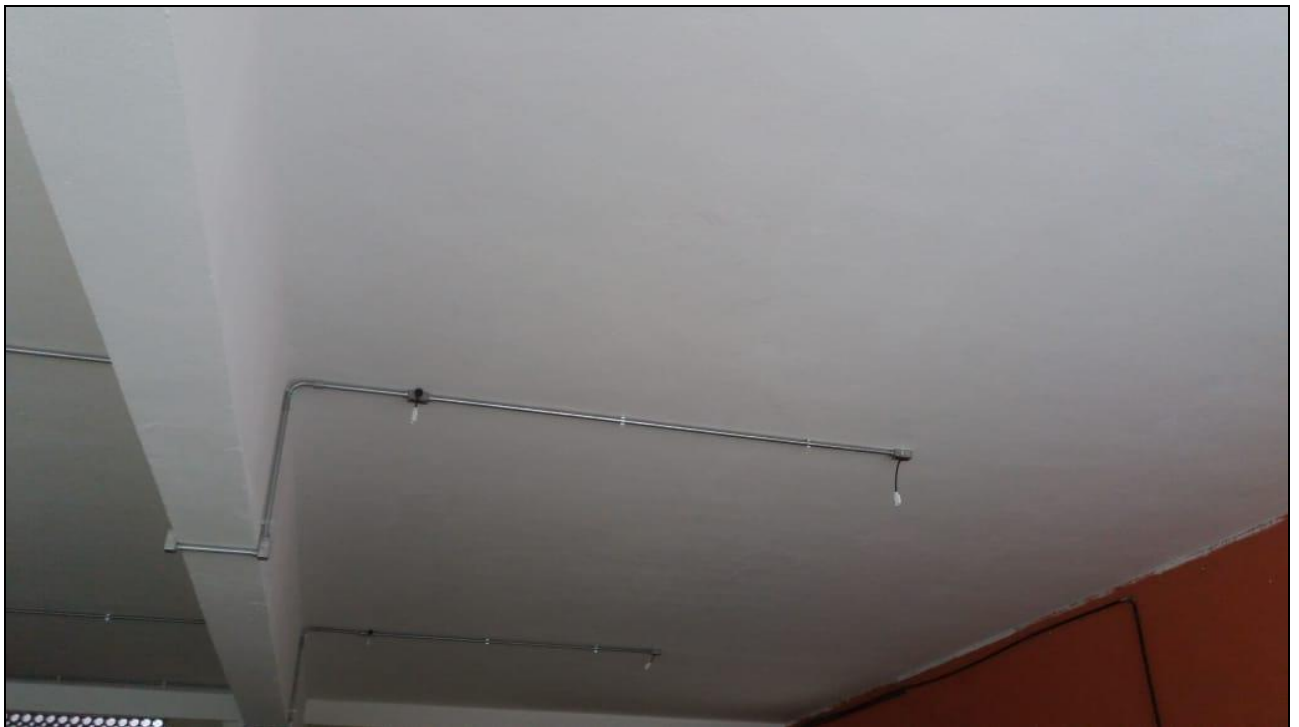
Foto 12 - Pintura do teto do salão do refeitório nº 02
