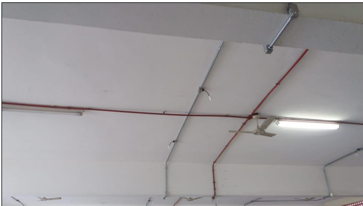
Foto 09 - Execução da rede elétrica do refeitório nº 02
