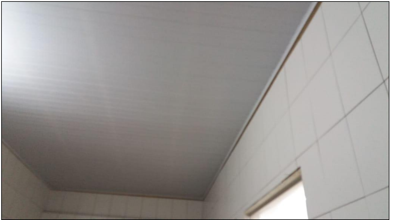
Foto 17 - Instalação do forro de PVC no teto do açougue
