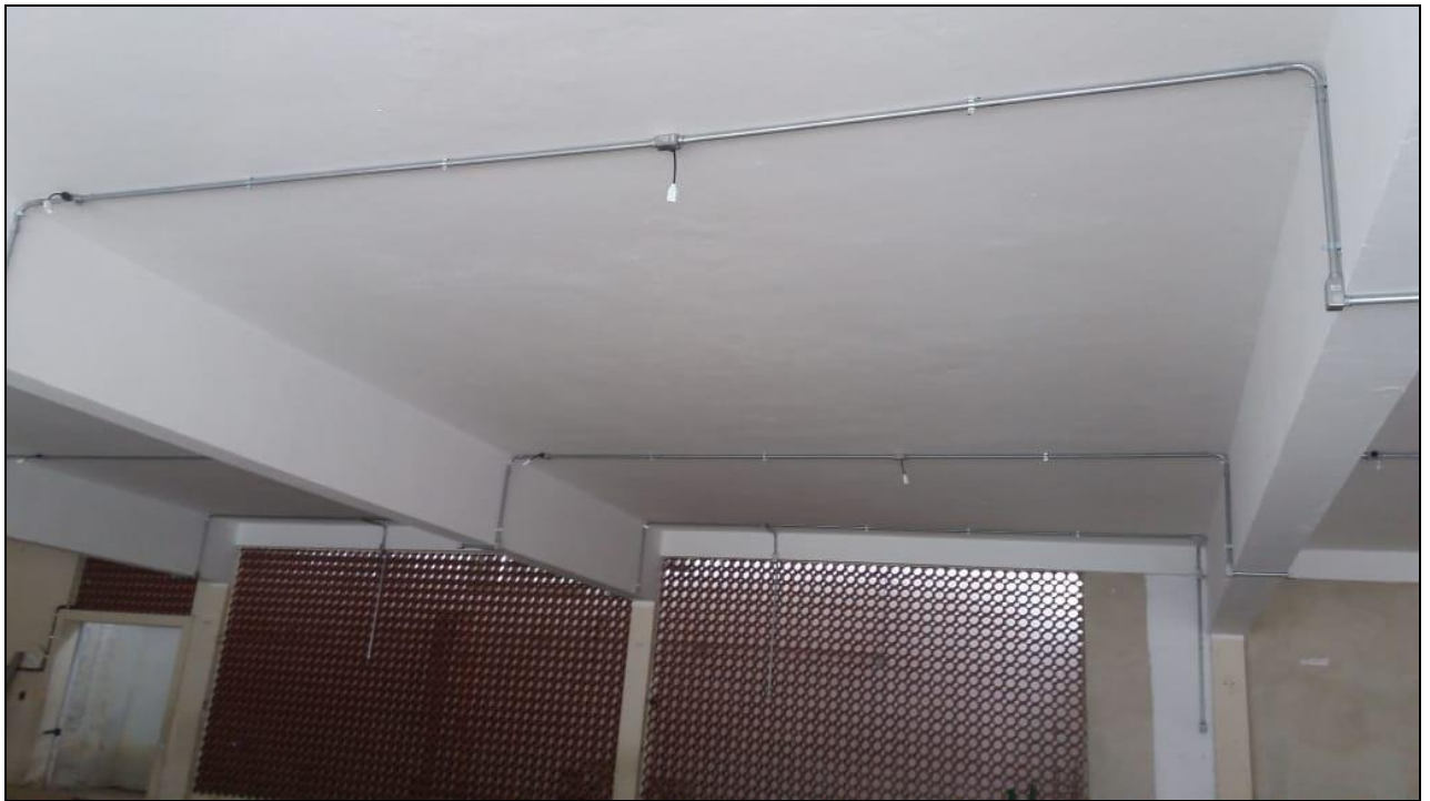
Foto 11 - Pintura do teto do salão do refeitório nº 02
