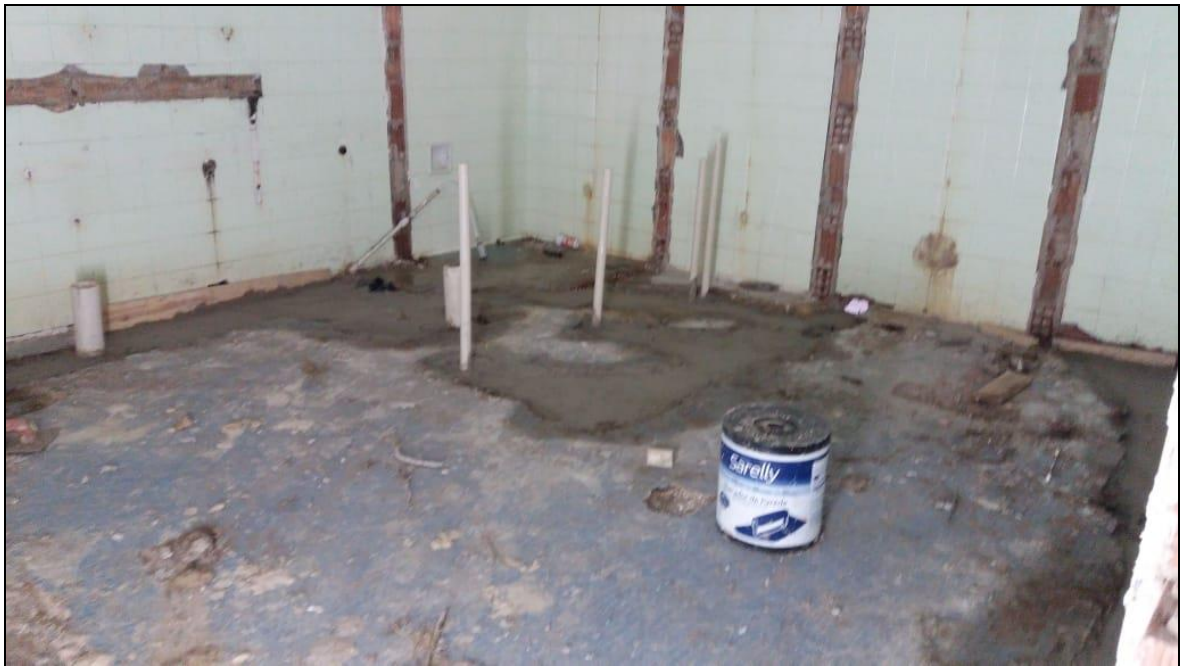
Foto 07 - Início da execução da rede de hidráulica e de esgoto do banheiro do refeitório n° 02
