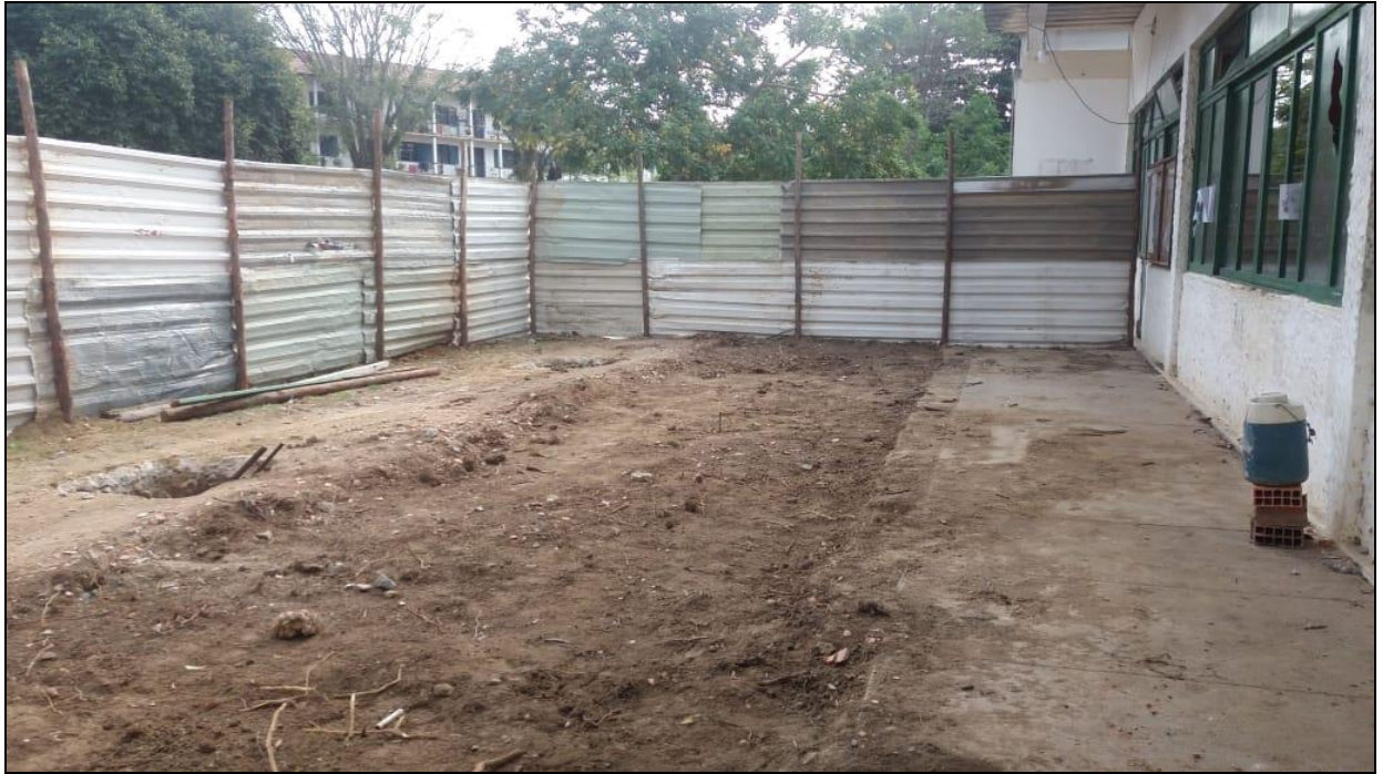
Foto 13 - Demolição e retirada das floreiras do salão do refeitório nº 01
