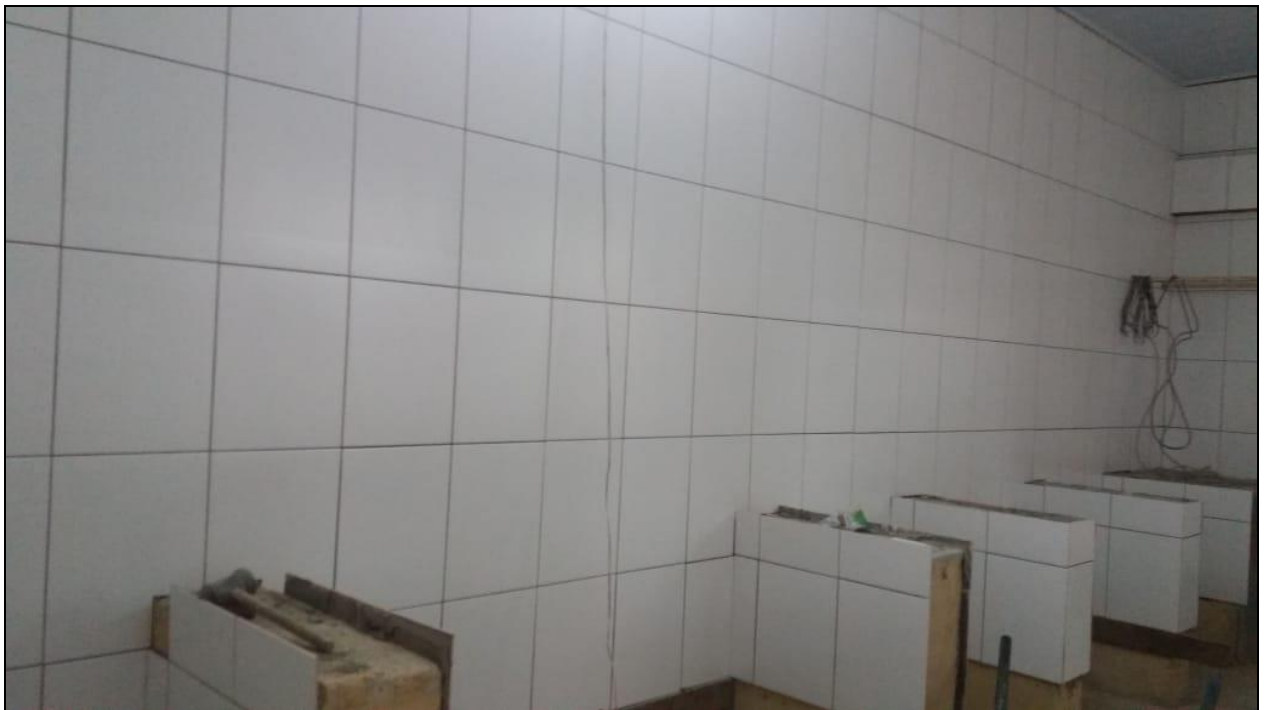
Foto 16 - Execução do revestimento cerâmico das paredes do açougue
