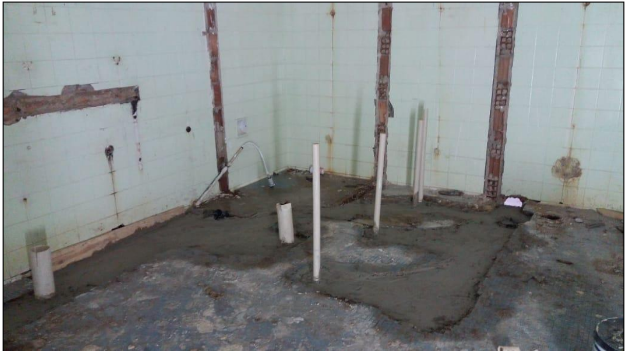
Foto 08 - Início da execução da rede de hidráulica e de esgoto do banheiro do refeitório n° 02
