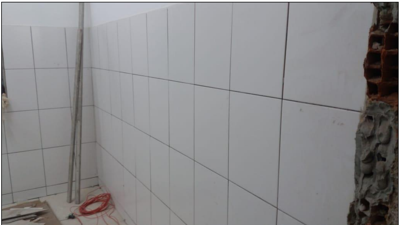
Foto 18 - Execução do revestimento cerâmico das paredes da dispensa diária
