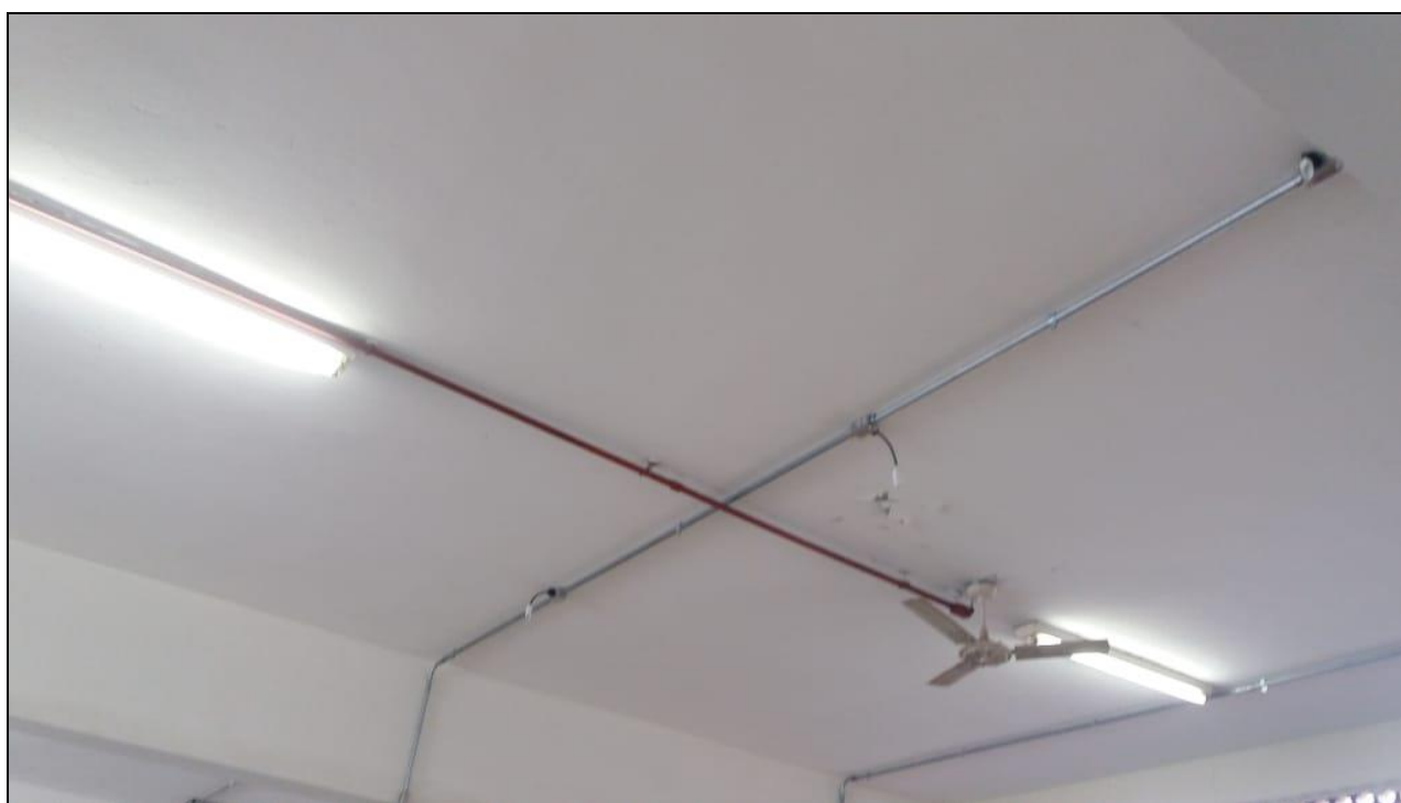
Foto 10 - Execução da rede elétrica do refeitório nº 02
