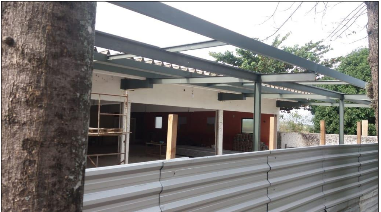
Foto 04 - Conclusão da execução da estrutura metálica da área de expansão do refeitório nº 02
