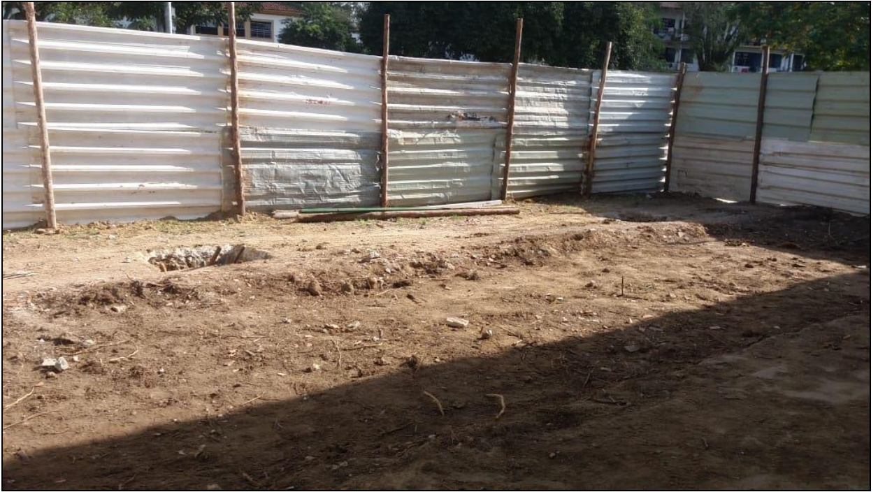
Foto 15 - Início da escavação para a execução da fundação do salão do refeitório nº 01
