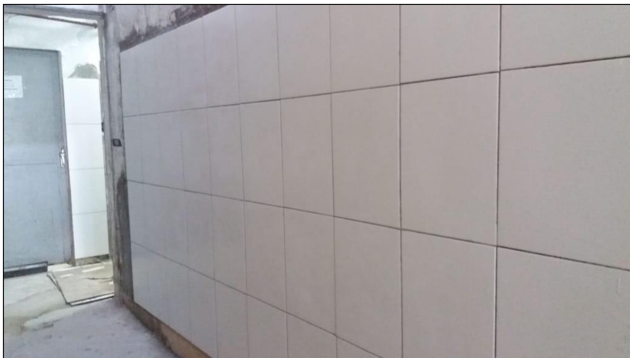
Foto 21 - Início do revestimento cerâmico do corredor das câmaras frias
