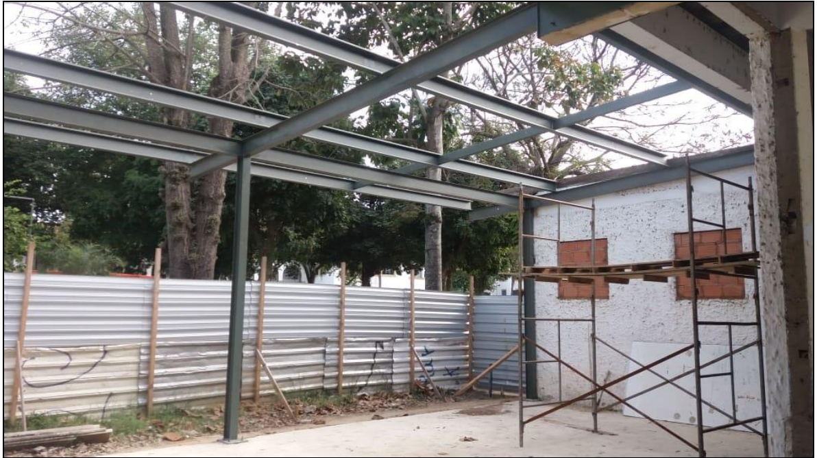
Foto 03 - Conclusão da execução da estrutura metálica da área de expansão do refeitório nº 02
