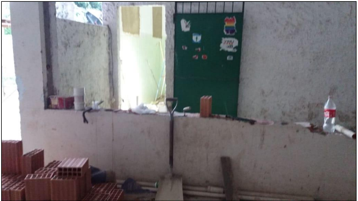
Foto 05 - Demolição da estrutura de alvenaria antiga do banheiro do refeitório n° 02
