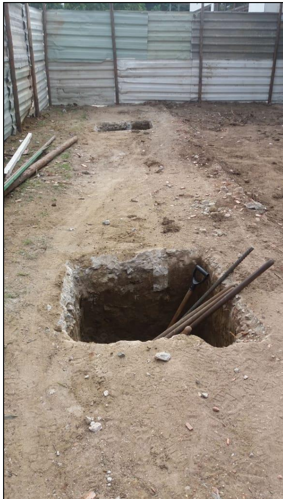
Foto 14 - Início da escavação para a execução da fundação do salão do refeitório nº 01
