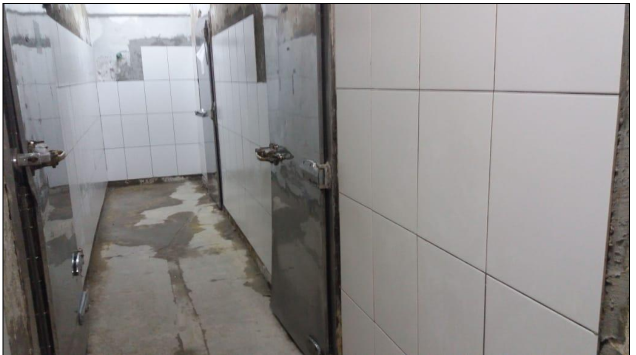
Foto 20 - Execução do revestimento cerâmico das paredes da área das câmaras frias
