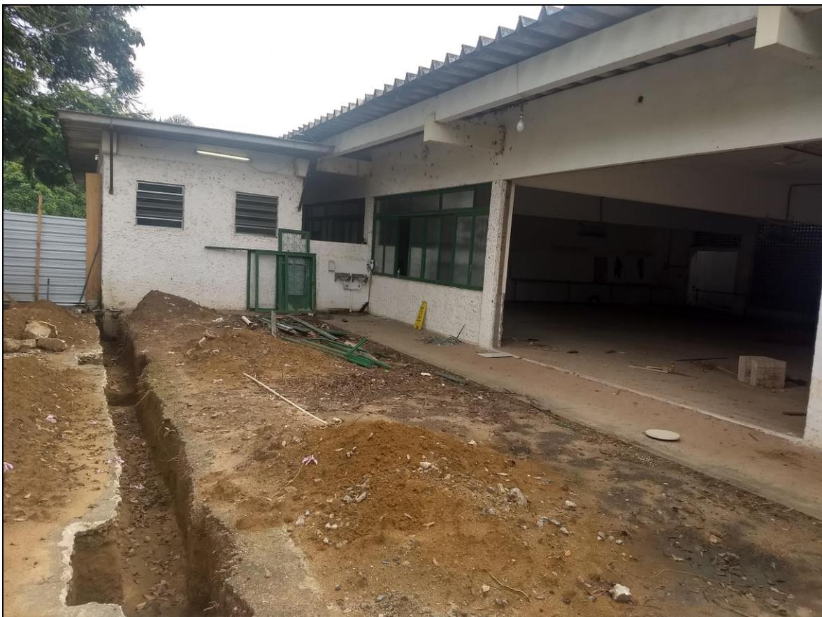
**Foto 16** - Início da escavação para a construção de fundações da área dos refeitórios que será ampliada.
