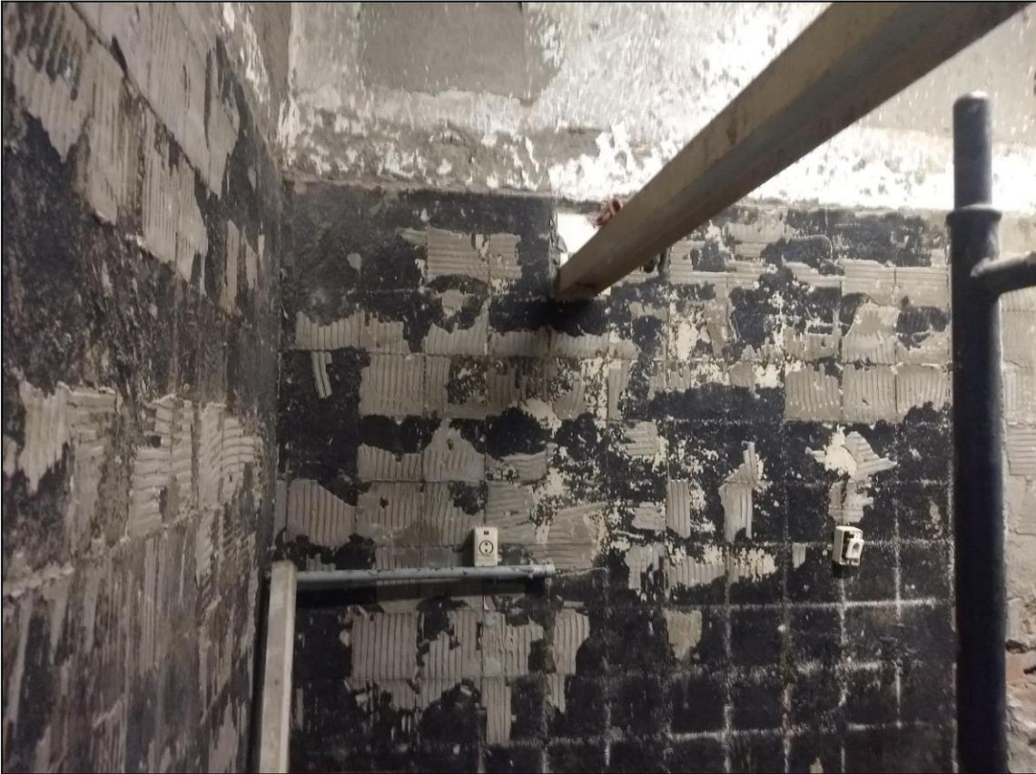
**Foto 07** - Demolição do revestimento cerâmico das paredes do piso do açougue e retirada da antiga instalação elétrica.
