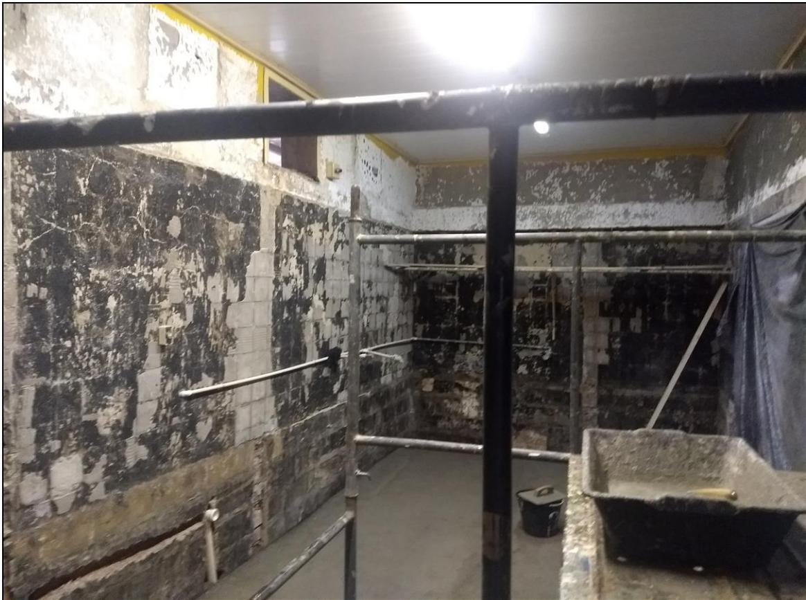
**Foto 08** - Demolição do revestimento cerâmico das paredes do piso do açougue e retirada da antiga instalação elétrica.
