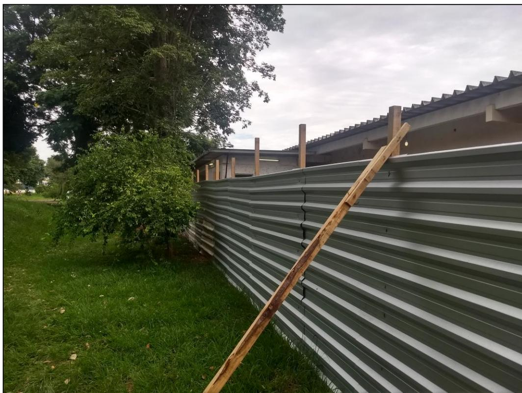
**Foto 01** - Instalação do canteiro de obras, com o isolamento com tapumes da área do RU que será objeto de reforma e ampliação (salões de alimentação).
