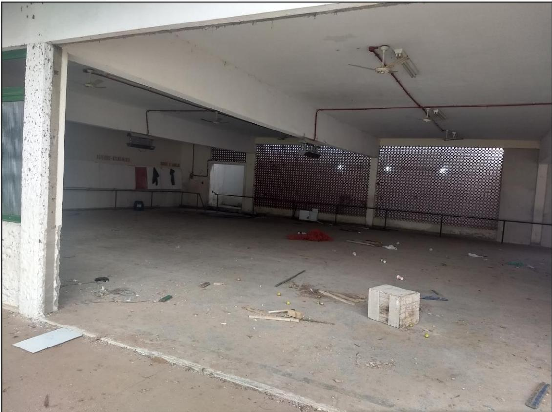
**Foto 13** - Retirada das esquadrias e demolição das paredes e janelas do refeitório.
