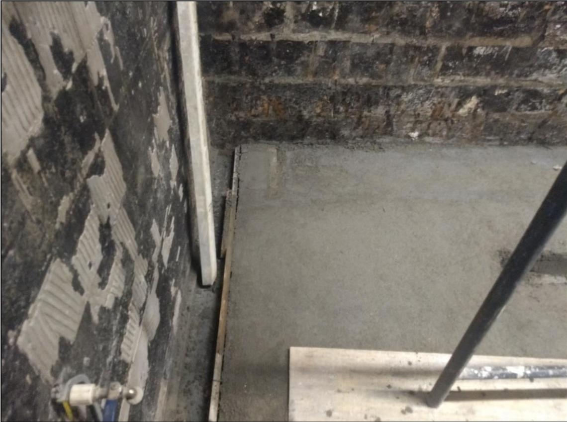
**Foto 09** - Instalação da rede de esgoto e execução do contrapiso do açougue.
