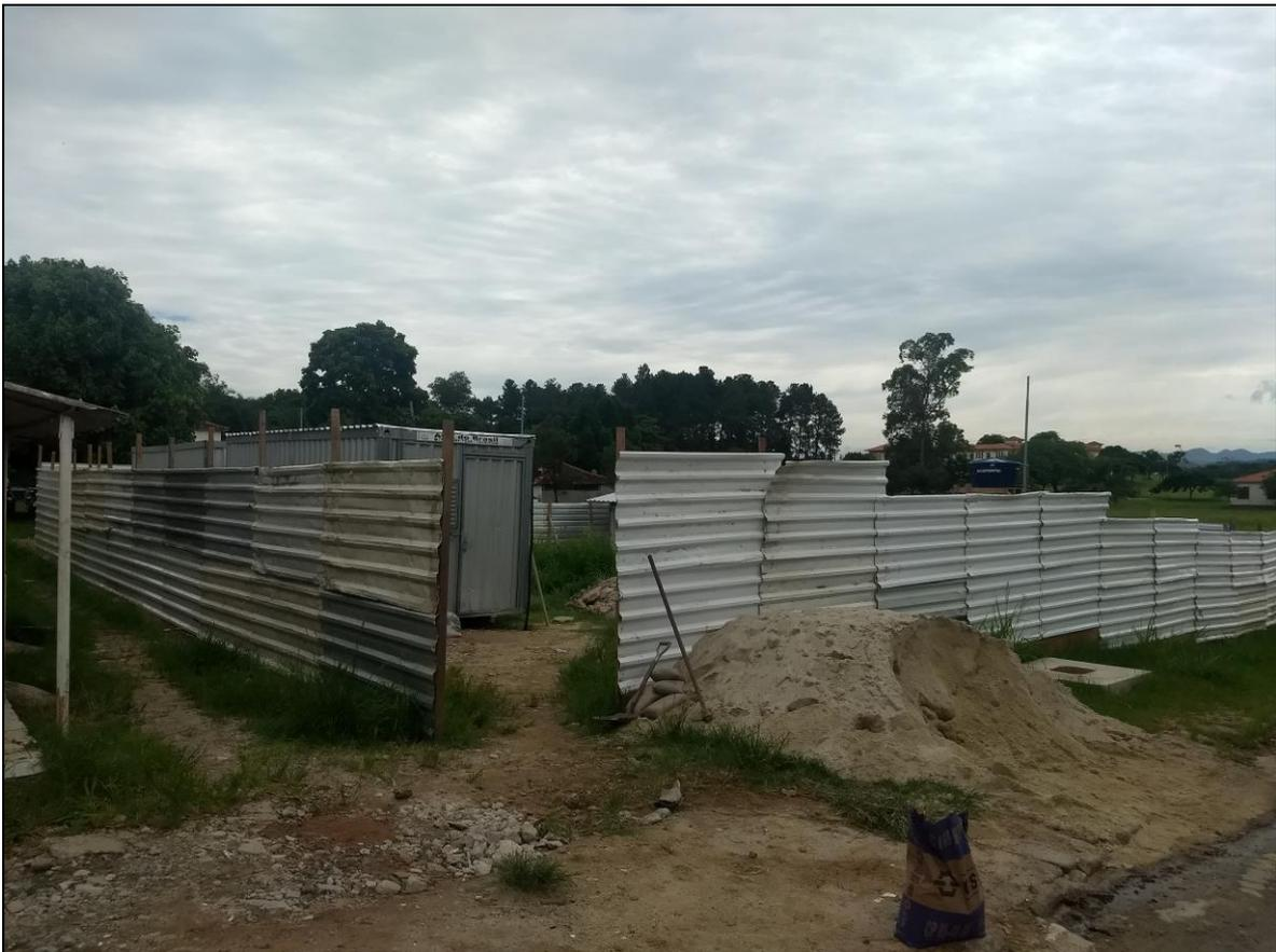
Foto 03 - Instalação do canteiro de obras, com o isolamento com tapumes da área do RU que será objeto de reforma e ampliação (salões de alimentação).
