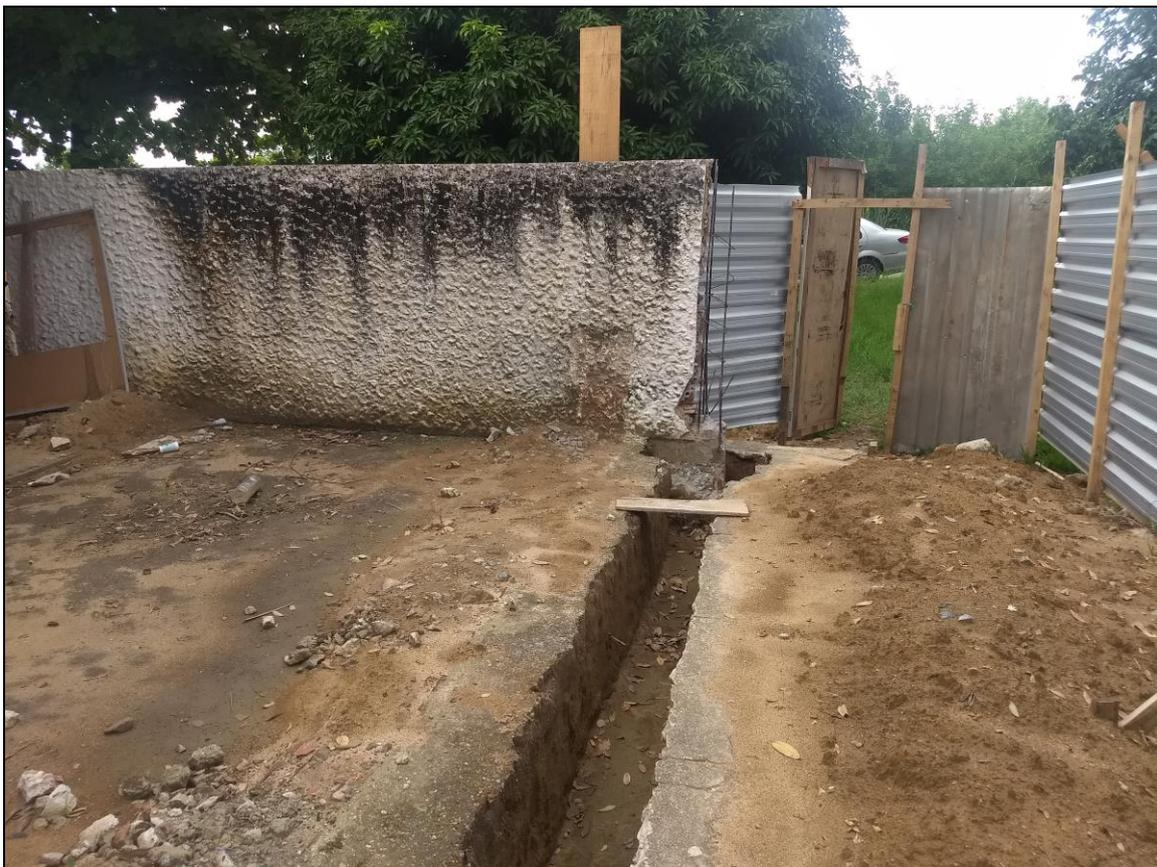
**Foto 15** - Início da escavação para a construção de fundações da área dos refeitórios que será ampliada.
