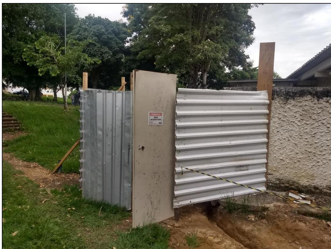
**Foto 02** - Instalação do canteiro de obras, com o isolamento com tapumes da área do RU que será objeto de reforma e ampliação (salões de alimentação).
