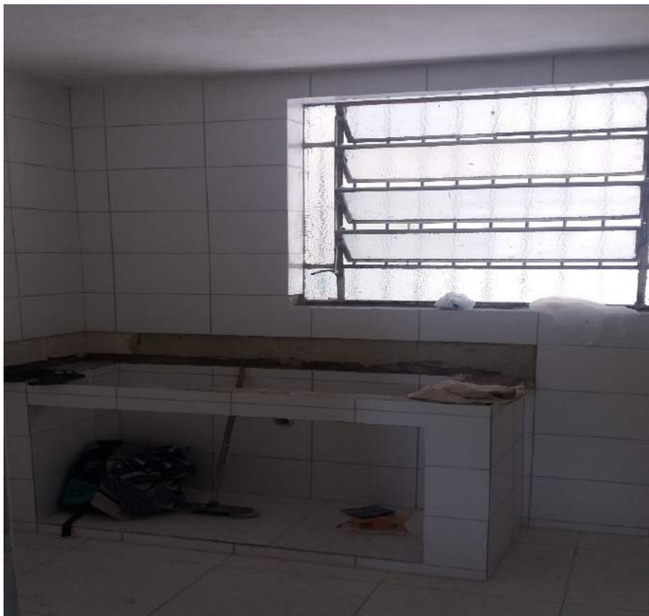
COZINHA EM REFORMA DA ANTIGA PNR
