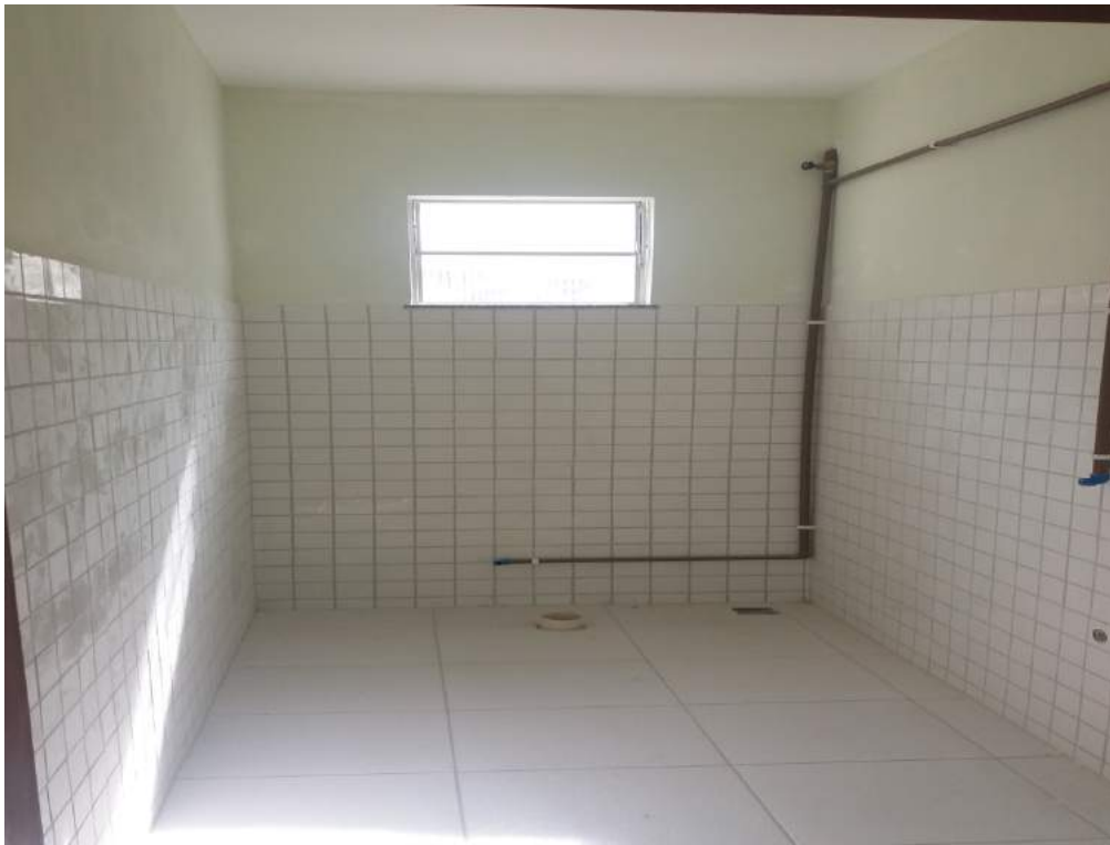
BANHEIRO DO NOVO ANEXO DA DAST
