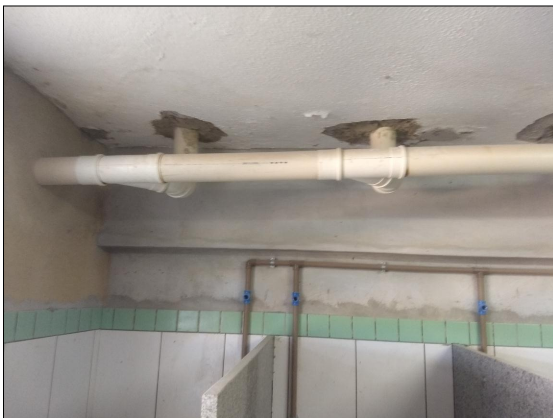
Foto 04 - Conclusão da instalação da tubulação da rede sanitária dos banheiros do 1º Andar.
