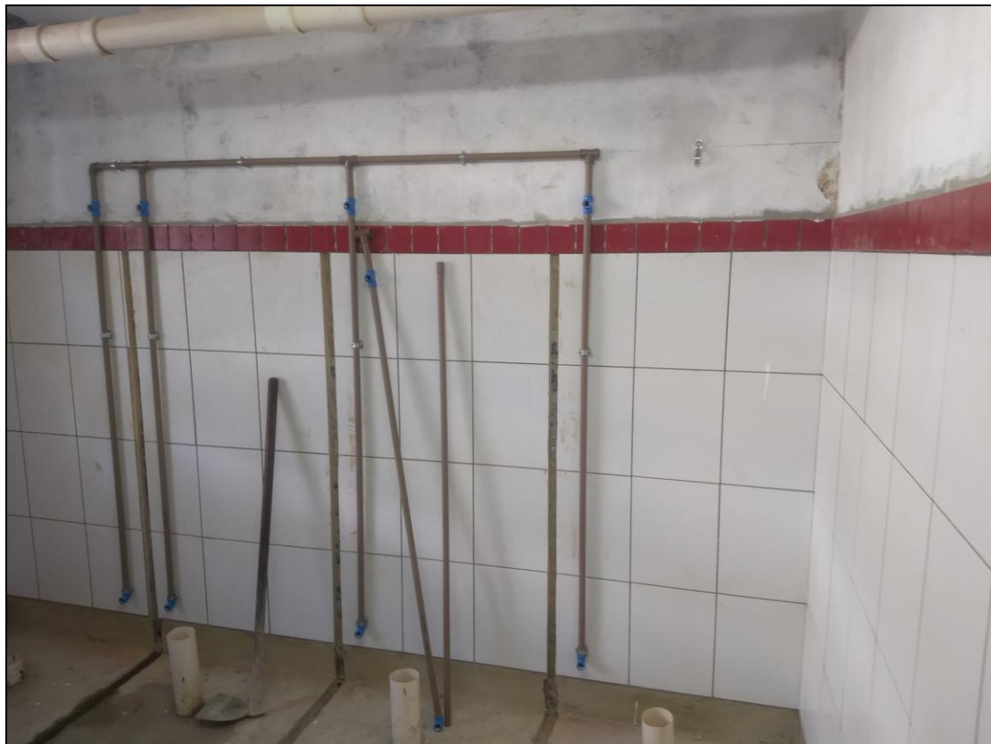
Foto 02 - Conclusão da instalação do contrapiso de concreto e da manta asfáltica de vedação nos banheiros do 1º Andar.
