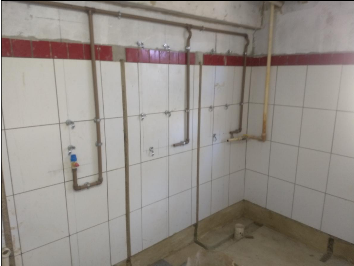
Foto 05 - Início da instalação da tubulação da rede hidráulica dos banheiros do 1º Andar.
