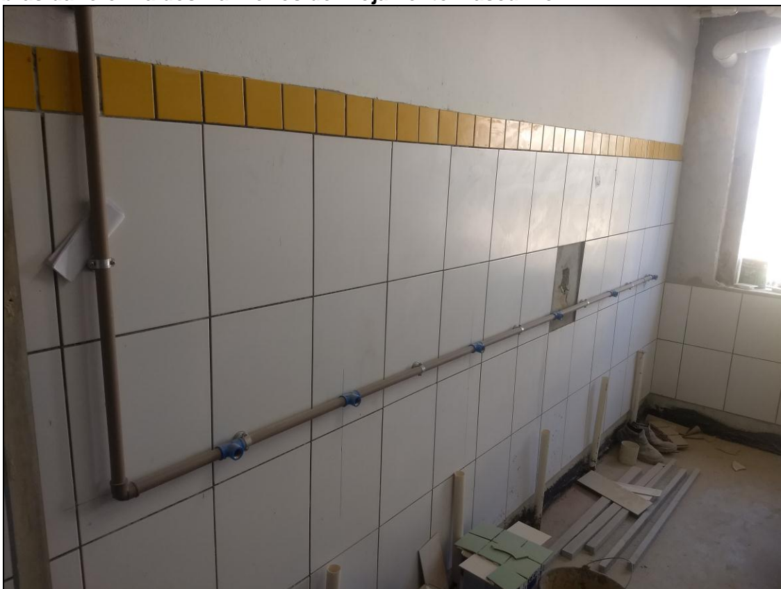
Foto 01 - Conclusão da instalação do contrapiso de concreto e da manta asfáltica de vedação nos banheiros do 1º Andar.
