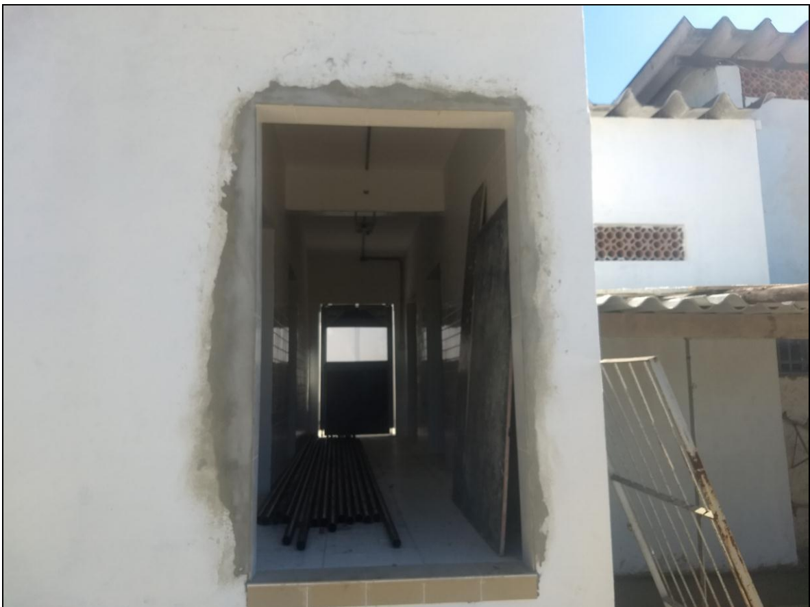
Foto 14 – Vista externa da área das lixeiras climatizadas
