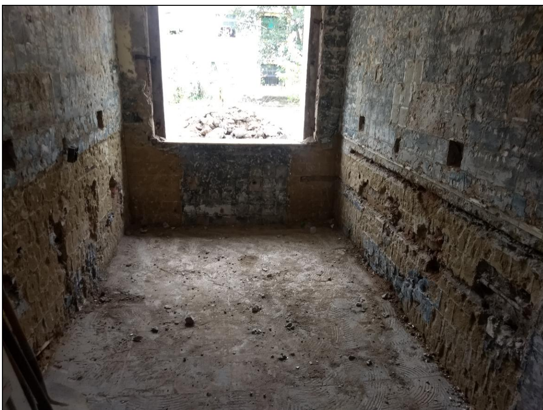
Foto 14 - Execução de serviços de demolição da infraestrutura antiga do banheiro do 1º Andar
