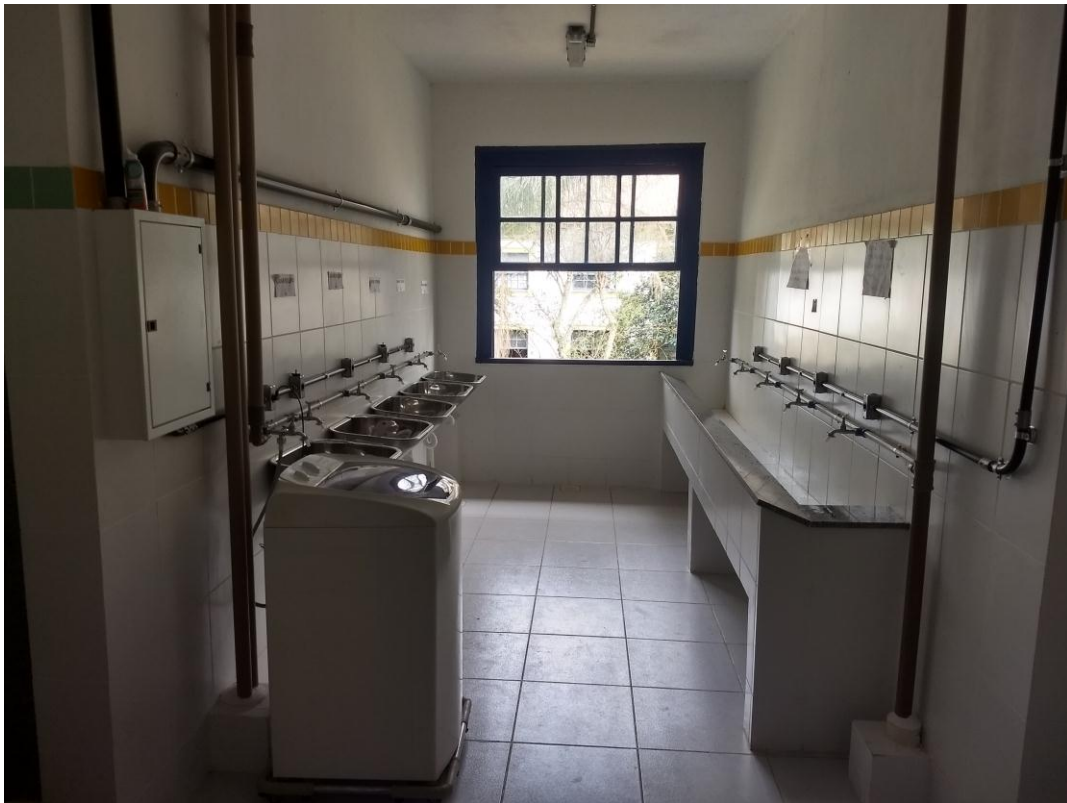
Foto 11 – Vista interna da área de higienização pessoal dos banheiros construídos no 2º e 3º andar
