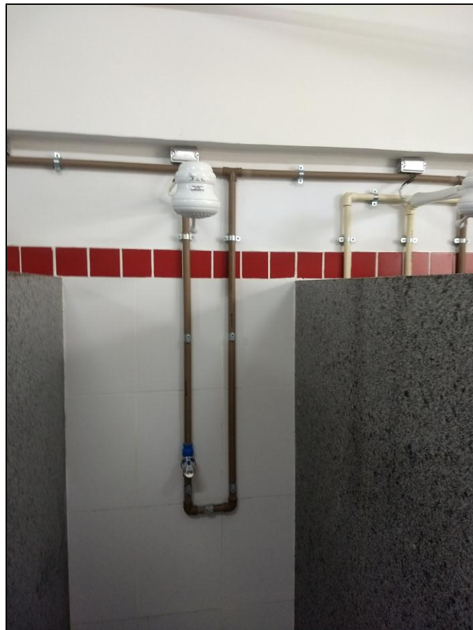
Foto 04 – Vista interna dos chuveiros com divisórias e portas de alumínio dos banheiros concluídos no 2º e 3º andar
