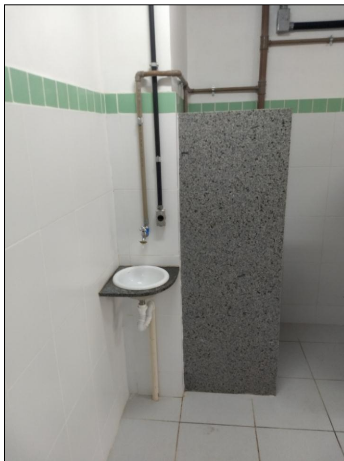
Foto 06 – Pia de higienização bucal instalada nos banheiros concluídos do 2º e 3º Andar
