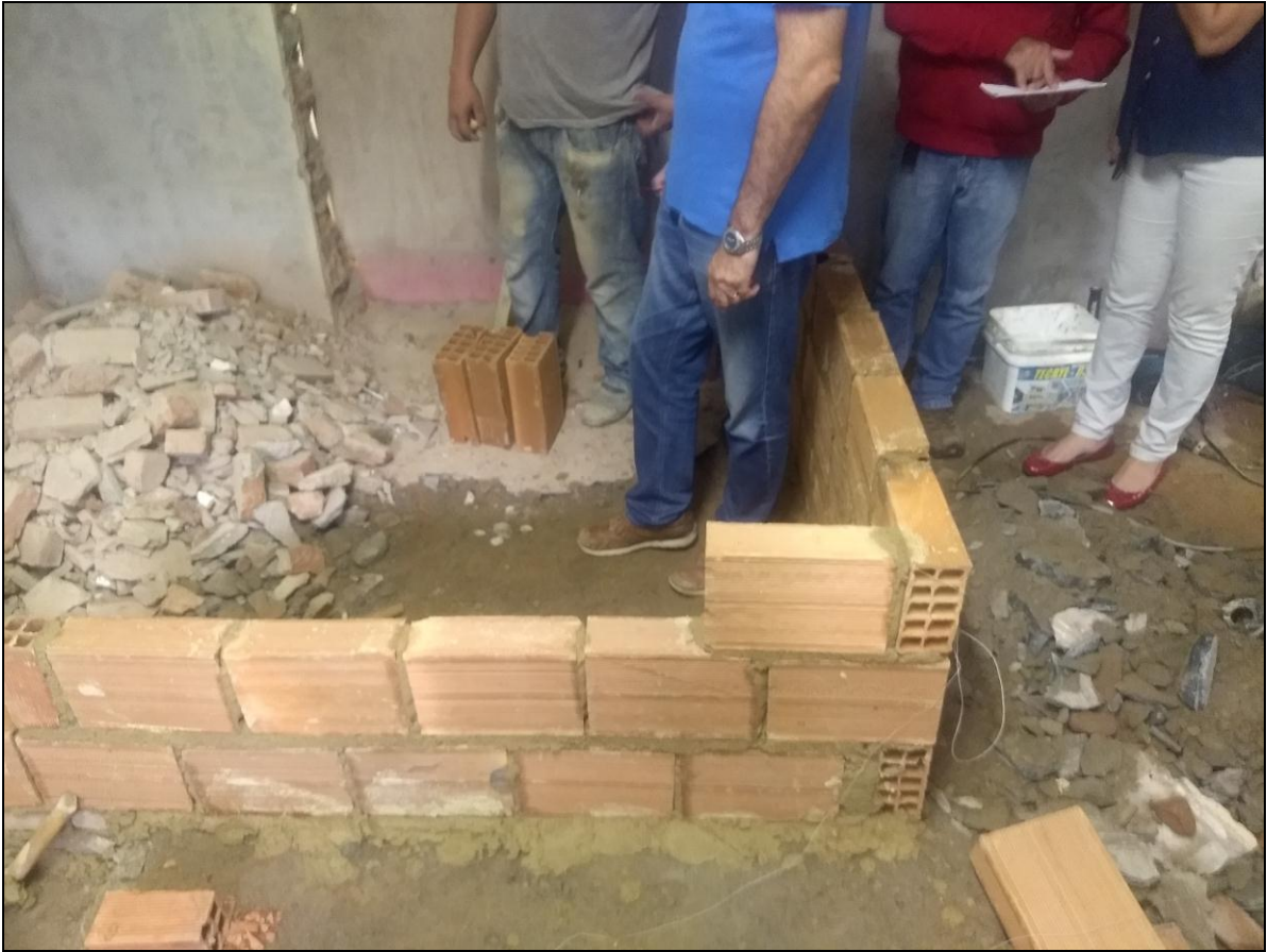
Foto 21 - Início do levantamento das paredes de alvenaria do banheiro adaptado para acessibilidade.
