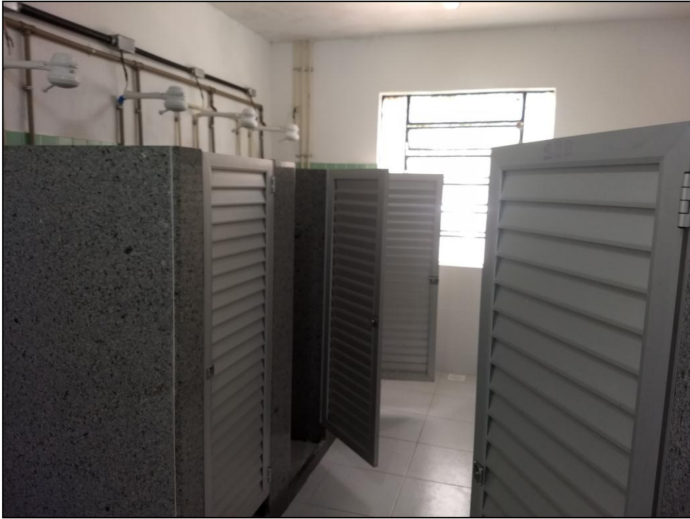
Foto 03 – Vista da área dos chuveiros com divisórias e portas de alumínio dos banheiros concluídos no 2º e 3º andar
