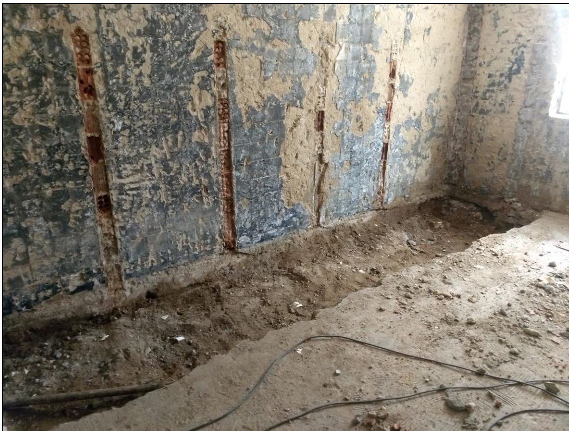
Foto 15 - Execução de serviços de demolição da infraestrutura antiga do banheiro do 1º Andar
