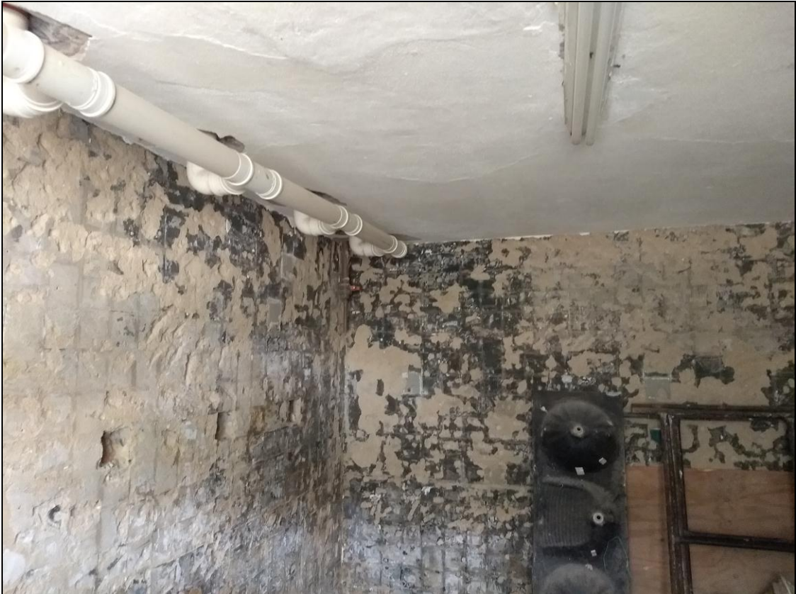
Foto 17 - Retirada do revestimento cerâmico antigo das paredes do banheiro do 1º Andar
