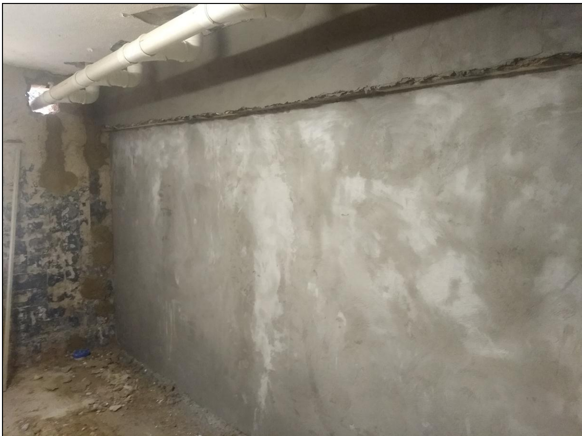
Foto 20 – Início da aplicação de emboço nas paredes do banheiro do 1º Andar
