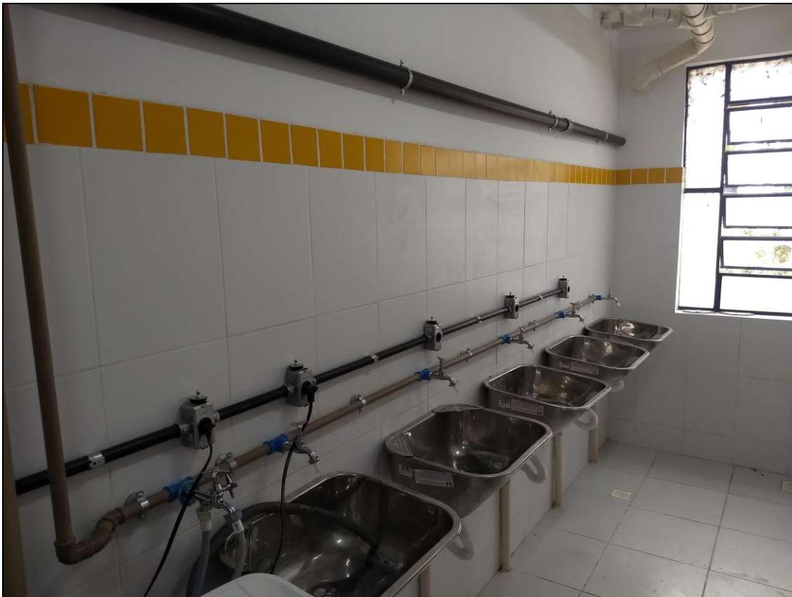
Foto 07 – Tanques em aço inox para lavar roupa instalados nos banheiros concluídos do 2º e 3º Andar
