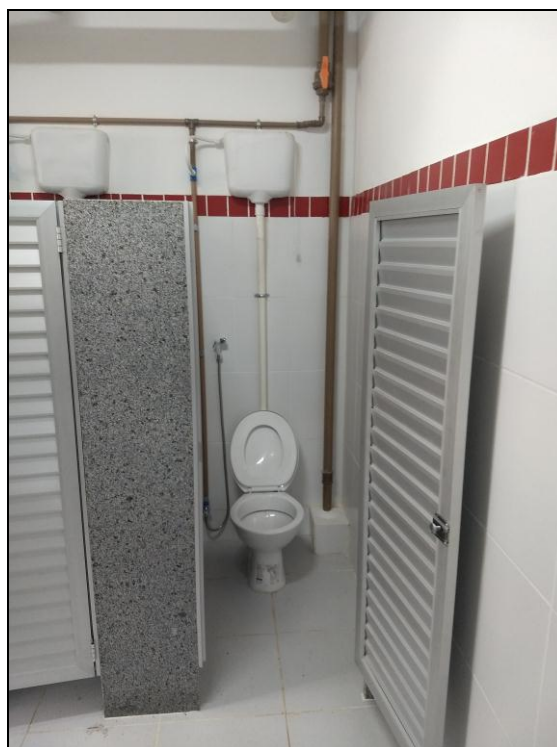
Foto 02 – Vista interna dos sanitários com divisórias e portas de alumínio dos banheiros concluídos no 2º e 3º andar
