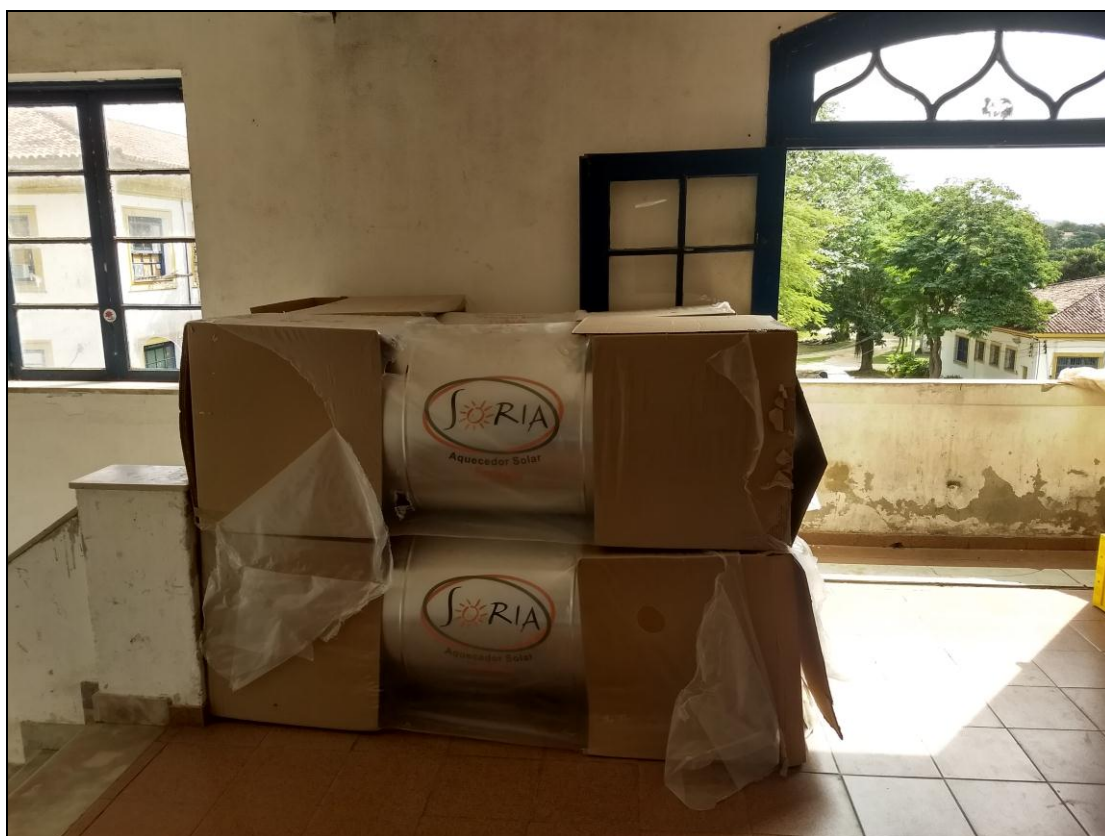
Foto 13 – Aquecedores de água de 500 litros em aço inox (boilers) que serão instalados nos banheiros concluídos do 2º e 3º andar pela equipe do Setor de Manutenção da Residência Estudantil (SEMRE).
