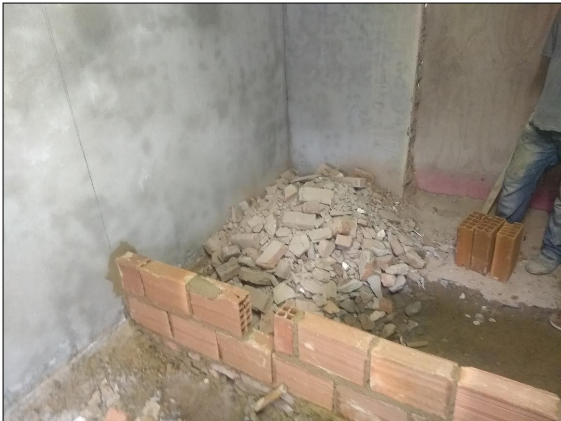
Foto 22 - Início do levantamento das paredes de alvenaria do banheiro adaptado para acessibilidade
