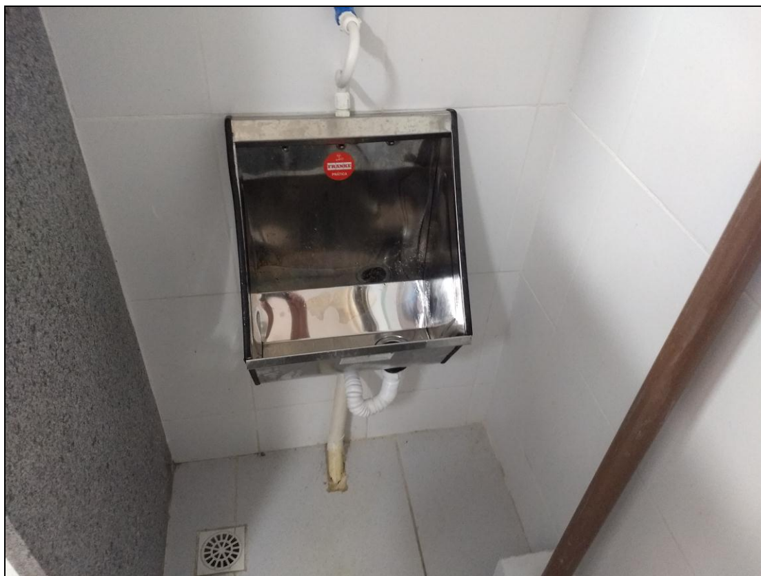
Foto 05 – Mictório em aço inox instalado nos banheiros concluídos do 2º e 3º Andar
