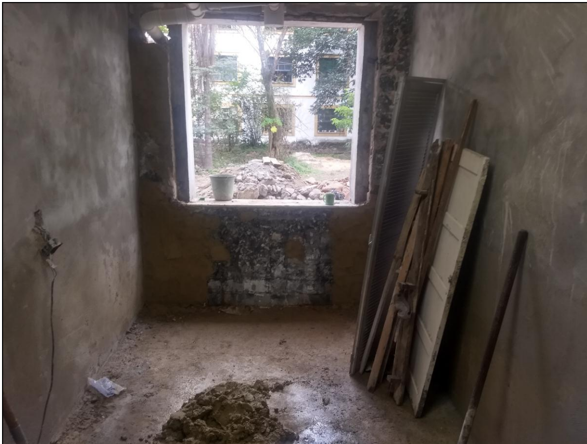
Foto 19 – Início da aplicação de emboço nas paredes do banheiro do 1º Andar
