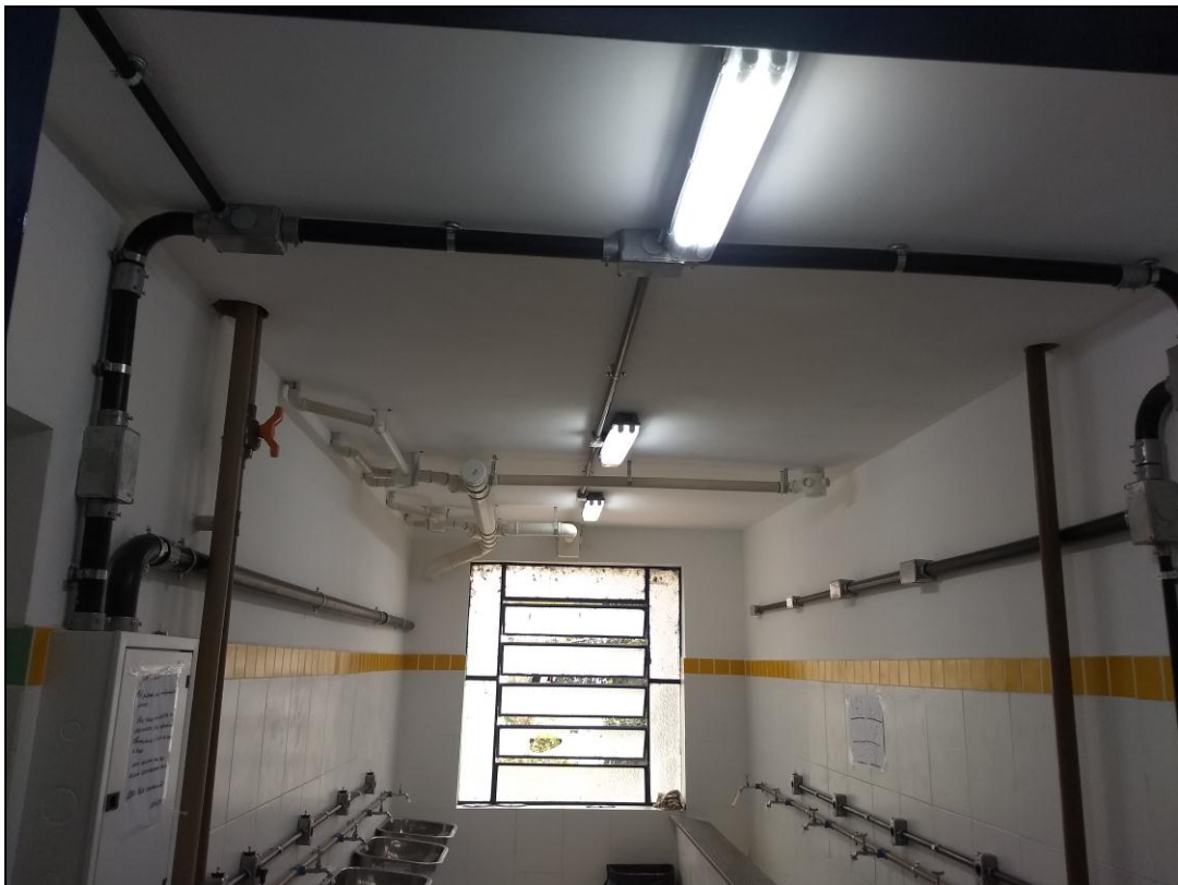
Foto 12 – Vista das redes elétricas, hidráulicas e sanitárias instaladas nos banheiros concluídos do 2º e 3º andar
