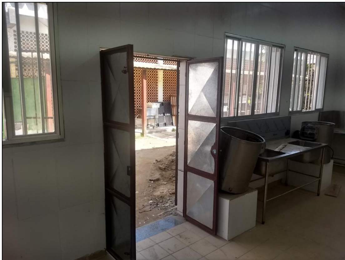
Foto 03 - Instalação de portas e janelas na área reformada
