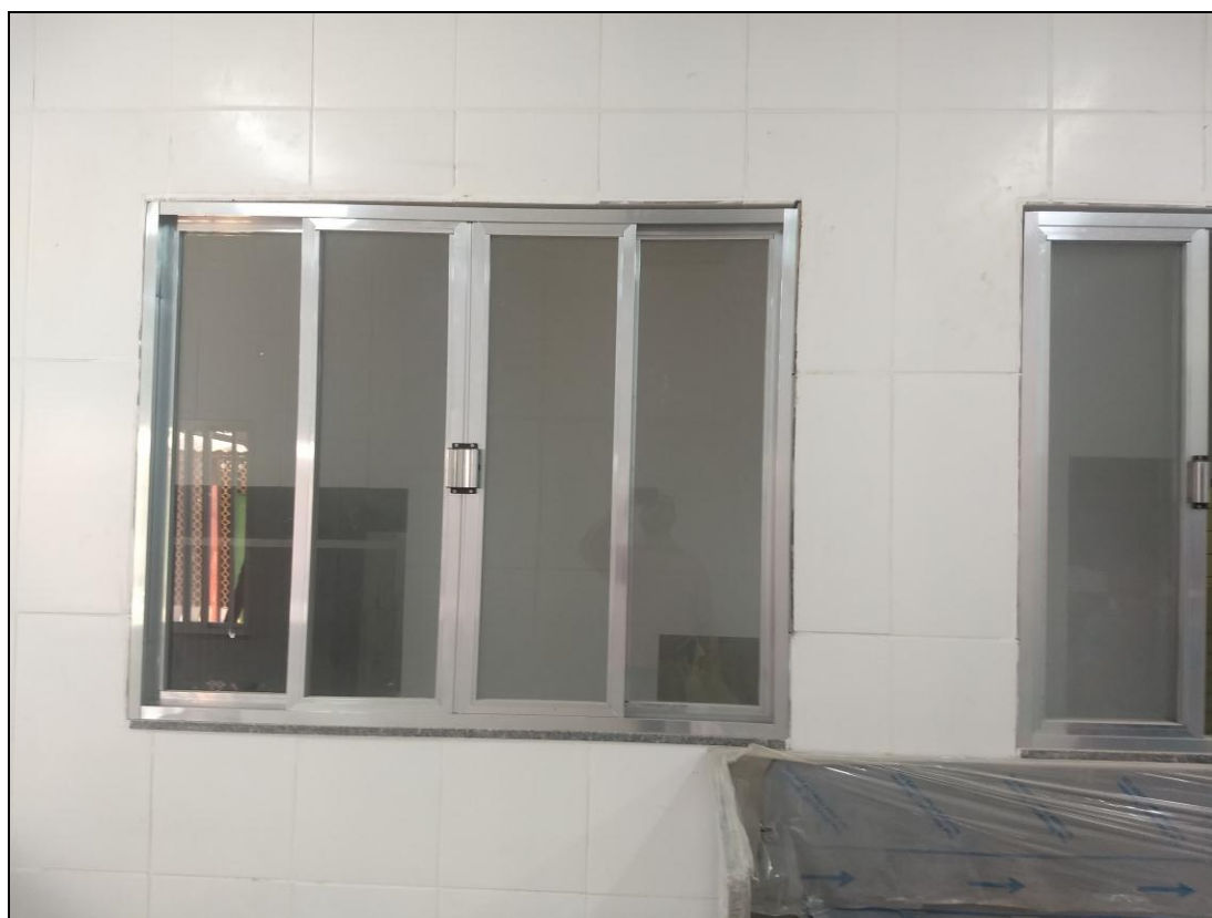
Foto 04- Instalação de portas e janelas na área reformada
