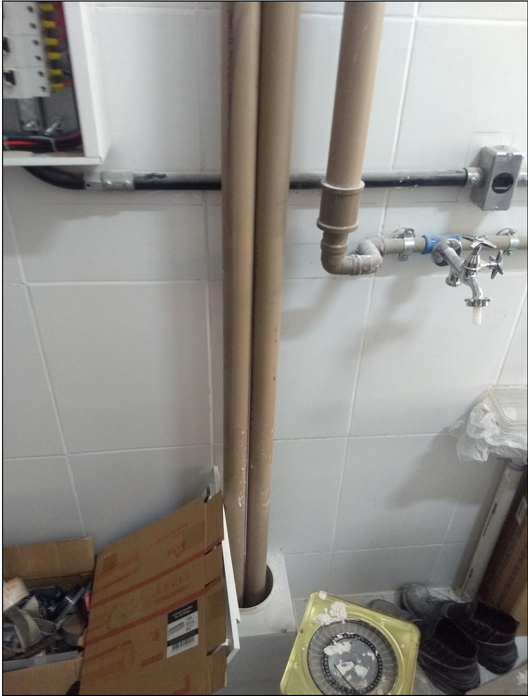
Foto 04 - Troca das colunas de água dos banheiros dos três andares.
