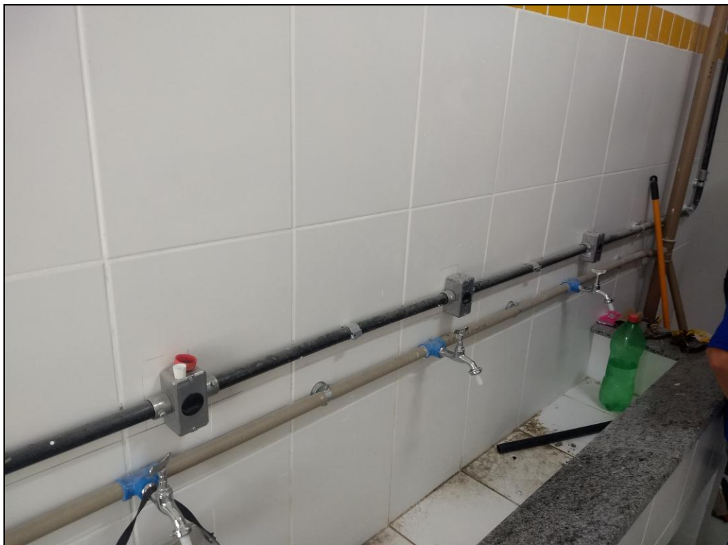
Foto 12 - Início da instalação dos eletrodutos da rede elétrica do banheiro do 2º andar.
