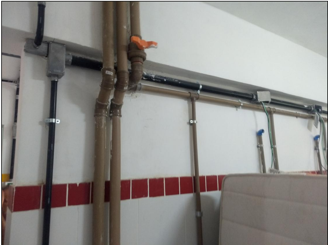
Foto 11 - Início da instalação dos eletrodutos da rede elétrica do banheiro do 2º andar.
