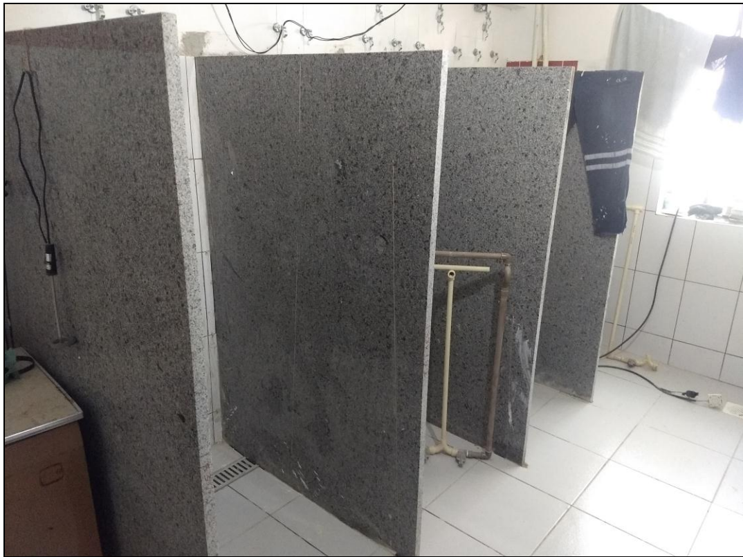
Foto 07 - Finalização da instalação das divisórias de granito do banheiro do 2º andar.
