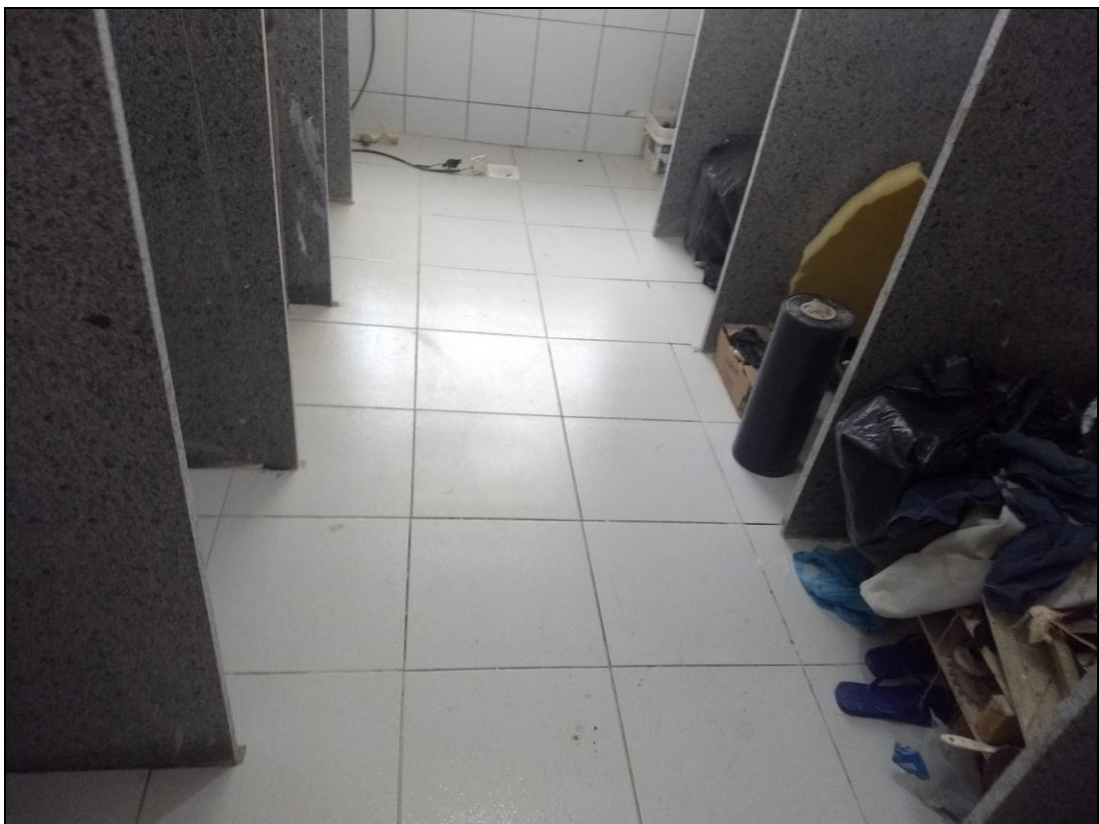
Foto 06 - Finalização da instalação do piso do banheiro do 2º andar.
