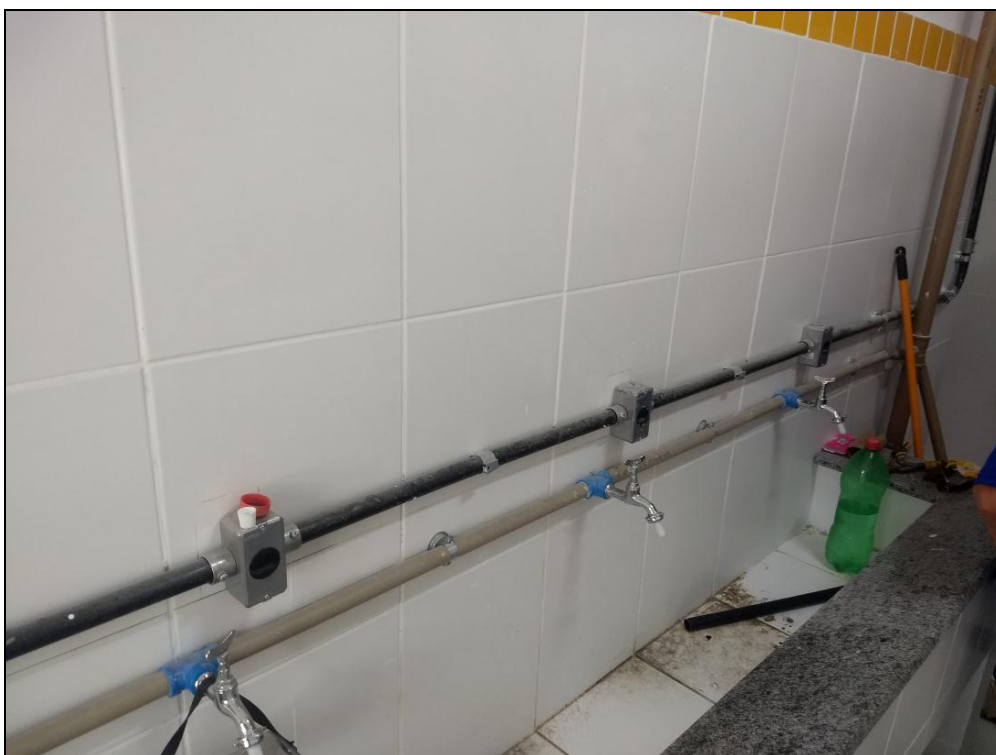
Foto 02 - Conclusão da instalação dos circuitos elétricos do banheiro do 3º andar.
