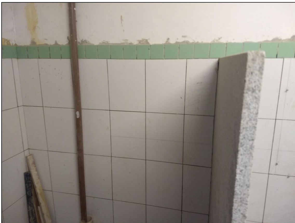
Foto 09 - Finalização da instalação de revestimento cerâmico das paredes do banheiro do 2º andar.
