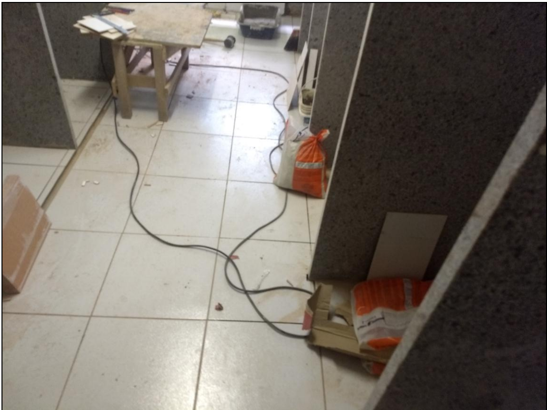
Foto 05 - Finalização da instalação do piso do banheiro do 2º andar.
