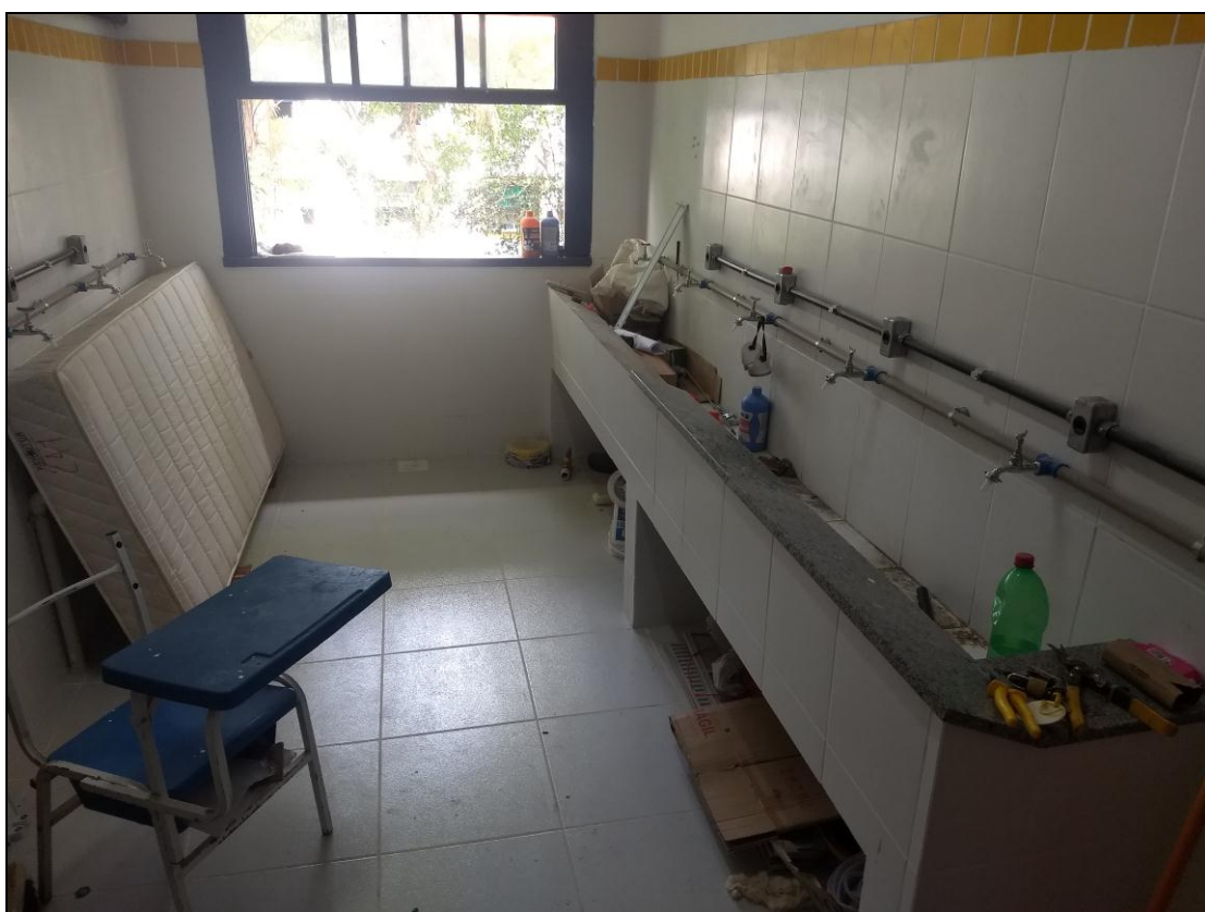
Foto 14 – Visão panorâmica dos serviços realizados até agora no banheiro do 3º Andar
