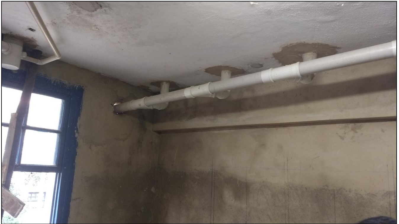
Foto 07 - Preparação para a instalação da tubulação hidráulica e de esgoto do banheiro do 2º andar
