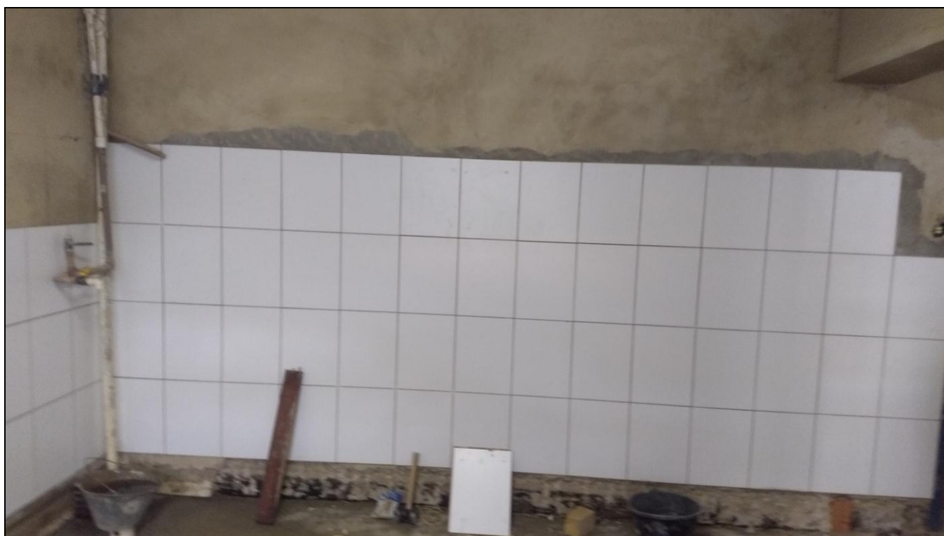
Foto 06 - Início da instalação do revestimento cerâmico das paredes do banheiro do 2º andar
