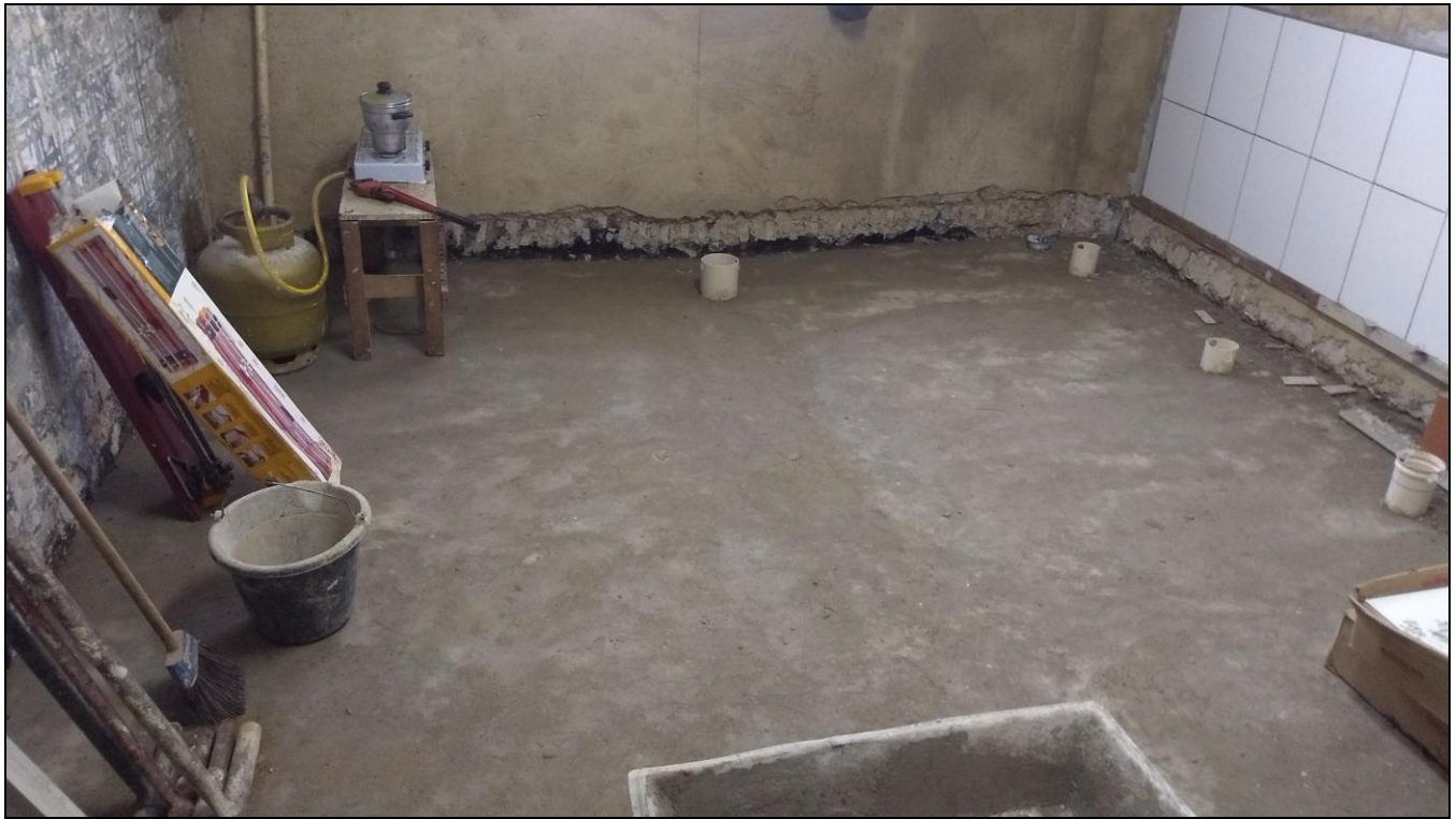
Foto 09 - Preparação para a instalação da tubulação hidráulica e de esgoto do banheiro do 2º andar
