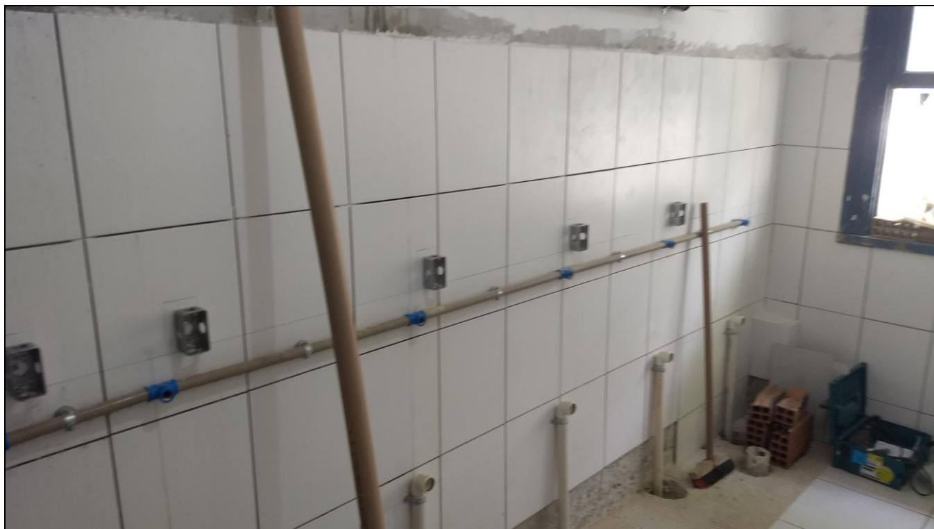
Foto 11 - Início da implantação dos quadros e eletrodutos para a instalação dos circuitos elétricos do banheiro do 3º andar
