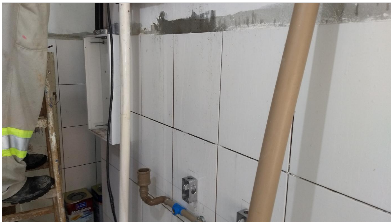
Foto 12 - Início da implantação dos quadros e eletrodutos para a instalação dos circuitos elétricos do banheiro do 3º andar
