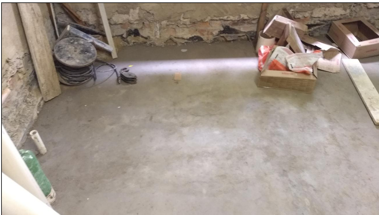
Foto 01 - Finalização da instalação do contrapiso do banheiro do 2º andar
