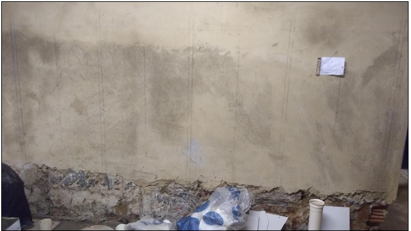
Foto 03 - Finalização do emboço das paredes do banheiro do 2º andar
