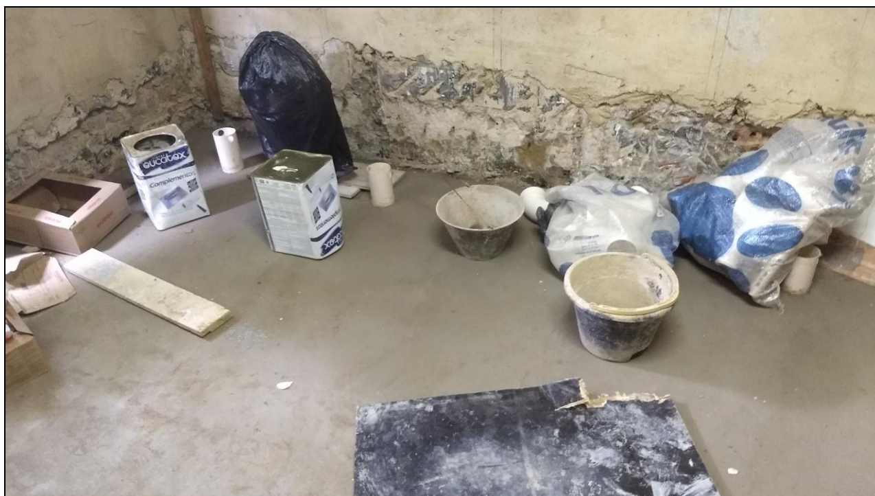
Foto 02 - Finalização da instalação do contrapiso do banheiro do 2º andar
