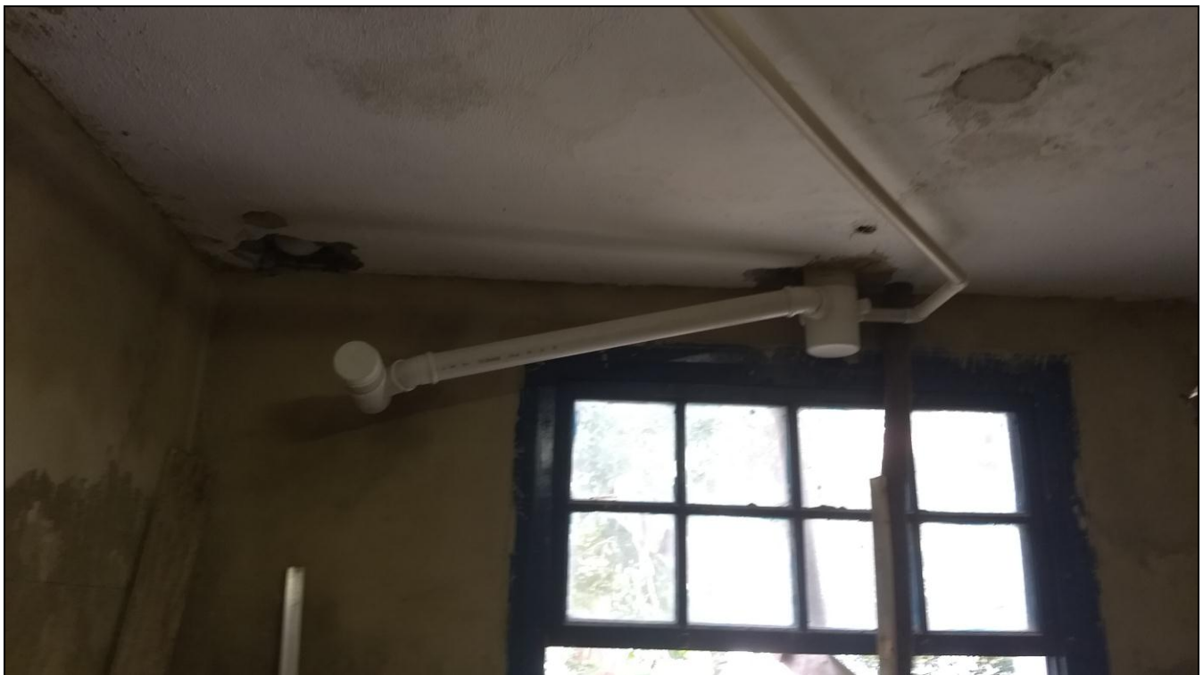
Foto 08 - Preparação para a instalação da tubulação hidráulica e de esgoto do banheiro do 2º andar
