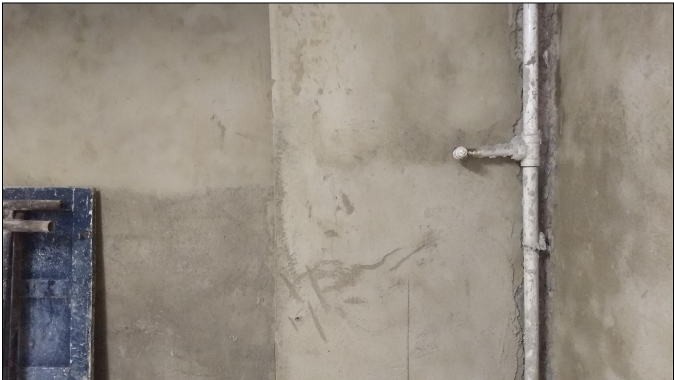
Foto 04 - Finalização do emboço das paredes do banheiro do 2º andar
