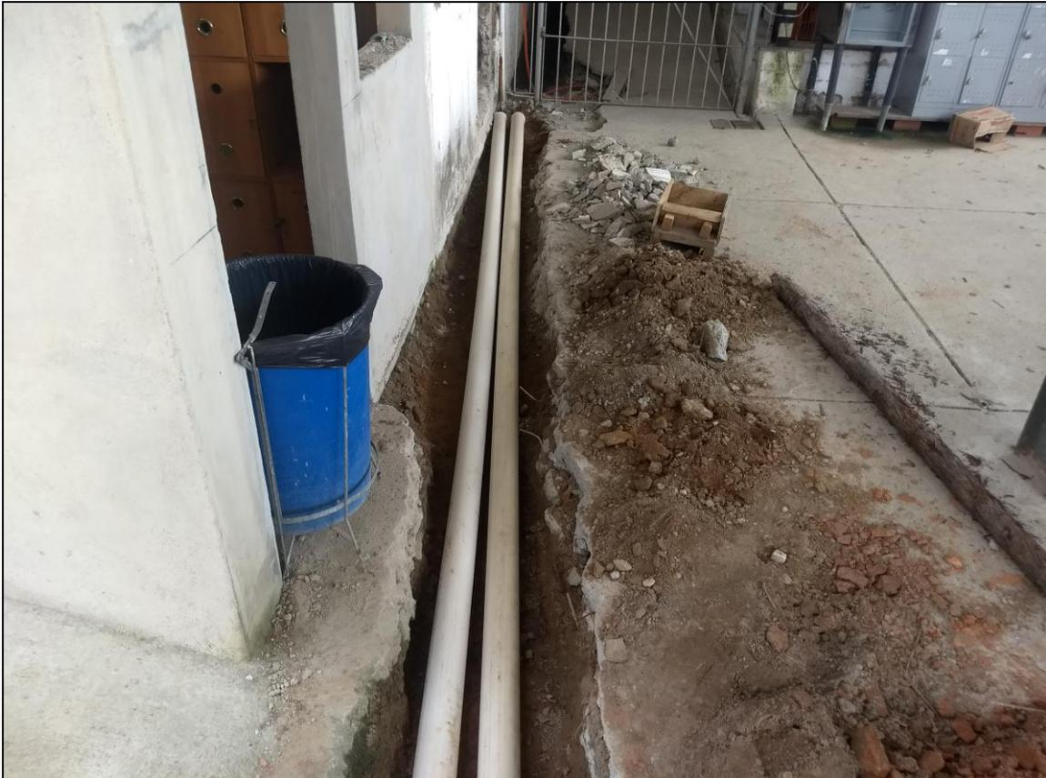
**Foto 10** - Continuidade da Instalação da rede de esgoto externa
