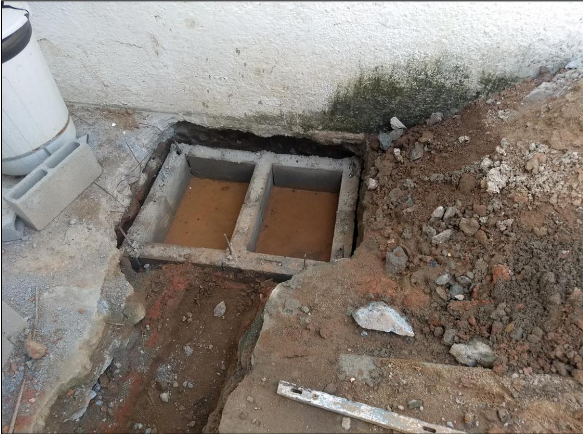
**Foto 09** - Continuidade da Instalação da rede de esgoto externa
