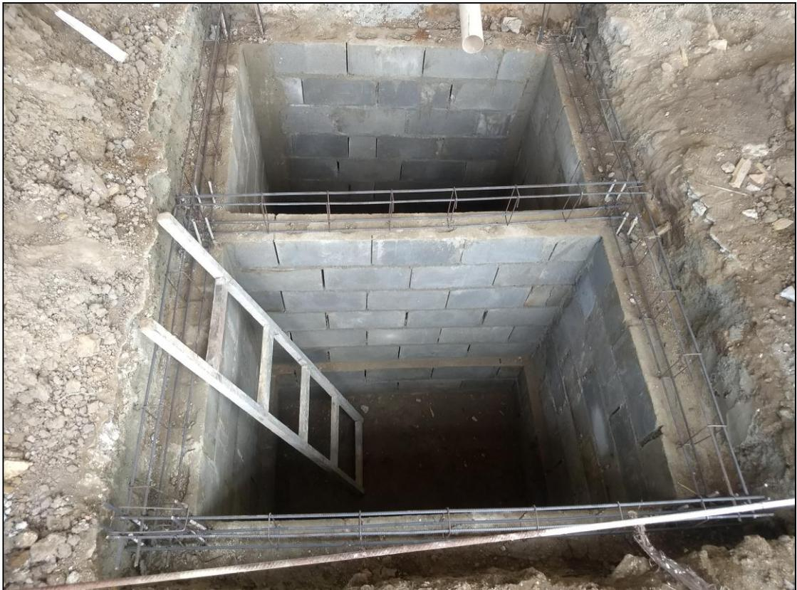
**Foto 14** - Construção de uma fossa e filtro para a rede de esgoto dos banheiros dos funcionários
