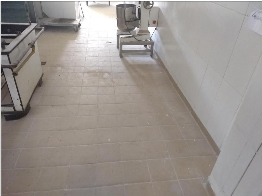
**Foto 01** - Conclusão do rejuntamento das paredes e do piso da área reformada e ampliada do RU.
