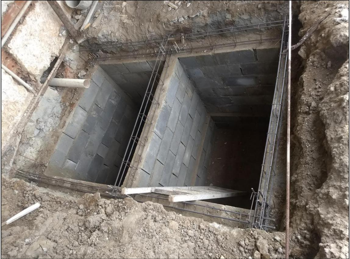
**Foto 13** - Construção de uma fossa e filtro para a rede de esgoto dos banheiros dos funcionários
