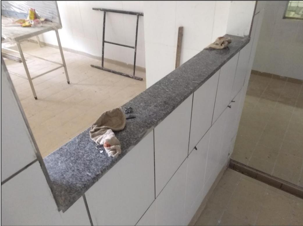
**Foto 03** - Instalação de peitoris e soleiras de granito na área reformada e ampliada do RU.
