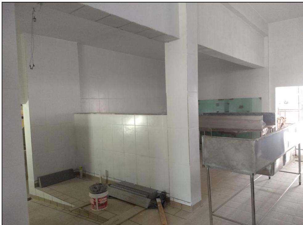
**Foto 02** - Conclusão do rejuntamento das paredes e do piso da área reformada e ampliada do RU.
