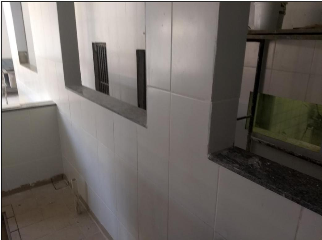
**Foto 04** - Instalação de peitoris e soleiras de granito na área reformada e ampliada do RU.
