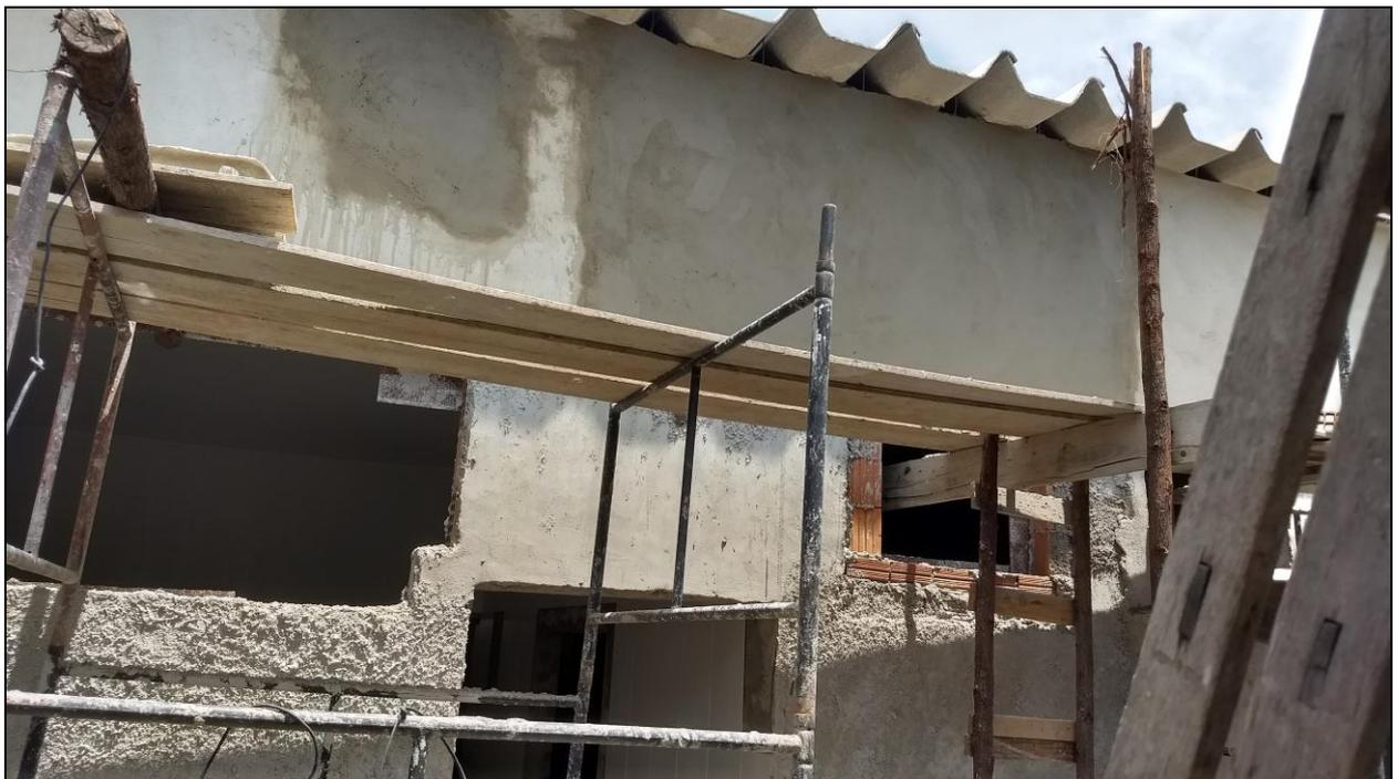
**Foto 14** - Conclusão do emboço das paredes externas da cozinha
