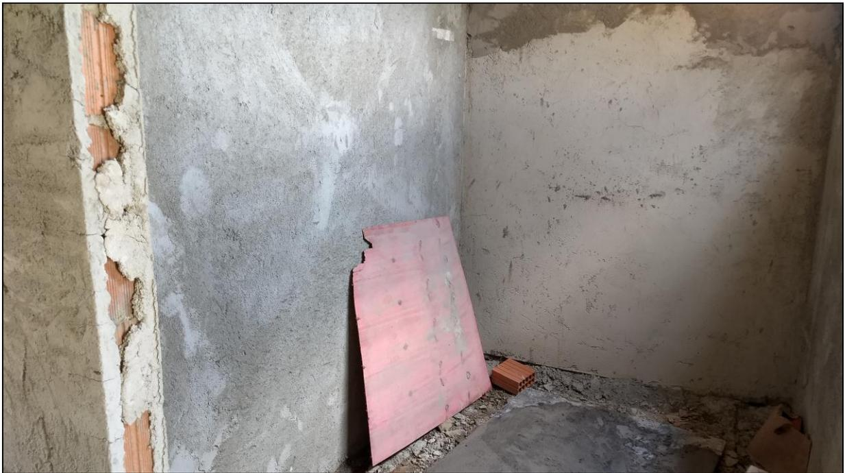
**Foto 16 - Conclusão do emboço das paredes internas da lixeira climatizada**
