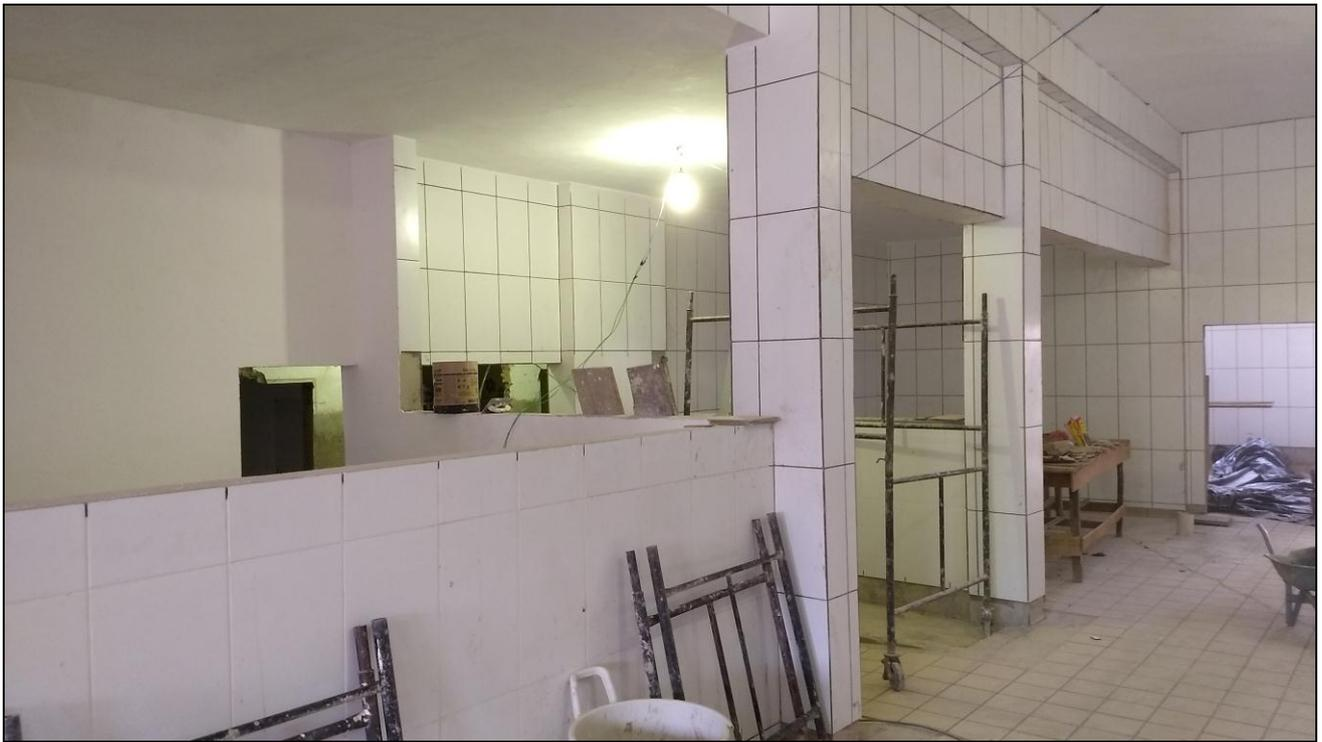
**Foto 05 - Conclusão da instalação do revestimento cerâmico das paredes**
