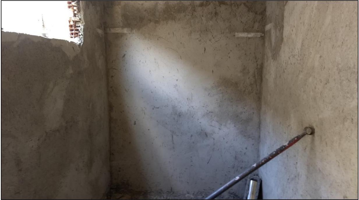
**Foto 17** - Conclusão do emboço das paredes internas da lixeira climatizada
