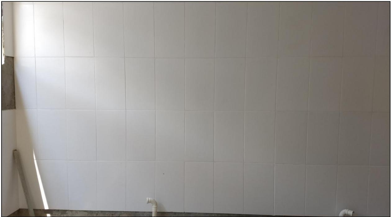
**Foto 13** - Início da implantação de rejunte branco do revestimento cerâmico das paredes
