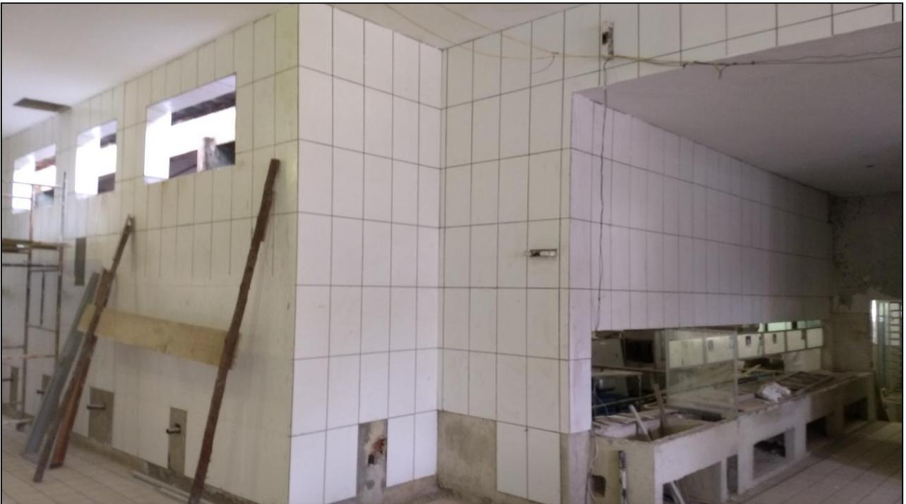
**Foto 04** - Conclusão da instalação do revestimento cerâmico das paredes
