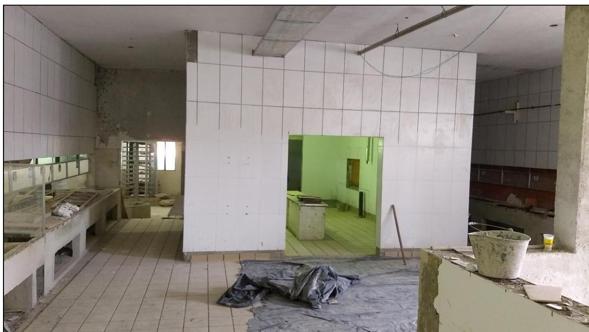
**Foto 12** - Início da implantação de rejunte branco do revestimento cerâmico das paredes
