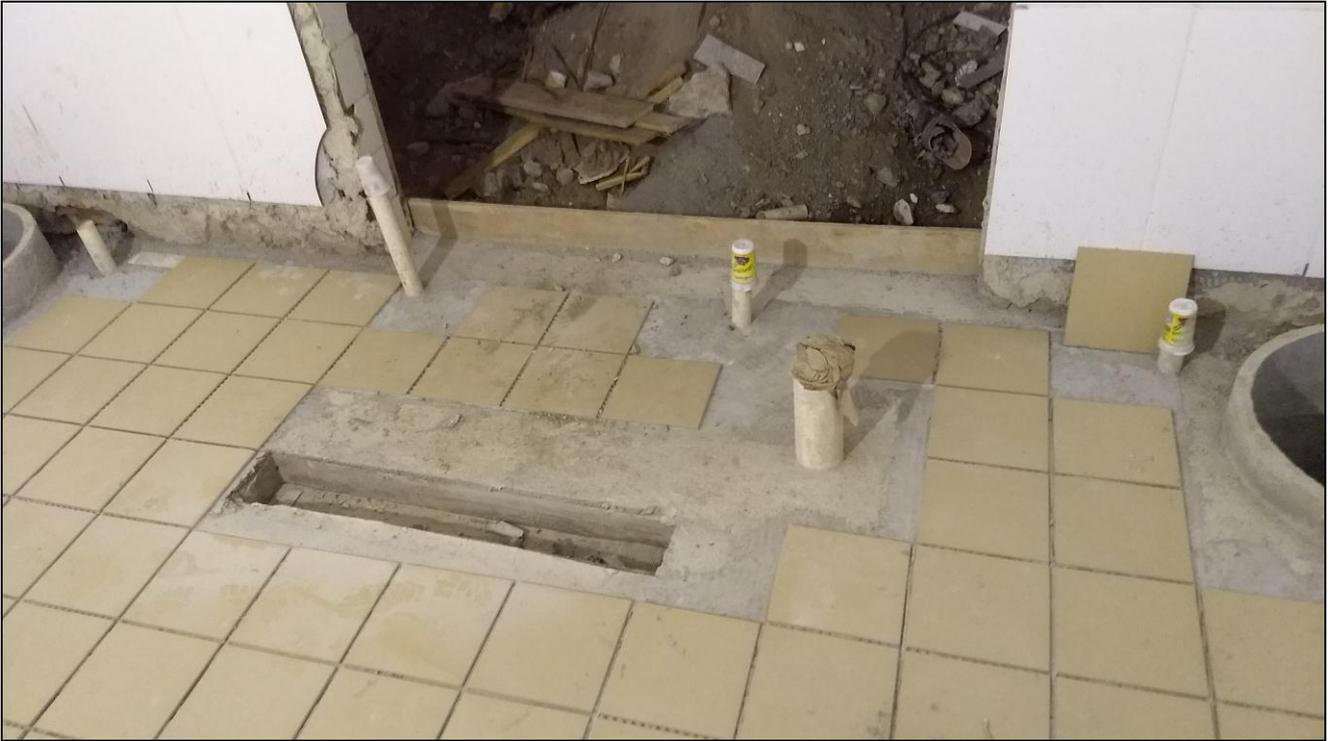
**Foto 09** - Conclusão da instalação da rede interna de esgoto
