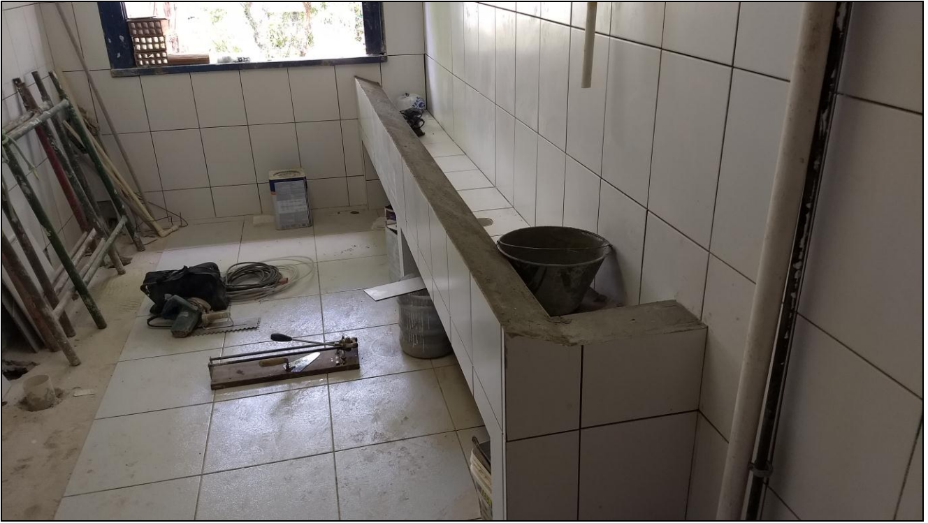
Foto 11 - Conclusão da confecção do tanque para a realização de higiene pessoal do banheiro do 3º andar
