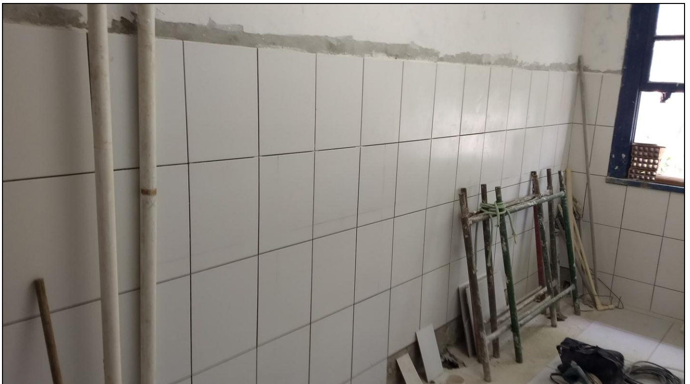
Foto 04 - Conclusão da implantação do revestimento cerâmico das paredes do banheiro do 3º Andar
