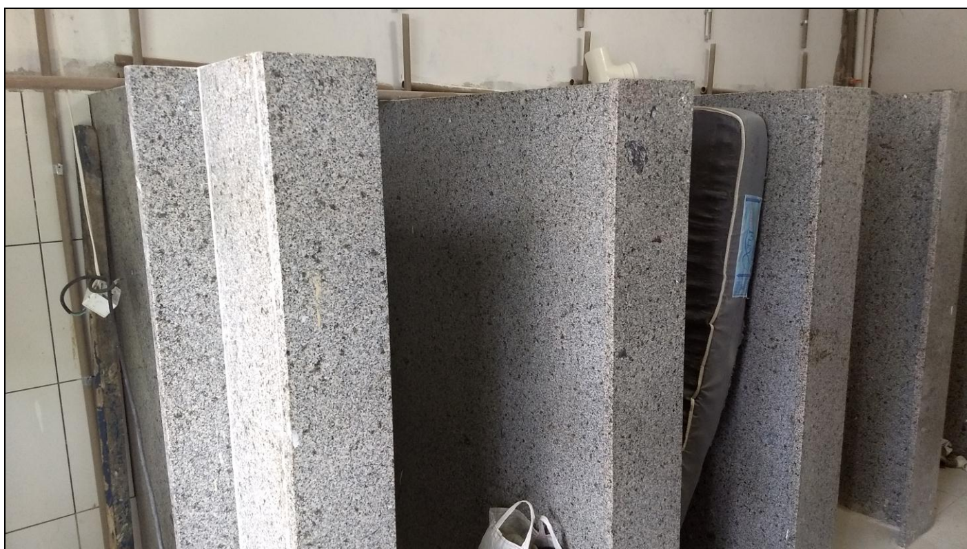
Foto 06 - Conclusão da instalação das placas divisórias de granito no banheiro do 3º andar
