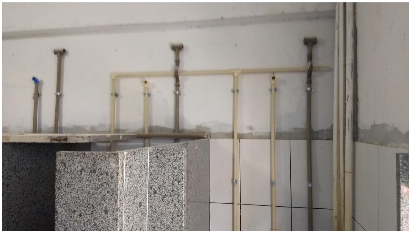
Foto 08 - Início da instalação da rede hidráulica dos chuveiros e caixas de descarga dos vasos sanitários do banheiro do 3º andar
