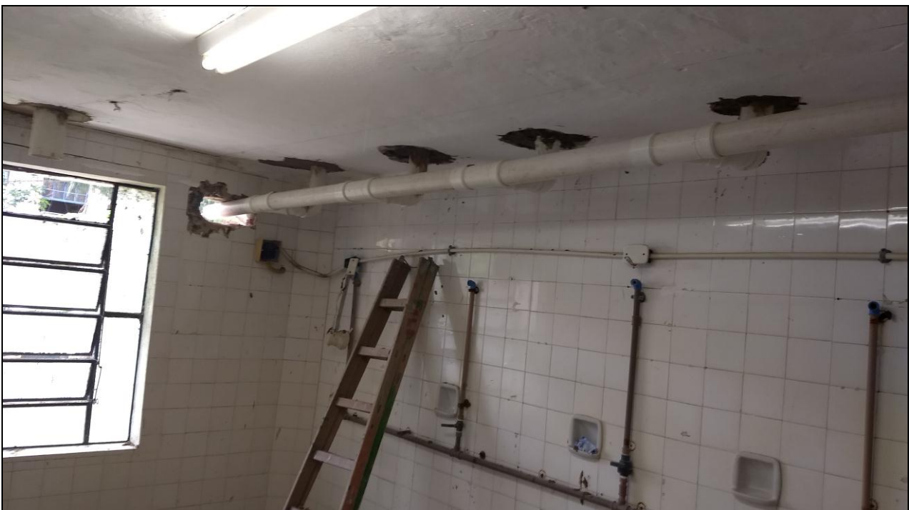
Foto 14 - Instalação das tubulações do esgoto do banheiro do 3º Andar;
