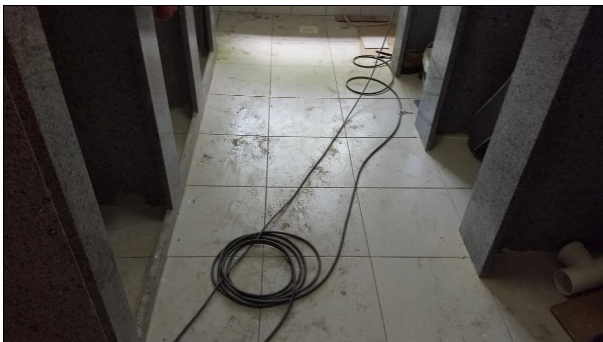
Foto 02 - Conclusão da instalação do piso do banheiro do 3º Andar
