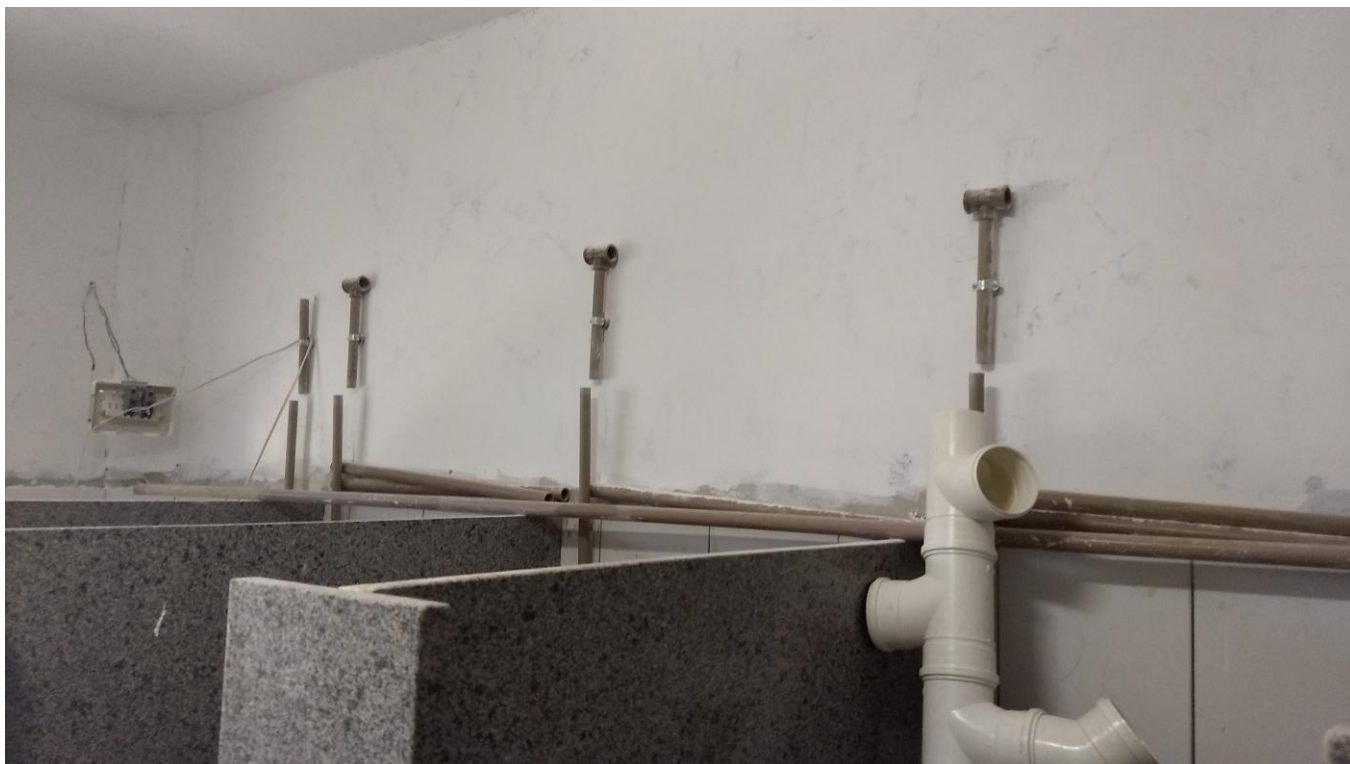
Foto 07 - Início da instalação da rede hidráulica dos chuveiros e caixas de descarga dos vasos sanitários do banheiro do 3º andar
