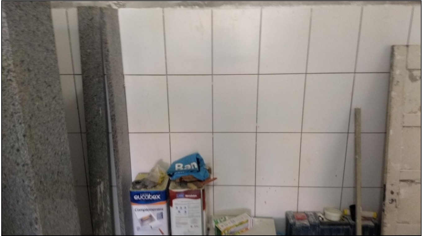
Foto 03 - Conclusão da implantação do revestimento cerâmico das paredes do banheiro do 3º Andar
