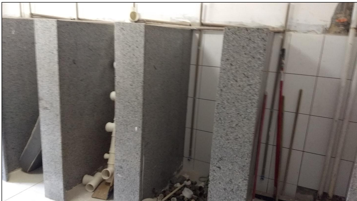
Foto 05 - Conclusão da instalação das placas divisórias de granito no banheiro do 3º andar
