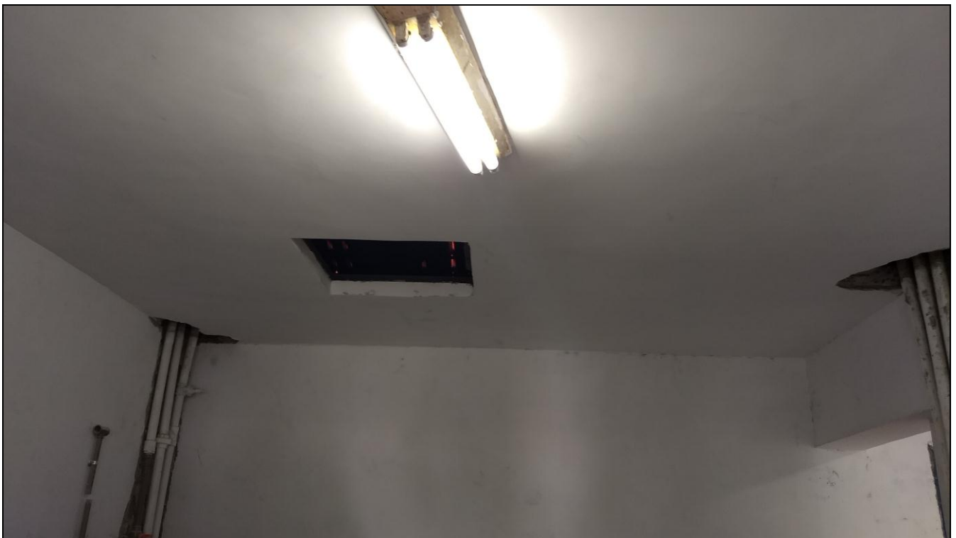
Foto 10 - Conclusão do emboço, aplicação de massa corrida e lixamento do teto do banheiro do 3º andar
