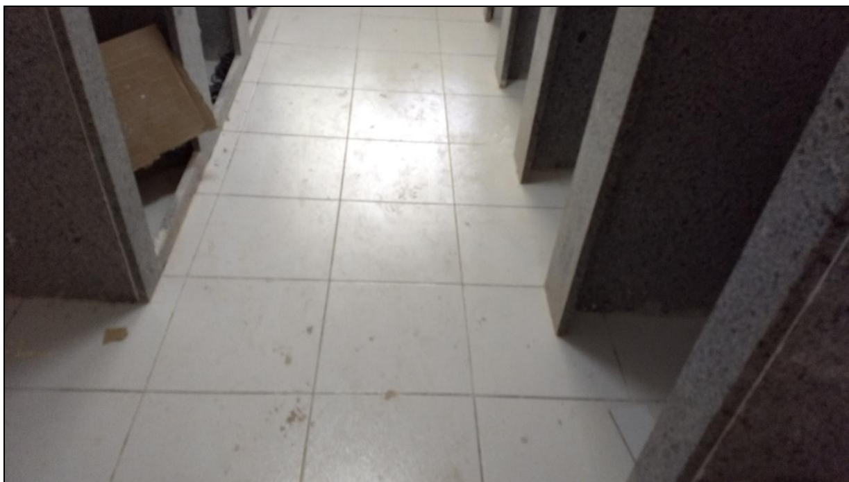
Foto 01 - Conclusão da instalação do piso do banheiro do 3º Andar
