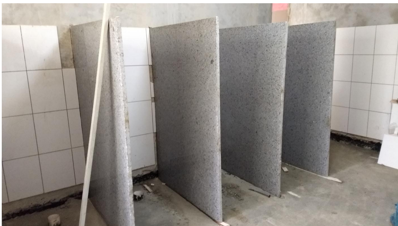
Foto 03 - Instalação de placas de granito das divisórias dos sanitários e chuveiros do banheiro do 3º Andar
