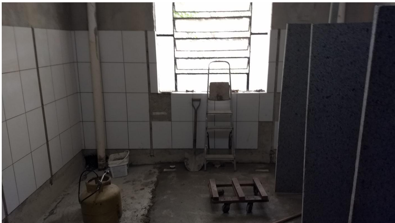
Foto 02 - Instalação de revestimento cerâmico nas paredes do banheiro do 3º Andar
