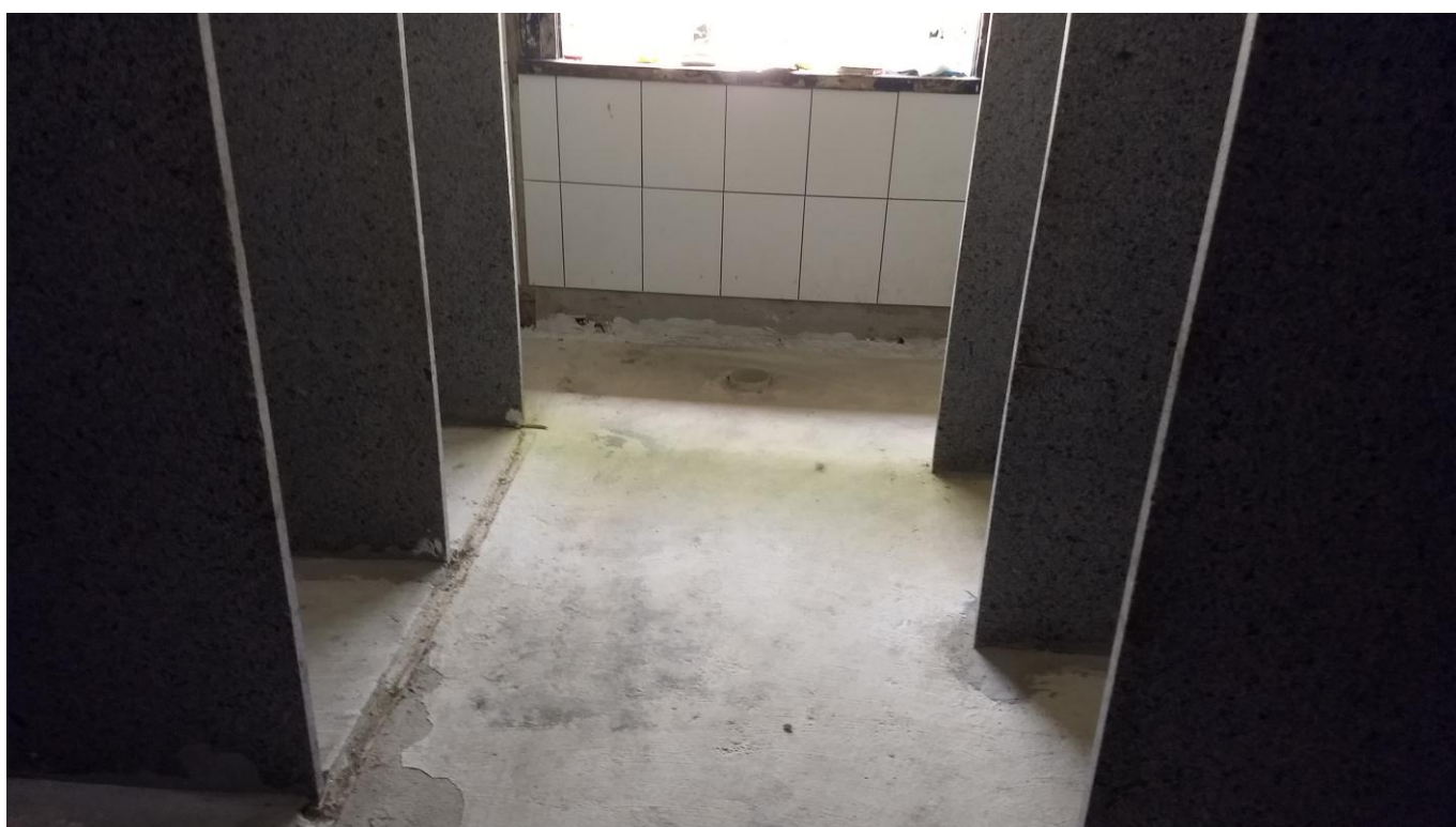
Foto 05 - Concretagem do contra piso do banheiro do 3º Andar, com implantação de manta asfáltica.
