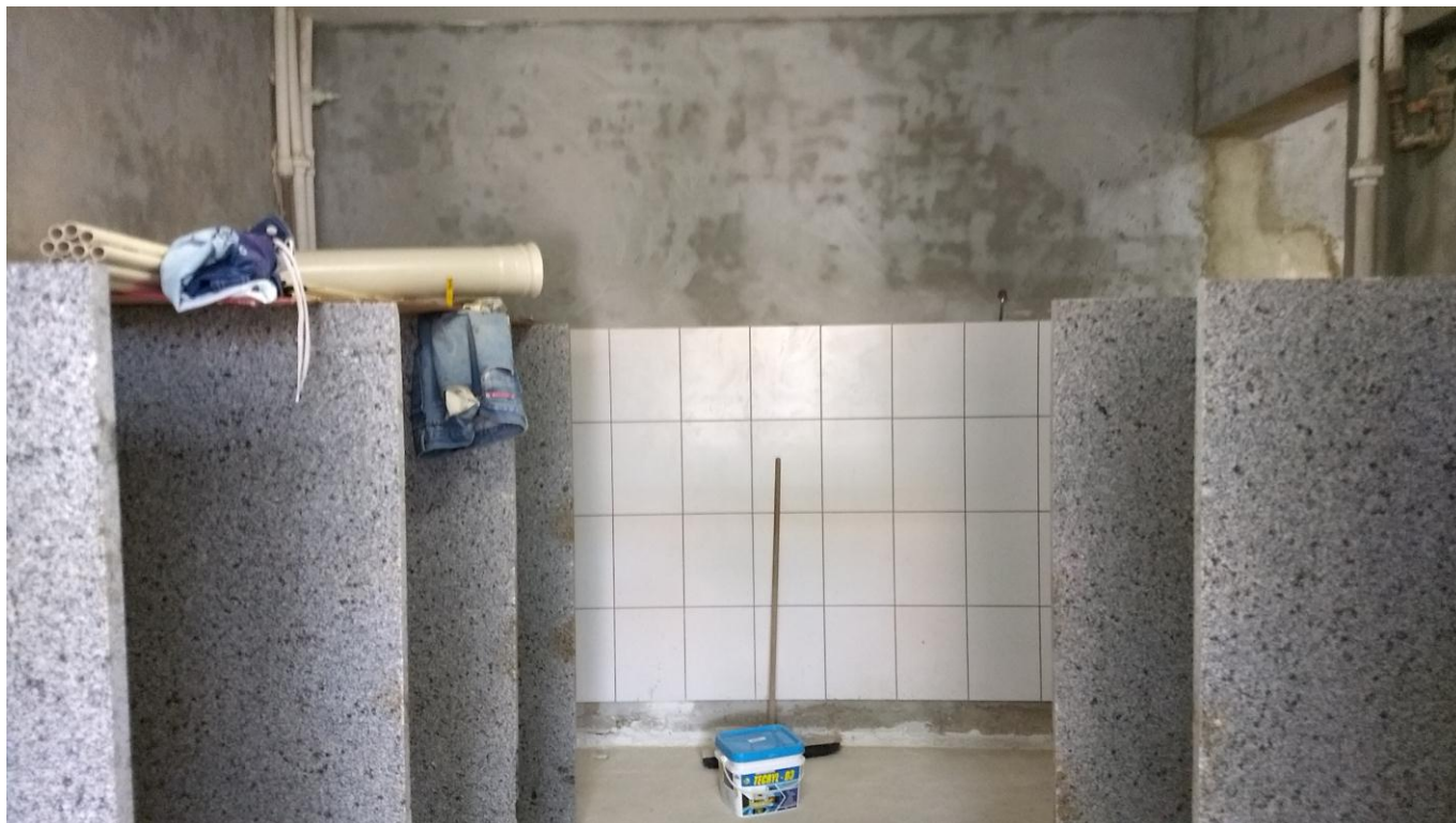
Foto 01 - Conclusão do emboço das paredes do banheiro do 3º Andar
