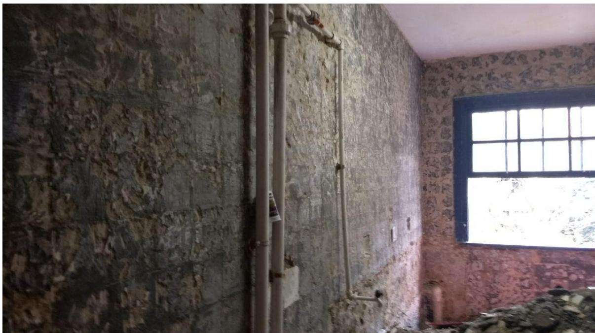
**Foto 01 - Remoção dos azulejos, do piso e do contra piso anteriormente existentes no banheiro do 3º andar do M1**
