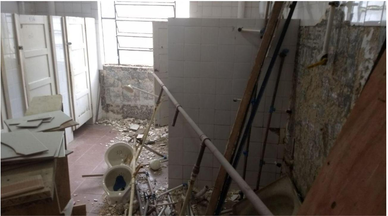
**Foto 07** - Retirada dos bebedouros de alvenaria do banheiro do 3º andar do M1
