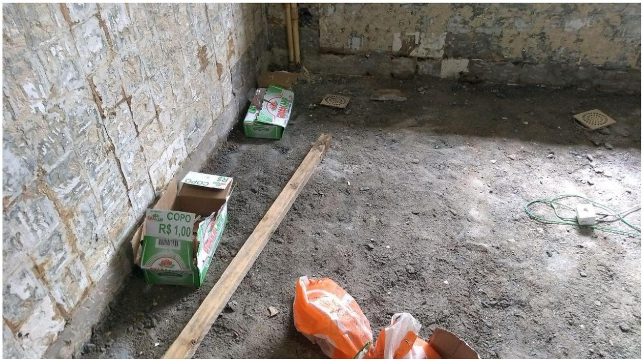
**Foto 05** - Remoção dos azulejos, do piso e do contra piso anteriormente existentes no banheiro do 3º andar do M1
