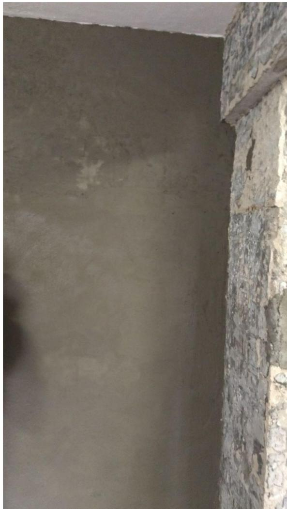
**Foto 08** - Início do emboço das paredes do banheiro para posterior instalação de azulejos novos
