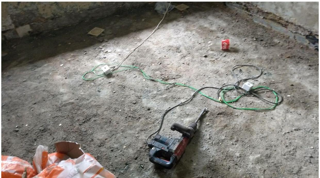
**Foto 04** - Remoção dos azulejos, do piso e do contra piso anteriormente existentes no banheiro do 3º andar do M1
