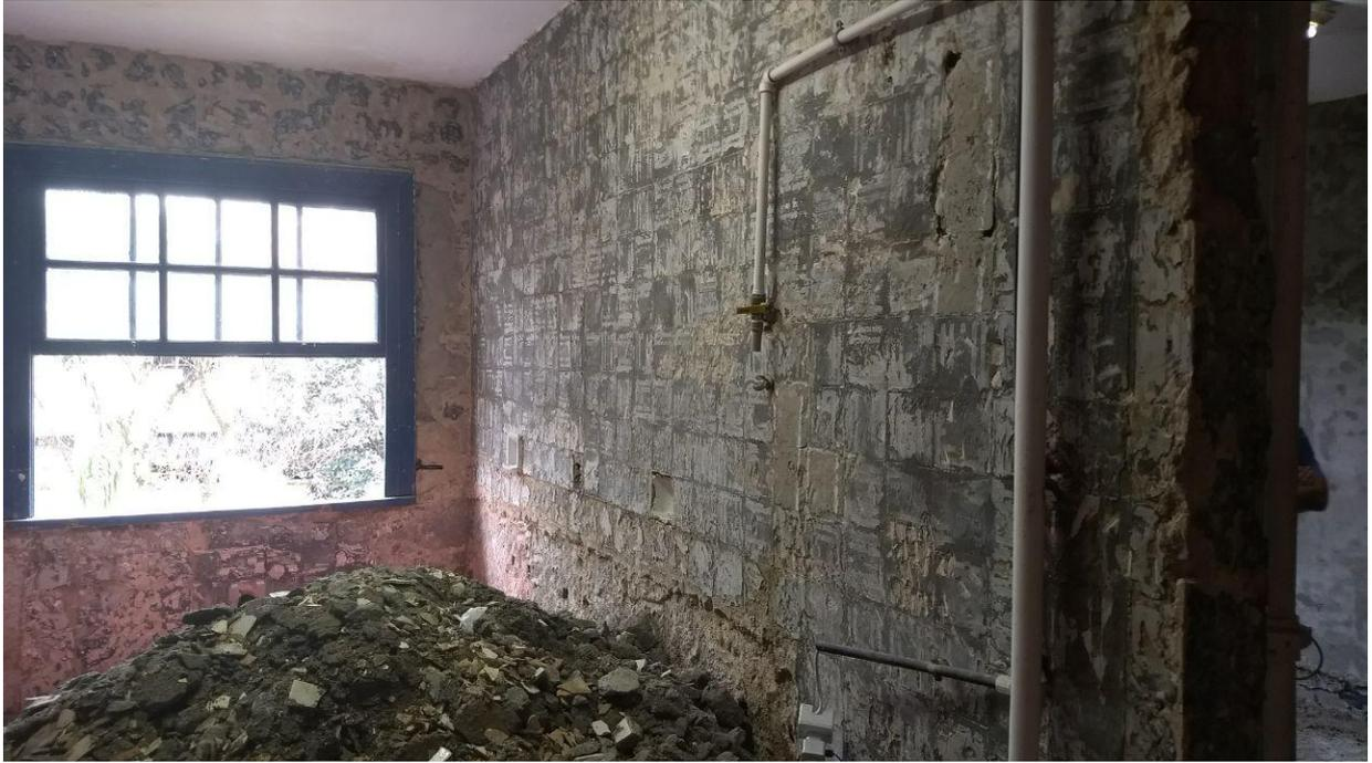
**Foto 03** - Remoção dos azulejos, do piso e do contra piso anteriormente existentes no banheiro do 3º andar do M1
