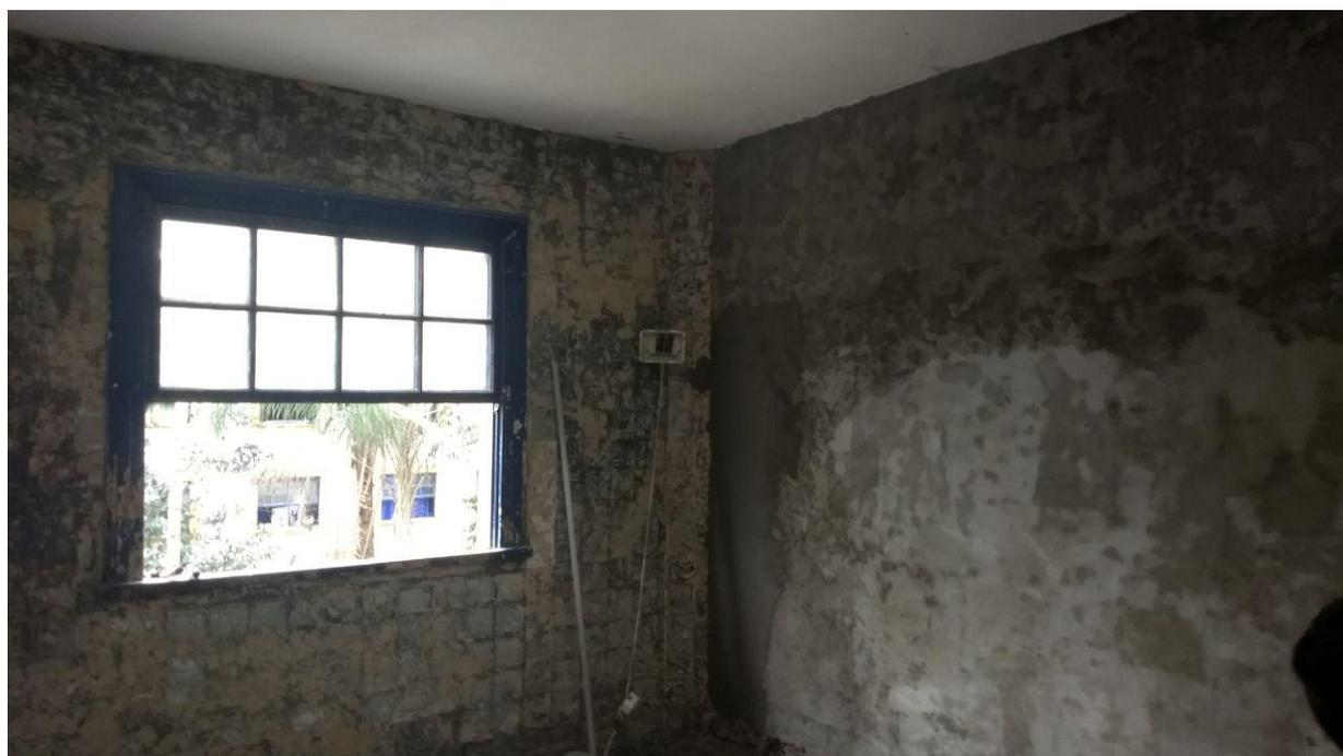
**Foto 02 - Remoção dos azulejos, do piso e do contra piso anteriormente existentes no banheiro do 3º andar do M1**
