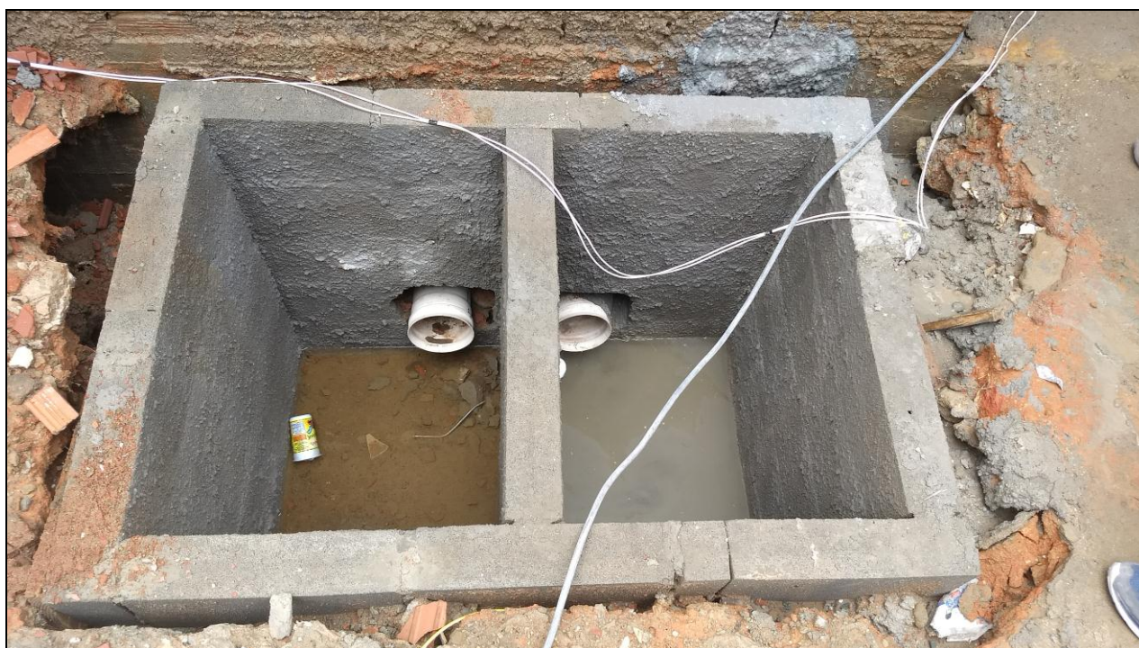
Foto 15 - Início da instalação da rede externa de esgoto
