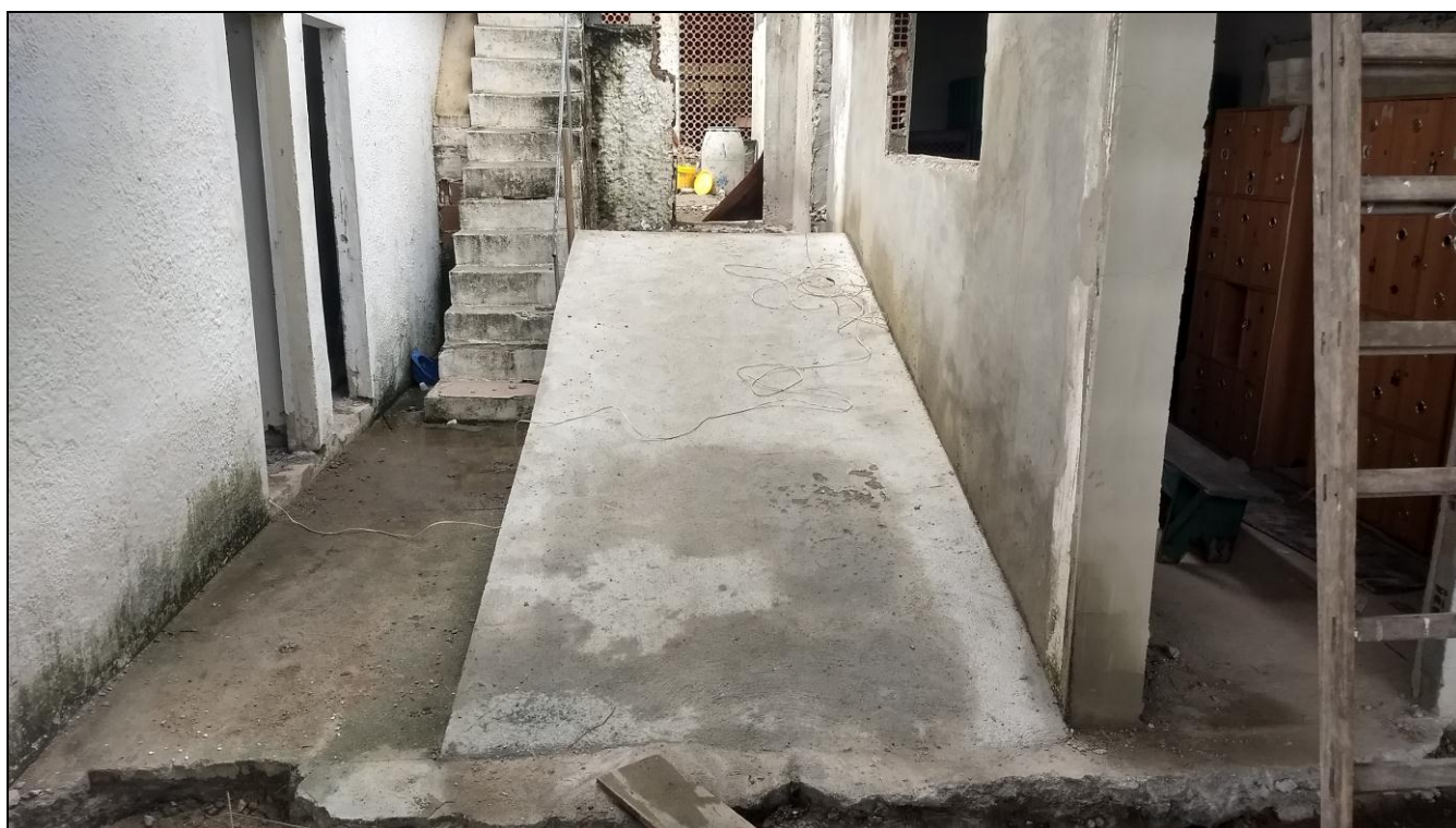
Foto 11 - Conclusão da rampa de acesso da área de serviço externa
