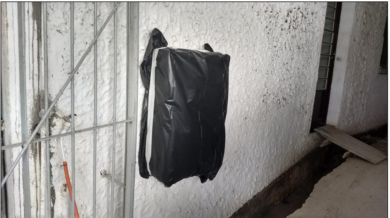
Foto 17 - Instalação dos quadros de distribuição de energia elétrica
