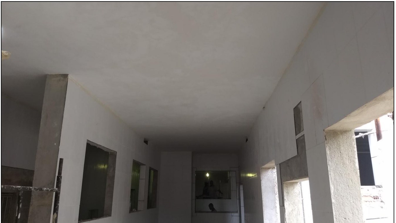
Foto 18 - Início da pintura do teto, com selador e aplicação de massa corrida na área de pré-preparo
