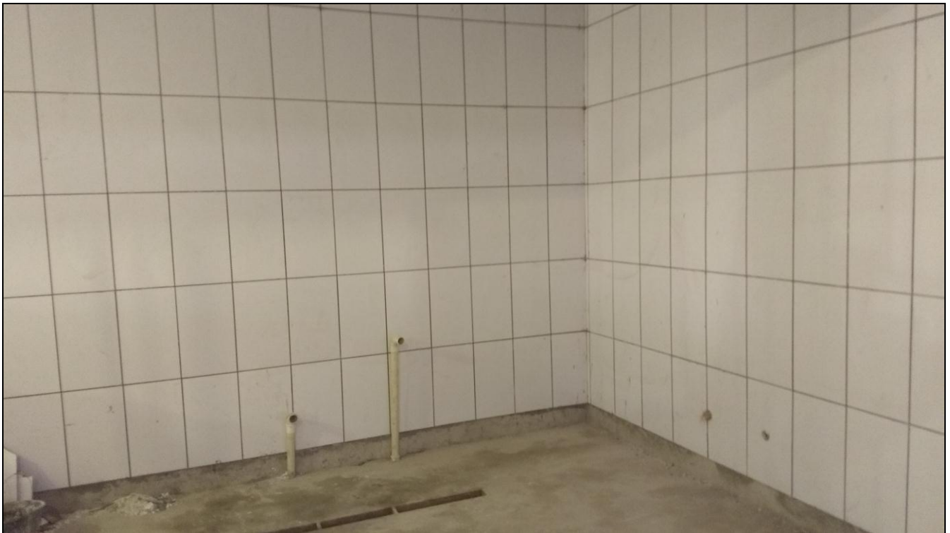
Foto 06 - Implantação de revestimento cerâmico nas paredes
