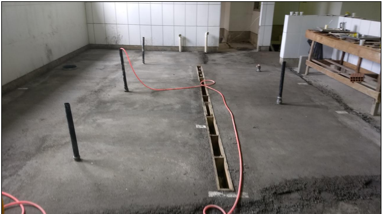
Foto 01 - Regularização de contrapiso para posterior implantação de piso Gail
