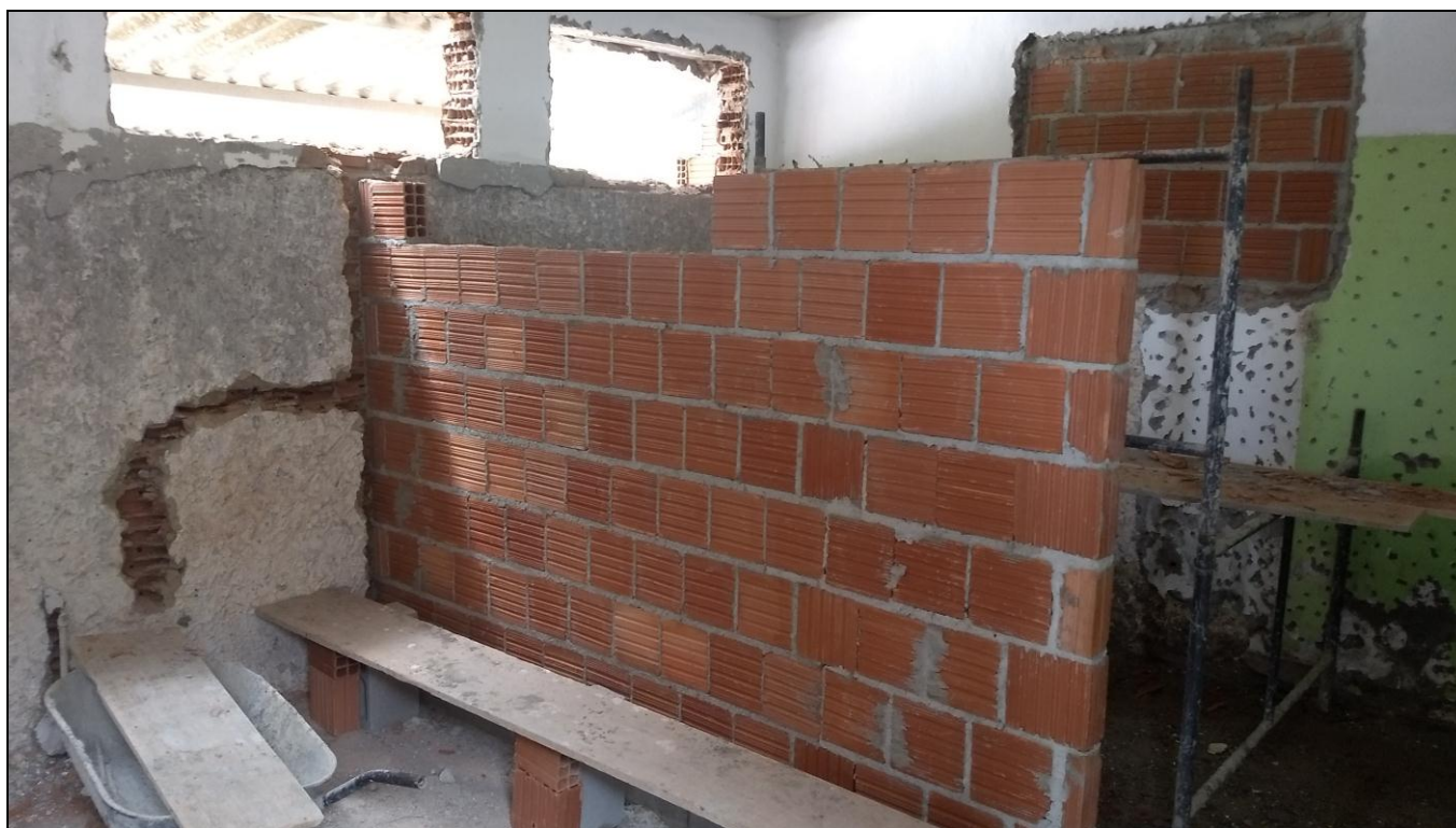
Foto 13 - Finalização da remoção dos azulejos antigos e construção de paredes dos banheiros dos funcionários
