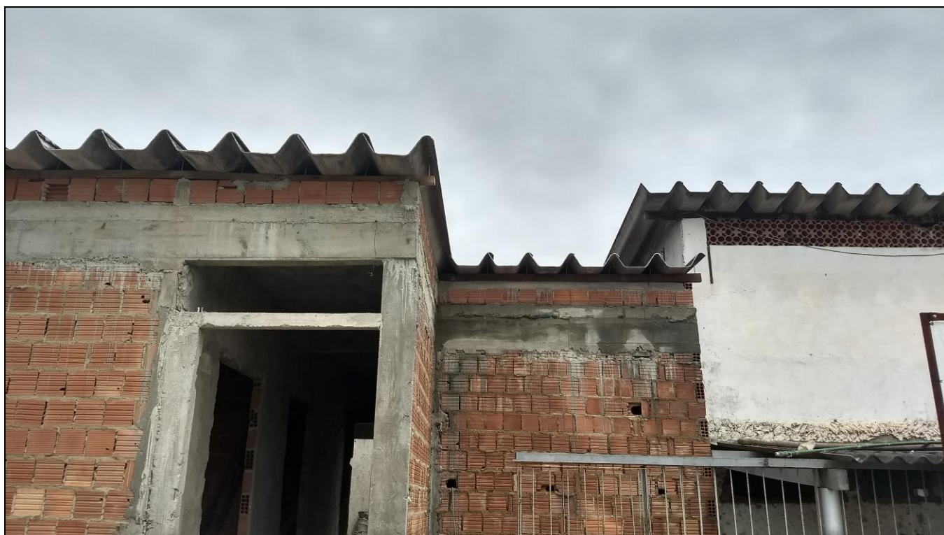
Foto 10 - Conclusão da implantação do telhado da área reformada e expandida
