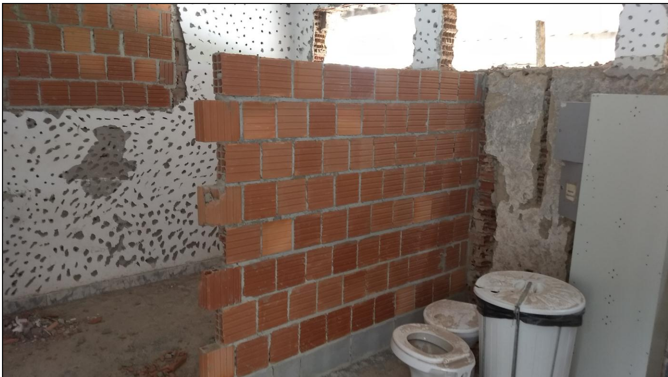
Foto 12 - Finalização da remoção dos azulejos antigos e construção de paredes dos banheiros dos funcionários
