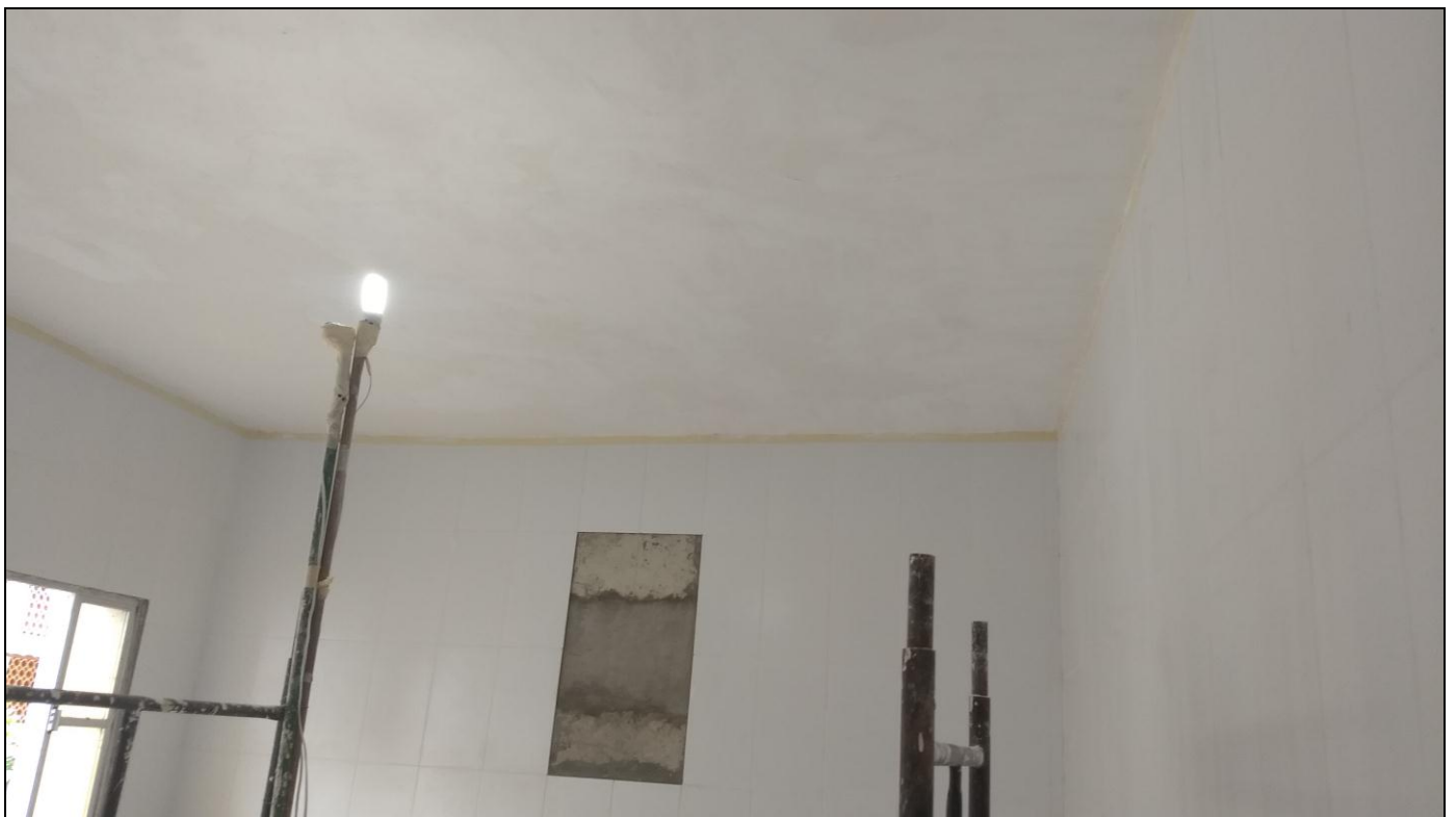
Foto 19 - Início da pintura do teto, com selador e aplicação de massa corrida na área de pré-preparo
