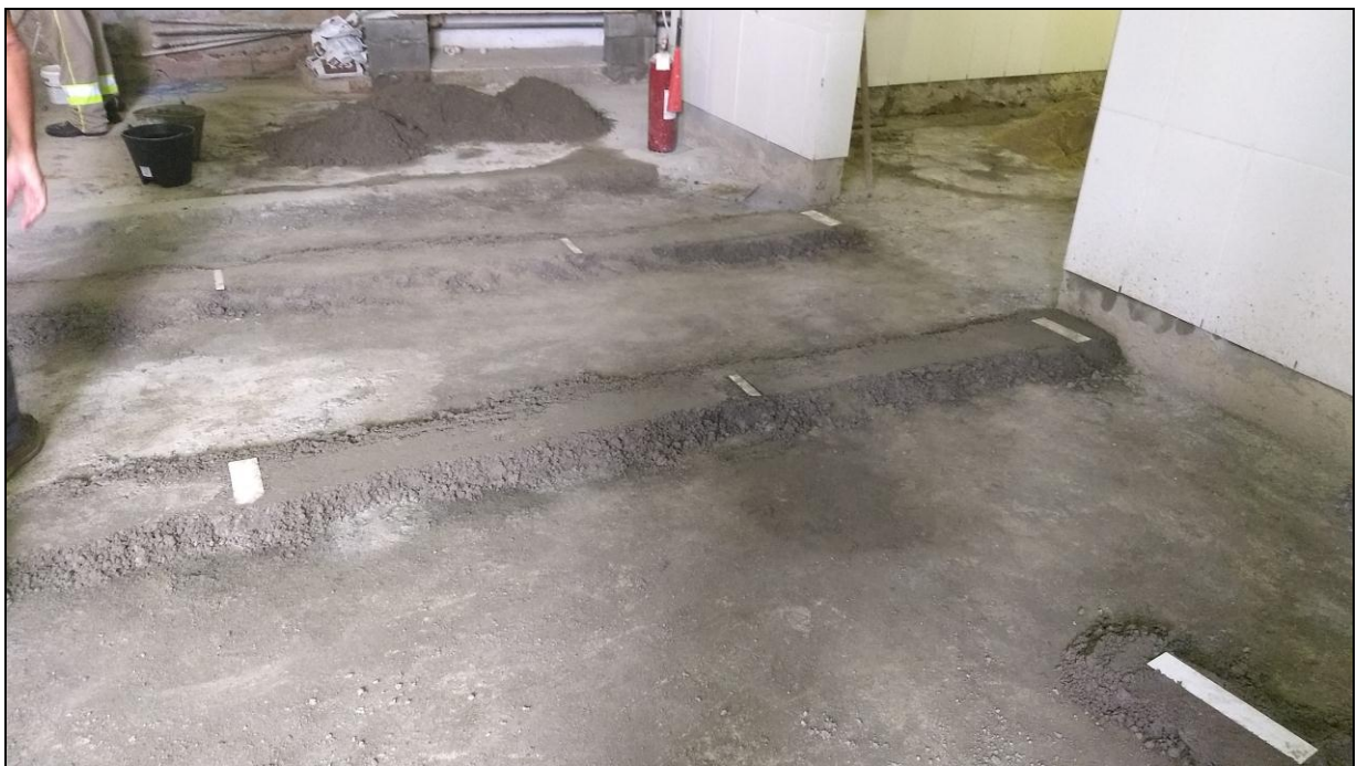
Foto 02 - Regularização de contrapiso para posterior implantação de piso Gail
