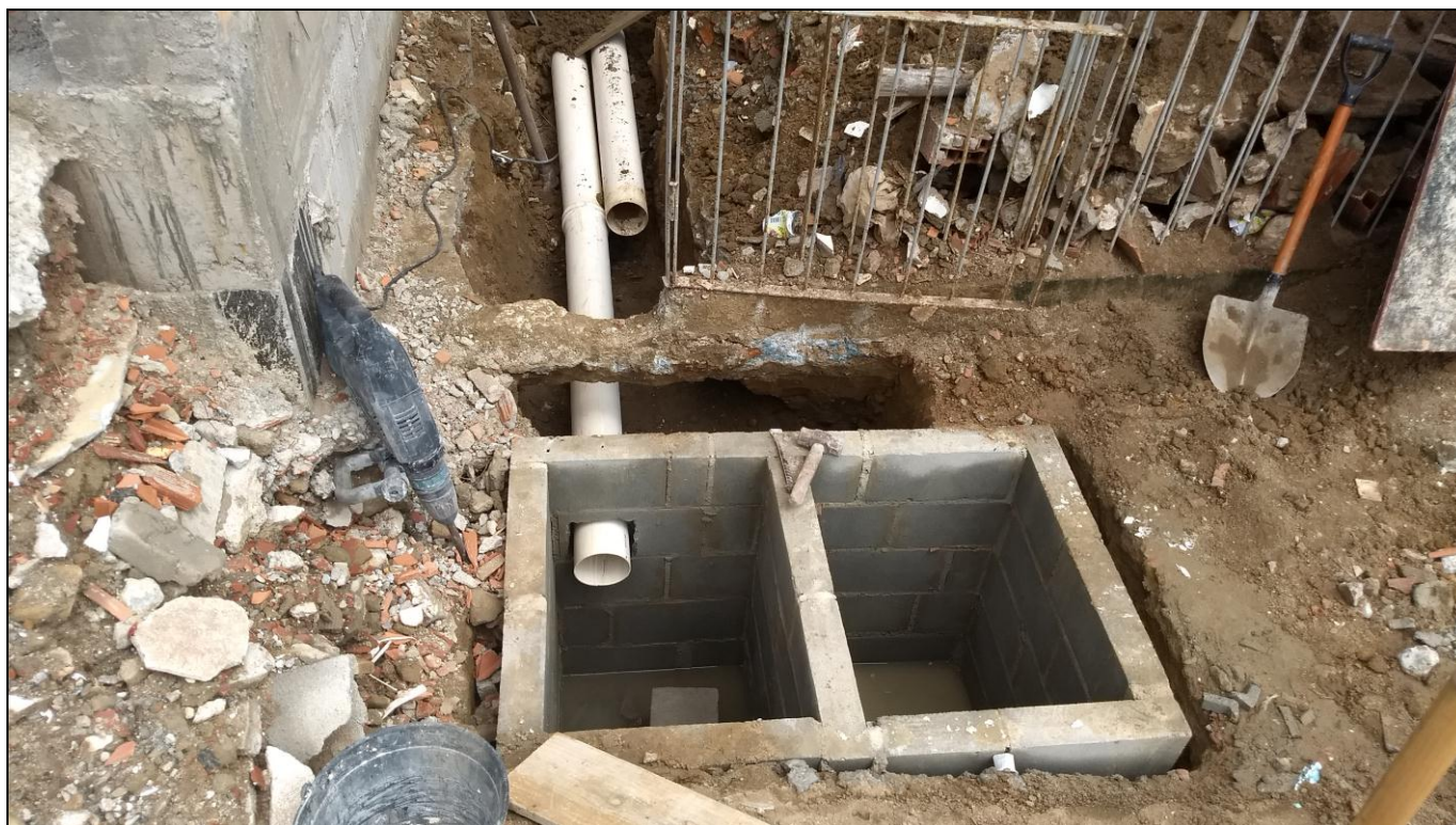
Foto 14 - Início da instalação da rede externa de esgoto
