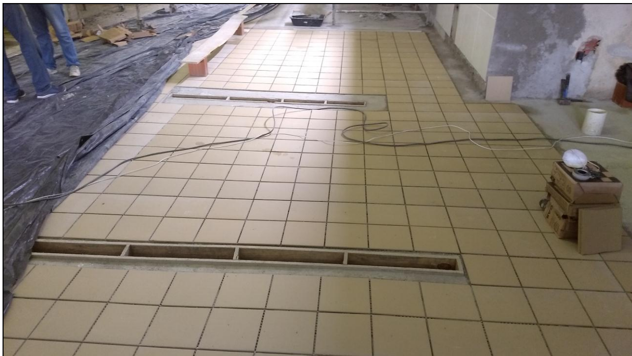
Foto 03 - Implantação de piso Gail na área reformada e expandida
