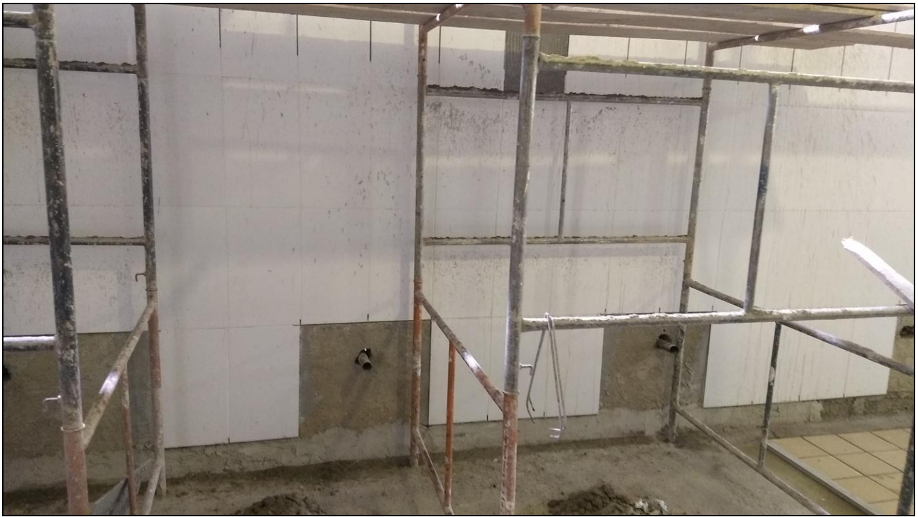
Foto 05 - Implantação de revestimento cerâmico nas paredes
