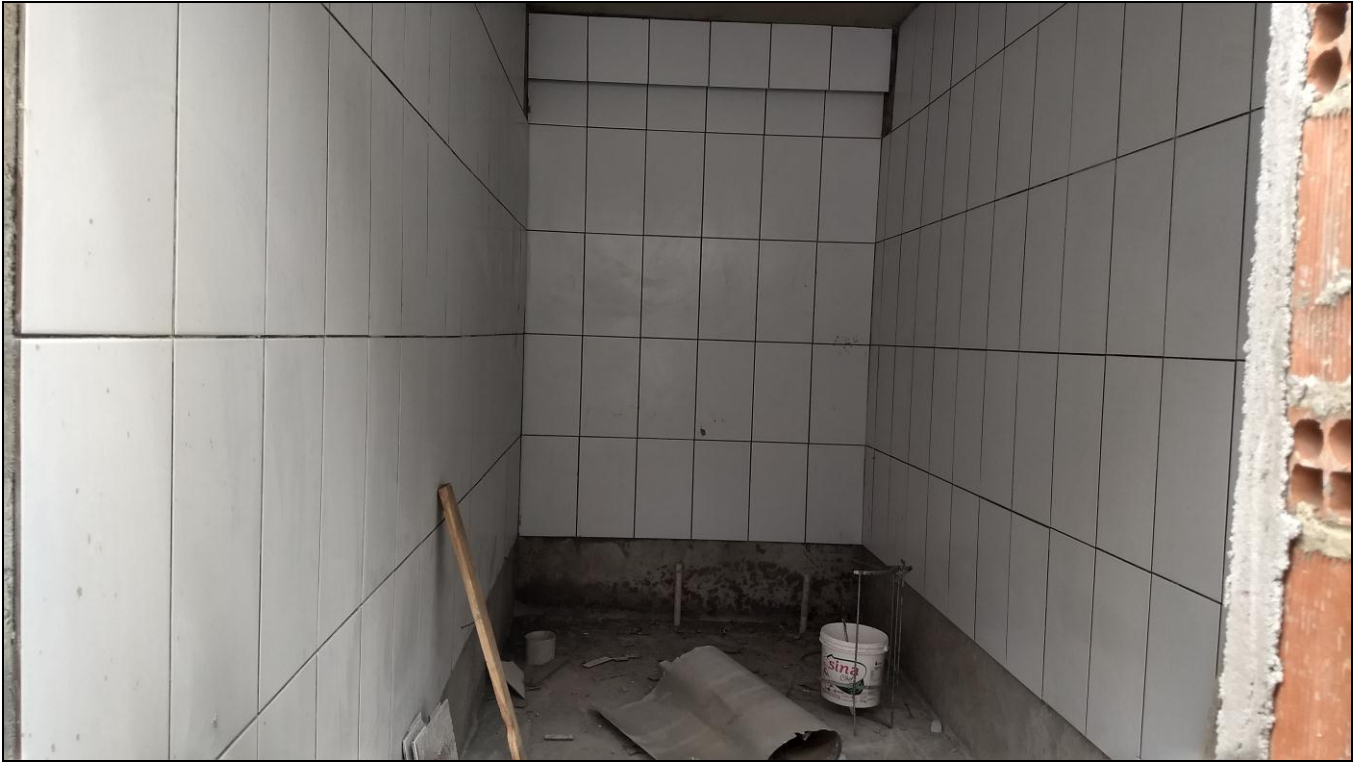
Foto 07 - Implantação de revestimento cerâmico nas paredes
