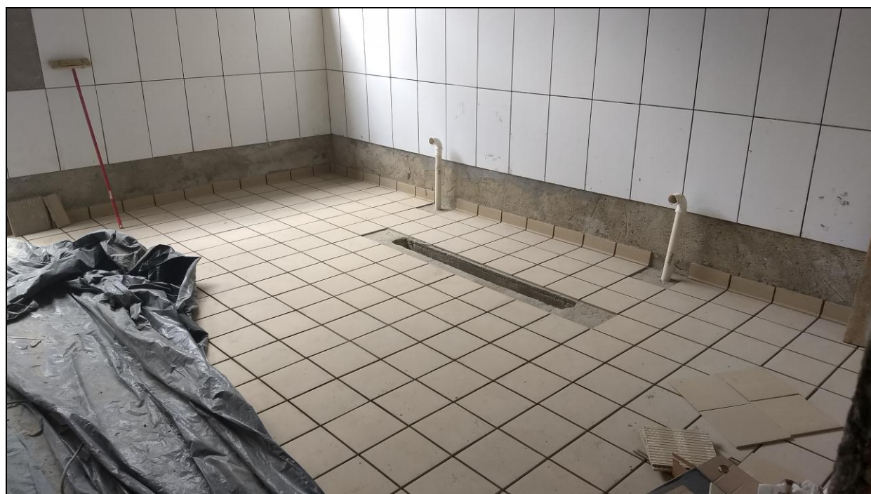
Foto 04 - Implantação de piso Gail na área reformada e expandida
