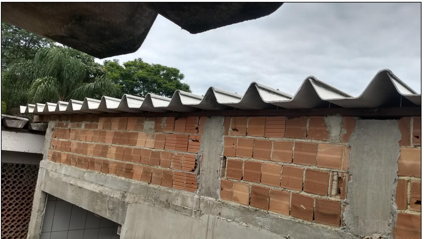
Foto 08 - Conclusão da implantação do telhado da área reformada e expandida
