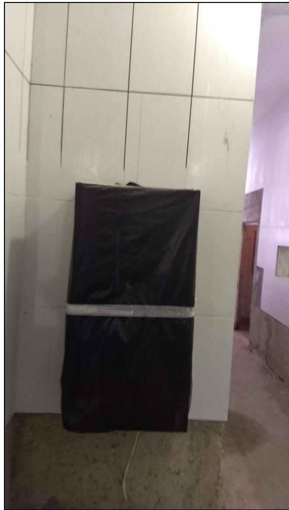
Foto 16 - Instalação dos quadros de distribuição de energia elétrica
