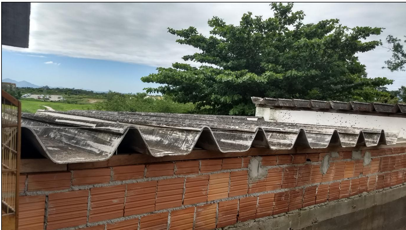
Foto 09 - Conclusão da implantação do telhado da área reformada e expandida
