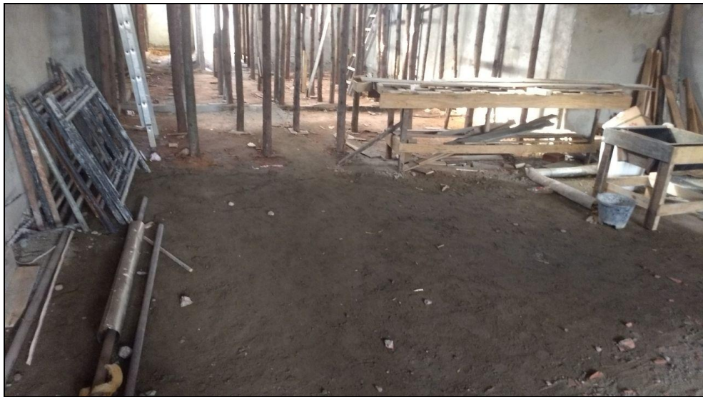
Foto 10 - Continuidade do aterro com compactação para posterior execução da laje do piso da área construída
