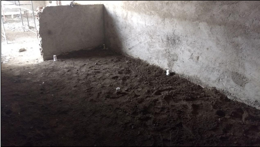
Foto 09 - Continuidade do aterro com compactação para posterior execução da laje do piso da área construída
