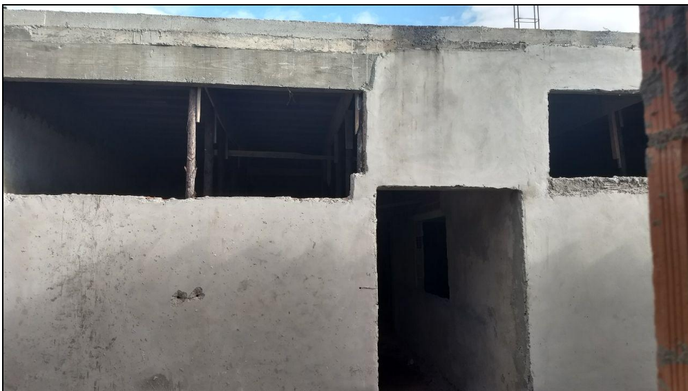
Foto 08 – Continuidade do emboço das paredes da área construída
