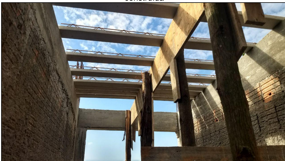
Foto 11 - Início da instalação das vigotas para a laje da lixeira climatizada.
