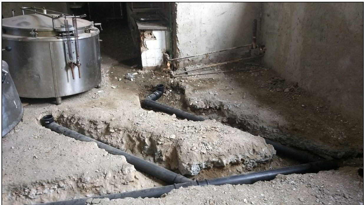
Foto 02 - Início da instalação das tubulações da rede de esgoto da cozinha do RU
