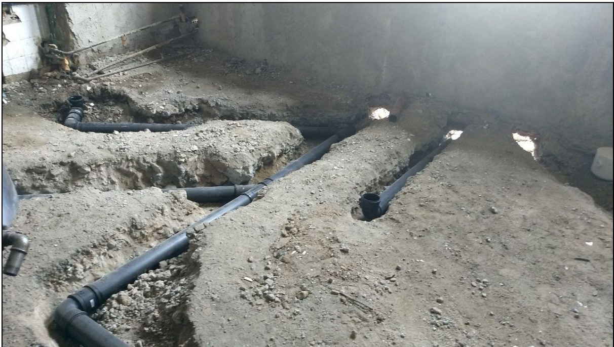
Foto 01 - Início da instalação das tubulações da rede de esgoto da cozinha do RU
