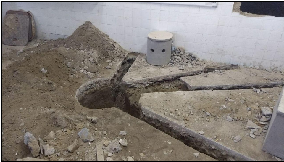
Foto 03 - Início da instalação das tubulações da rede de esgoto da cozinha do RU
