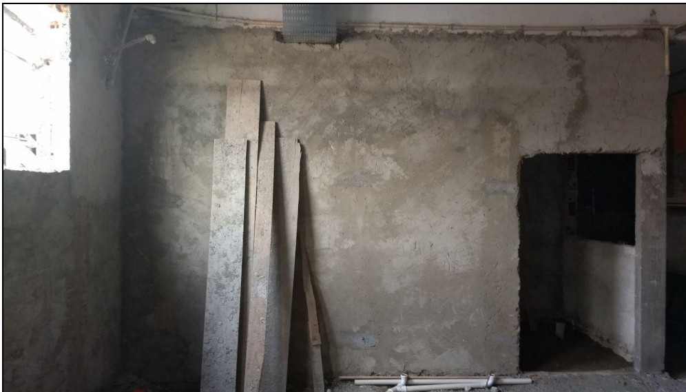
Foto 07 – Continuidade do emboço das paredes da área construída
