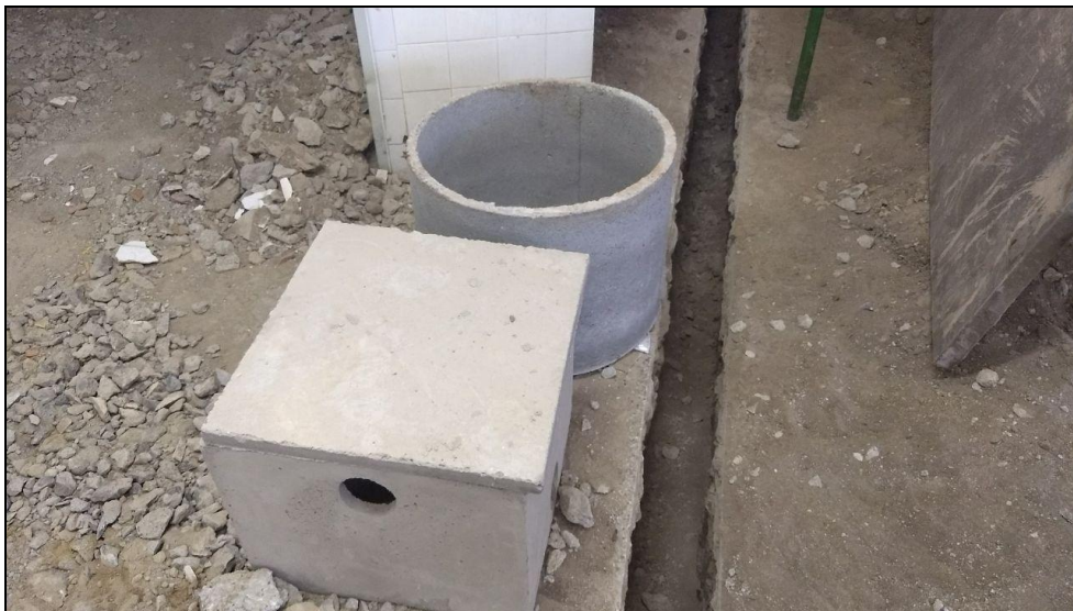
Foto 04 - Início da instalação das tubulações da rede de esgoto da cozinha do RU
