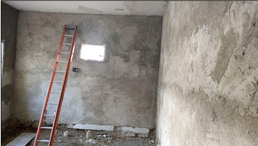
Foto 06 – Continuidade do emboço das paredes da área construída
