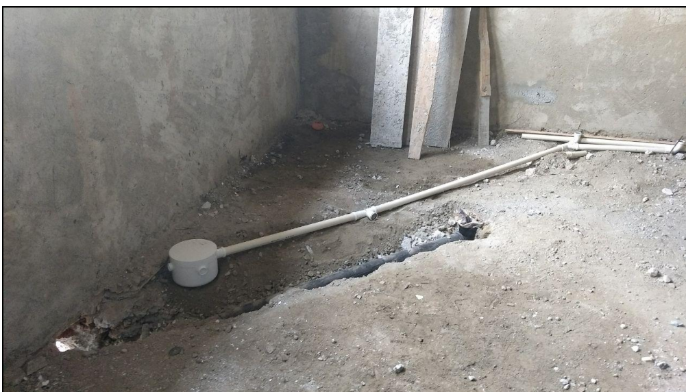
Foto 05 - Início da instalação das tubulações da rede de esgoto da cozinha do RU
