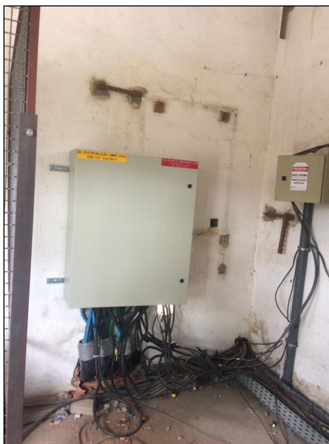
Foto 10 – Instalação do quadro de ligação da subestação
