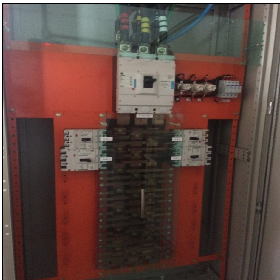
Foto 06 - Instalação do quadro geral de distribuição de energia
