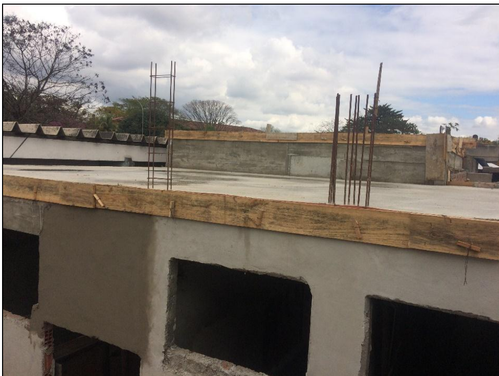
Foto 04 – Continuidade do emboço da área do Pré-preparo de leguminosas
