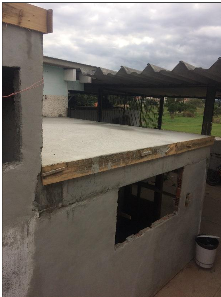
Foto 01 - Concretagem da laje da recepção
