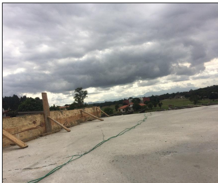
Foto 02 - Concretagem da área de higienização
