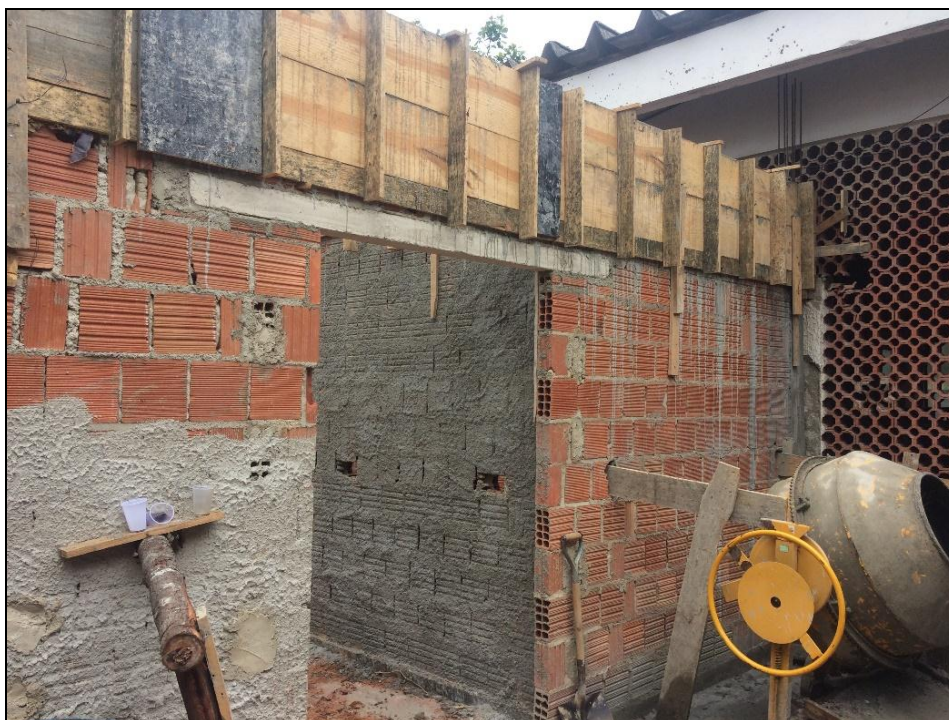
Foto 05 – Continuidade da concretagem da área da lixeira climatizada
