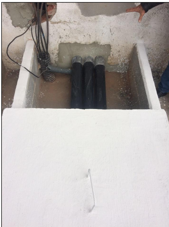
Foto 09 - Colocação dos cabos da subestação até o quadro Geral e o fechamento
