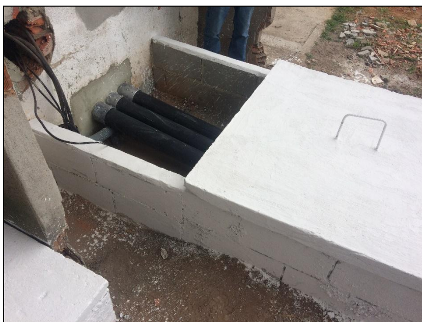
Foto 08 - Colocação dos cabos da subestação até o quadro Geral e o fechamento
