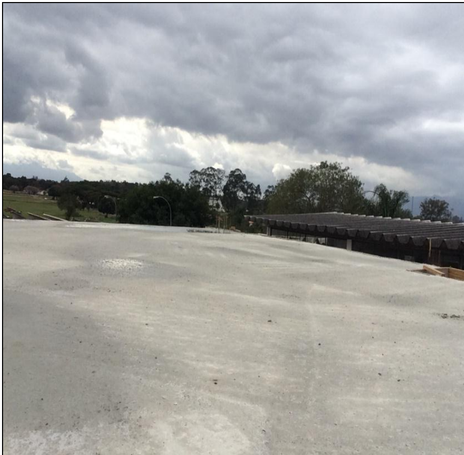
Foto 03 - Concretagem da laje da cozinha
