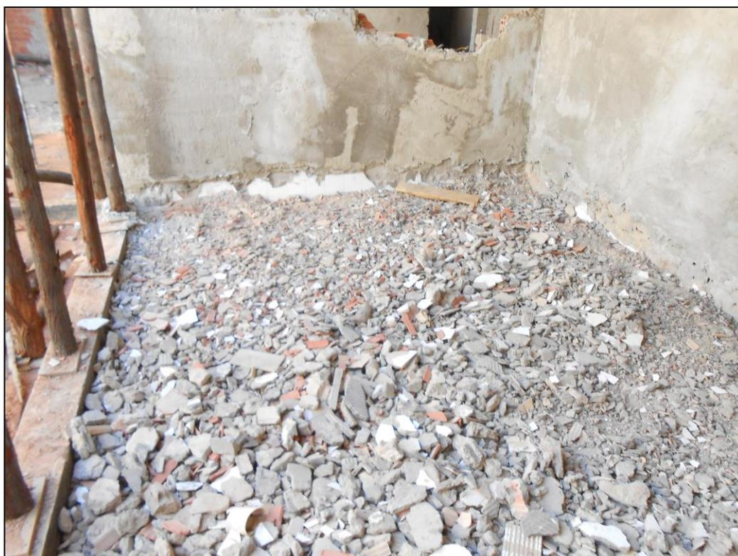
**Foto 08** - Aterro e compactação da área de expansão da cozinha e da lixeira climatizada
