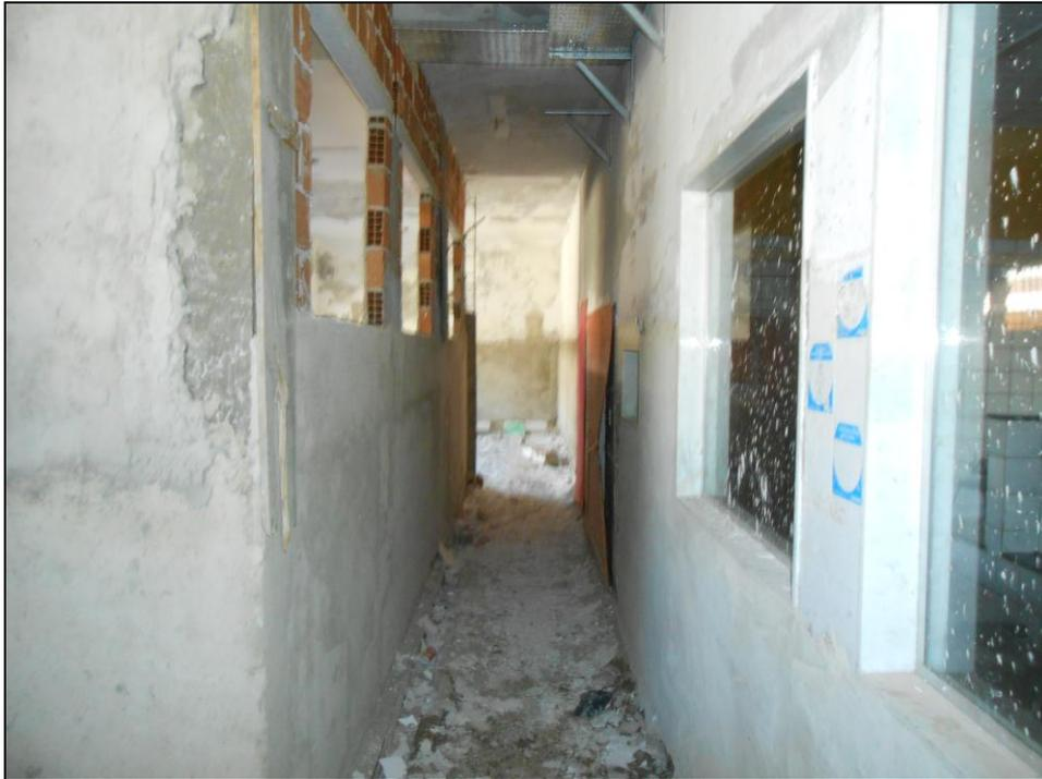
**Foto 01** - Continuidade do emboço (reboco) das paredes de alvenaria da área construída
