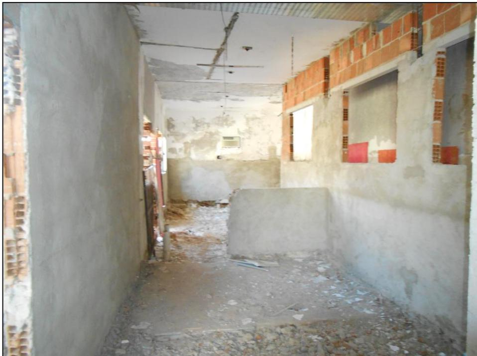
**Foto 02** - Continuidade do emboço (reboco) das paredes de alvenaria da área construída
