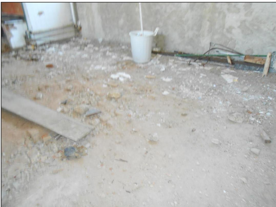
**Foto 07** - Aterro e compactação da área de expansão da cozinha e da lixeira climatizada
