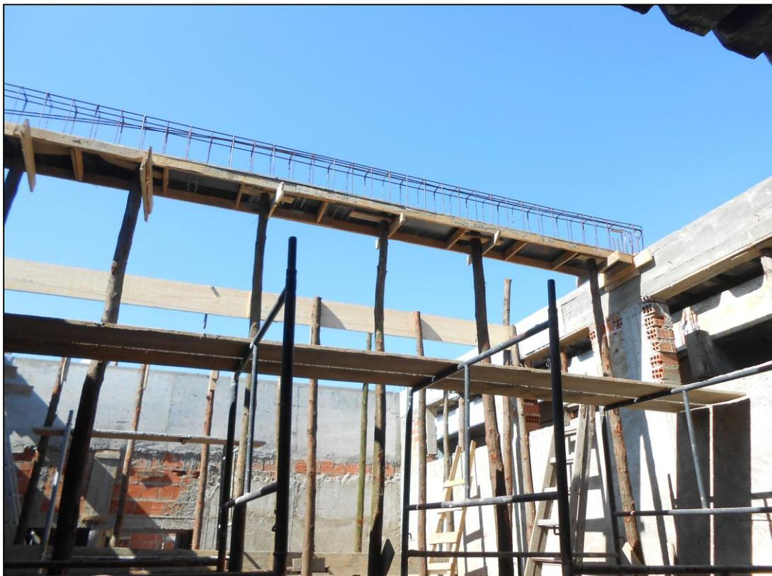
**Foto 10** - Finalização da viga de parte da área de expansão da cozinha do RU
