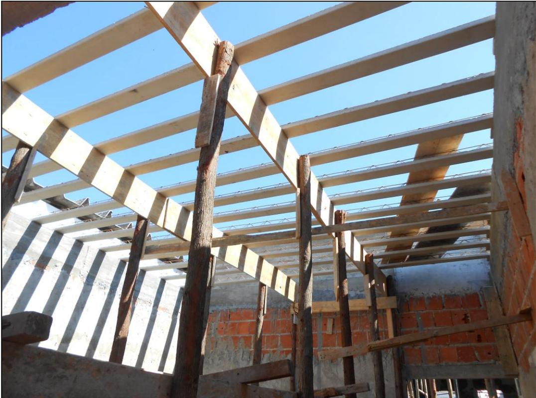
**Foto 08** - Início de instalação da laje do teto da área de expansão da cozinha do RU
