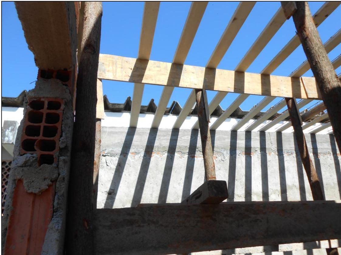
**Foto 09** - Início de instalação da laje do teto da área de expansão da cozinha do RU
