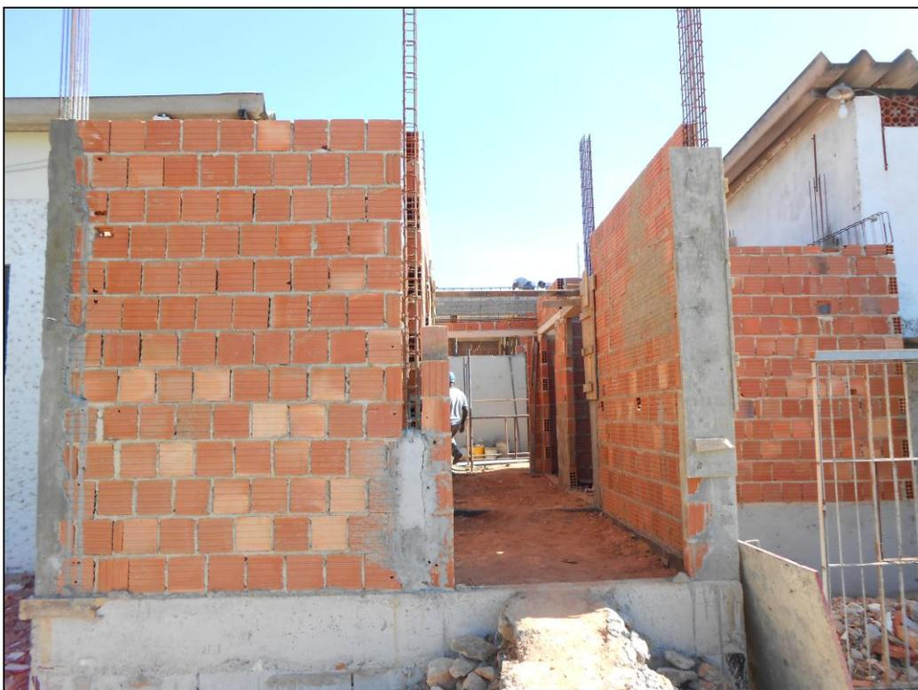
**Foto 03** - Finalização do levantamento das paredes de alvenaria da área da lixeira climatizada
