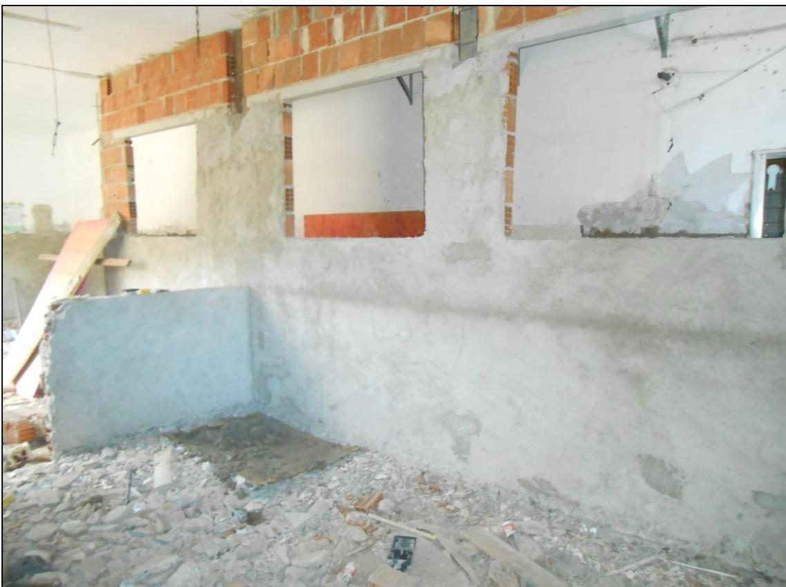
**Foto 02 - Continuidade do emboço das paredes (reboco) da área construída**
