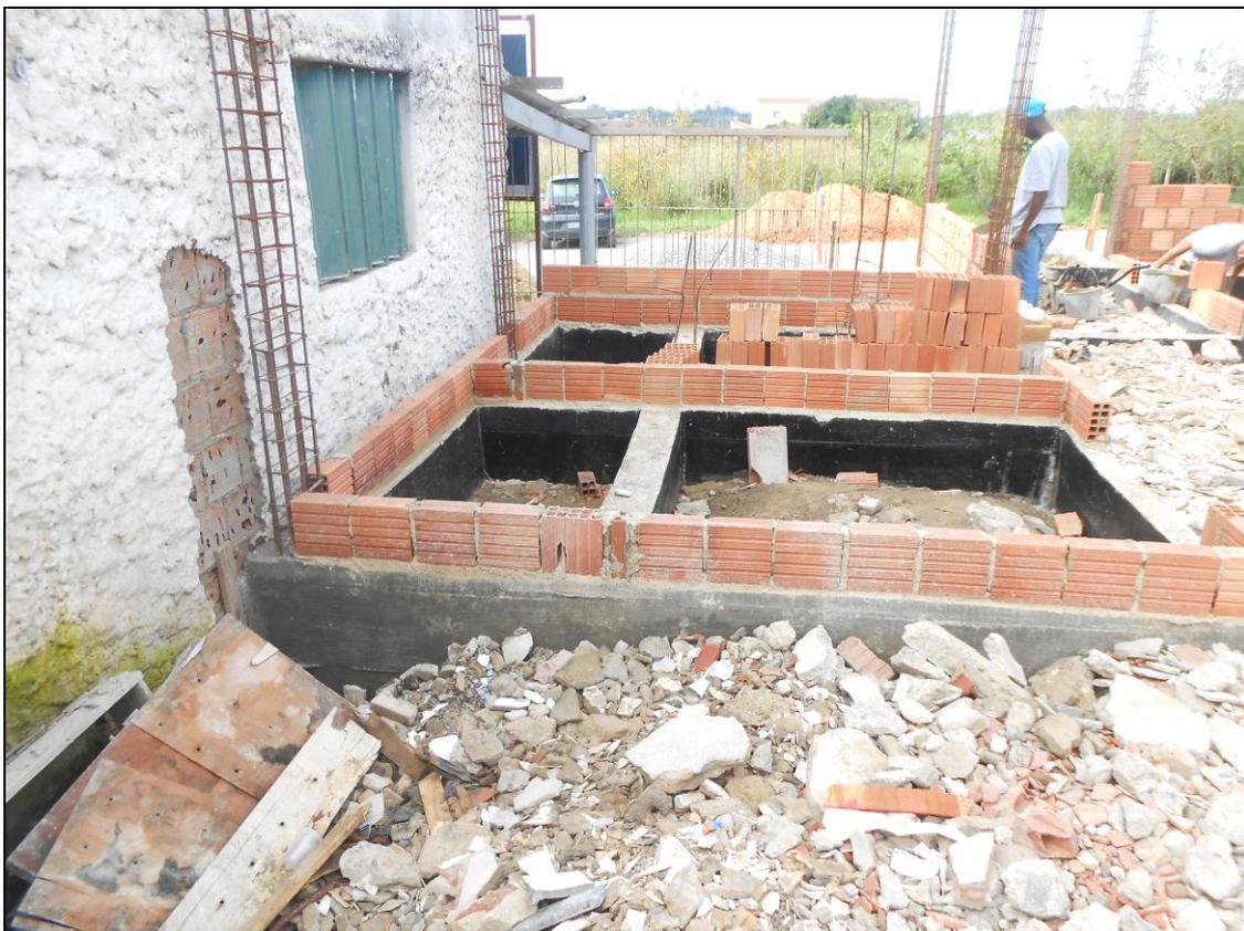
**Foto 04** – Início do levantamento das paredes da área da lixeira climatizada
