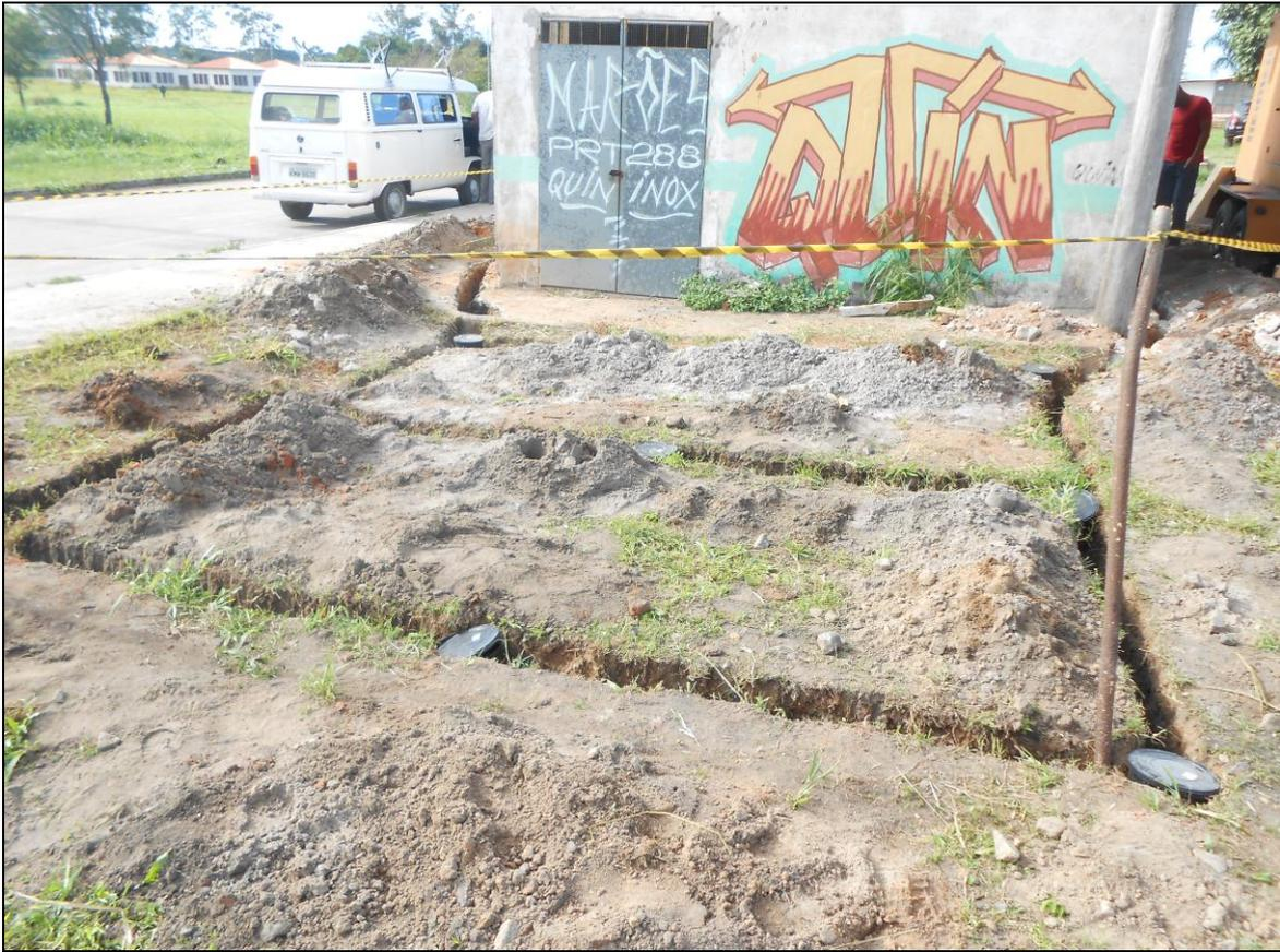
**Foto 13** - Construção da malha de aterramento (fio terra) da rede de baixa tensão, do transformador e do para-raios
