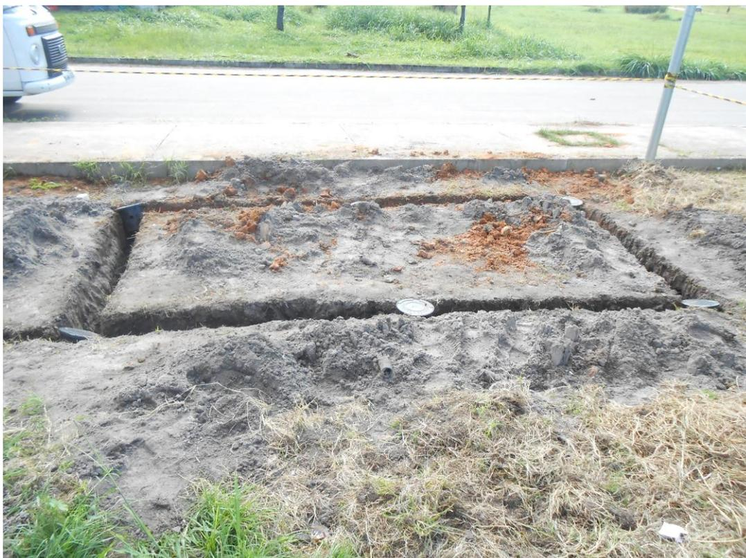
**Foto 11** - Construção da malha de aterramento (fio terra) da rede de baixa tensão, do transformador e do para-raios
