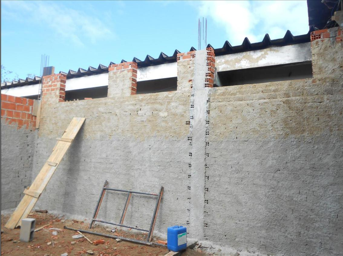
**Foto 01 - Continuidade do emboço das paredes (reboco) da área construída**
