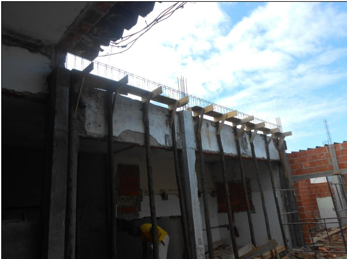
**Foto 08** - Confeção da armação dos pilares com vergalhões de aço
