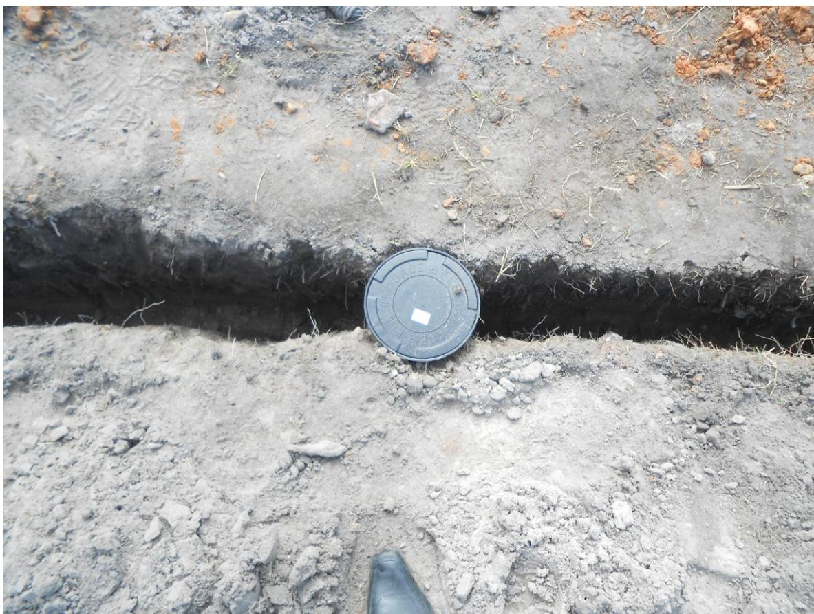
**Foto 12** - Construção da malha de aterramento (fio terra) da rede de baixa tensão, do transformador e do para-raios
