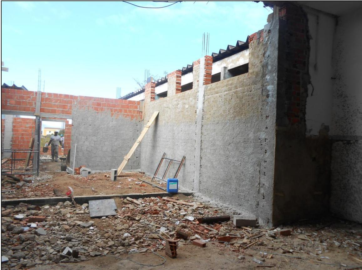
**Foto 07** – Início da remoção do entulho e nivelamento da área do futuro piso da cozinha
