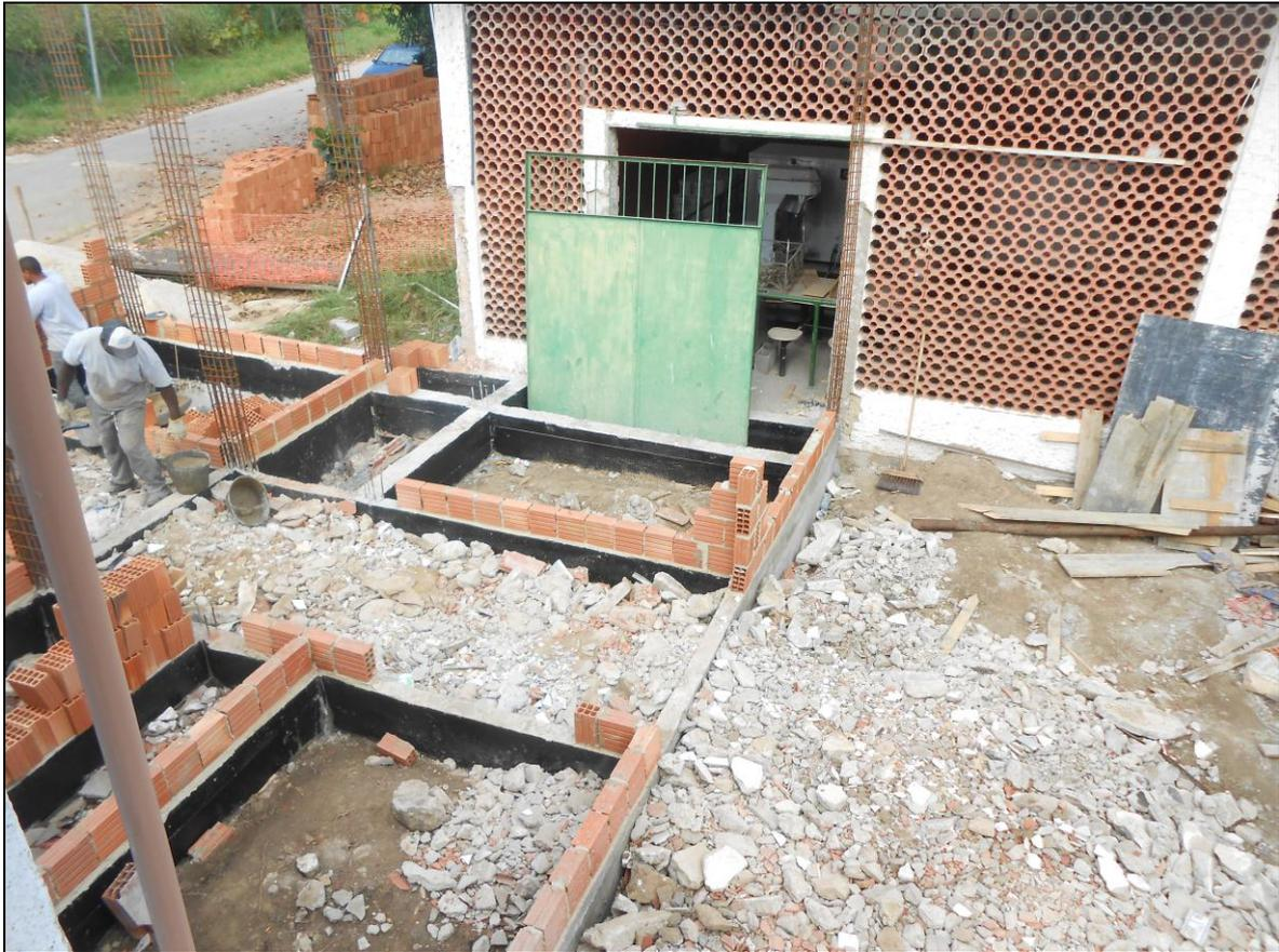
**Foto 03** – Início do levantamento das paredes da área da lixeira climatizada
