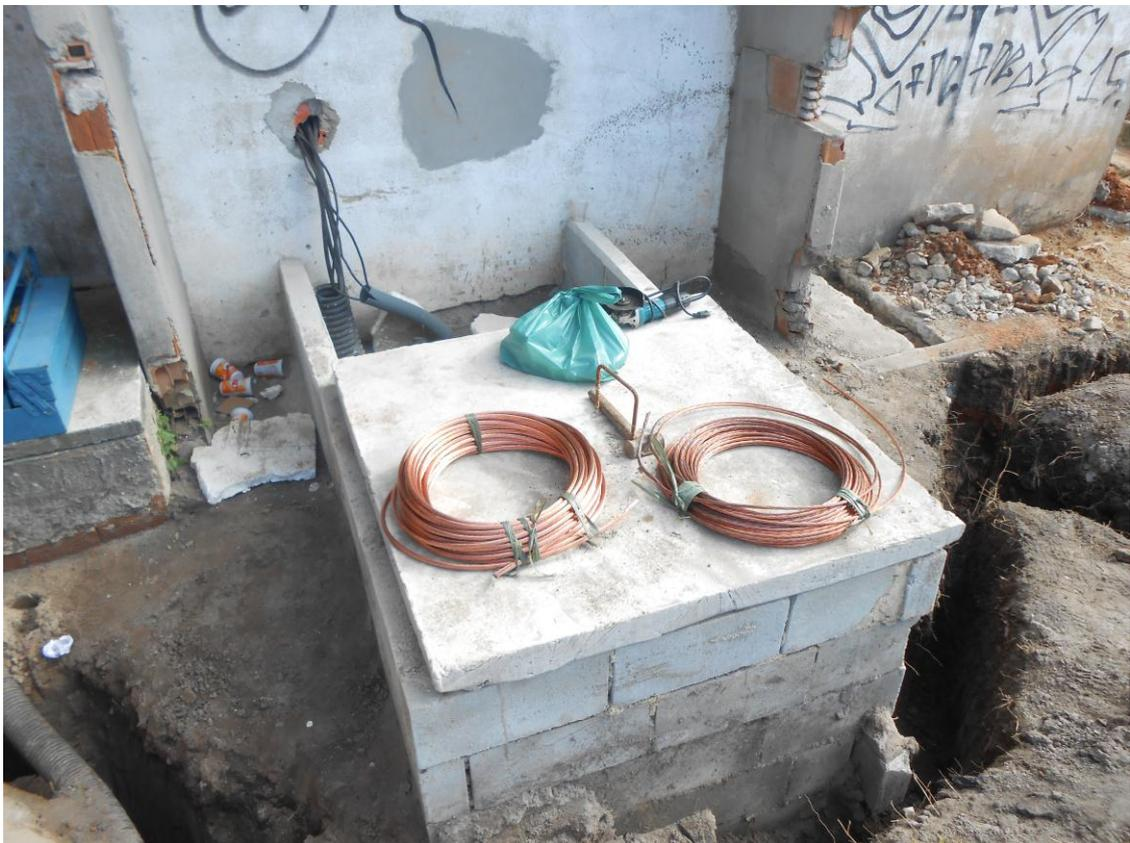
**Foto 10** - Construção da malha de aterramento (fio terra) da rede de baixa tensão, do transformador e do para-raios
