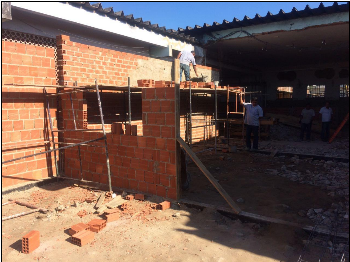
Foto 03 - Continuidade do levantamento das paredes de alvenaria da cozinha.
