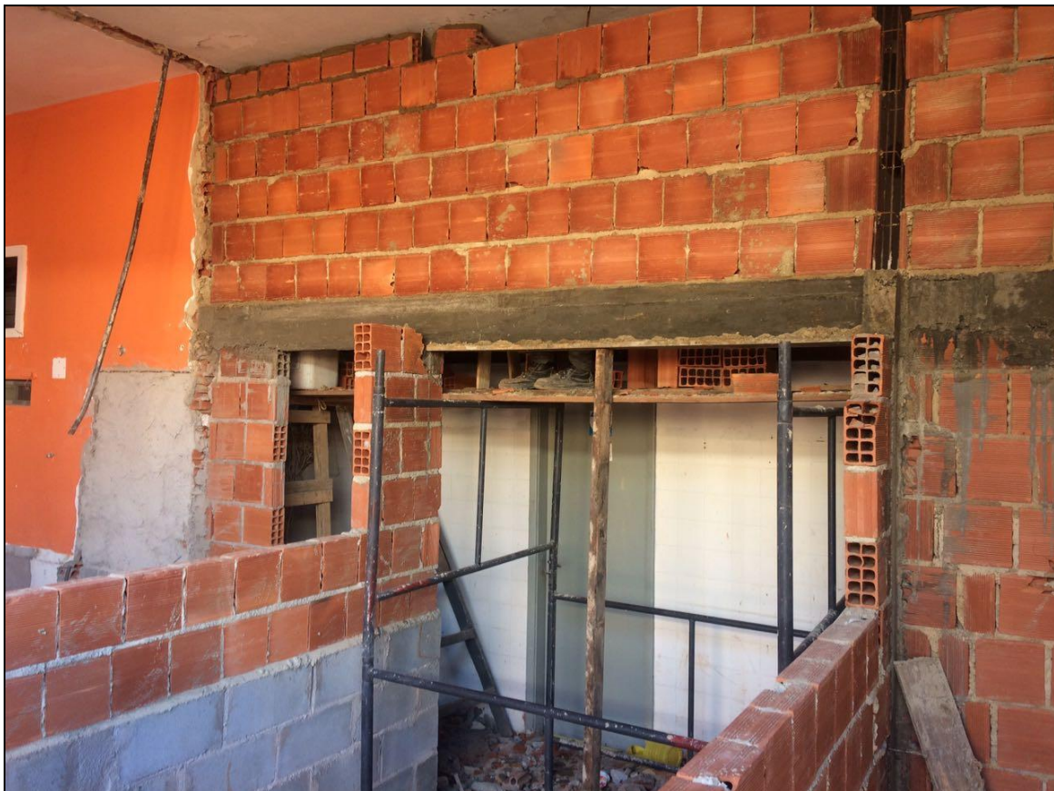
Foto 04 - Continuidade do levantamento das paredes de alvenaria da área de pré-preparo
