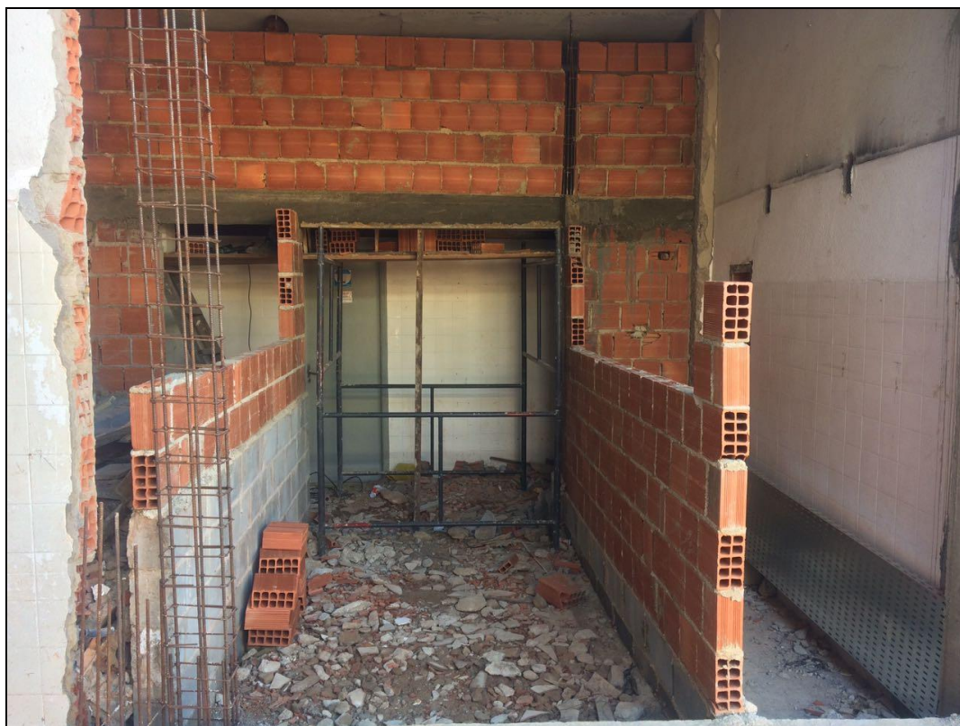
Foto 01 – Início da construção da rampa de acesso à cozinha
