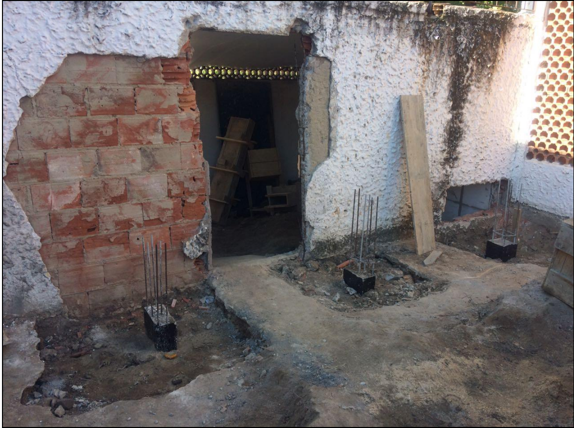
Foto 05 - Conclusão da construção das fundações da área de lixo
