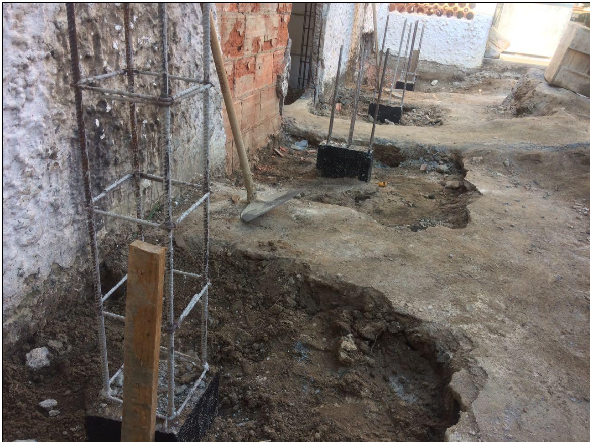
Foto 06 - Conclusão da construção das fundações da área de lixo
