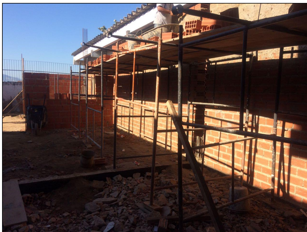
Foto 02 - Continuidade do levantamento das paredes de alvenaria da cozinha.
