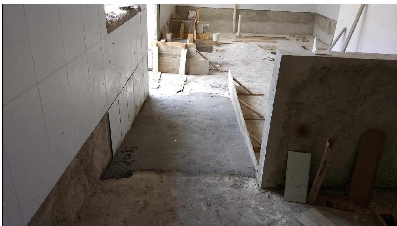
Foto 16 - Construção da rampa da área de pré-preparo de legumes
