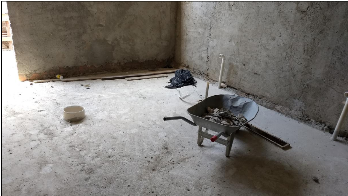
Foto 08 - Realização de concretagem da laje do piso da área reformada e da área nova
