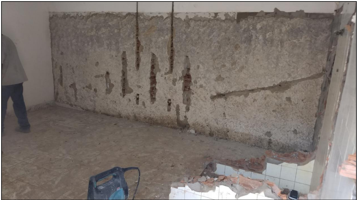
Foto 13 - Demolição da área dos banheiros externos dos funcionários
