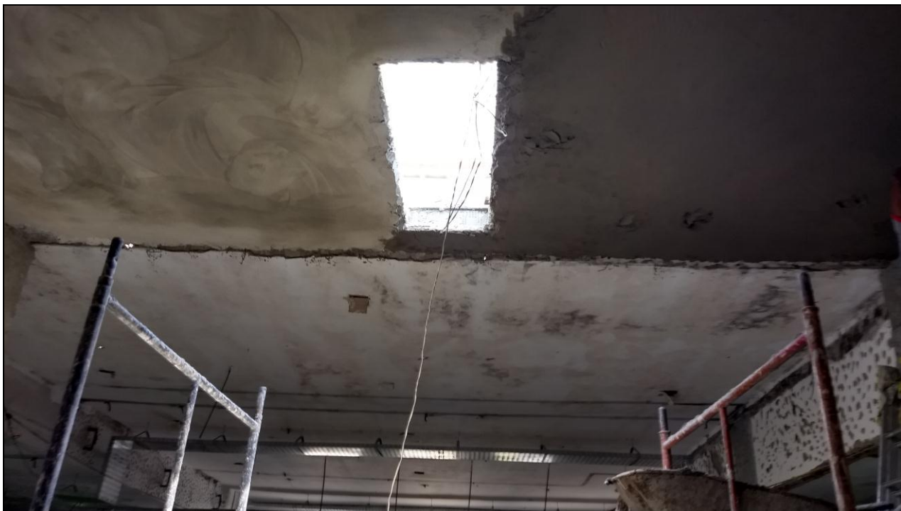
Foto 17 - Construção de saídas para a implantação do sistema de exaustão mecanizado
