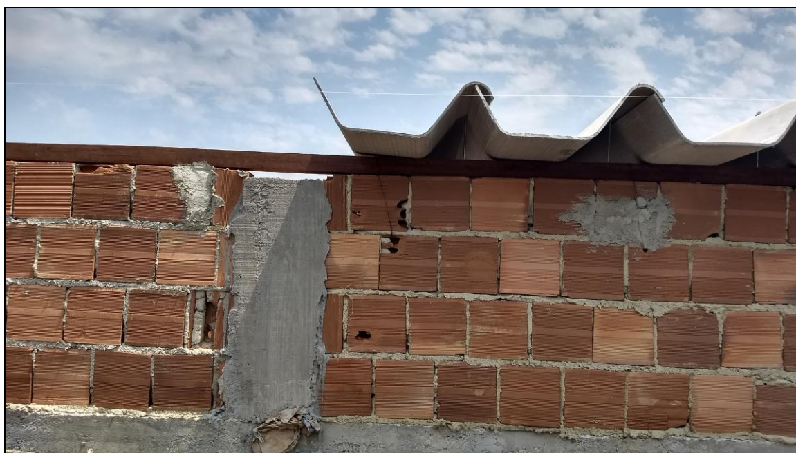
Foto 20 - Início da instalação do telhado da área nova
