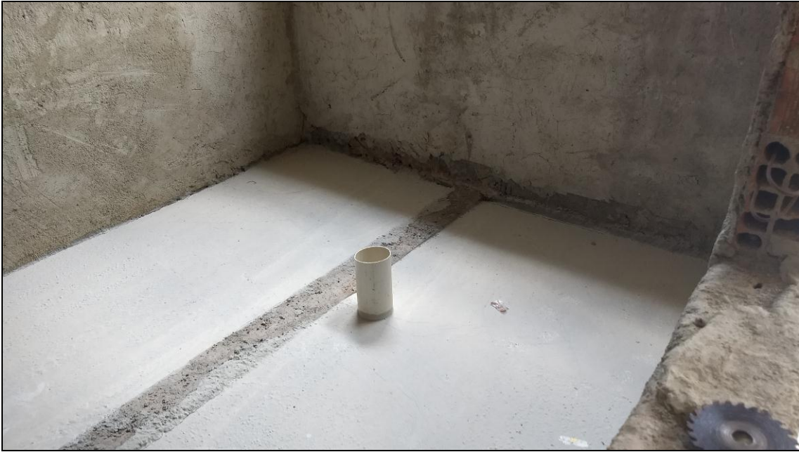
Foto 05 - Finalização da instalação das tubulações da rede de esgoto interna
