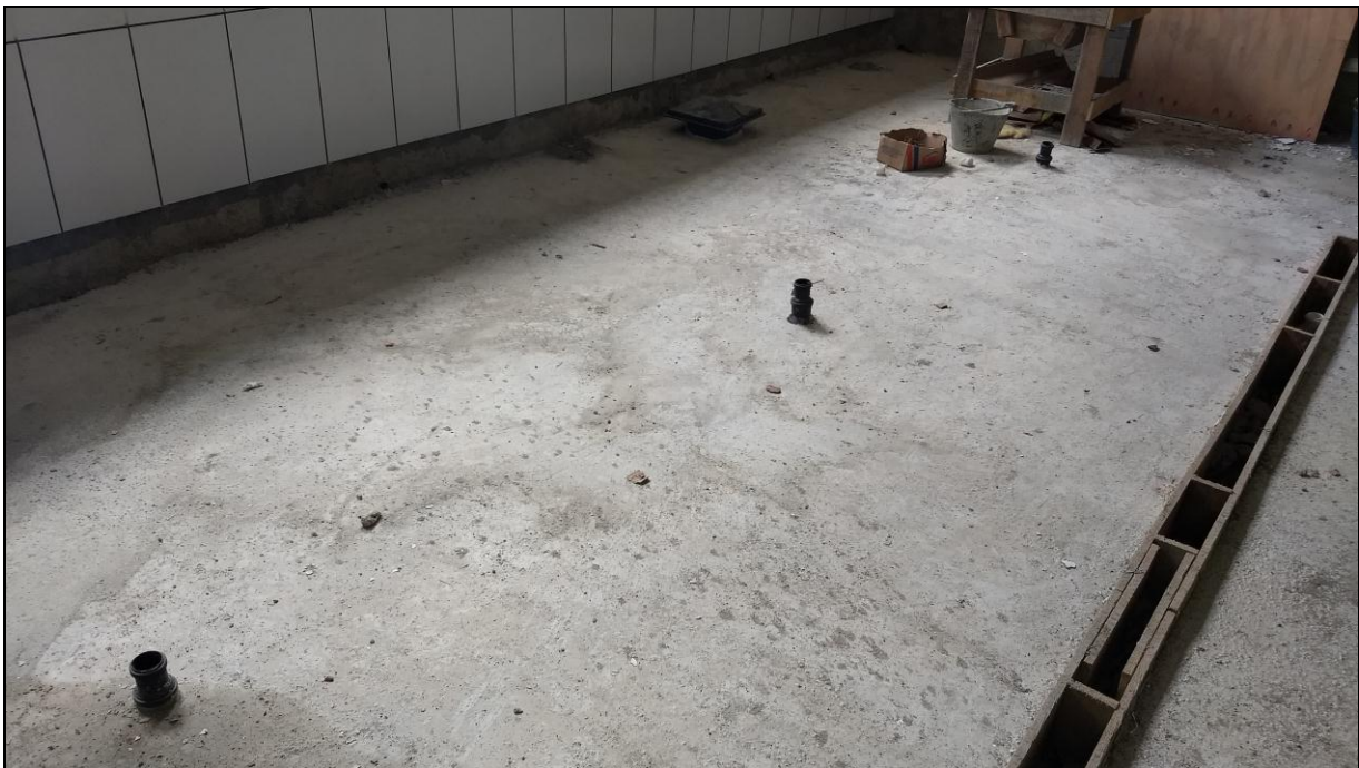
Foto 04 - Finalização da instalação das tubulações da rede de esgoto interna
