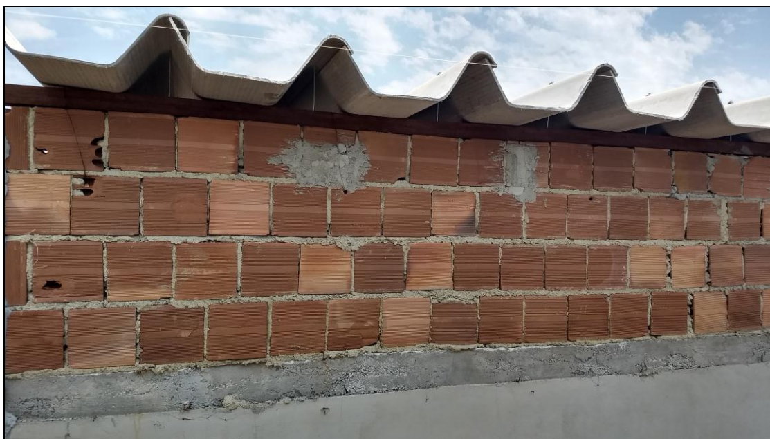
Foto 19 - Início da instalação do telhado da área nova
