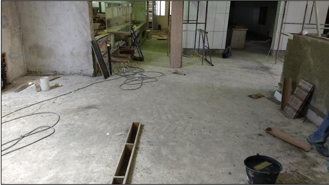
Foto 07 - Realização de concretagem da laje do piso da área reformada e da área nova
