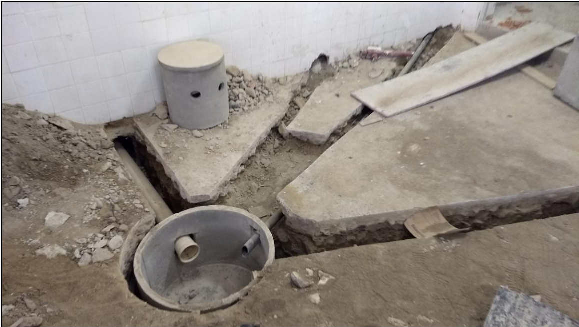
Foto 06 - Finalização da instalação das tubulações da rede de esgoto interna
