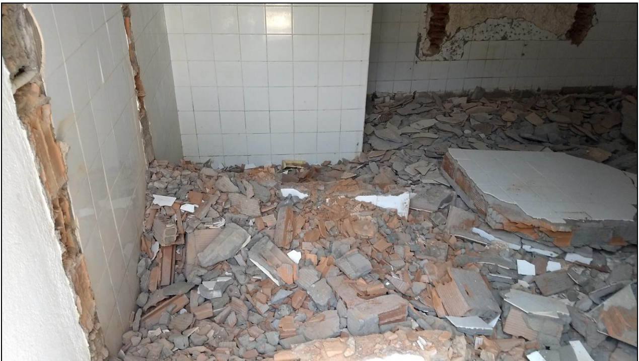
Foto 12 - Demolição da área dos banheiros externos dos funcionários
