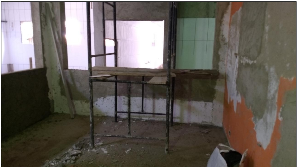
Foto 14 - Realização de concretagem da sala das profissionais da equipe técnica da área de alimentação do RU (“aquário”)
