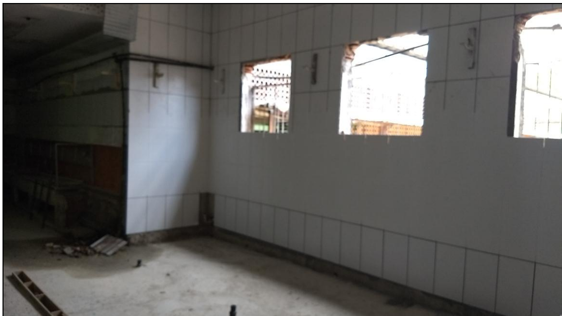
Foto 02 - Início do revestimento de cerâmica das paredes da área reformada
