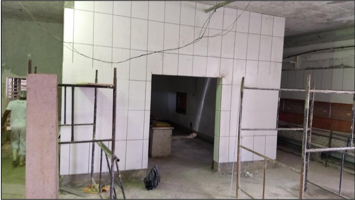
Foto 03 - Início do revestimento de cerâmica das paredes da área reformada
