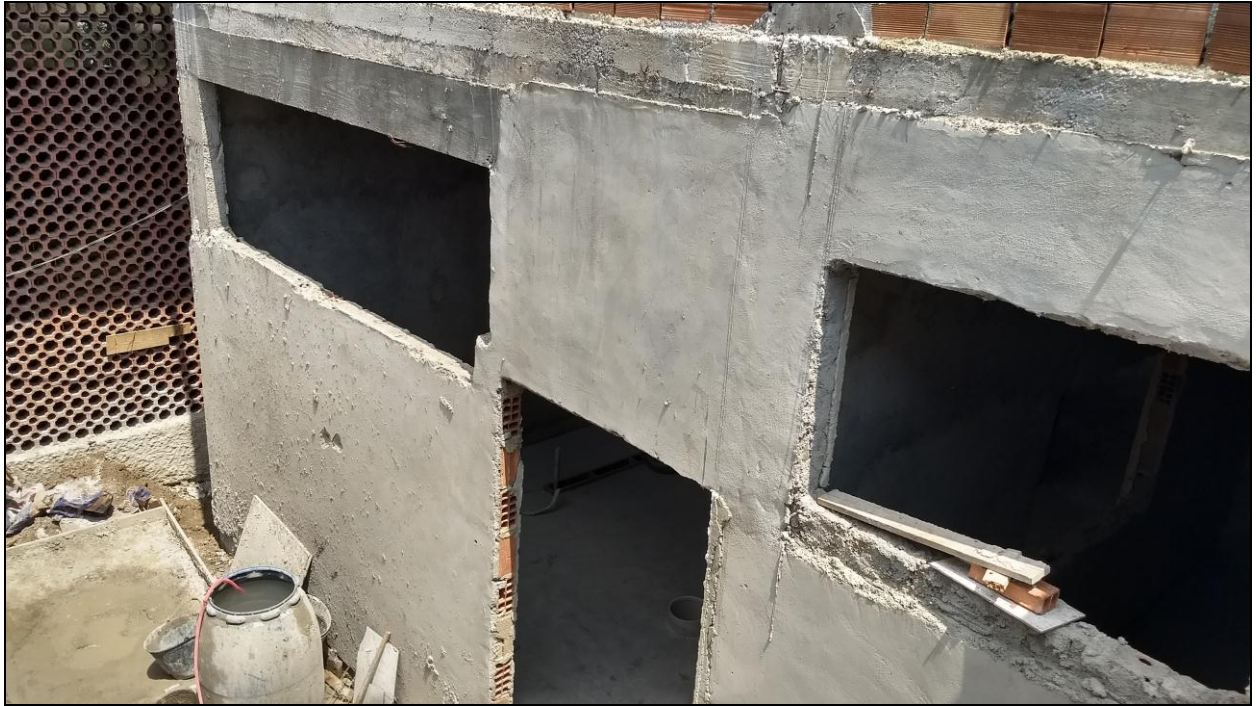
Foto 09 - Continuidade do emboço das paredes e do teto da área reformada e da área nova
