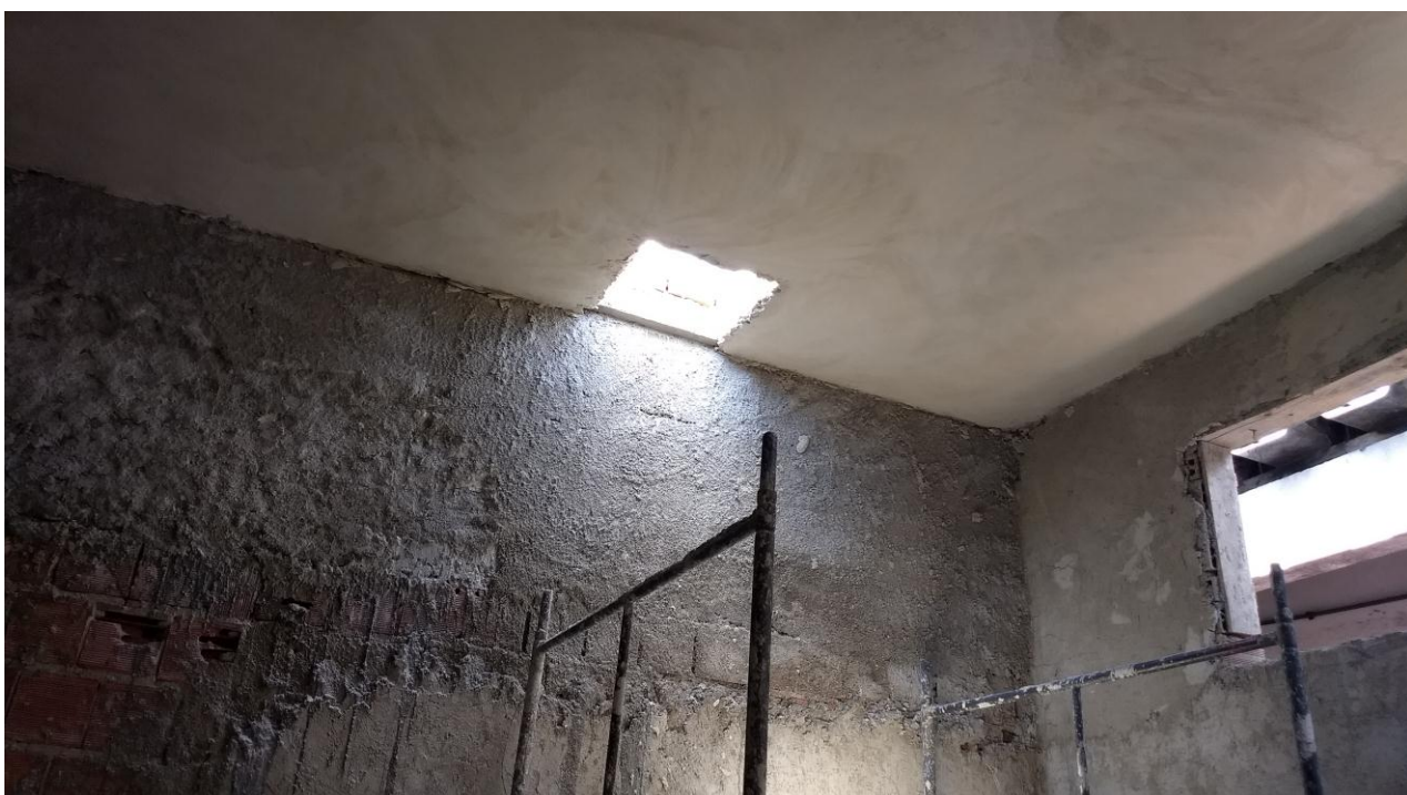
Foto 18 - Construção de saídas para a implantação do sistema de exaustão mecanizado
