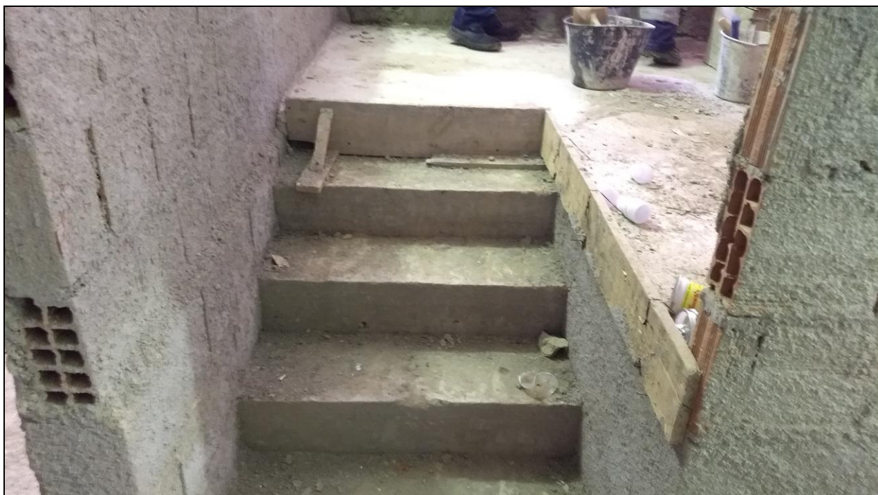
Foto 15 - Realização de concretagem da sala das profissionais da equipe técnica da área de alimentação do RU (“aquário”)
