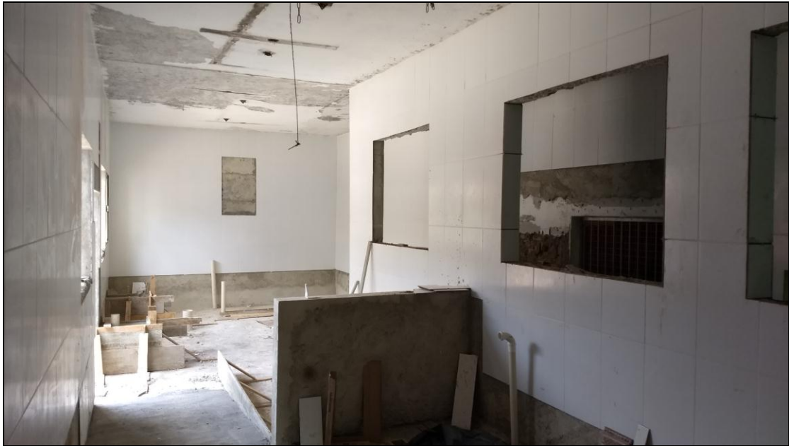
Foto 01 - Início do revestimento de cerâmica das paredes da área reformada
