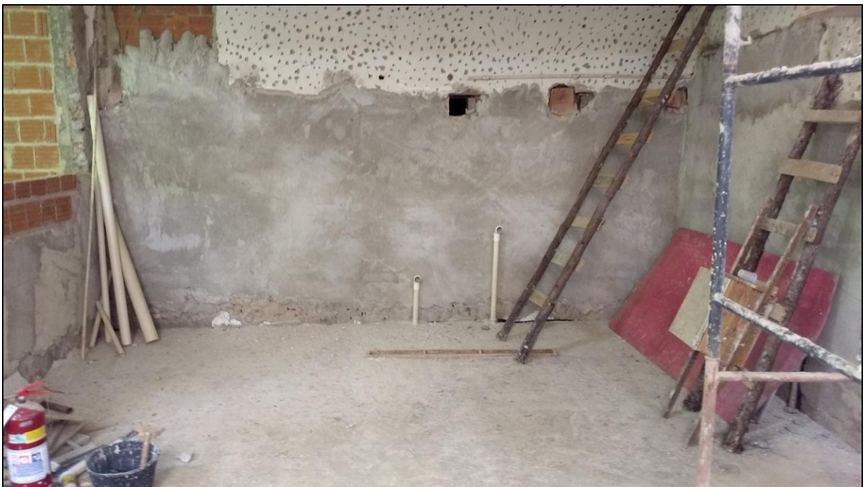
Foto 10 - Continuidade do emboço das paredes e do teto da área reformada e da área nova
