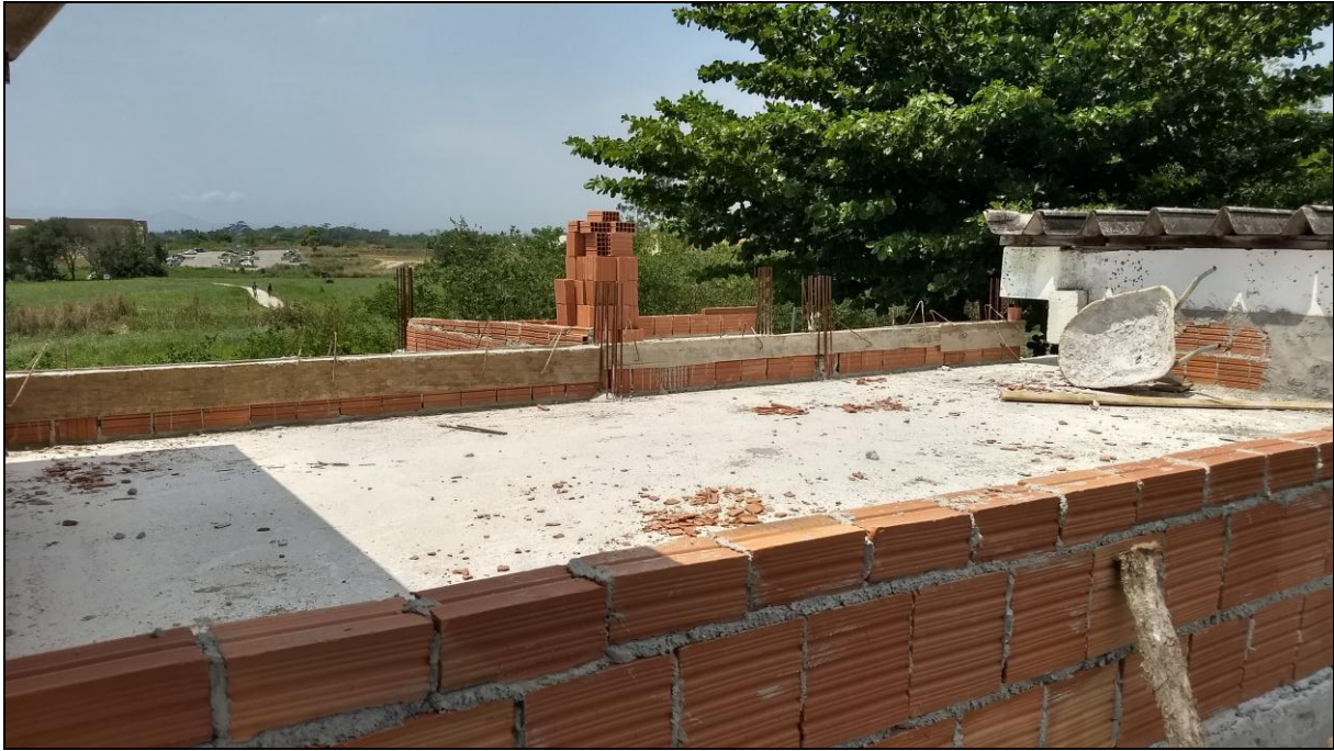
Foto 11 - Implantação de laje do teto da área da lixeira climatizada
