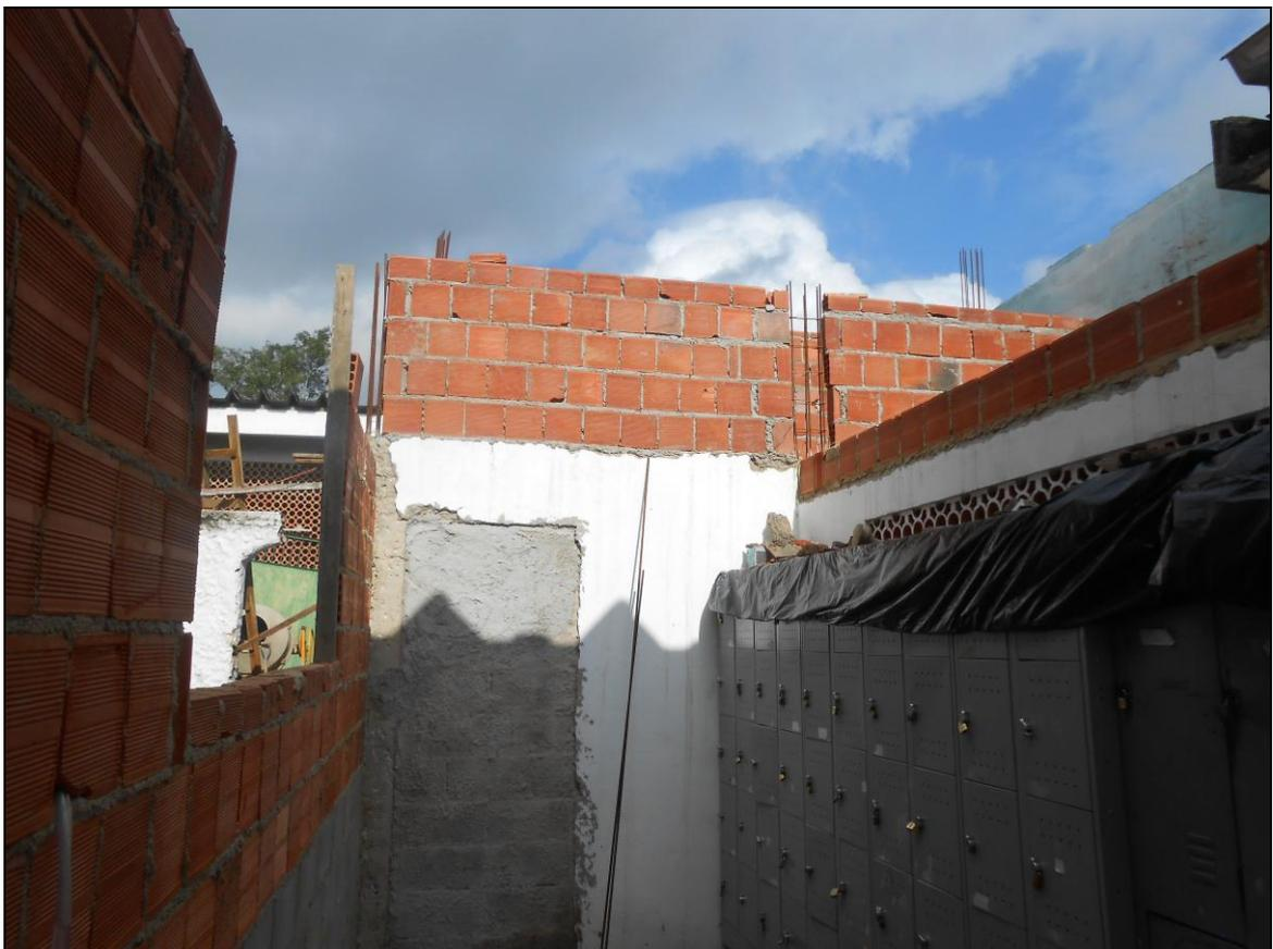
**Foto 10** – Finalização das paredes e cintamento da laje para a área de recepção do RU
