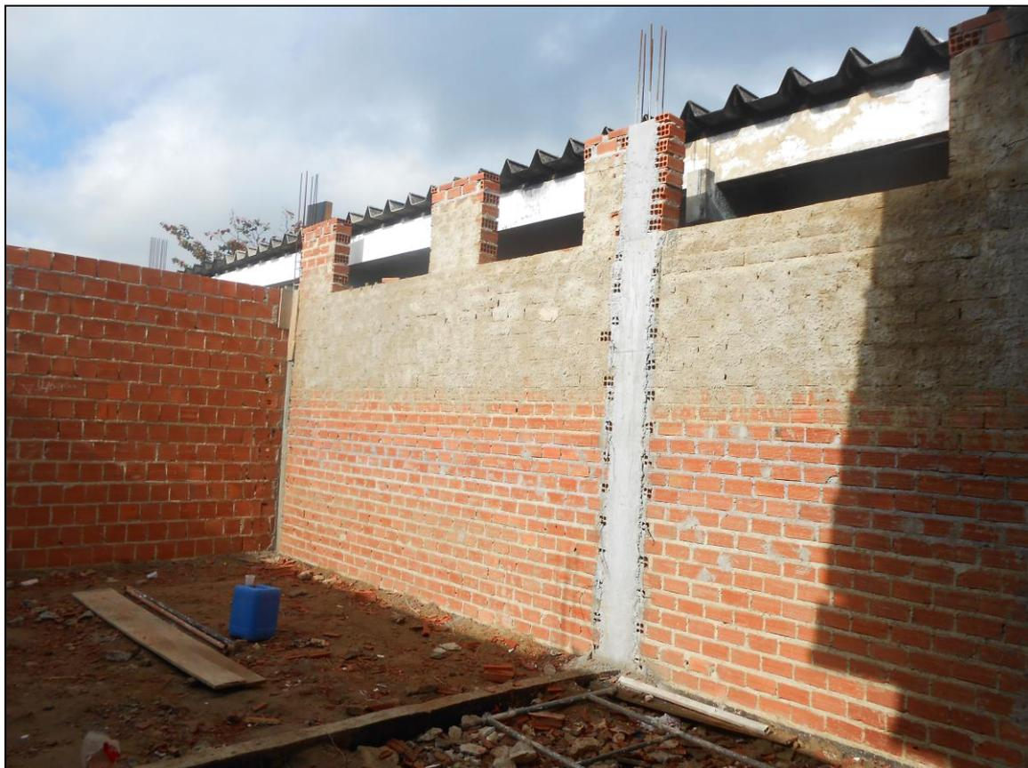
**Foto 05** – Conclusão das paredes para o cintamento da lage (teto), com levantamento das colunas de concreto estrutural
