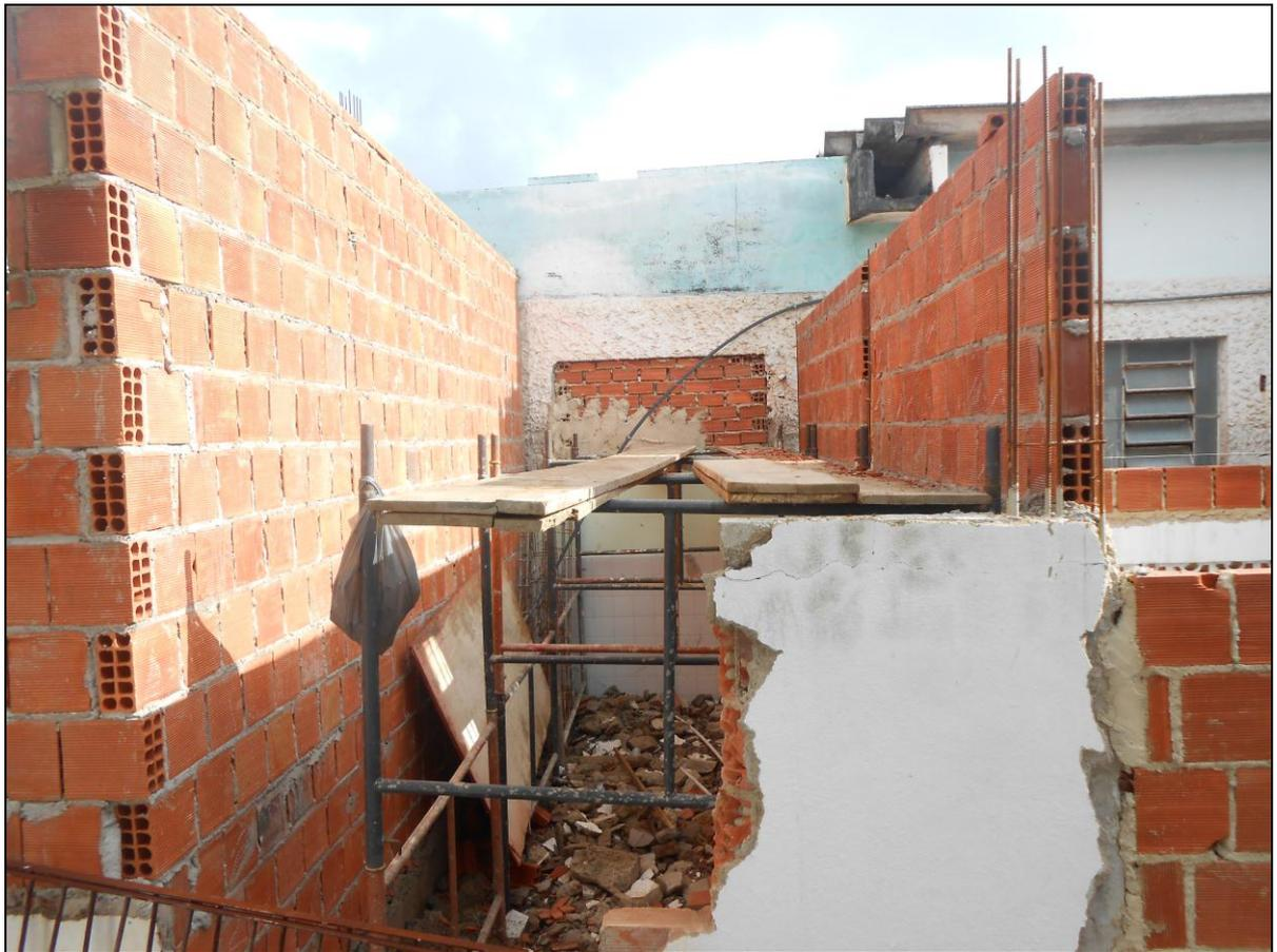
**Foto 09** – Finalização das paredes e cintamento da laje para a área de recepção do RU
