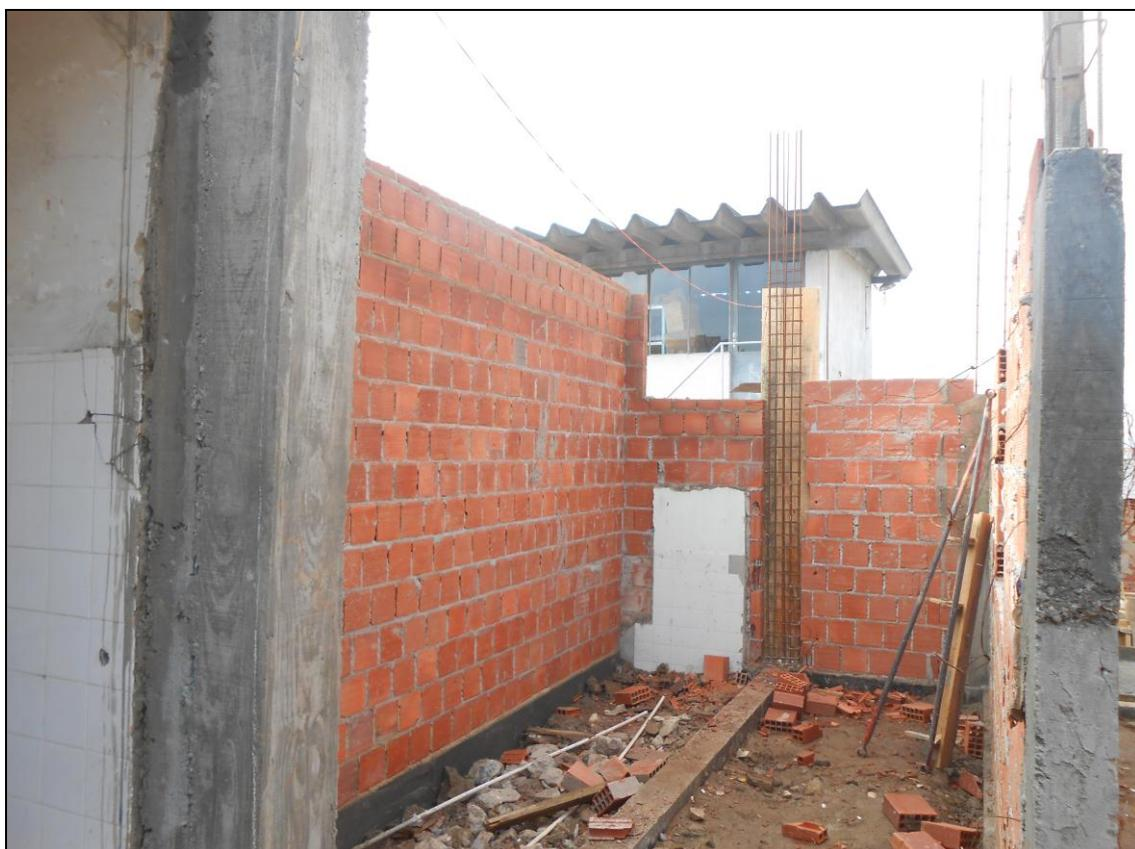
**Foto 06** – Conclusão das paredes para o cintamento da lage (teto), com levantamento das colunas de concreto estrutural
