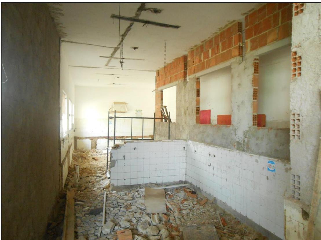
**Foto 06 – Levantamento das paredes de alvenaria da área de pré-preparo**
