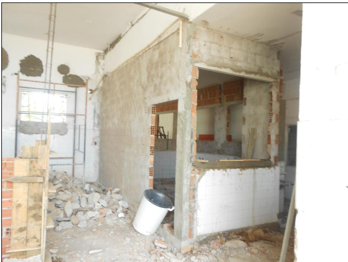
**Foto 05 – Levantamento das paredes de alvenaria da área de pré-preparo**
