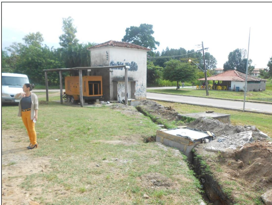
**Foto 01 – Instalação dos conduítes da rede elétrica subterrânea:**
