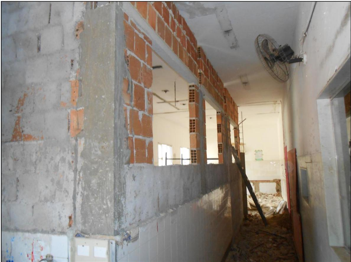
**Foto 07 – Levantamento das paredes de alvenaria da área de pré-preparo**
