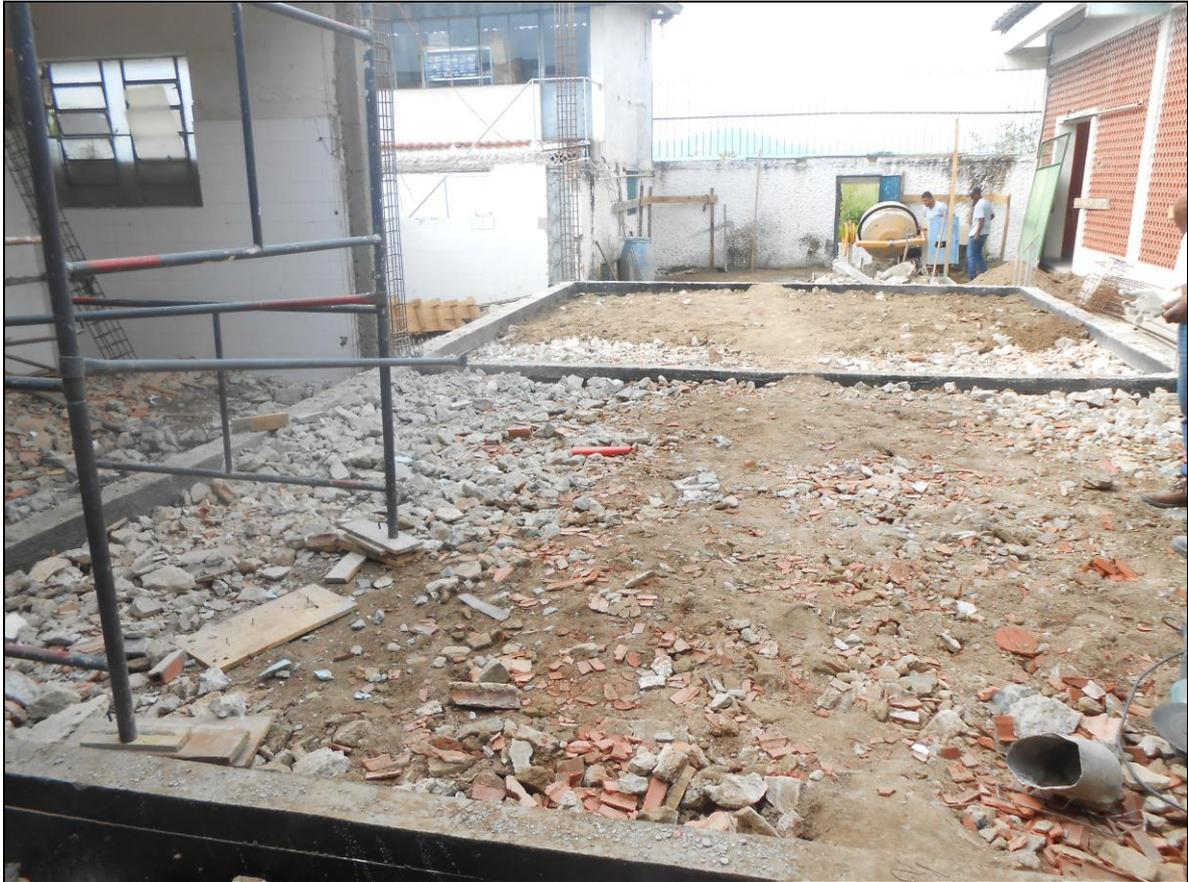
**Foto 09 - Aterramento do alicerce da área de expansão da cozinha com resíduos da demolição**
