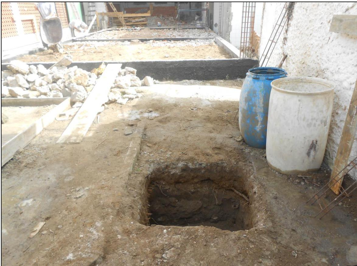
**Foto 10 - Início da construção das fundações da área para o depósito do lixo**
