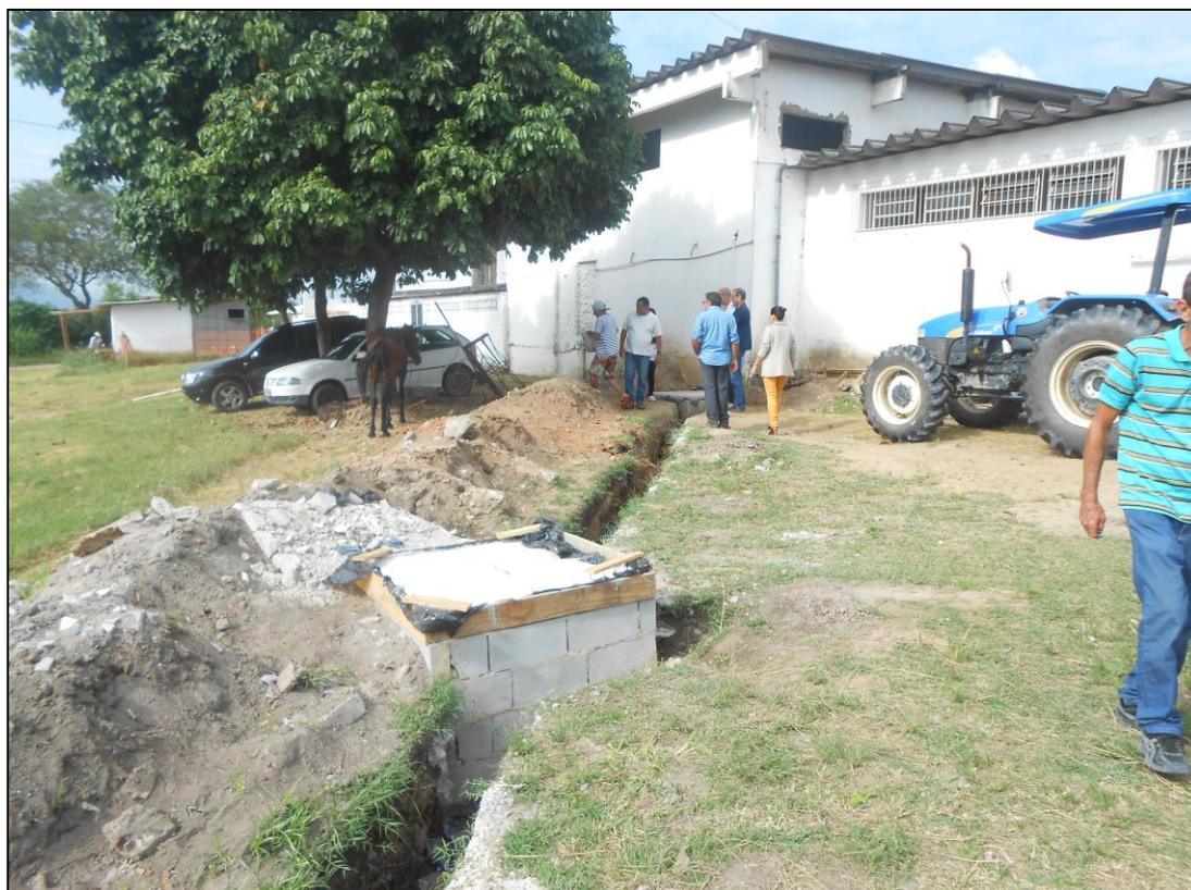
**Foto 02 – Instalação dos conduítes da rede elétrica subterrânea:**
