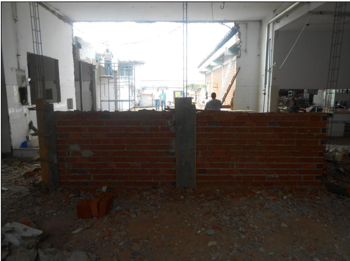
**Foto 08 – Levantamento de parede de alvenaria da área de cocção**
