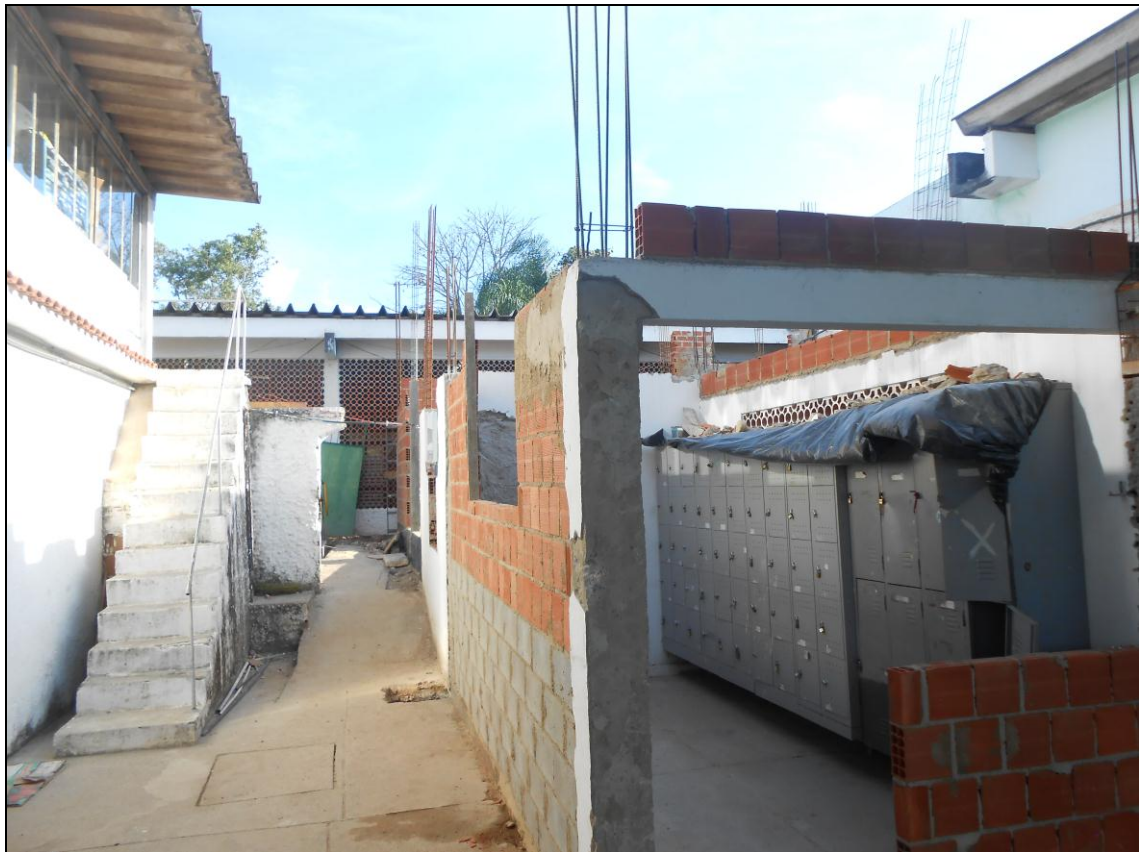
Foto 10 - Levantamento do pé direito da parede de alvenaria da área de recepção
