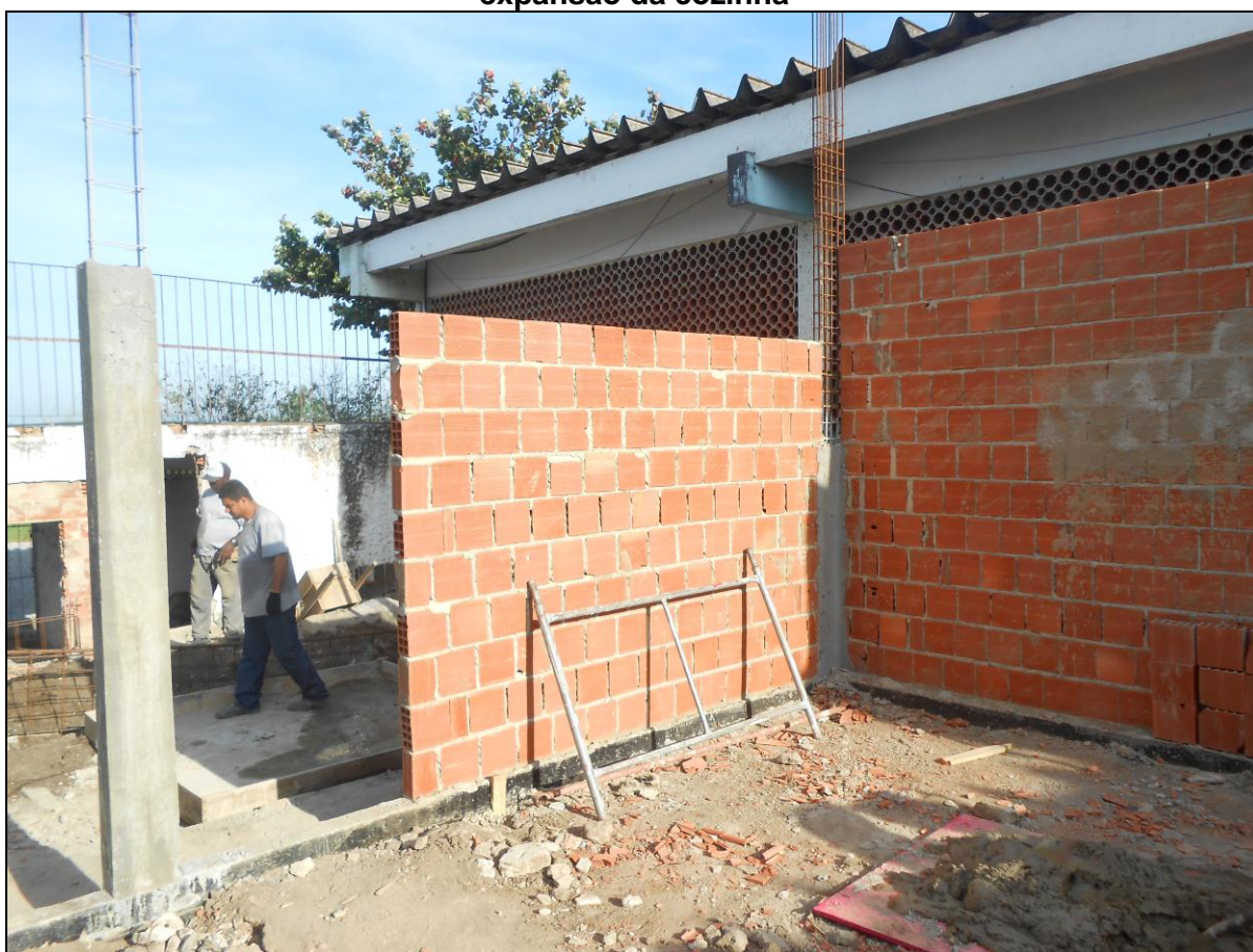
Foto 04 - Continuidade do levantamento do pé direito das paredes de alvenaria da área de expansão da cozinha
