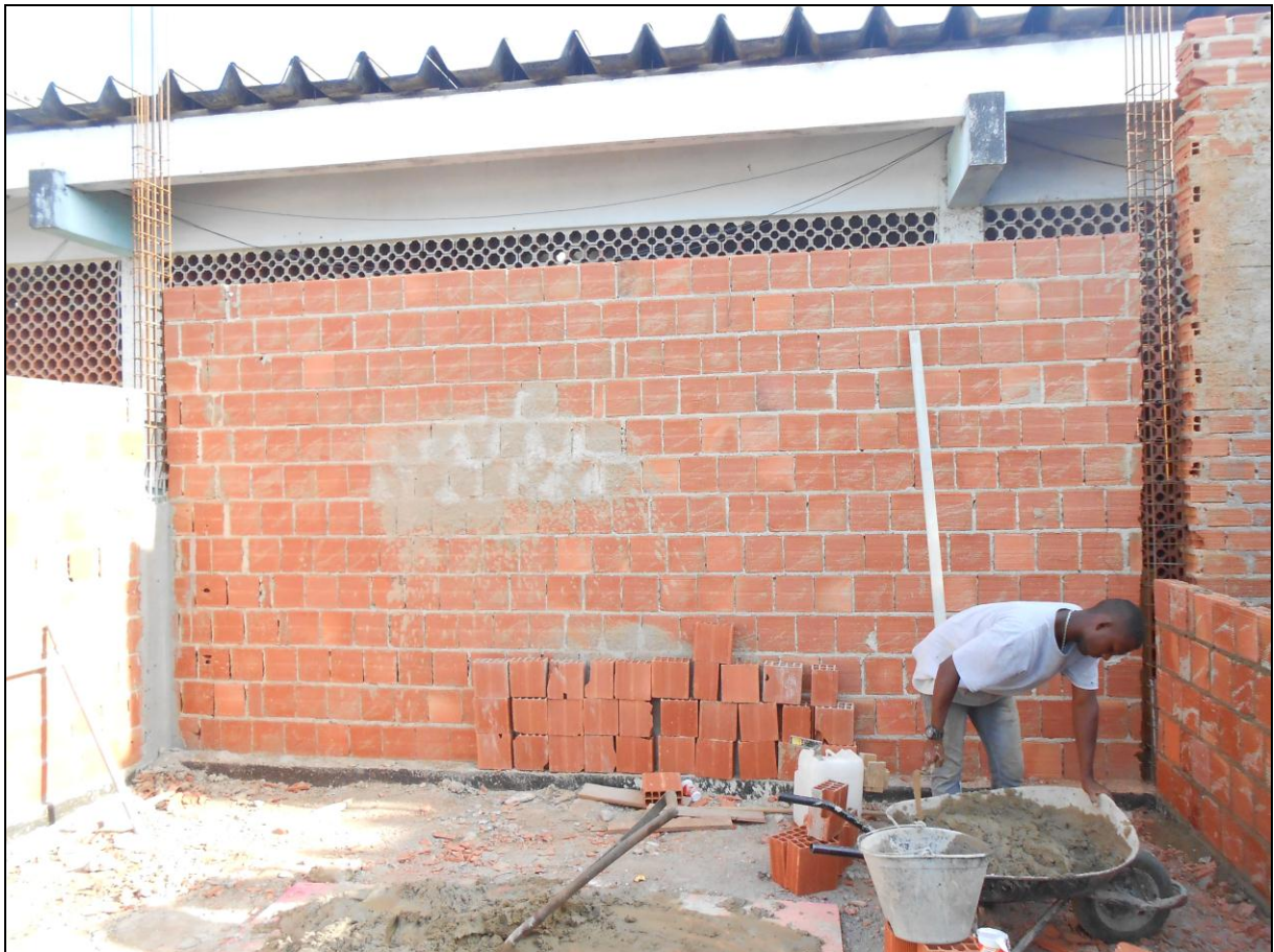
Foto 05 - Enchimento com entulho de obra na base para a confecção da área de depósito de material de limpeza
