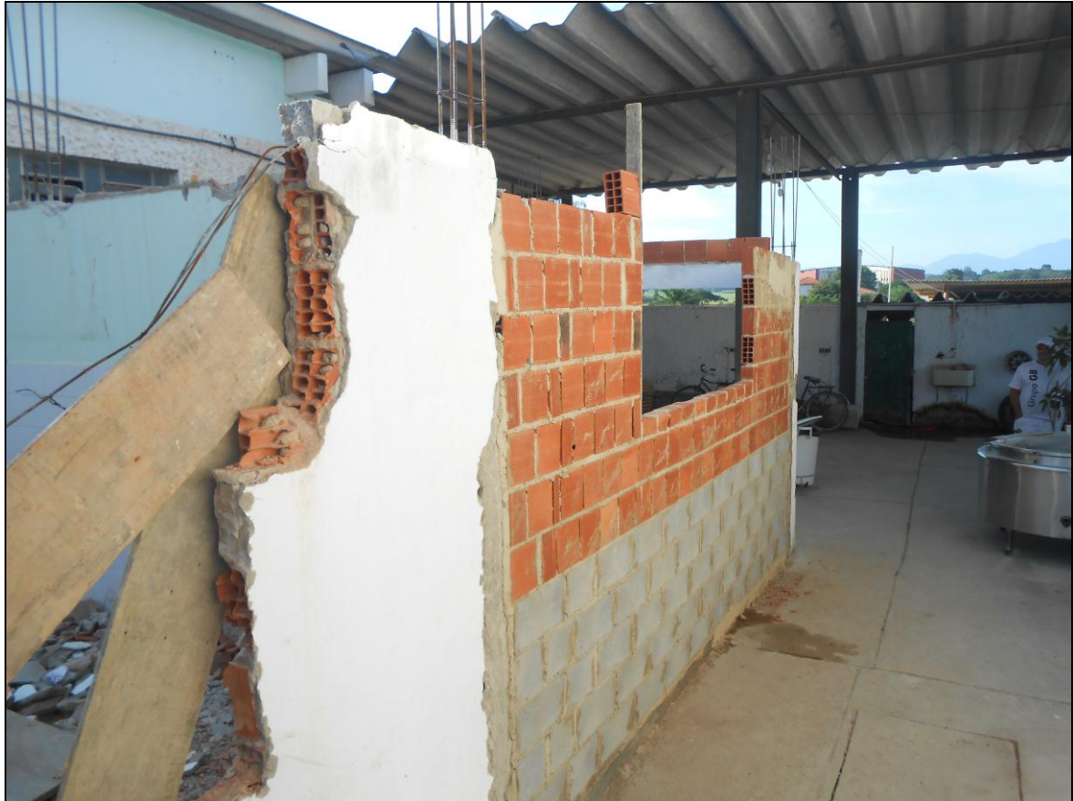
Foto 09 - Levantamento do pé direito da parede de alvenaria da área de recepção
