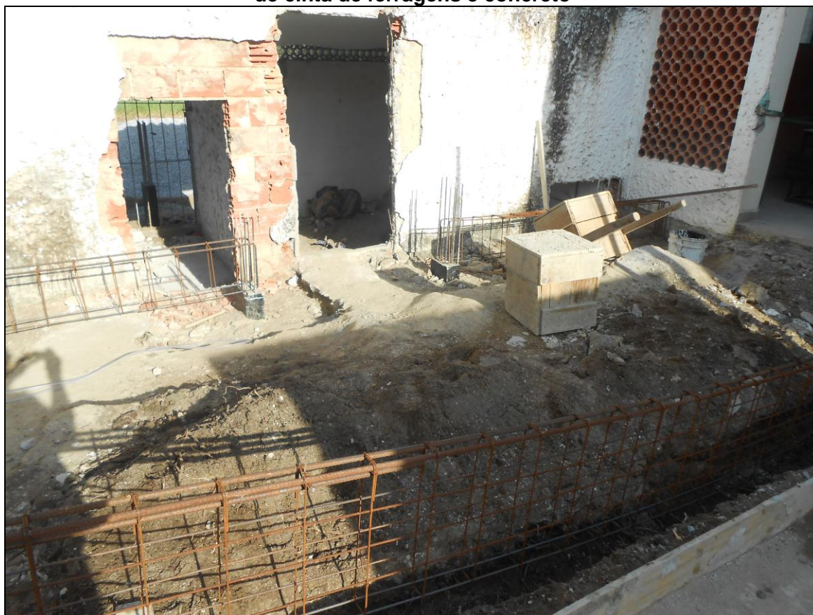
Foto 08 - Continuidade da construção das fundações da área de lixo, com confecção e colocação de cinta de ferragens e concreto
