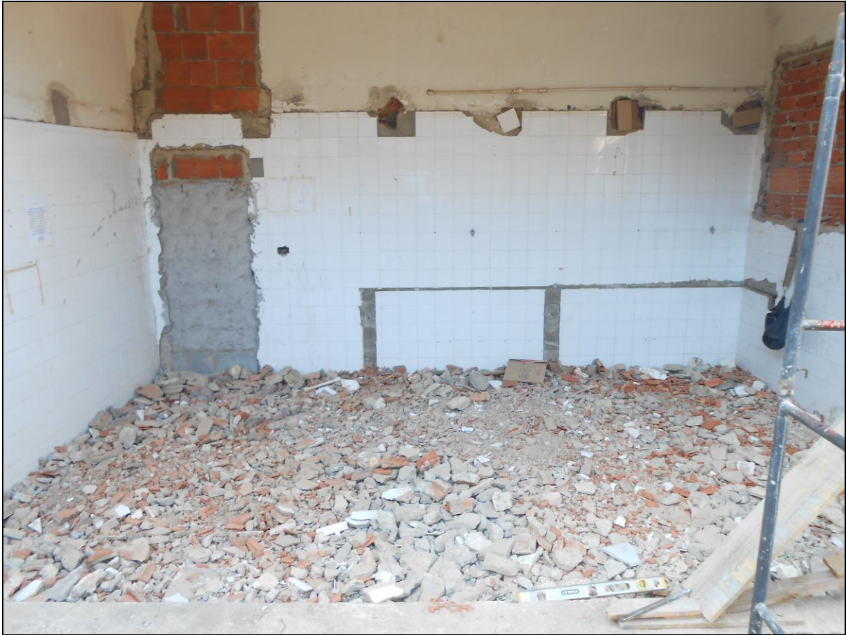
Foto 05 - Enchimento com entulho de obra na base para a confecção da área de depósito de material de limpeza
