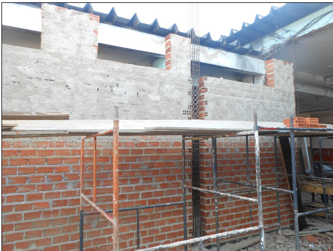
Foto 03 - Continuidade do levantamento do pé direito das paredes de alvenaria da área de expansão da cozinha
