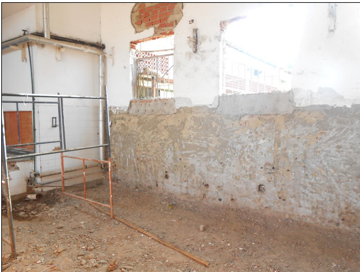
Foto 02 - Continuidade da remoção dos azulejos antigos da cozinha
