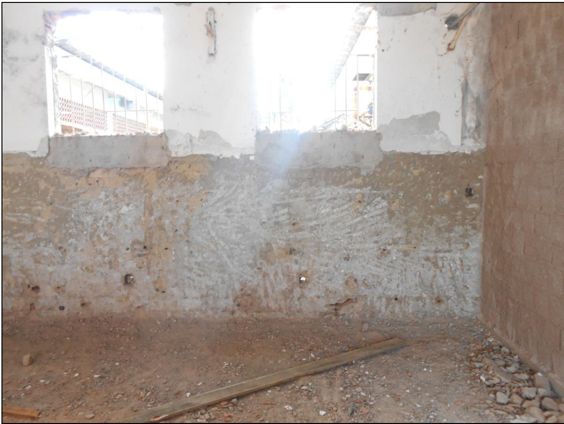
Foto 01 – Continuidade da remoção dos azulejos antigos da cozinha
