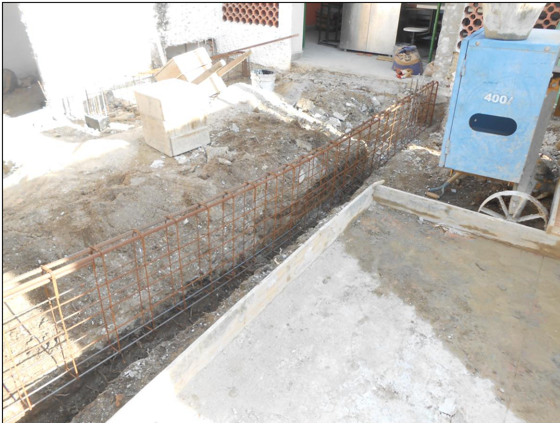
Foto 07 - Continuidade da construção das fundações da área de lixo, com confecção e colocação de cinta de ferragens e concreto
