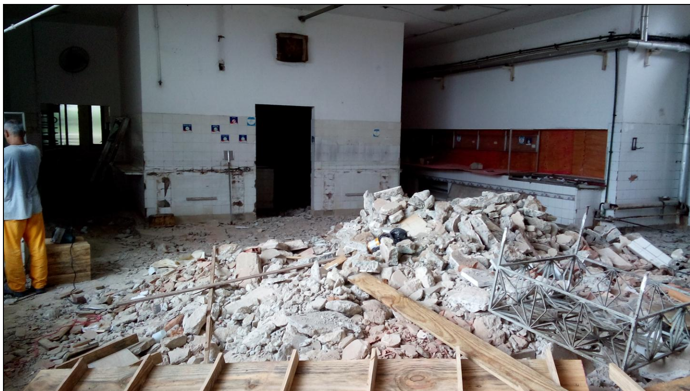
Foto 05: Antiga cozinha do RU após demolição e retirada dos equipamentos
