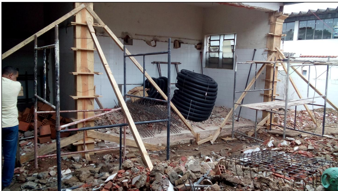
Foto 09: Reforço estrutural da antiga cozinha do RU
