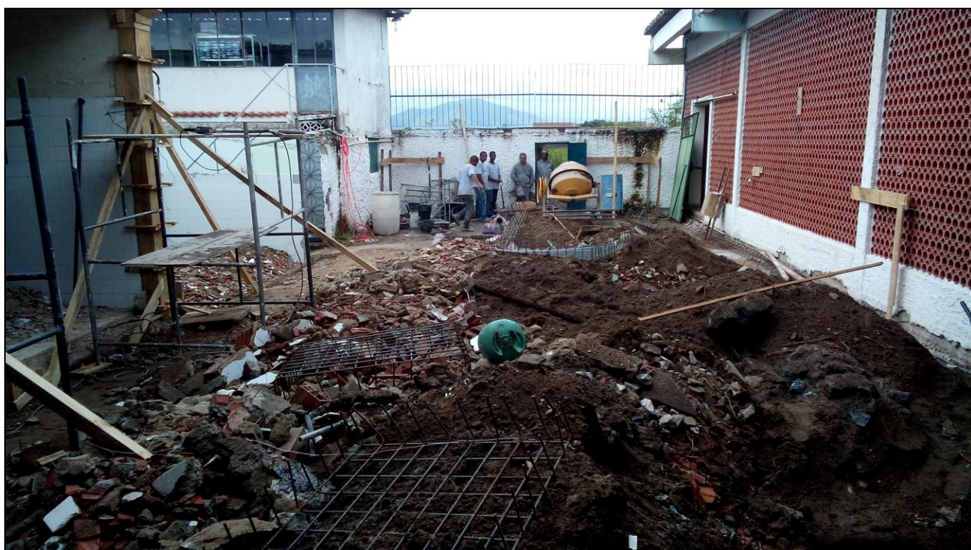
Foto 08: Reforço estrutural da antiga cozinha do RU
