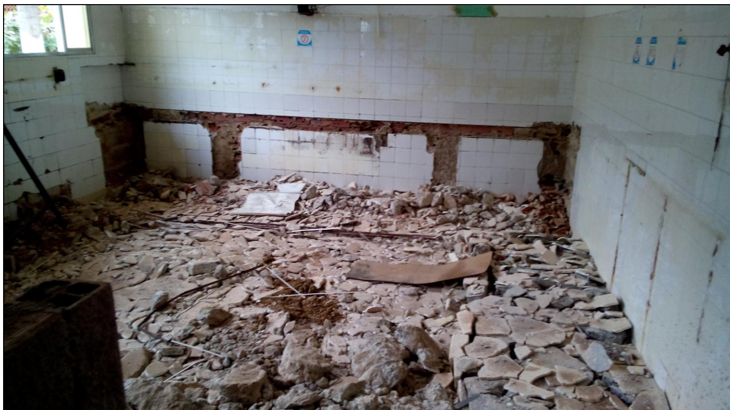
Foto 07: Antiga cozinha do RU após demolição e retirada dos equipamentos
