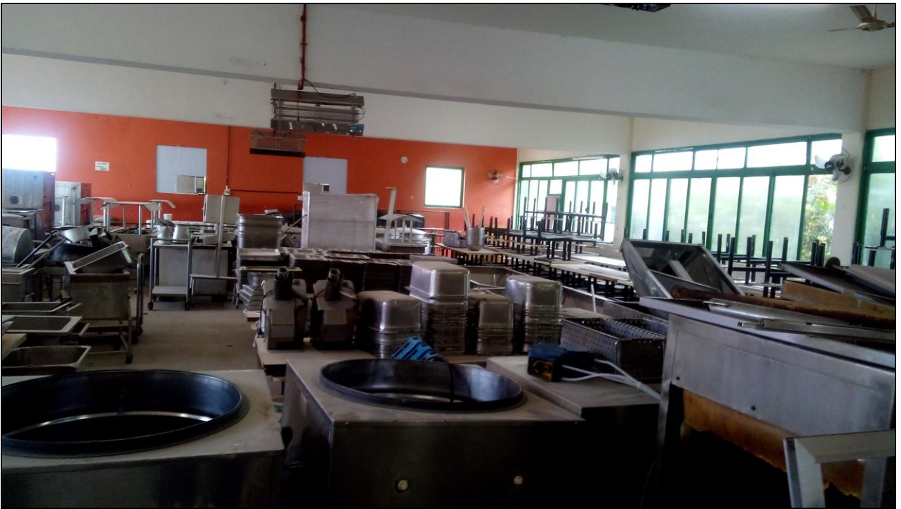
Foto 03 - Armazenamento dos equipamentos da cozinha do RU no Salão nº 02
