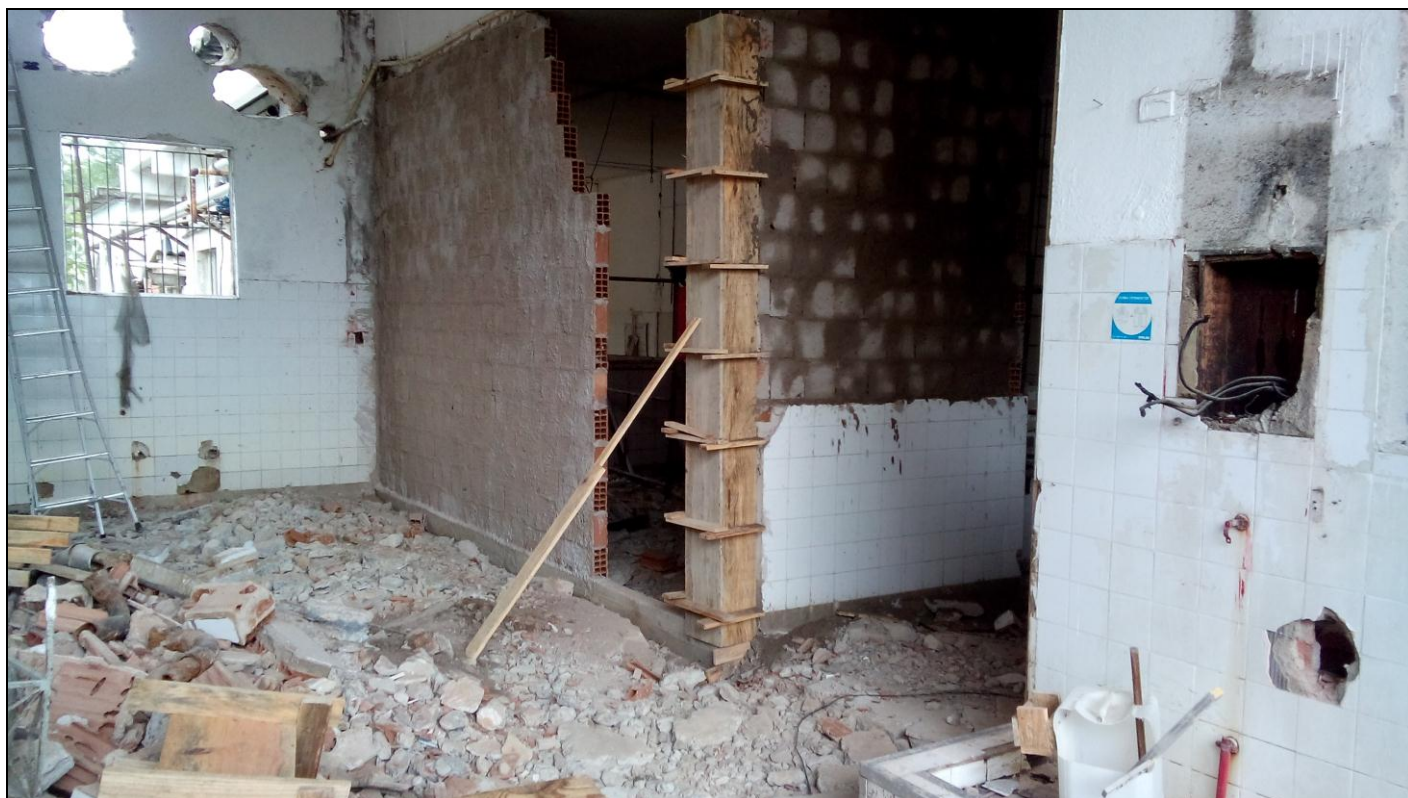
Foto 11: Construção de novas paredes internas de alvenaria
