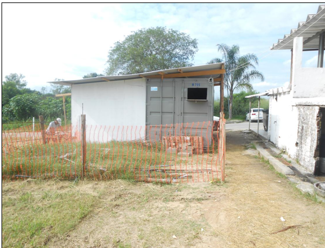
Foto 01 – Instalação do Container da Line Pró Engenharia LTDA
