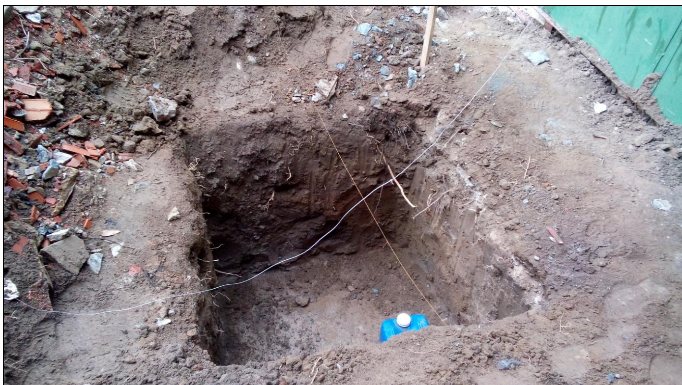
Foto 10: Início da construção das fundações da área de expansão da cozinha do RU
