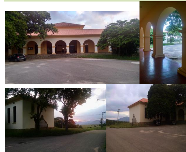
Prédio Principal – Departamento de Geociências/IA
